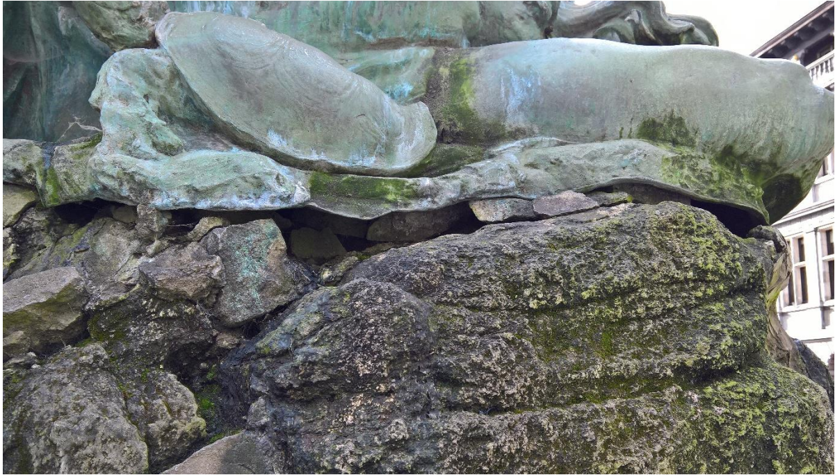
Figuur 44. Loszittende voegen tussen brons en rotspartij. Mogelijkheid tot waterinsijpeling.
