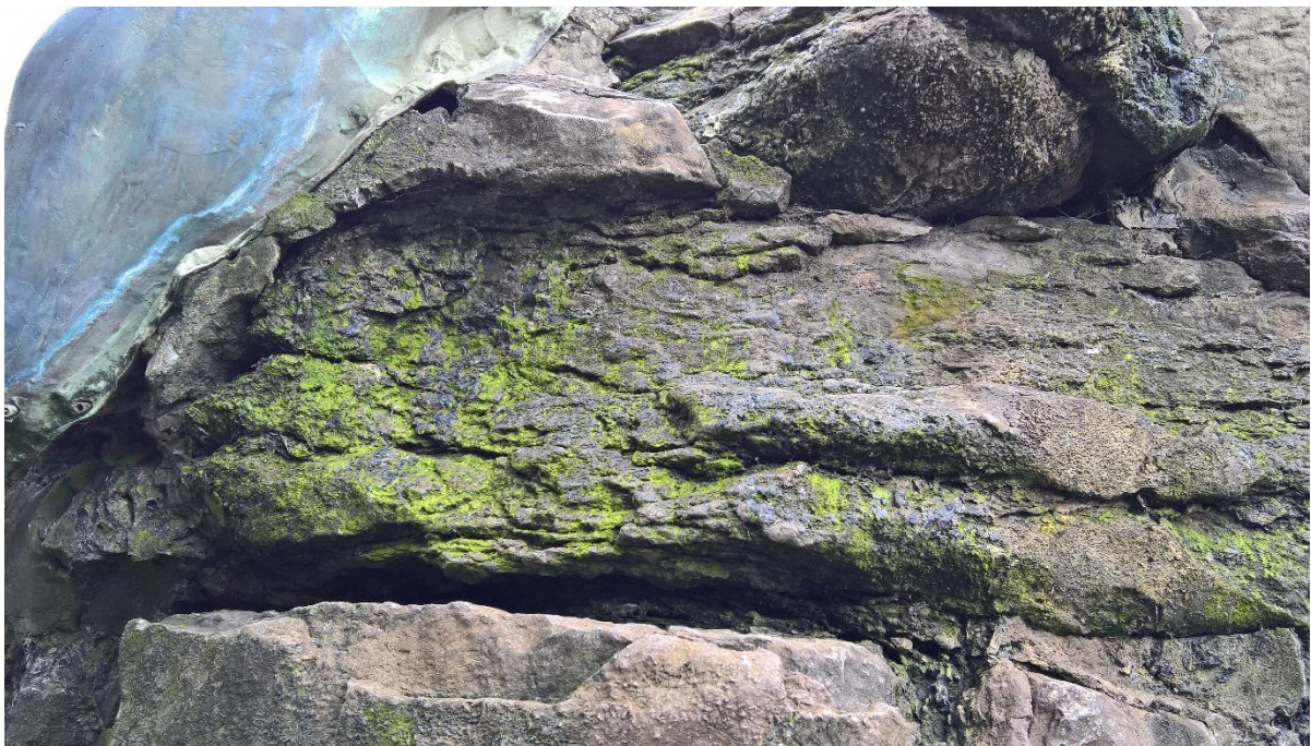
Figuur 52. Contaminatie door geïncrusteerd stof en biologische organismen.
