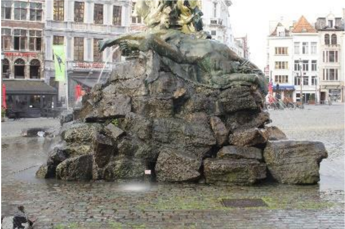
Figuur 51. Mosvorming aan de noordzijde van de fontein.
