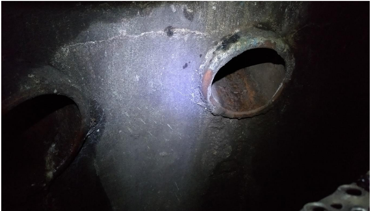
Figuur 68. Uitmonding afvoerpijpen in de centrale put.
