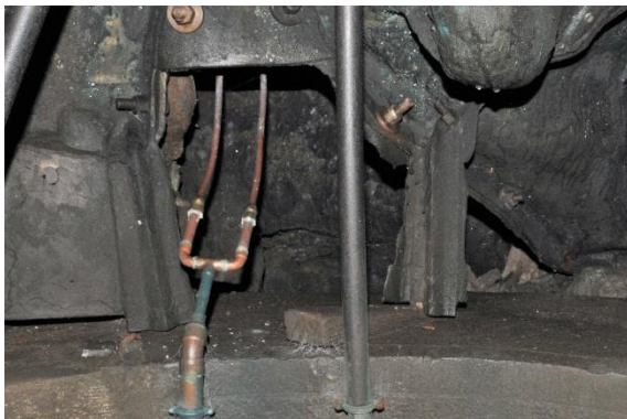
Figuur 26. Aaneensluiting van het bronzen beeld op de cilindrische sokkel, interieurzijde. De steunlippen rusten niet volledig op de steen.
