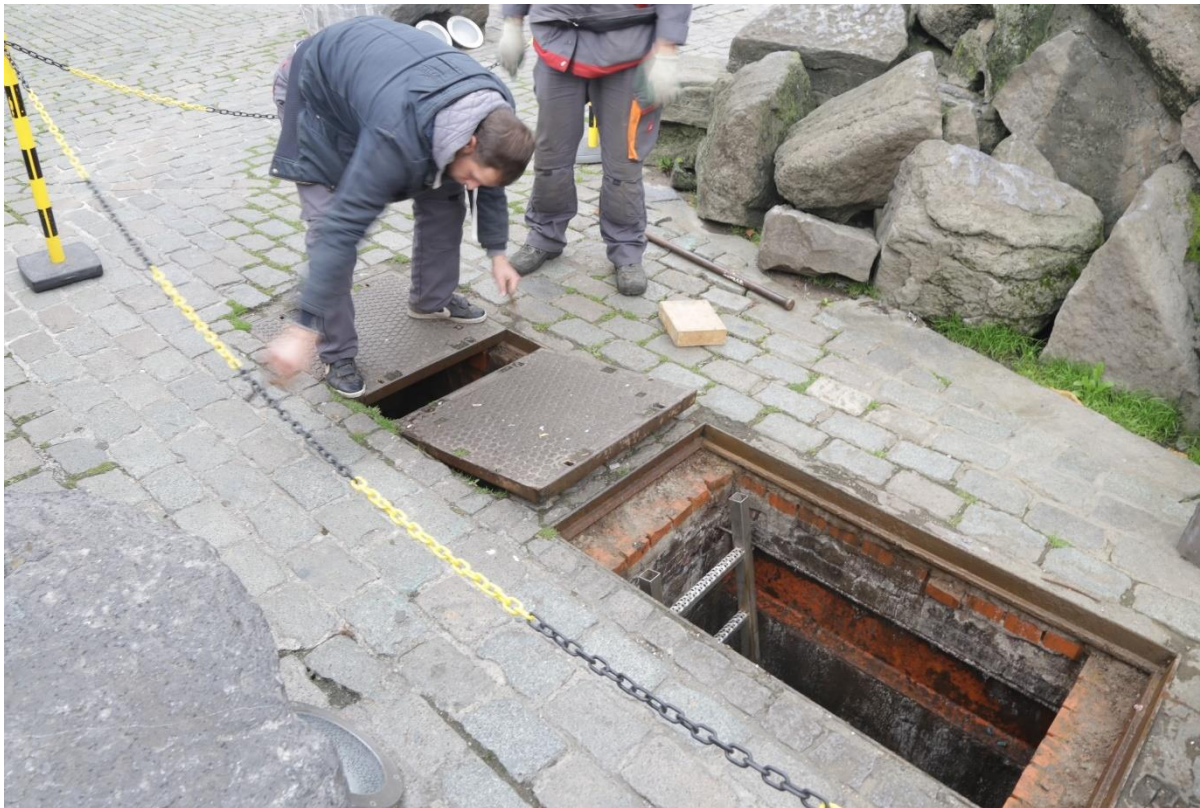
Figuur 57. Zicht op de toegangsluiken van de 2 kelderruimtes, links de pompkelder, rechts de kelder met terugloop.
