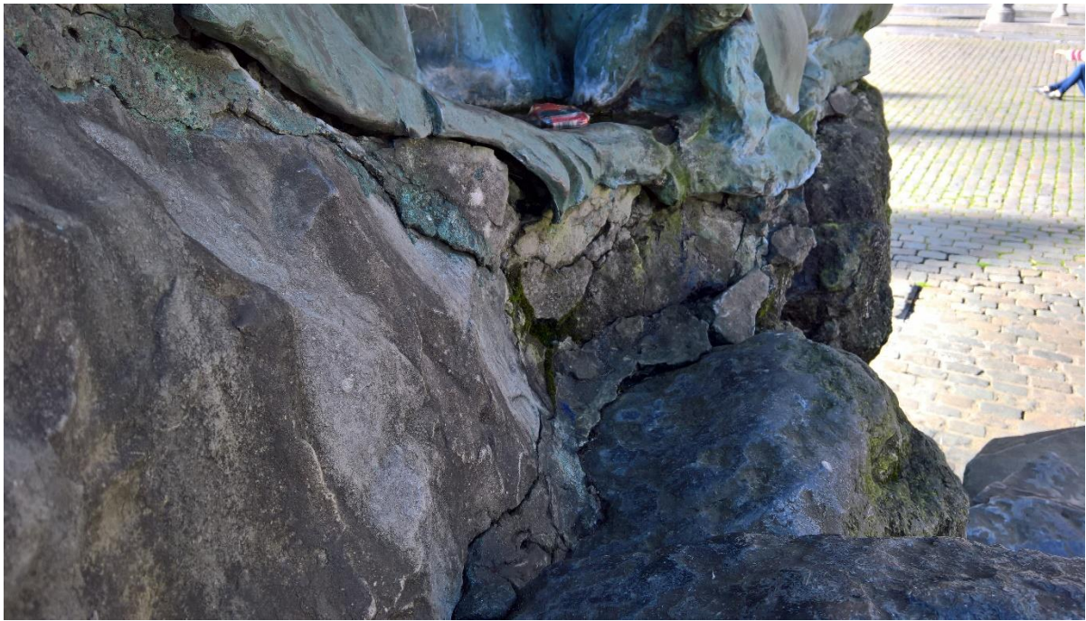
Figuur 48. Loszittend voegsel zorgt voor lokale verzakkingen en instortingsgevaar.
