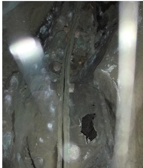
Figuur 25. Naad tussen 2 onderdelen die aan de binnenzijde met elkaar verbonden zijn met behulp van bouten.
