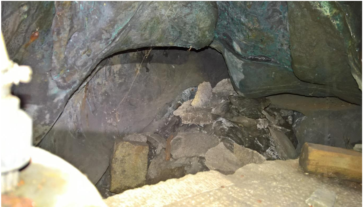
Figuur 53. Ophoping losse stenen tussen sokkel en de voet van het bronzen beeld.
