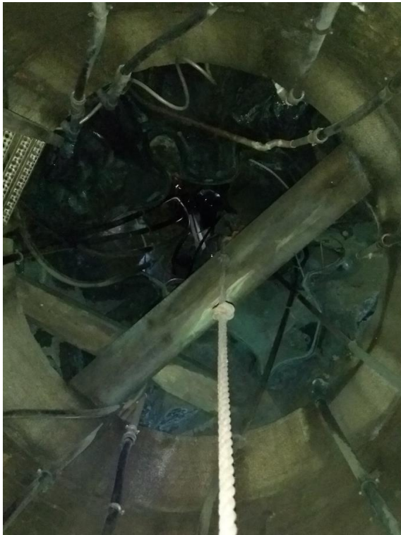
Figuur 63. Zicht naar boven toe vanuit de cilindrische put. Rondom vertrekken de kunststof toevoerleidingen naar de verschillende spuitkoppen.
