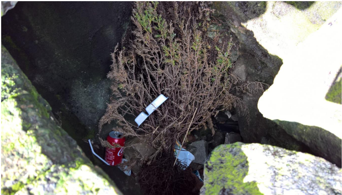
Figuur 42. Grote hoeveelheden zwerfvuil verstopen de afvoerkanalen.
