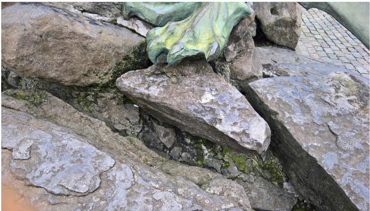
Figuur 47. Loszittende rotsblokken onder het bronzen monster zorgen ervoor dat dit onstabiel is.
