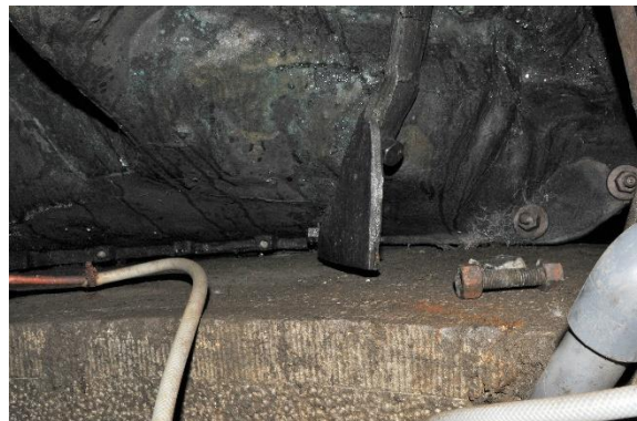
Figuur 27. Aaneensluiting van het bronzen beeld op de cilindrische sokkel, interieurzijde. De steunlip rust niet op de steen.
