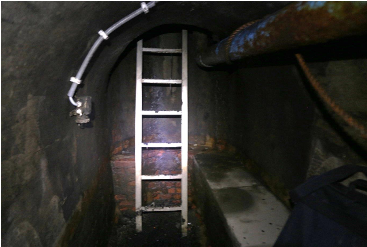
Figuur 59. De tunnel die toegang geeft aan de binnenzijde van het bronzen beeld en tevens dienst doet als waterterugloop. Rechtsboven de aanvoerleiding in gietijzer (blauw met bruine roestvlekken). Achteraan is een moderne ladder aangebracht in roestvast staal.
