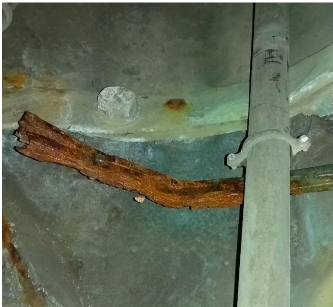
Figuur 65. Roestige bevestigingspunten van de kunststof waterleidingen
