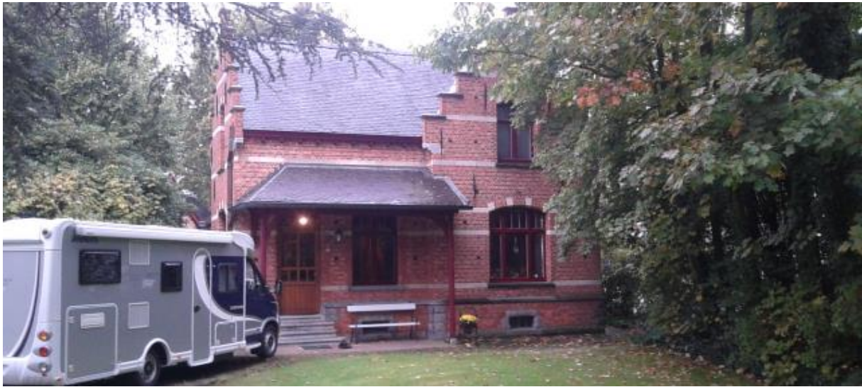
Portierswoning met zichtvervuiling
