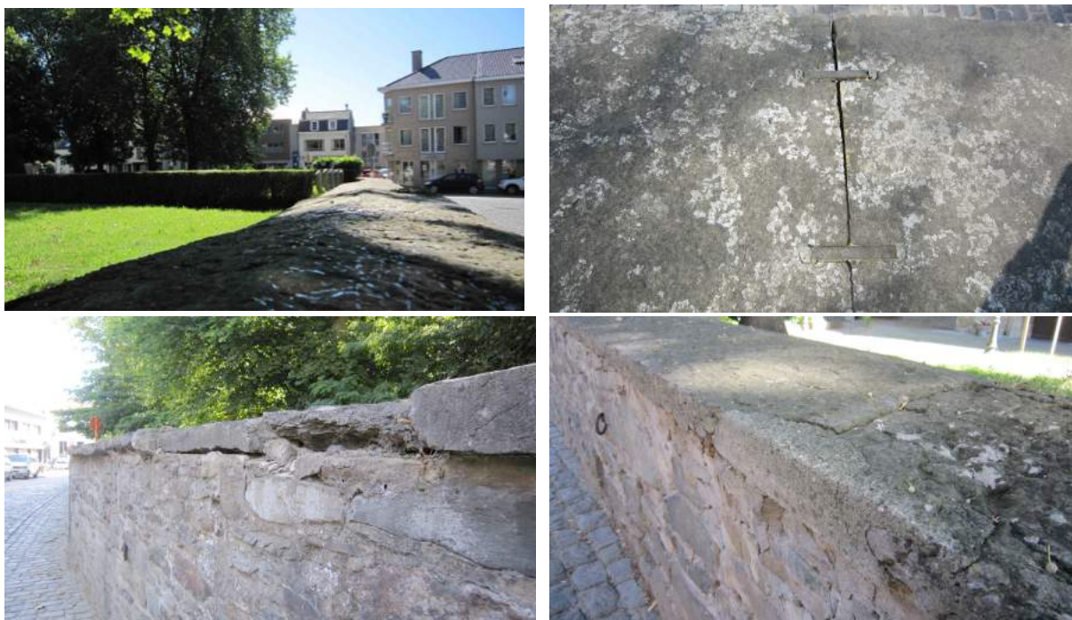
Afbeelding 128. Reeks met weergave van dekstenen: profiel, verankeringen, schadebeeld, herstellingen.
