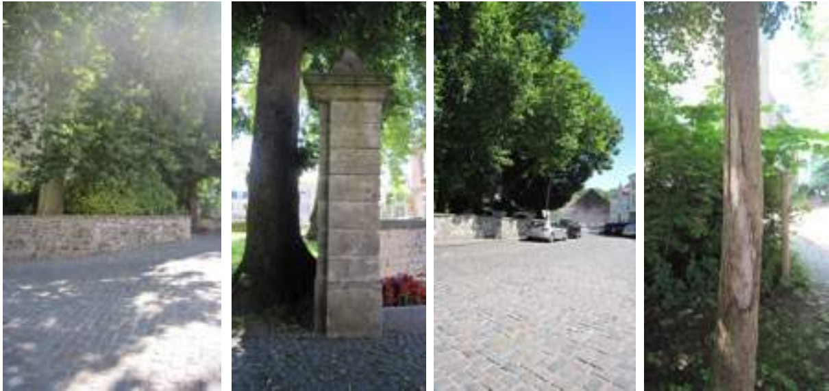
Afbeelding 182. Reeks met weergave knelpunten: nabijheid bomen bij muur en pilasters, overhangende kruinen, beschadigde stam.
