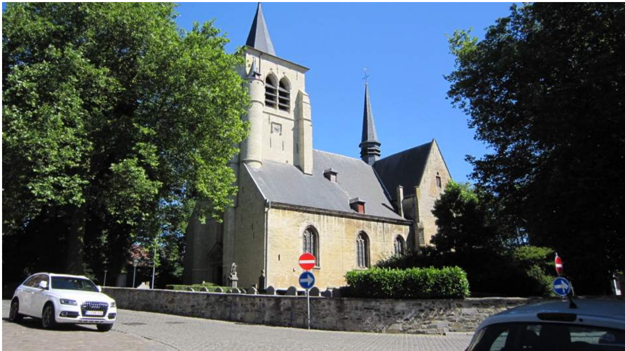
Afbeelding 105. De zuidgevel, gedomineerd door de westertoren, is op dit moment het meest zichtbare deel van de kerk (eigen foto).
