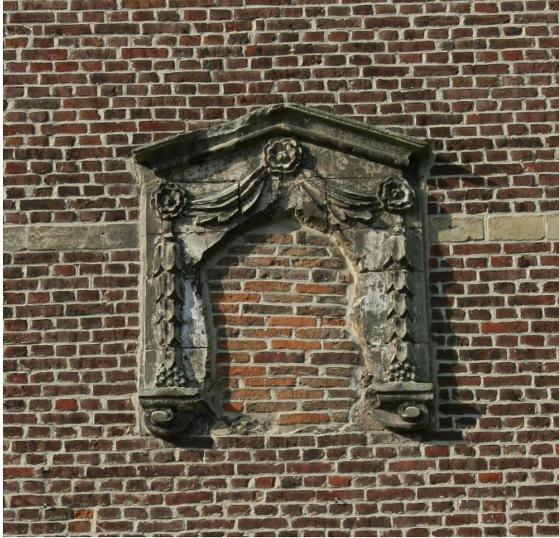
Foto 12: Oostgevel, de dichtgemetselde beeldnis.
