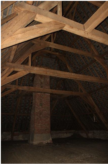
De eikenhouten kapconstructie (laatste foto van Team Herman Van Meer, 2010).
