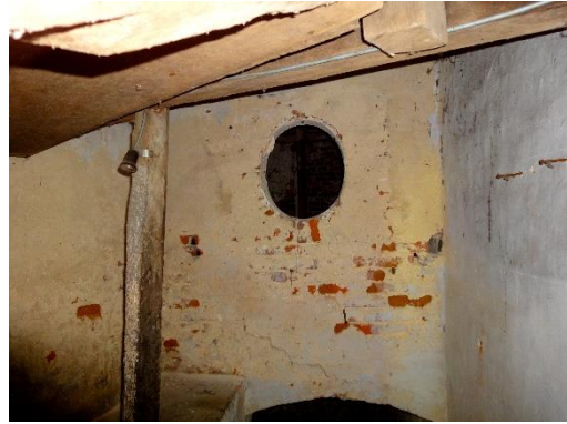
Bakstenen keldertrap met houten treden. Rechter foto: boven de trap een oculus om via de achterliggende opkamer licht binnen te halen.
