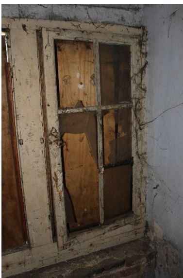
Het westelijke kruisvenster met bewaard 17 de -eeuws schrijnwerk, hang- en sluitwerk .
