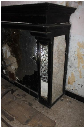
Schouwmantel in gemarmerd hout. Onder de marmerimitatie zijn sporen van roodschildering zichtbaar.
