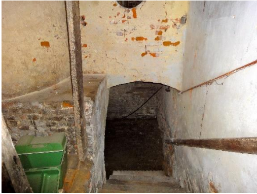
Bakstenen keldertrap met houten treden. Rechter foto: boven de trap een oculus om via de achterliggende opkamer licht binnen te halen.
