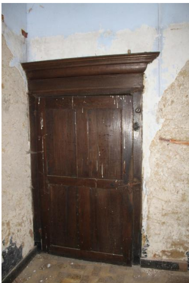
Paneeldeur met geprofileerde deurkader en een gesmede klinksluiting (twee laatste foto's: Team Herman Van Meer, 2010).
