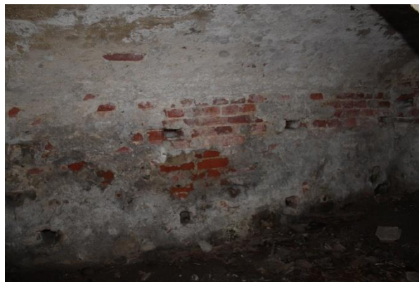
Dichtgemaakte deuropening naar kamer G4 voorheen toegankelijk via een bakstenen trap met houten treden. Rechter foto: de kleine eveneens getonwelfde kelder met een vloer van aangestampte aarde. De gaten in de muur verwijzen naar voormalige legplanken.
