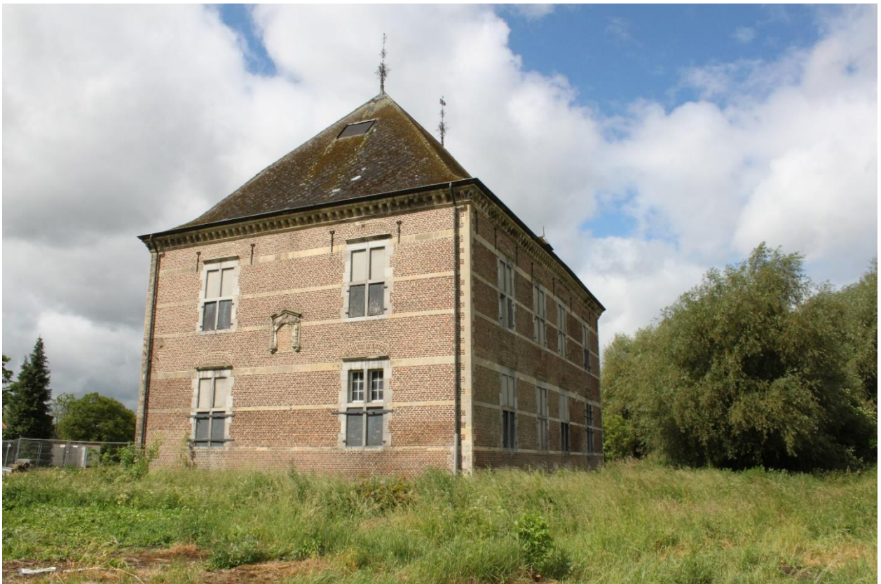
Foto 11: Oost- en noordgevel.
