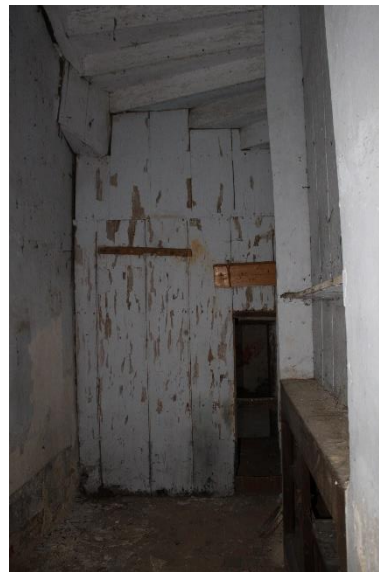
Zicht op de westgevel met de dichtgemaakte deur naar kamer G4. De opkamer wordt in twee gedeeld door een houten tussenwand. Rechts van de houten wand is de ingebouwde kast achter het altaar zichtbaar. Het oostelijke kruisvenster van de opkamer is volledig dichtgemetseld.
