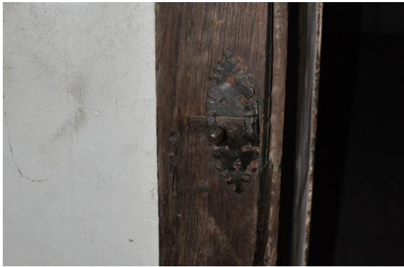
Gesmede grendel op de deurstijl van kamer V2 (foto Team Herman Van Meer, 2010). Rechter foto: detail van de geprofileerde deurkader van kamer V3.
