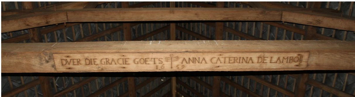
Afbeelding 10: De kapconstructie is gedateerd en gesigneerd met de naam van de opdrachtgeefster.
