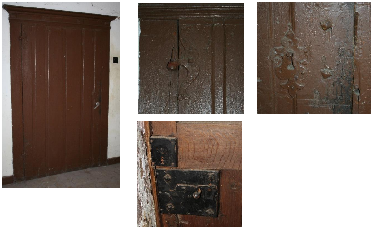
Zuidoostelijke kamer (G2): originele deurkader met diamantkoppen en opgeklampte deur, accoladevormige gehengen en decoratief sleutelplaatje en aan de achterzijde het slot.
