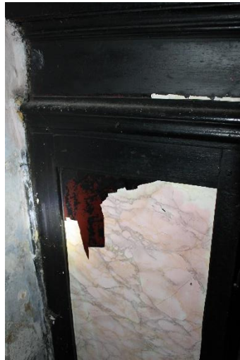
Schouwmantel in gemarmerd hout. Onder de marmerimitatie zijn sporen van roodschildering zichtbaar.
