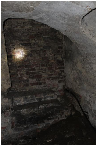
Dichtgemaakte deuropening naar kamer G4 voorheen toegankelijk via een bakstenen trap met houten treden. Rechter foto: de kleine eveneens getonwelfde kelder met een vloer van aangestampte aarde. De gaten in de muur verwijzen naar voormalige legplanken.
