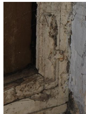
Het westelijke kruisvenster met bewaard 17 de -eeuws schrijnwerk, hang- en sluitwerk .
