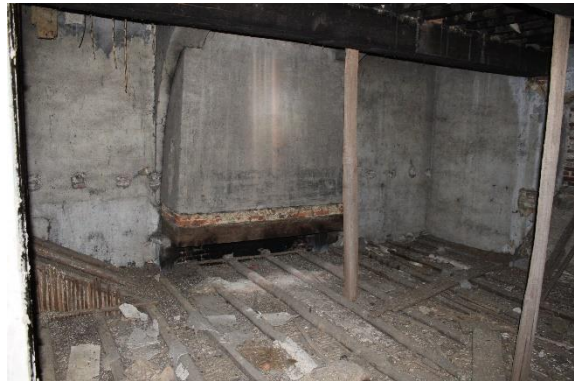
Duidelijke brandsporen op de moer- en kinderbalken alsook bouwsporen van een verwijderd vals plafond ca. 1m hoger dan het huidige vloerniveau.
