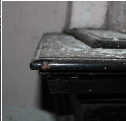
Schouwmantel in gemarmerd hout. Onder de marmerimitatie zijn sporen van roodschildering zichtbaar.
