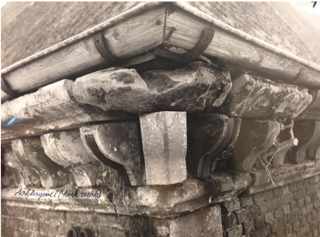
Foto 13. De beschadigde kroonlijst in Maastrichtersteen vóór de restauratie in 1984-1985 – Bron: Archief Onroerend Erfgoed Hasselt, doos DL 149 Hasselt – Kuringen, abdij van Herkenrode – infirmerie: restauratiedossier 1984-1985.
