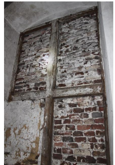
Zicht op de westgevel met de dichtgemaakte deur naar kamer G4. De opkamer wordt in twee gedeeld door een houten tussenwand. Rechts van de houten wand is de ingebouwde kast achter het altaar zichtbaar. Het oostelijke kruisvenster van de opkamer is volledig dichtgemetseld.
