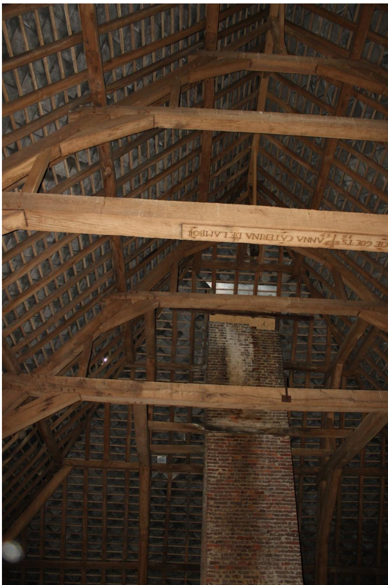
Afbeelding 11: 17 de -eeuwse dakconstructie met bewaarde schaargebinten, gordingen en kepers.
