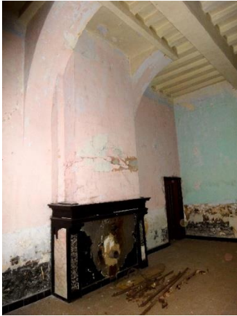
De rechte schouwboezem en lage gemarmerde schouwmantel wijzen op een aanpassing uit de 18 de eeuw.
