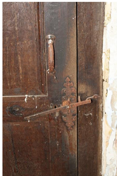
Paneeldeur met geprofileerde deurkader en een gesmede klinksluiting (twee laatste foto's: Team Herman Van Meer, 2010).
