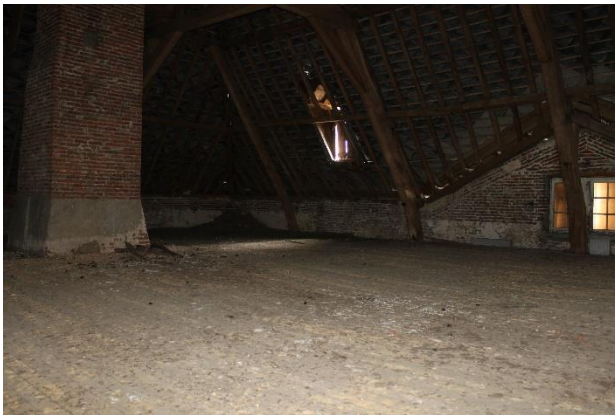
De eikenhouten kapconstructie (laatste foto van Team Herman Van Meer, 2010).
