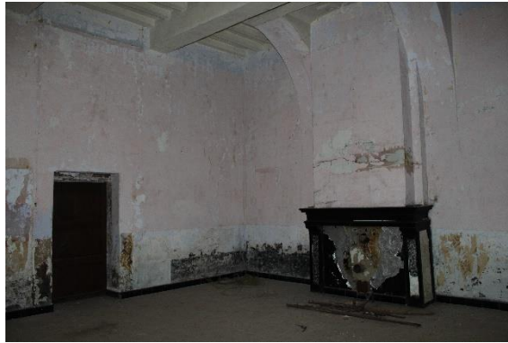
De rechte schouwboezem en lage gemarmerde schouwmantel wijzen op een aanpassing uit de 18 de eeuw.
