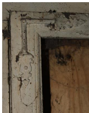
Het westelijke kruisvenster met bewaard 17 de -eeuws schrijnwerk, hang- en sluitwerk .
