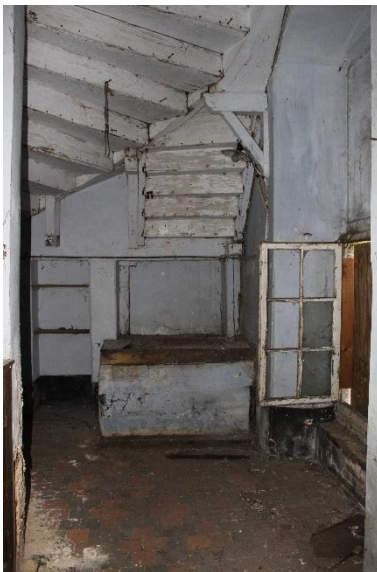
Zicht op de westgevel met de dichtgemaakte deur naar kamer G4. De opkamer wordt in twee gedeeld door een houten tussenwand. Rechts van de houten wand is de ingebouwde kast achter het altaar zichtbaar. Het oostelijke kruisvenster van de opkamer is volledig dichtgemetseld.
