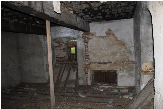
Duidelijke brandsporen op de moer- en kinderbalken alsook bouwsporen van een verwijderd vals plafond ca. 1m hoger dan het huidige vloerniveau.
