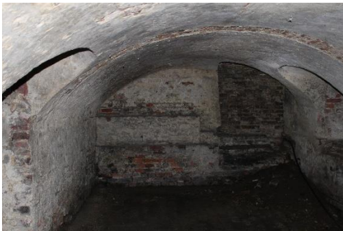
Getonwelfde kelder met bakstenen vloer, in de achterwand een dichtgemaakte deuropening naar kamer G4 en links de toegang tot de kleine kelder. de bakstenen vloer.
