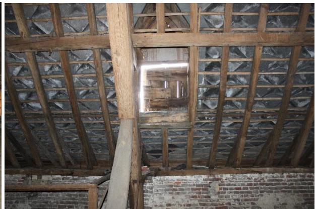
De eikenhouten kapconstructie (laatste foto van Team Herman Van Meer, 2010).
