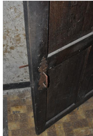
Paneeldeur met geprofileerde deurkader en een gesmede klinksluiting (twee laatste foto's: Team Herman Van Meer, 2010).
