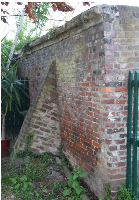
Foto 6a en b: Detail van de steunberen, de geprofileerde kroonlijst in Maastrichtersteen en de afgeschuinde plint in Maaskalksteen aan de noordzijde.
