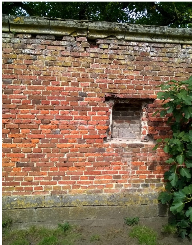
Foto 6a en b: Detail van de steunberen, de geprofileerde kroonlijst in Maastrichtersteen en de afgeschuinde plint in Maaskalksteen aan de noordzijde.
