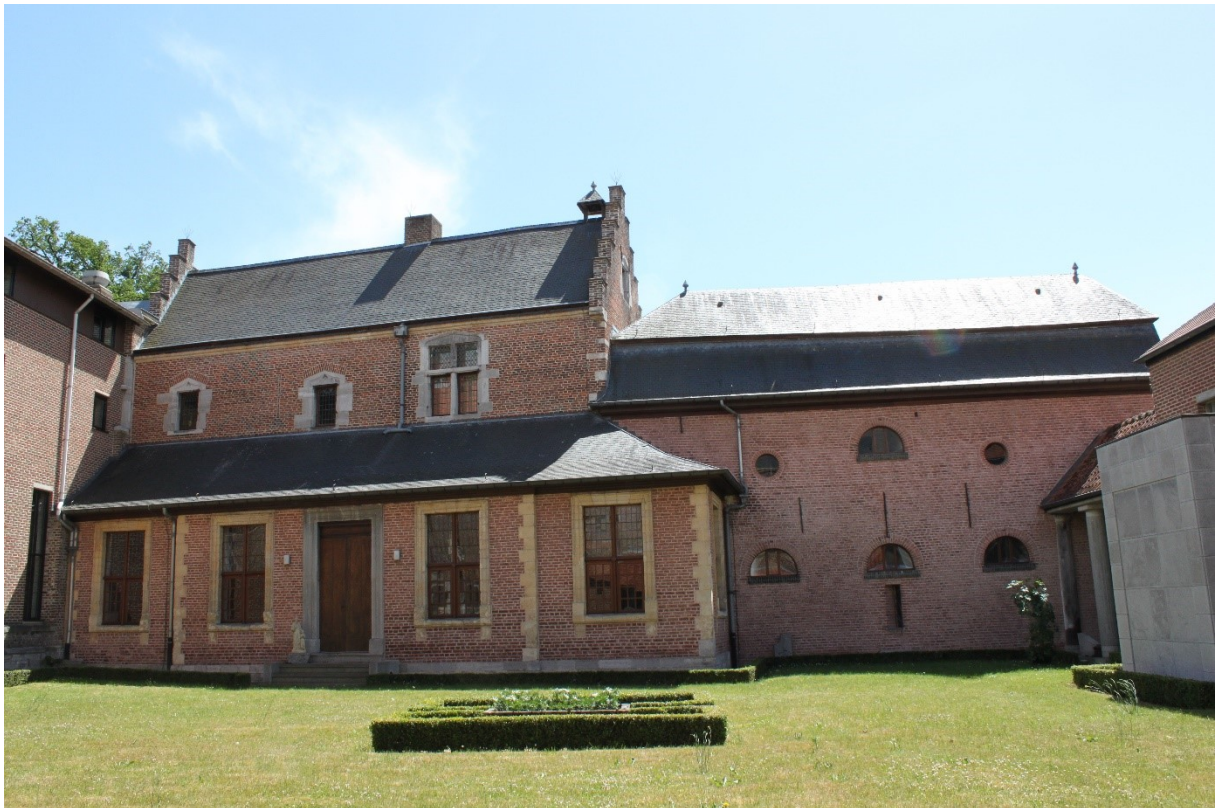
Foto 5: Voormalig abdissenkwartier, zuidvleugel met 16de-eeuws breedhuis en gang (links) en het poortgebouw met portierswoning (rechts) uit het tweede kwart van de 18de eeuw
