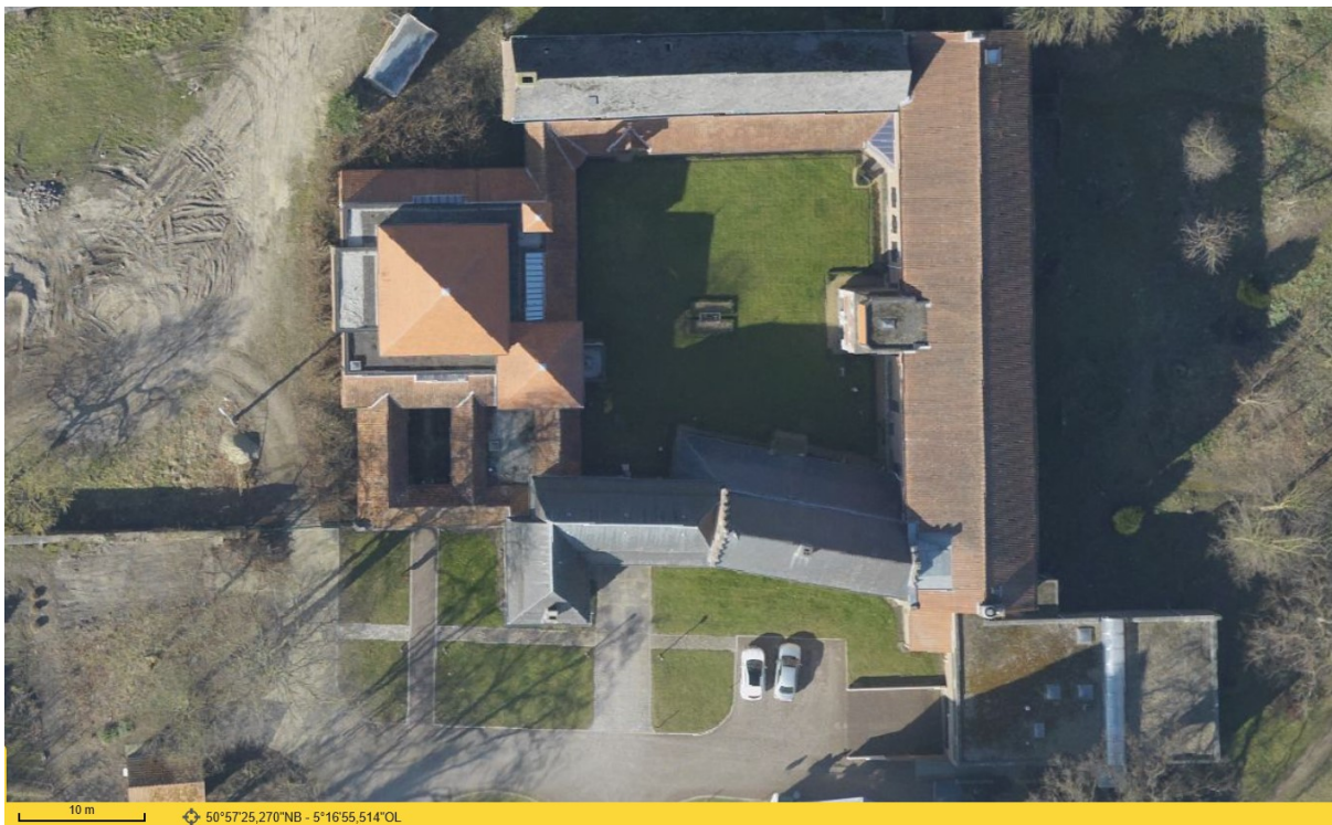
Foto 3: Luchtfoto van het voormalige abdissenkwartier, nu klooster- Bron: Geopunt
