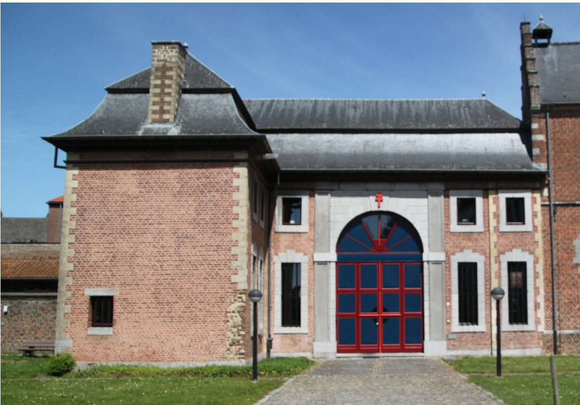
Foto 9: Voormalig abdissenkwartier, zuidvleugel: poortgebouw
