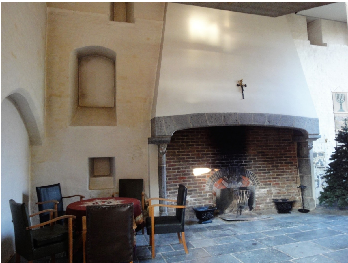
Foto 56: Abdissenverblijf, oksel noord- en oostvleugel: gotische schouw en gedichte muuropeningen
