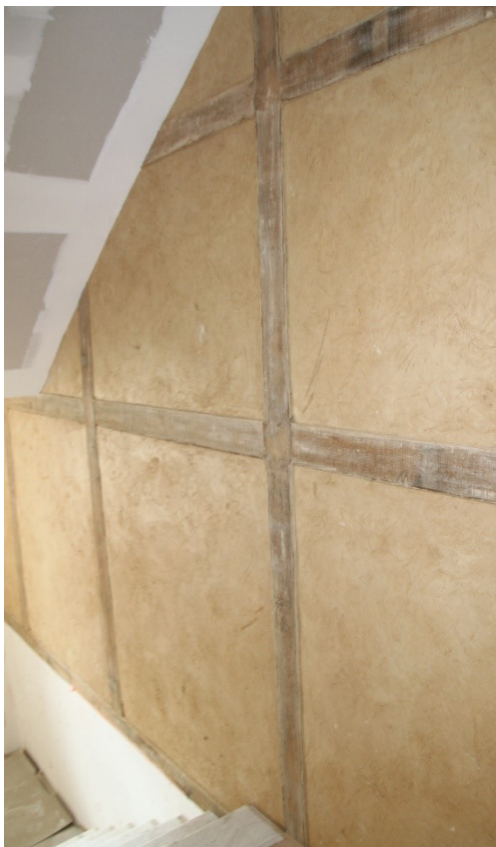
Foto 54: Abdissenverblijf, noordvleugel: vakwerkwand
