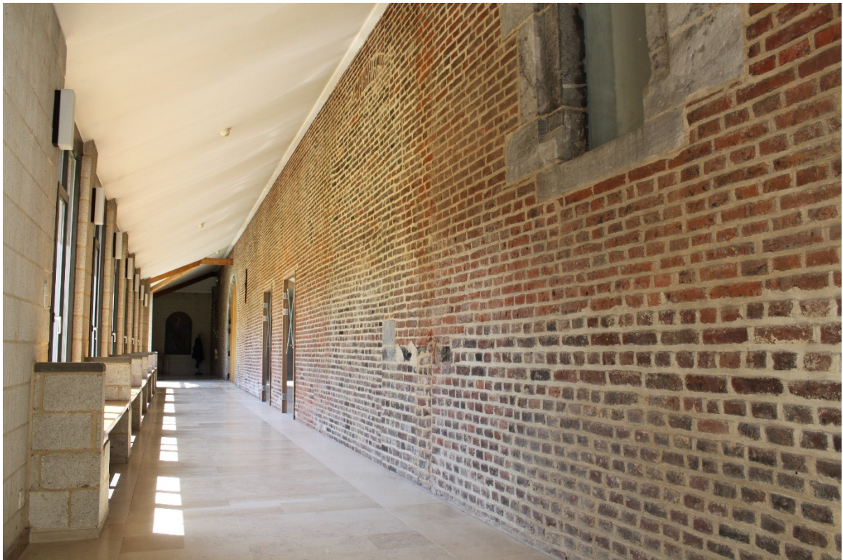
Foto 18: Abdissenkwartier, noordvleugel: koergevel met bouwsporen
