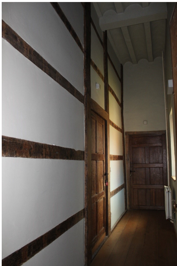
Foto 44: Abdissenkwartier, gang +1 met vakwerk wand, plankenvloer en troggewelfjes
