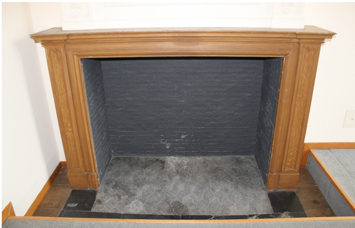
Foto 97: +1, kamer K7a, schouwmantel met leistenen haardvloer
