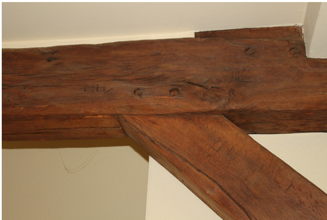
Foto 104, zolder, logeerkamer, detail genummerd spantbeen
