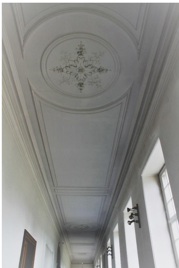
Foto 20: +0, gang, detail stucplafond
