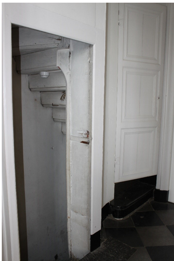
Foto 55: +0, sas met deur naar de insteekverdieping en de kelder
