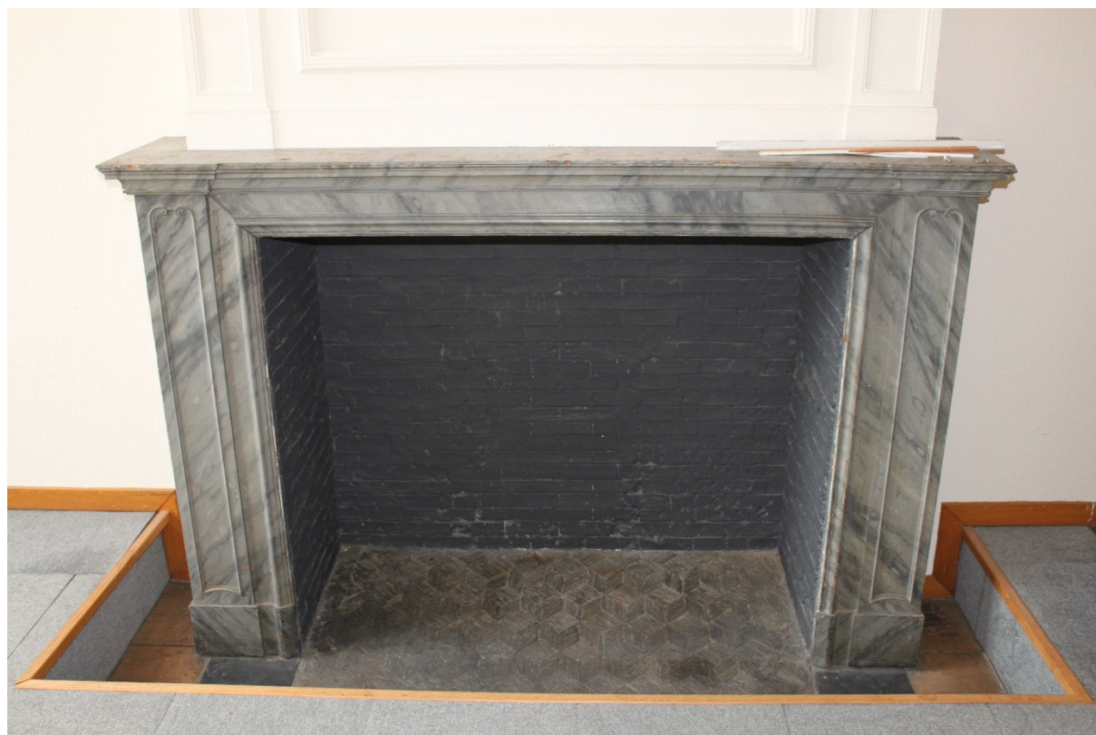
Foto 96: +1, kamer K5b, schouwmantel met leistenen haardvloer
