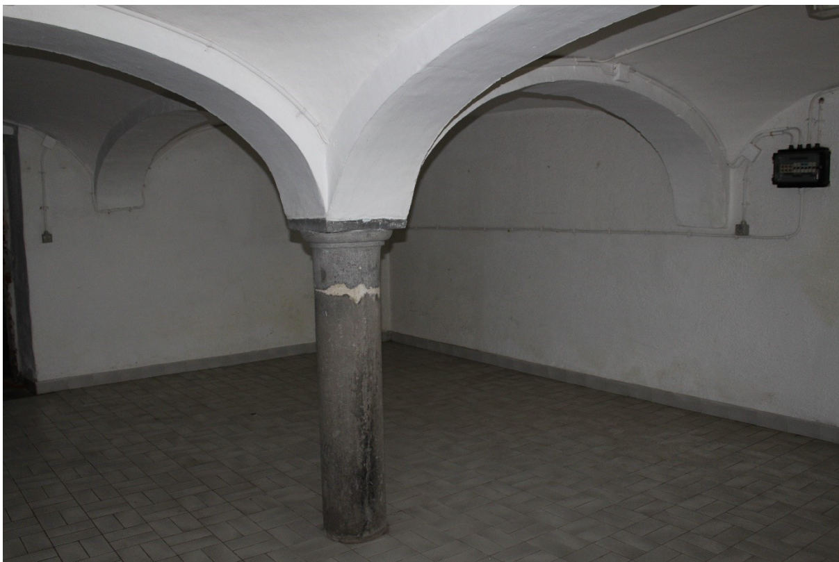
Foto 107, -1, kelder, kelderruimte met Boheemse kap op hardstenen Dorische zuil
