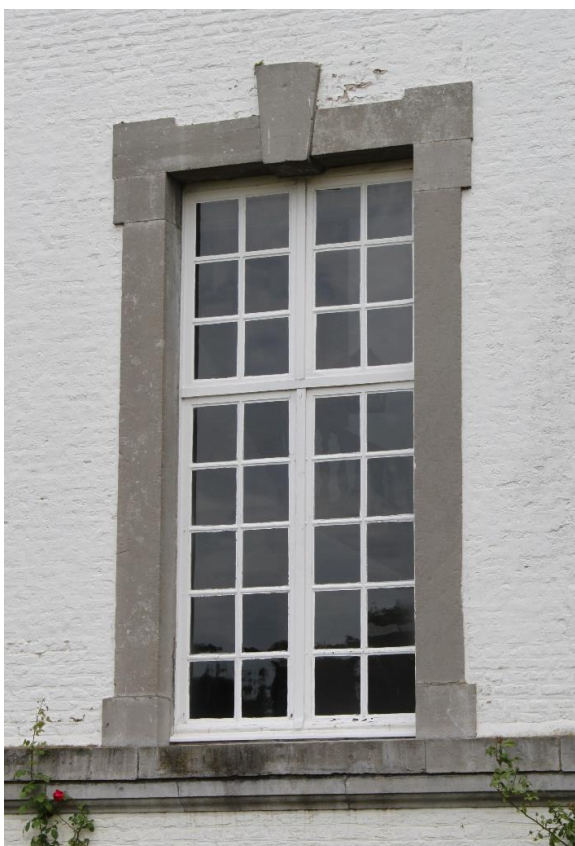
Foto 7: voorgevel, detail venster
