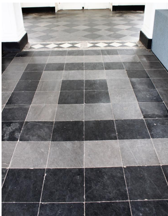
Foto 18: +0, dwarsgang, detail vloer
