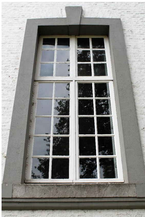
Foto 8: achtergevel, detail venster
