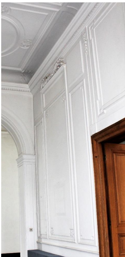
Foto 23: +0, dwarsgang, gestucte wand
