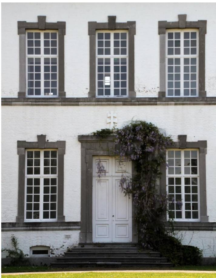
Foto 9: voorgevel, detail toegangstravee
