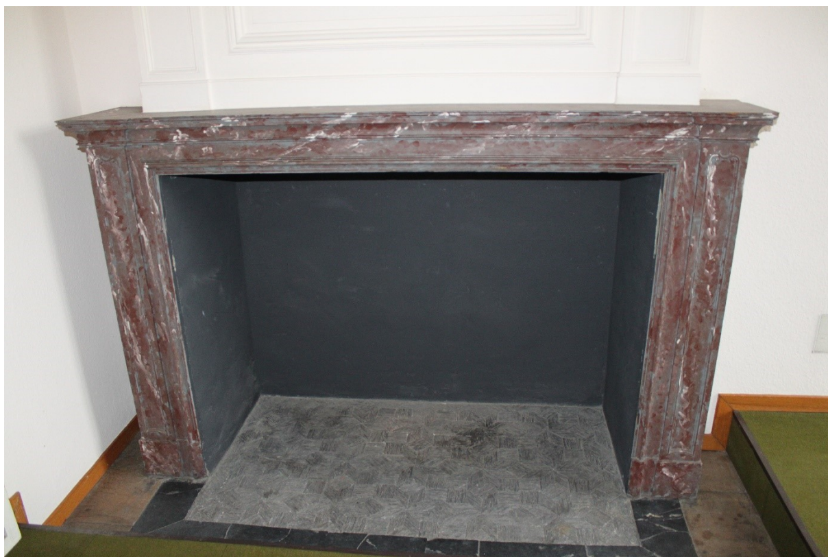
Foto 93: +1, kamer K3a, schouwmantel met leistenen haardvloer
