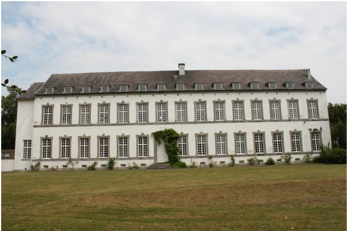
Foto 3: 18 de -eeuws abdissenverblijf, naar het westen gerichte voorgevel
