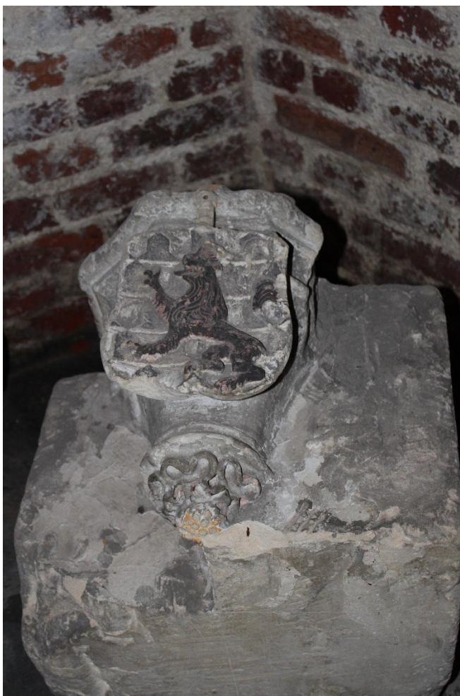
Foto 112, -1, kelder, gepolychromeerde natuurstenen aanzet van een kruisribgewelf met het wapen van de abdissen de Lechy (1491-1561)
