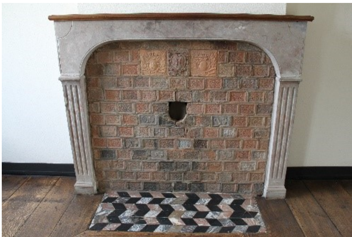
Foto 53: +0, zitkamer, detail schouwmantel met terracotta haardtegels en marmeren haardvloer in visgraatmotief
