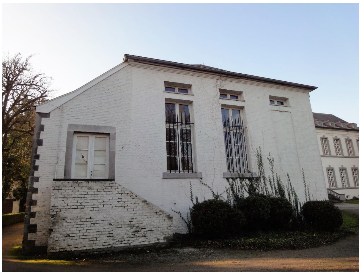
Foto 15: dienstvleugel, kopse gevel
