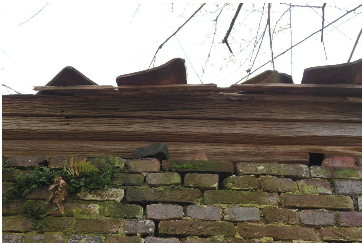
Foto 11: Westgevel, detail: geprofileerde houten kroonlijst van de voormalige galerij
