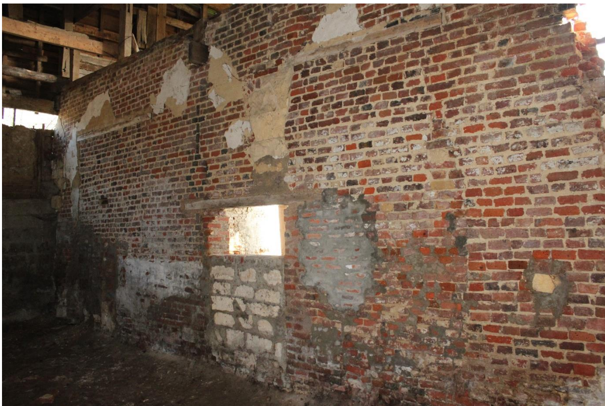
Foto 20: Noordelijke zijde van de galerij met zicht op de werstelijke buitengevel van het vakwerkgebouw met metselteken en de suggestie van de kruisribgewelven die de arcade eertijds overdekten
