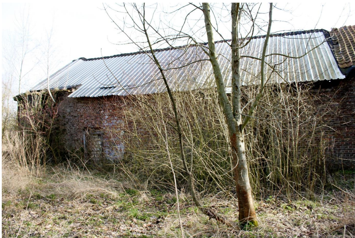
Foto 10: Westgevel: noordelijke helft met gedichte deur
