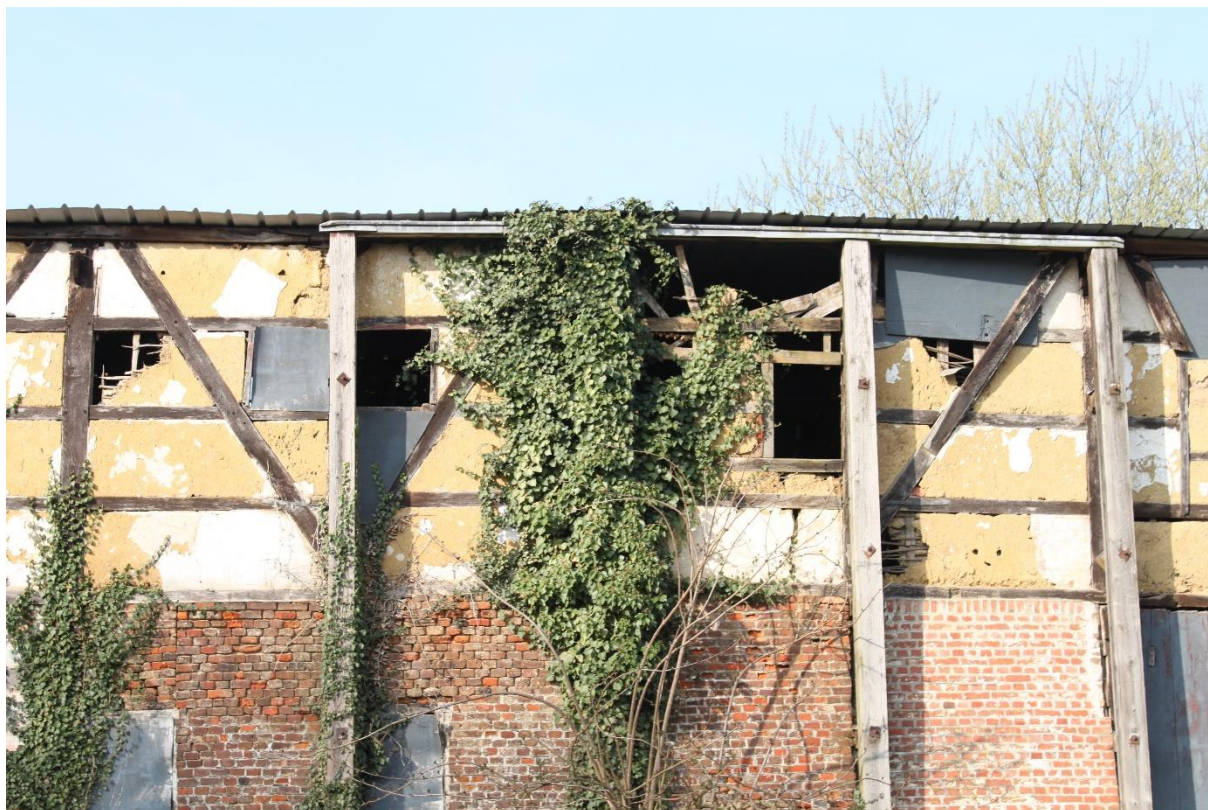
Foto 7: Oostgevel, detail: bolkozijnen
