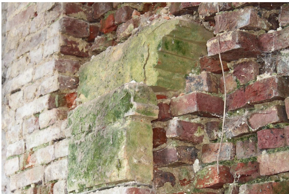
Foto 18: Westelijke binnengevel, detail impost rondboogarcade
