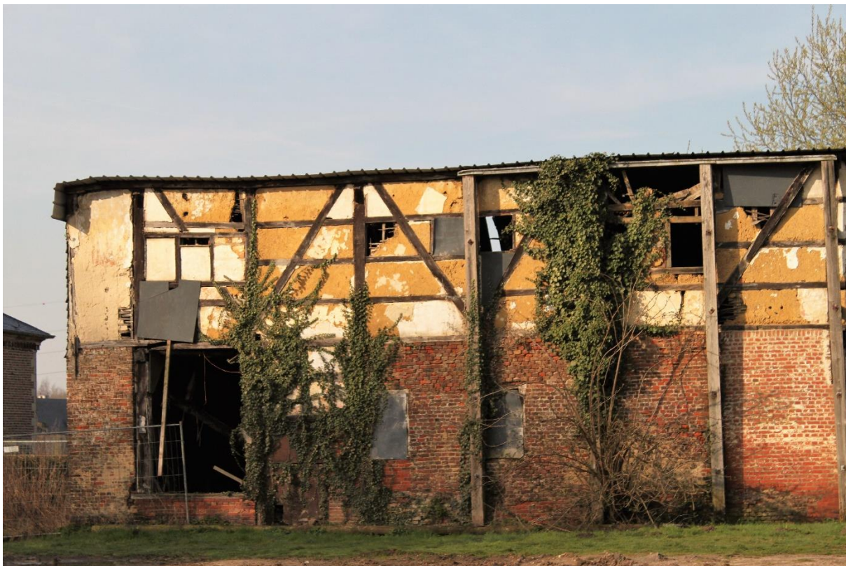
Foto 6: Oostgevel, detail: bewaarde ordonnantie in traveeën 15 tot 17 (travee 3 tot 5 v.r.n.l.)
