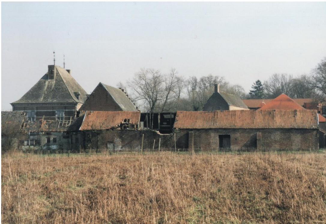
Foto 25: Westgevel, ongedateerde foto – Bron: Marc Willems
