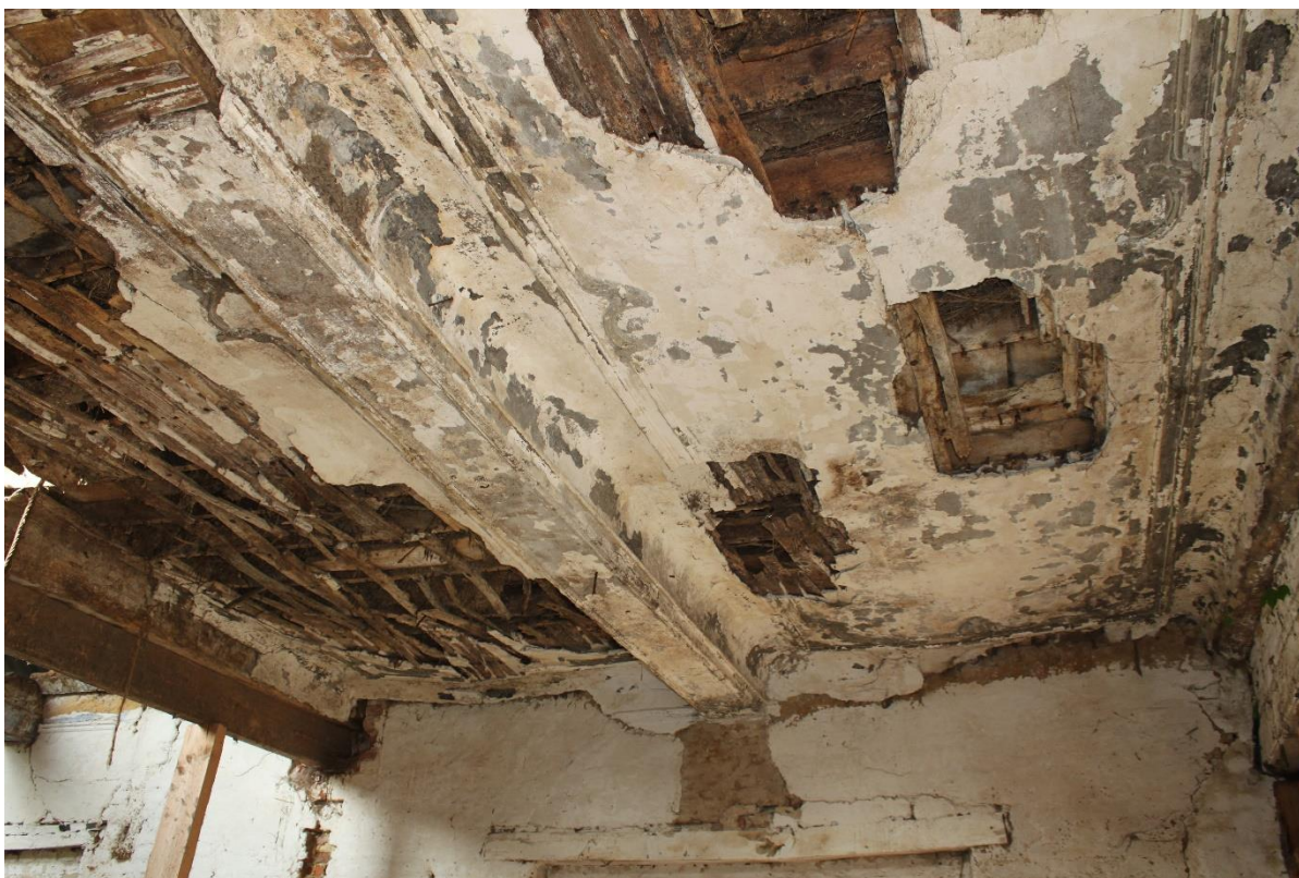
Foto 15: Noordelijke zuster cel, travee-indeling en stucplafond
