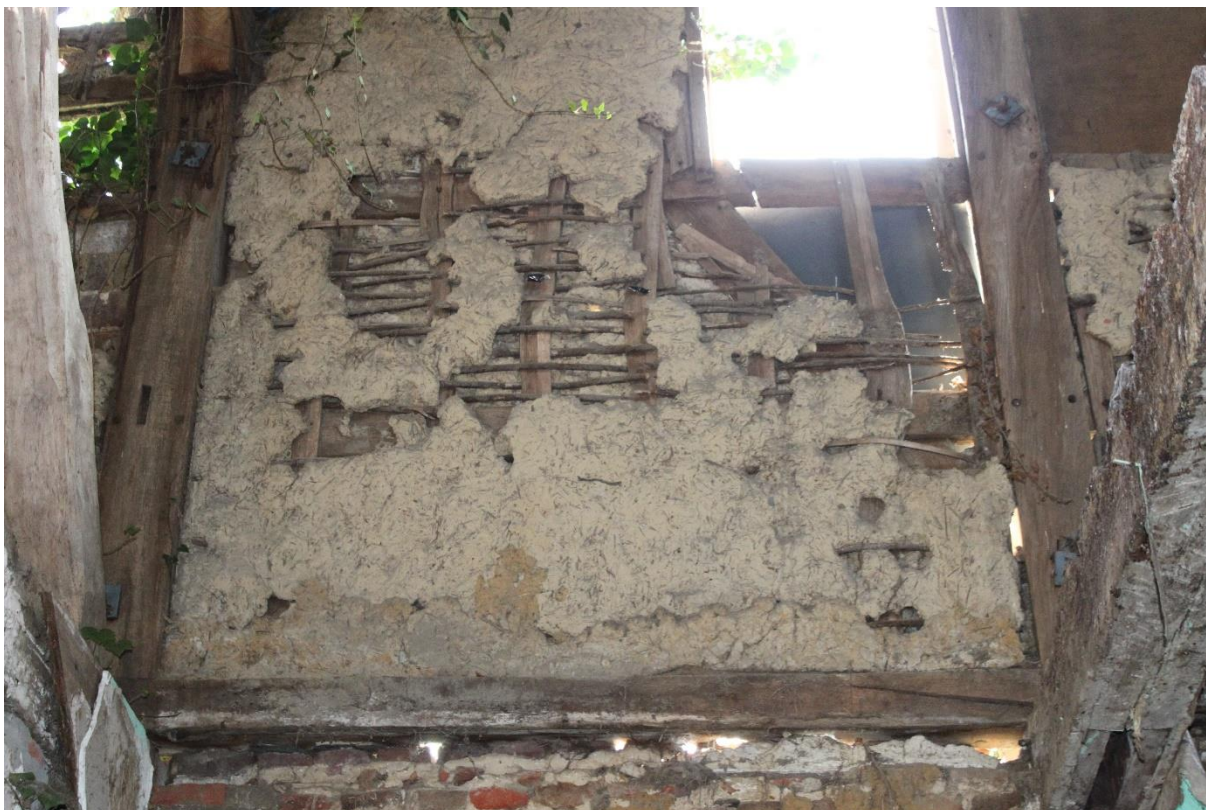
Foto 14: Oostgevel, detail bewaard Kempisch vitswerk op de verdieping
