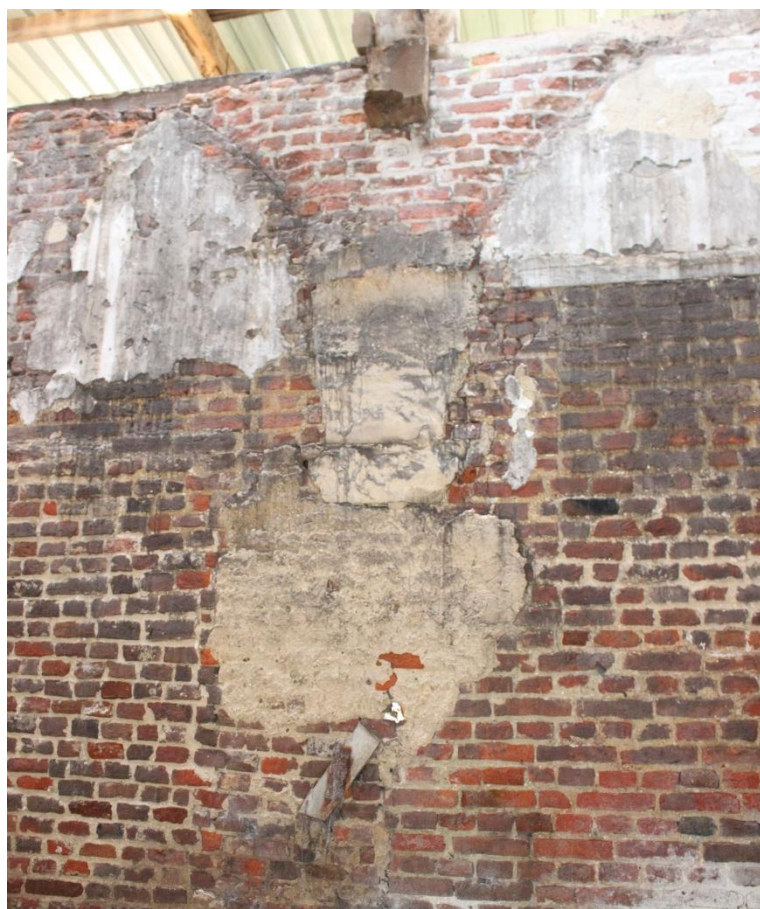
Foto 19: Voormalige galerij, aanzet voormalig kruisribgewelf
