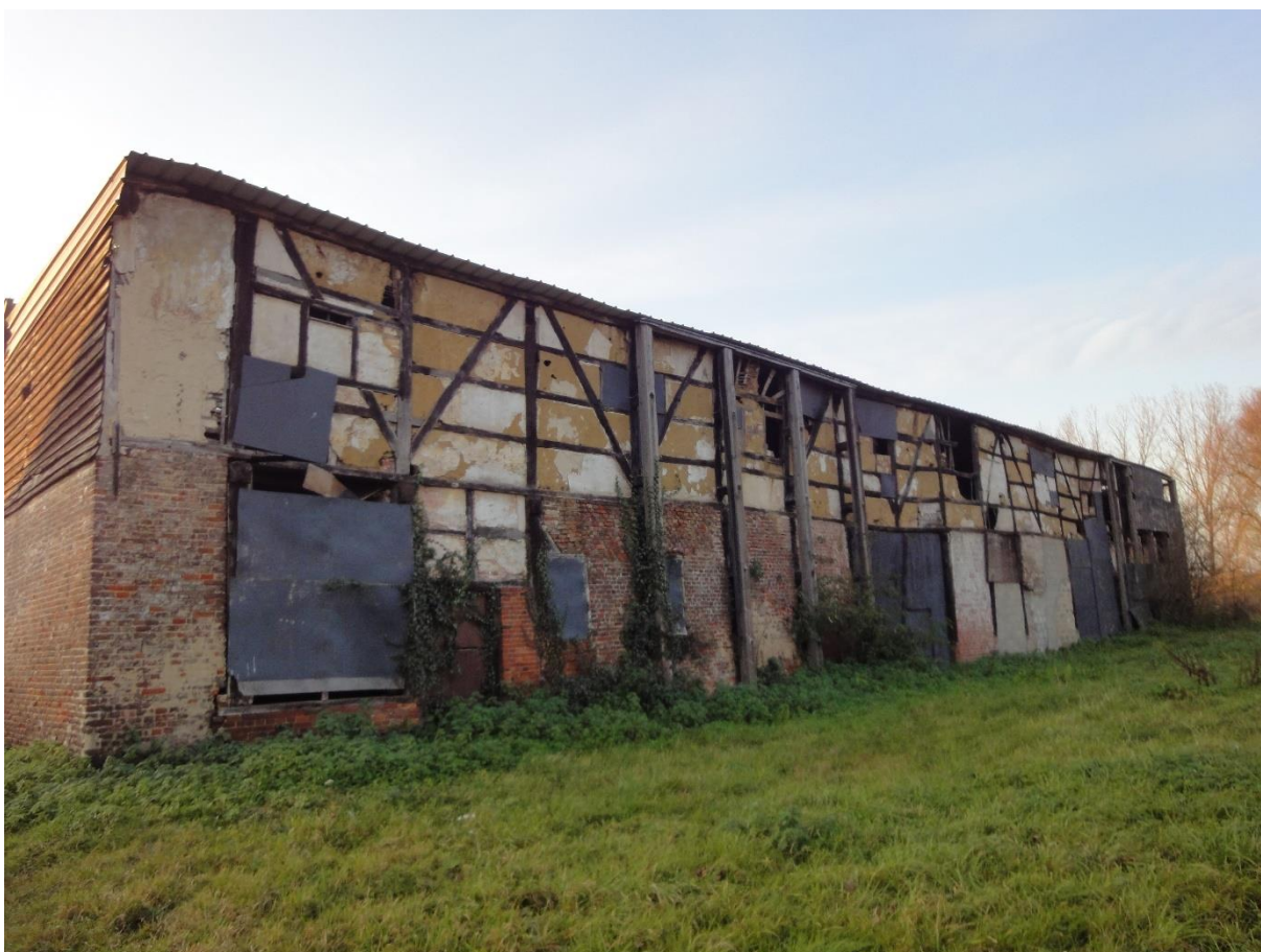
Foto 2: Vakwerkgebouw van de zustersverblijven: oostgevel
