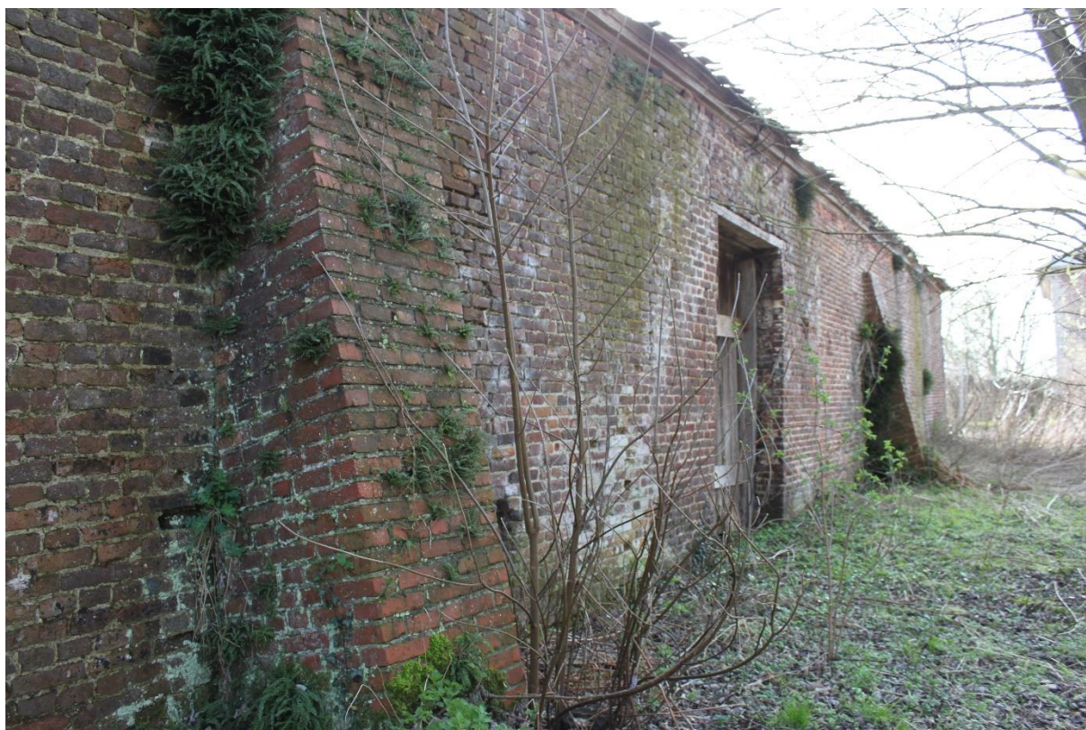
Foto 9: Westgevel: zuidelijke helft met poort en steunberen
