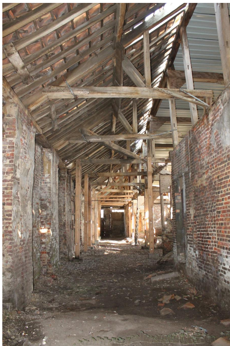
Foto 17: Voormalige galerij met bewaarde bakstenen pilasters (links)
