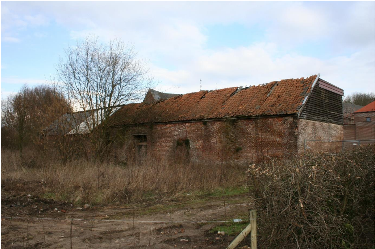
Foto 3: Vakwerkgebouw van de zusterverblijven: zicht vanuit het zuidwesten
