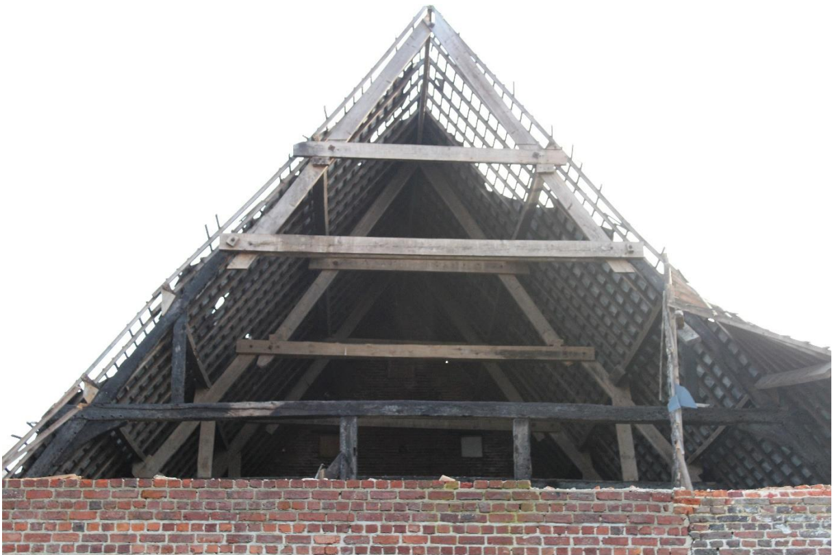
Foto 12: Oude infirmerie, nagenoeg volledig vernieuwd dakegebinte (toestand 15.05.2017)
