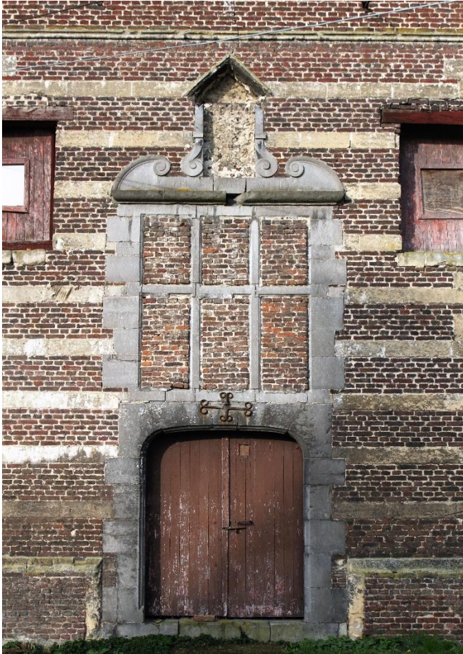
Foto 9: Oude infirmerie, oostgerichte trapgevel, poorttravee (toestand 14.03.2017)
