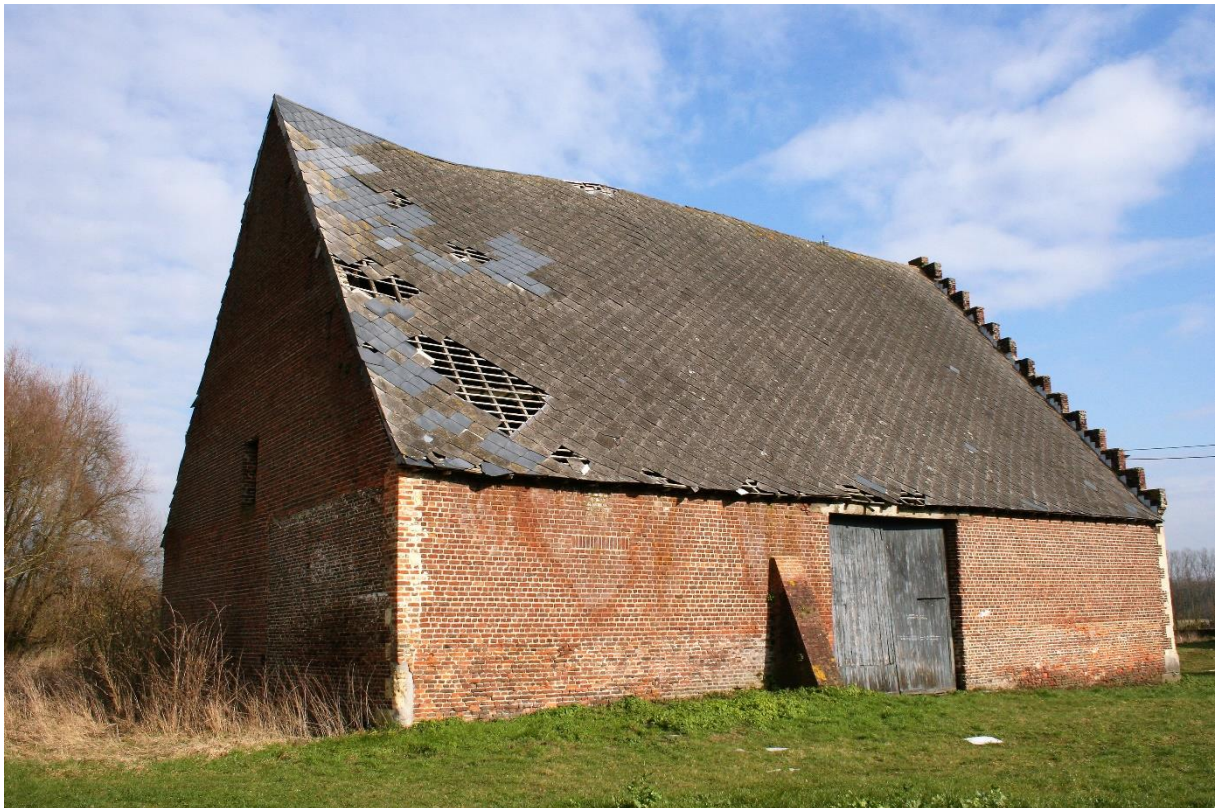
Foto 5: Oude infirmerie, westelijke puntgevel en zuidelijke zijgevel (toestand 25.02.2016)
