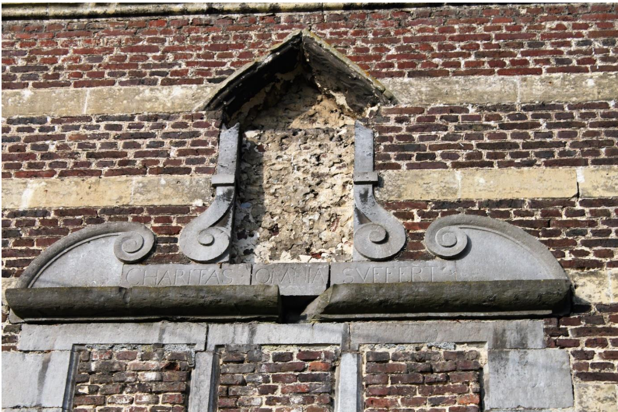
Foto 10: Oude infirmerie, oostgerichte trapgevel, detail poorttravee (toestand 14.03.2017)
