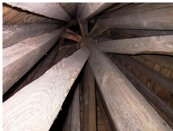
links : gezicht op het eerste juk van de spits. De staven zijn de aandrijfstangen van de wijzers van het torenuurwerk rechts : gezicht op het hoogste torenjuk, net onder de top van de spits
