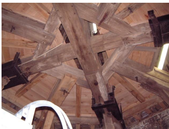
links : gezicht op het stervormige spant waarop de spits aanzet rechts : gezicht op de vloer van de spits vanuit de derde torenverdieping
