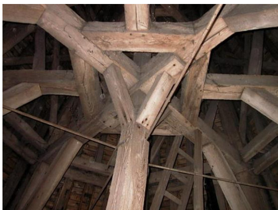
links : gezicht op het eerste juk van de spits. De staven zijn de aandrijfstangen van de wijzers van het torenuurwerk rechts : gezicht op het hoogste torenjuk, net onder de top van de spits
