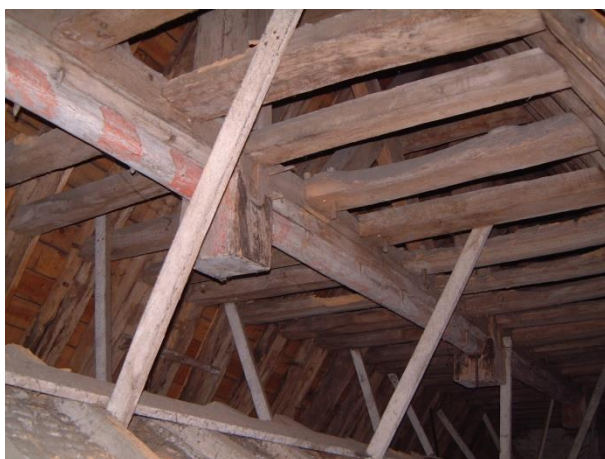
links : Gezicht in het zuidelijke nevenkoor. De koningstijlen zijn duidelijk afgezaagd. De verticale pennen in de hanenbalken, net vóór de middenflering, zijn de bevestigingen van de voormalige formelen van de oorspronkelijke gewelfbebording. Onderaan zichtbaar is de gepleisterde tongewelfbekleding.
