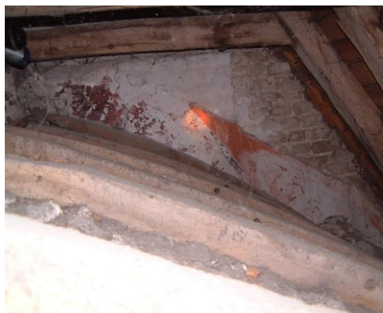
links : Gezicht in het zuidelijk nevenkoor. Onder de afgezaagde koningstijl van de oostelijke gevelmuur zit een console, uitgewerkt als een naïef gezichtje. Opvallend zijn de resten van muurbeschilderingen overeenkomend met de oudste tongewelfbekleding.
