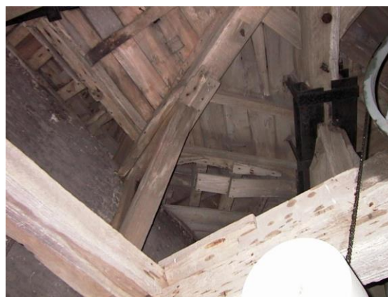
links : gezicht op het stervormige spant waarop de spits aanzet rechts : gezicht op de vloer van de spits vanuit de derde torenverdieping
