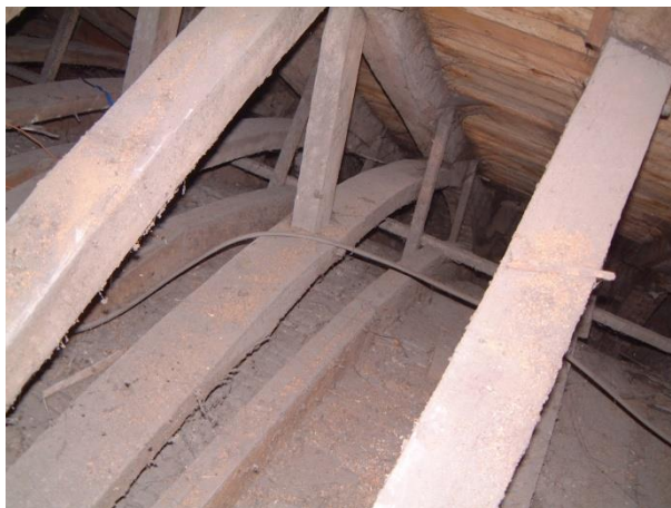
Gezicht in het dak van het hoogkoor. De formelen van de oorspronkelijke tongewelfbebording zijn zichtbaar boven de gedeeltelijk bewaarde tongewelfbepleistering. Onder deze bepleistering zit de huidige tongewelfbekleding met houten schrootjes die vanuit de kerk zichtbaar is.
