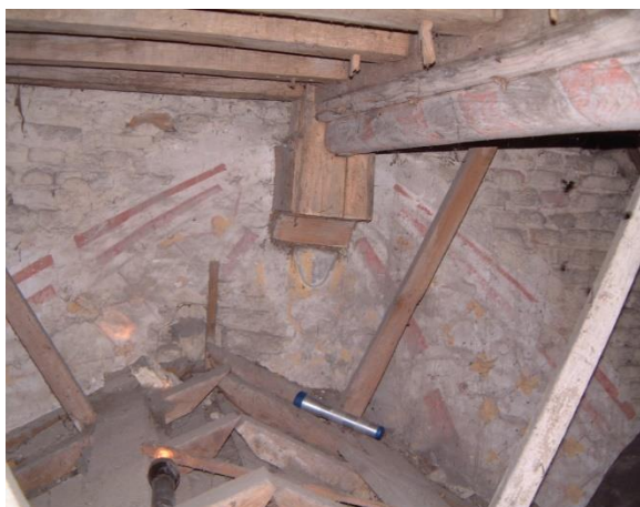
links : Gezicht in het zuidelijk nevenkoor. Onder de afgezaagde koningstijl van de oostelijke gevelmuur zit een console, uitgewerkt als een naïef gezichtje. Opvallend zijn de resten van muurbeschilderingen overeenkomend met de oudste tongewelfbekleding.
