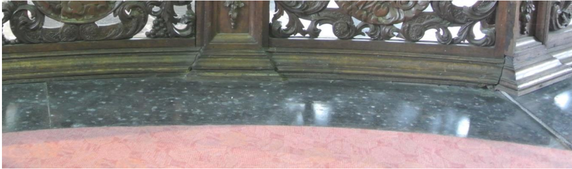
traptrede voor de communiebank. Elke witte vlek op de hardsteen is een urineplek
