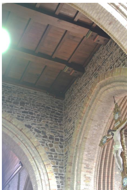
gezicht op de balkenlaag in de viering
