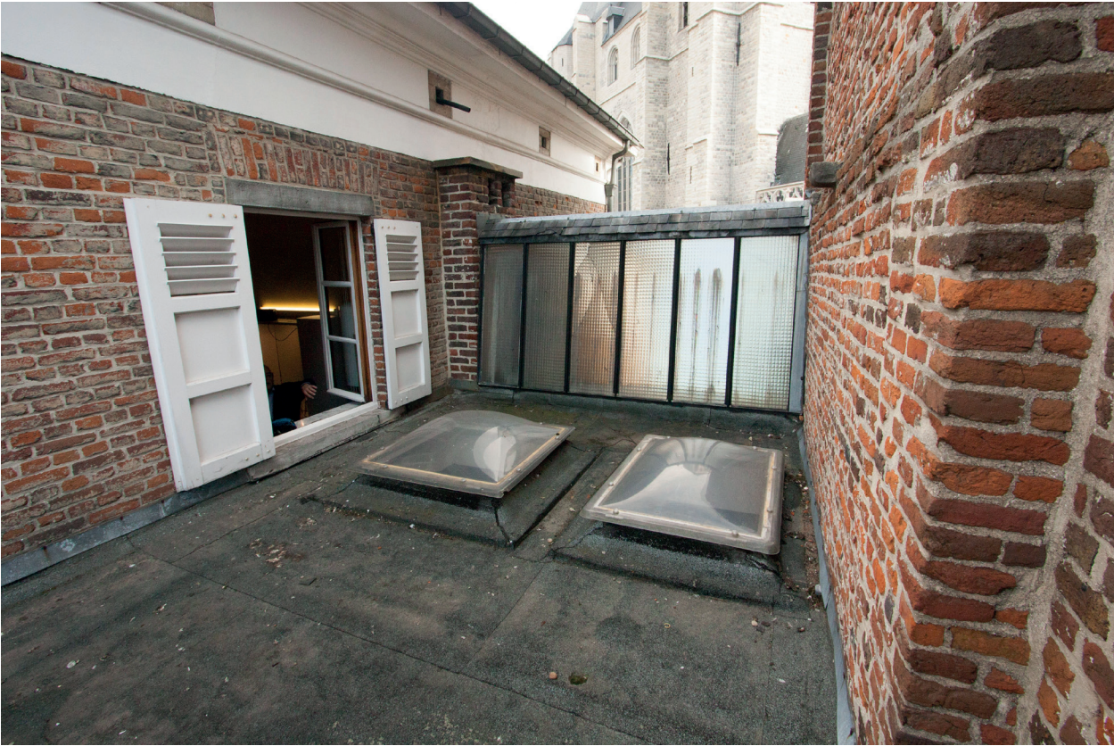
Afb. 038. linkerzijgevel- zicht naar voorgevel
