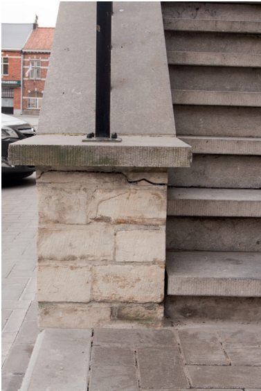
Afb. 020. afscheuring witte steen
