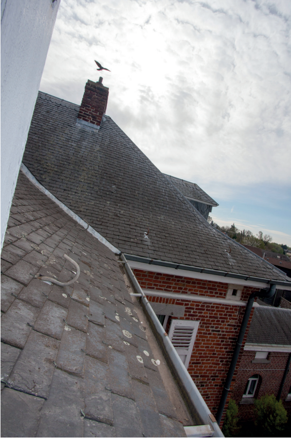
Afb. 063. zicht op leidendak vanuit centrale dakkapel achtergevel
