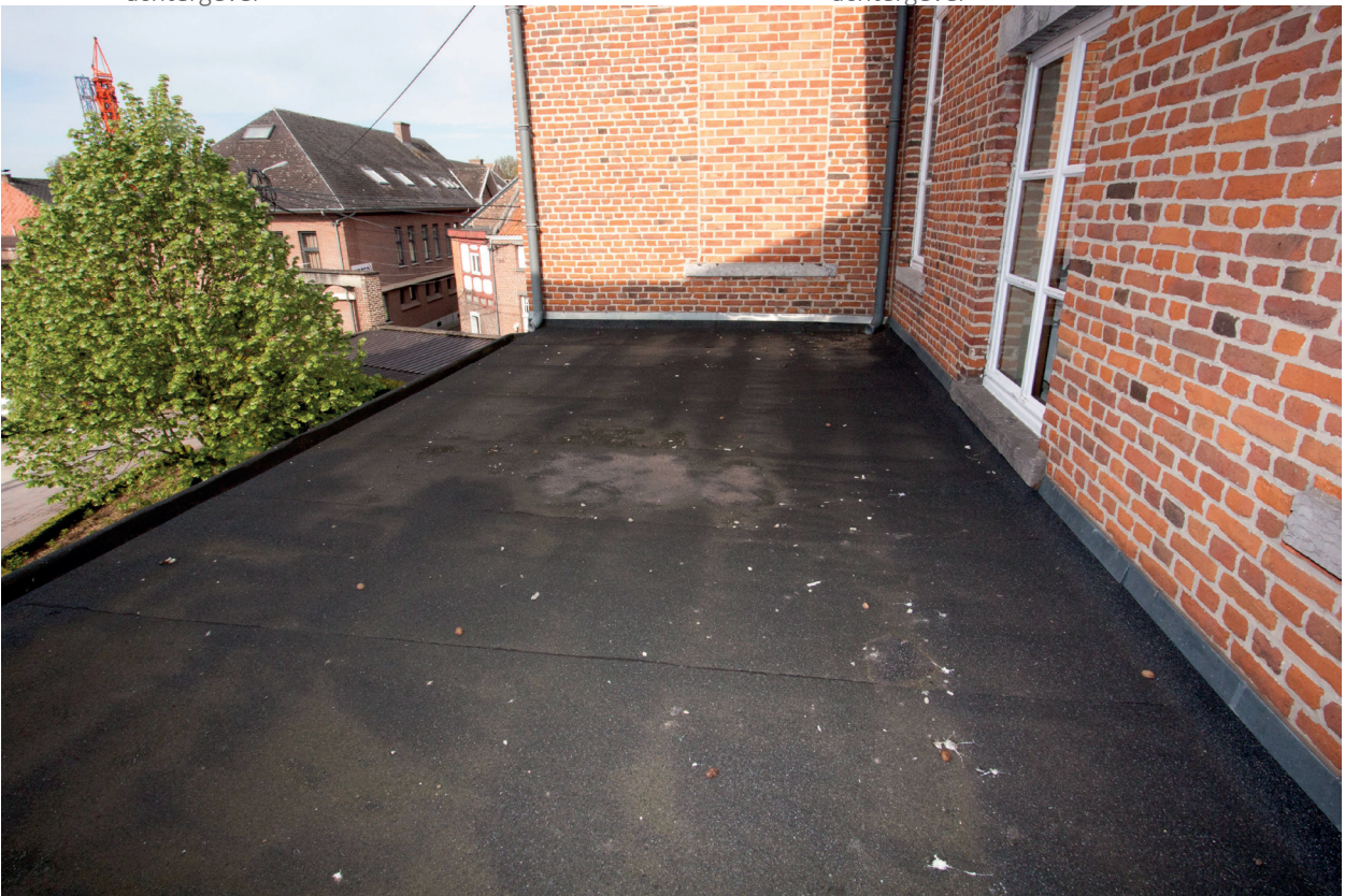
Afb. 065. platte dak boven zitkamer 0.13
