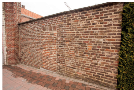
Afb. 060. Zijmuur garageboxen (deur dichtgemetseld)
