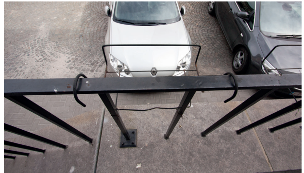
Afb. 023. bovenzicht balustrade thv bordes
