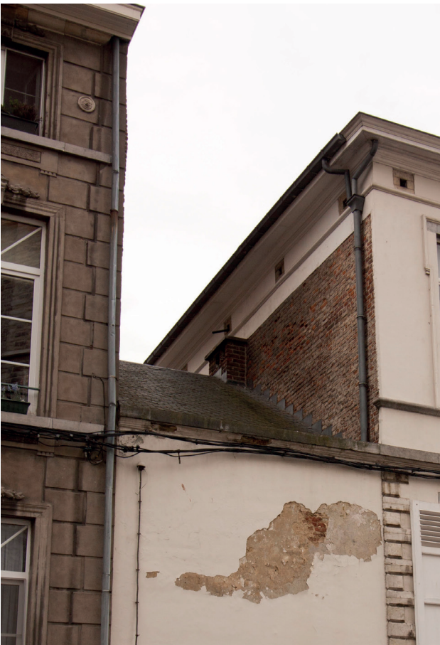
Afb. 039. linkerzijgevel- zicht aan de voorgevel
