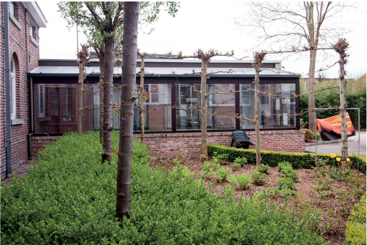
Afb. 047. zijgevel gang catecheselokaal
