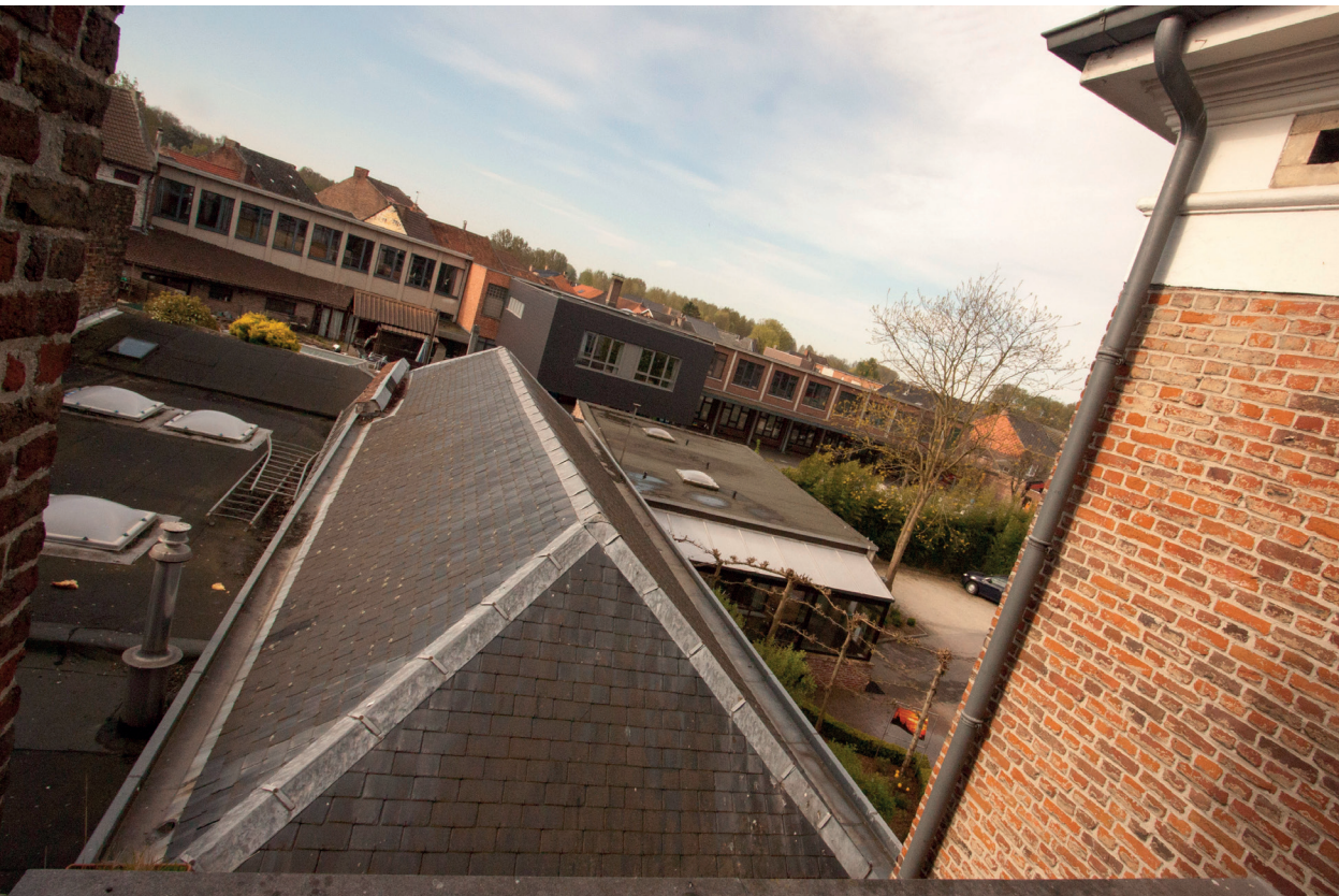
Afb. 070. bovenaanzicht van het dak van de bijgebouwen (vanaf platte dak linkerbijgebouw)
