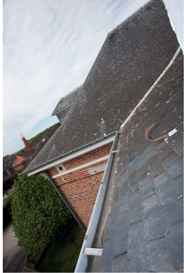
Afb. 064. zicht op leidendak vanuit centrale dakkapel achtergevel
