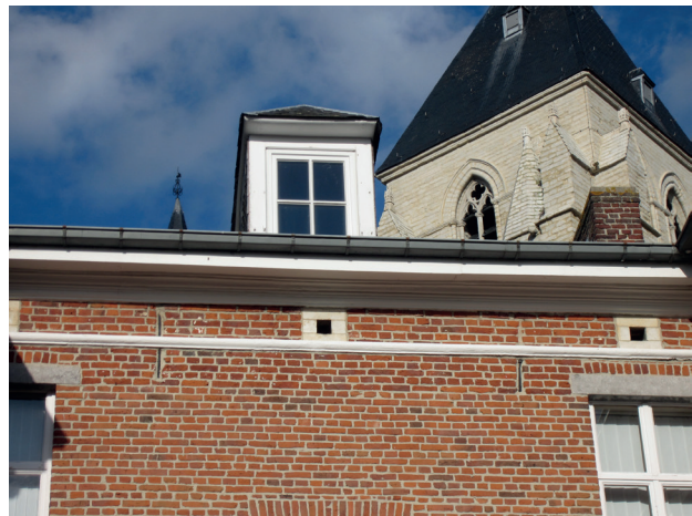
Afb. 033. kroonlijst achtergevel (verzonken gevelankers)
