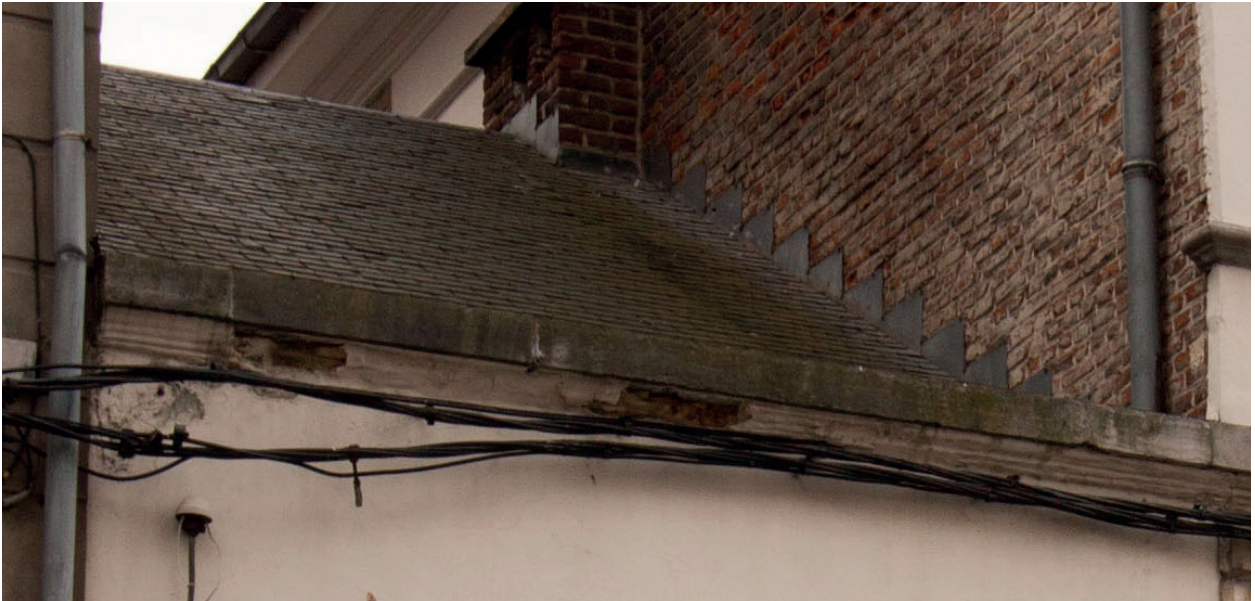
Afb. 066. leidendak van het linkerbijgebouw aan de voorgevel
