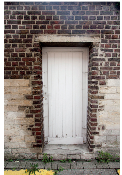
Afb. 050. zicht op de toegangsdeur in de tuinmuur
