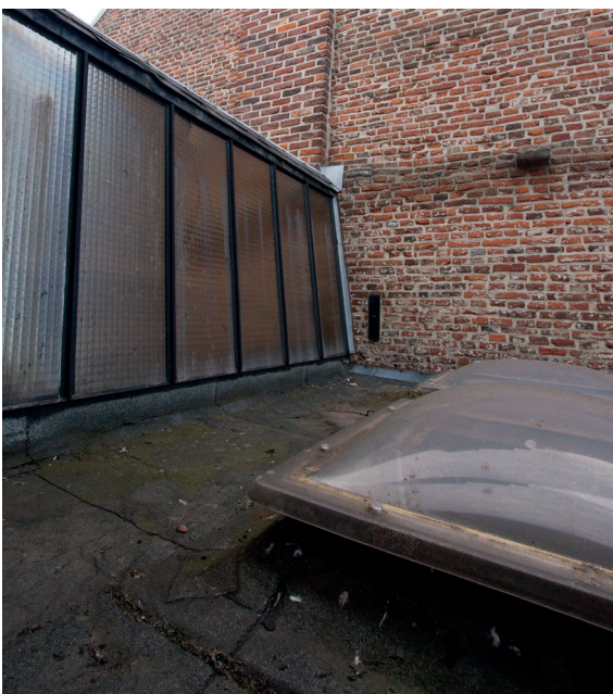
Afb. 068. buitenaanzicht van de lichtstraat van het linkerbijgebouw
