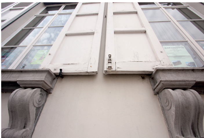
Afb. 024. ontbrekend luikmannetje en verschaald schilderwerk
