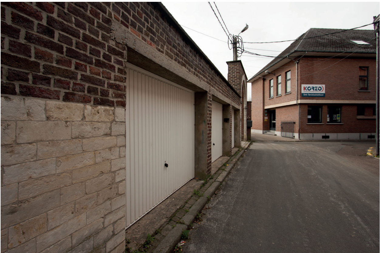
Afb. 005. Zicht op tuinmuur richting Predikherenstraat
