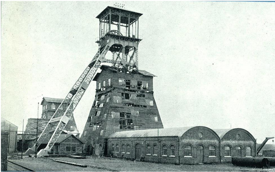
Figuur 4: De schachtbok in opbouw. © B. DELBROEK, F. DELARBRE, S. KRUL, L. MINTEN, C. NELIS, De Koolputters. Geschiedenis van de Limburgse Mijnwerkers , Waanders uitgevers i.s.m. het Vlaams Mijnmuseum en het Museum van de Mijnwerkerswoning, Zwolle, 2006.
