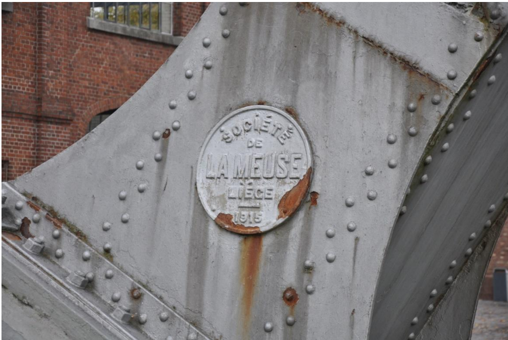
Figuur 10: Foto ter plaatse. © Studiebureau Monumentenzorg.
