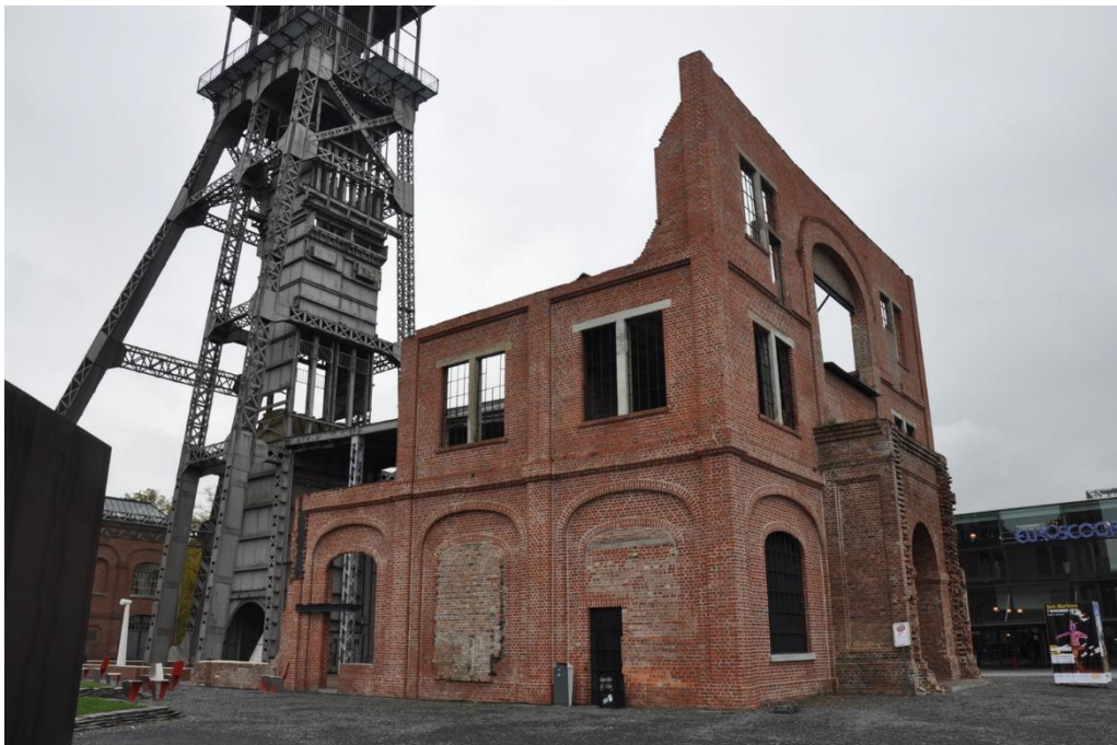
Figuur 32: Huidige situatie ontvangstgebouw. © Studiebureau Monumentenzorg.
