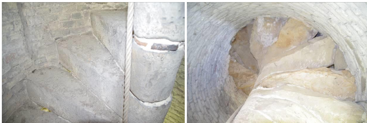
Figuur 176 en 177: Natuurstenen spiltrap onderste twee torenverdiepingen.
