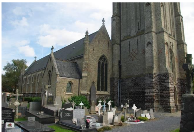
Figuur 75 : westgevel van de noordbeuk en doopkapel
