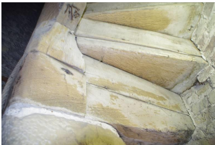
Figuur 180 : Houten spiltrap, aanzet boven de stenen trap en zicht op de onderzijde van de treden.
