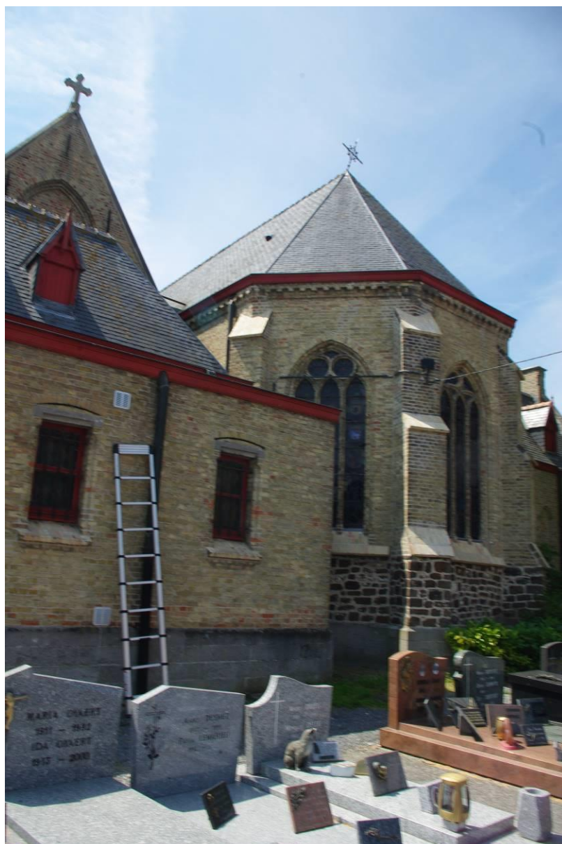
Figuur 72 : Zicht op het polygonale kooreinde en (links) de nutsgebouwen aangebouwd aan de sacristie.
