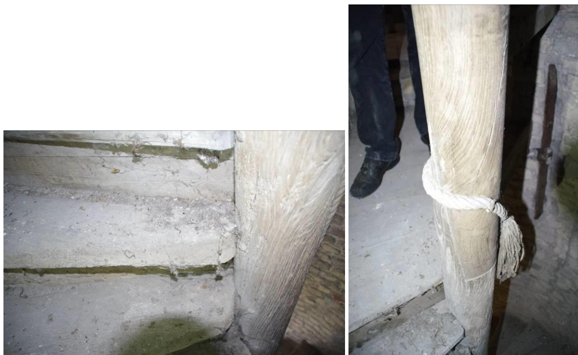
Figuur 178 en 179 : Houten spiltrap – bovenste verdiepingen.
