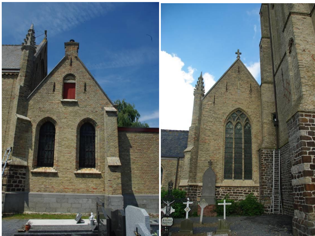
Figuur 73 : Zicht op de zuidgevel van de sacristie en op de eindgevel van het zuidkoor.
