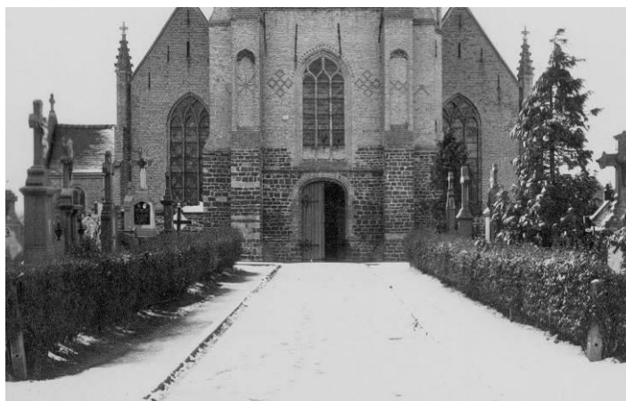
Figuur 188 : Verharding voor de kerk in 1961 in baksteen klinkers, en verhoogde stoep in beton boordsteen en betontegels (foto www.westhoekverbeeldt.be HEU007500988) – deze erfgoedelementen maken momenteel geen deel meer uit van het kerkhof Sint-Rictruduskerk.
