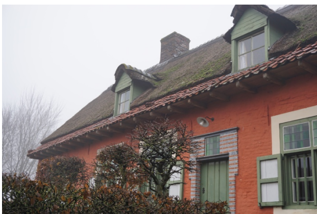
foto 3 veelkleurige baksteen deuroplijsting
