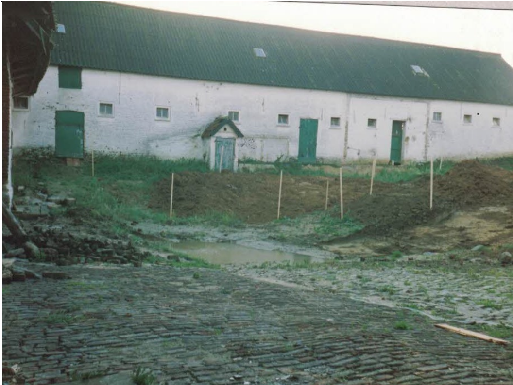
Figuur 15 : foto stalvleugel voor restauratie
