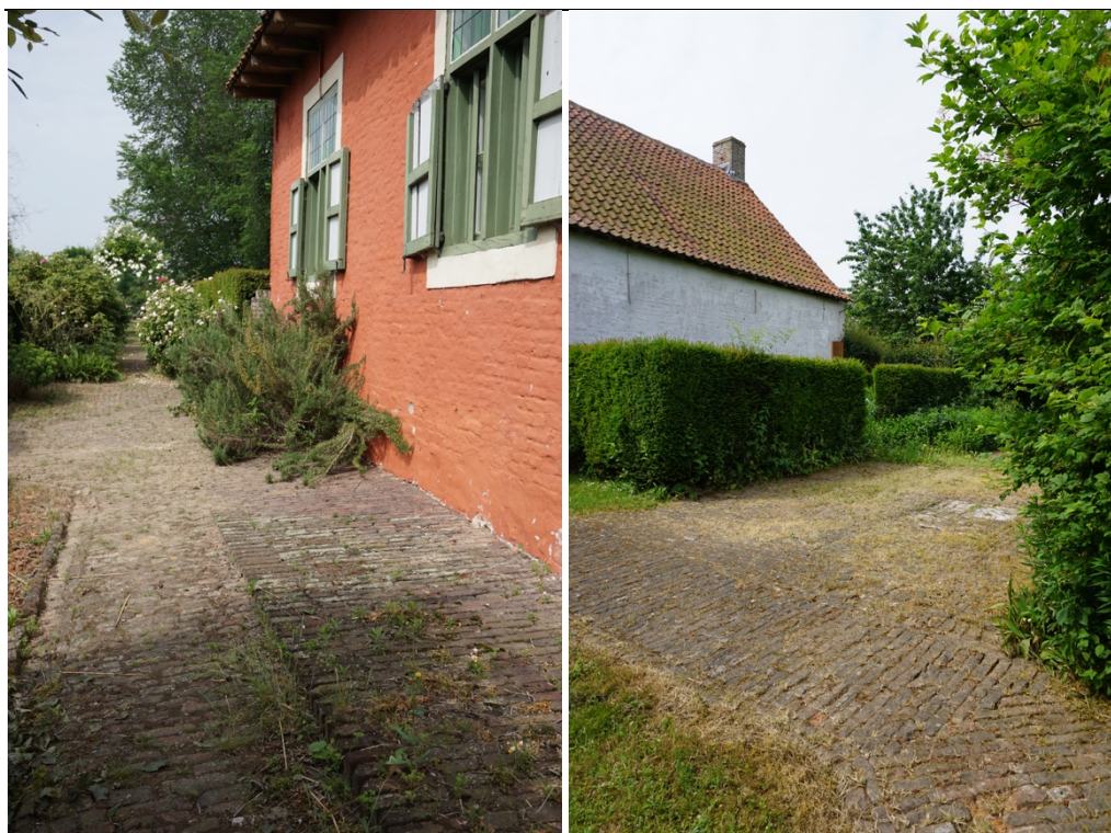
Foto 31 : verharding in baksteen tegen zuidgevel woning Foto 32 : verharding in vroegere doornit schuur
