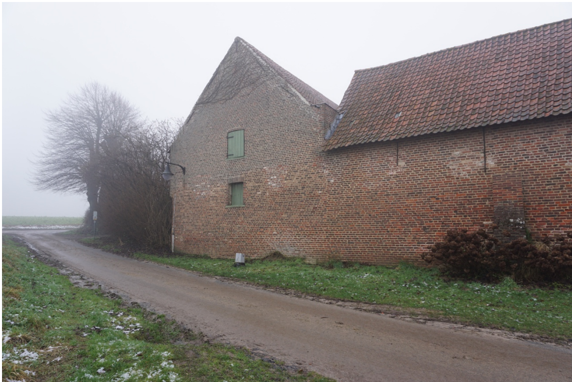
Foto 9 : straatgevel oostvleugel – zuidelijke helft & straatgevel zuidelijke stallen
