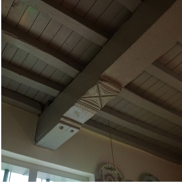
foto 5 balkenlaag met versierde moerbalk
