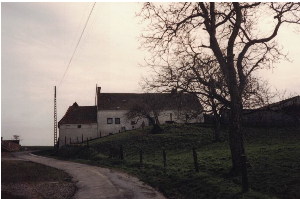
Figuur 14 : foto noordzijde voor de restauratie
