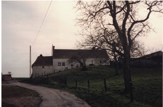
Figuur 21 : noordzijde voor restauratie, op de voorgrond de bewaarde es
