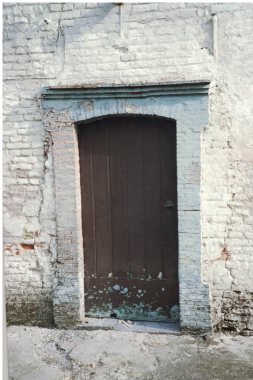
Figuur 16 : detail deur noordzijde voor restauratie
