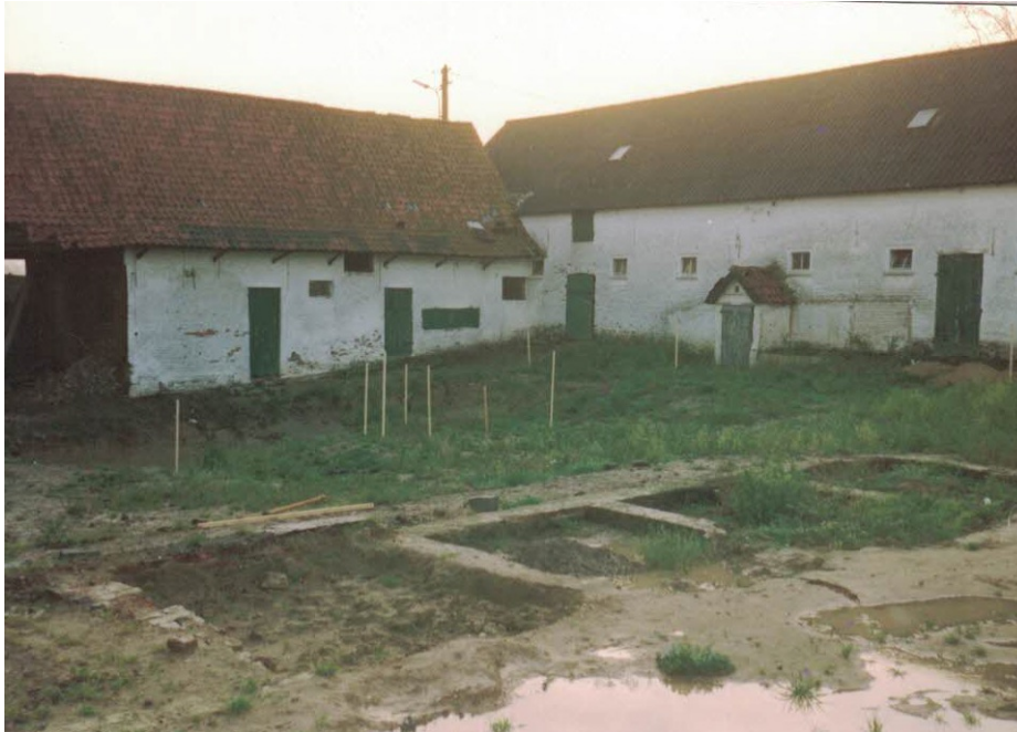
Foto 34 : binnenkoer tijdens de restauratie met zicht op de funderingen van de afgebrande vleugel
