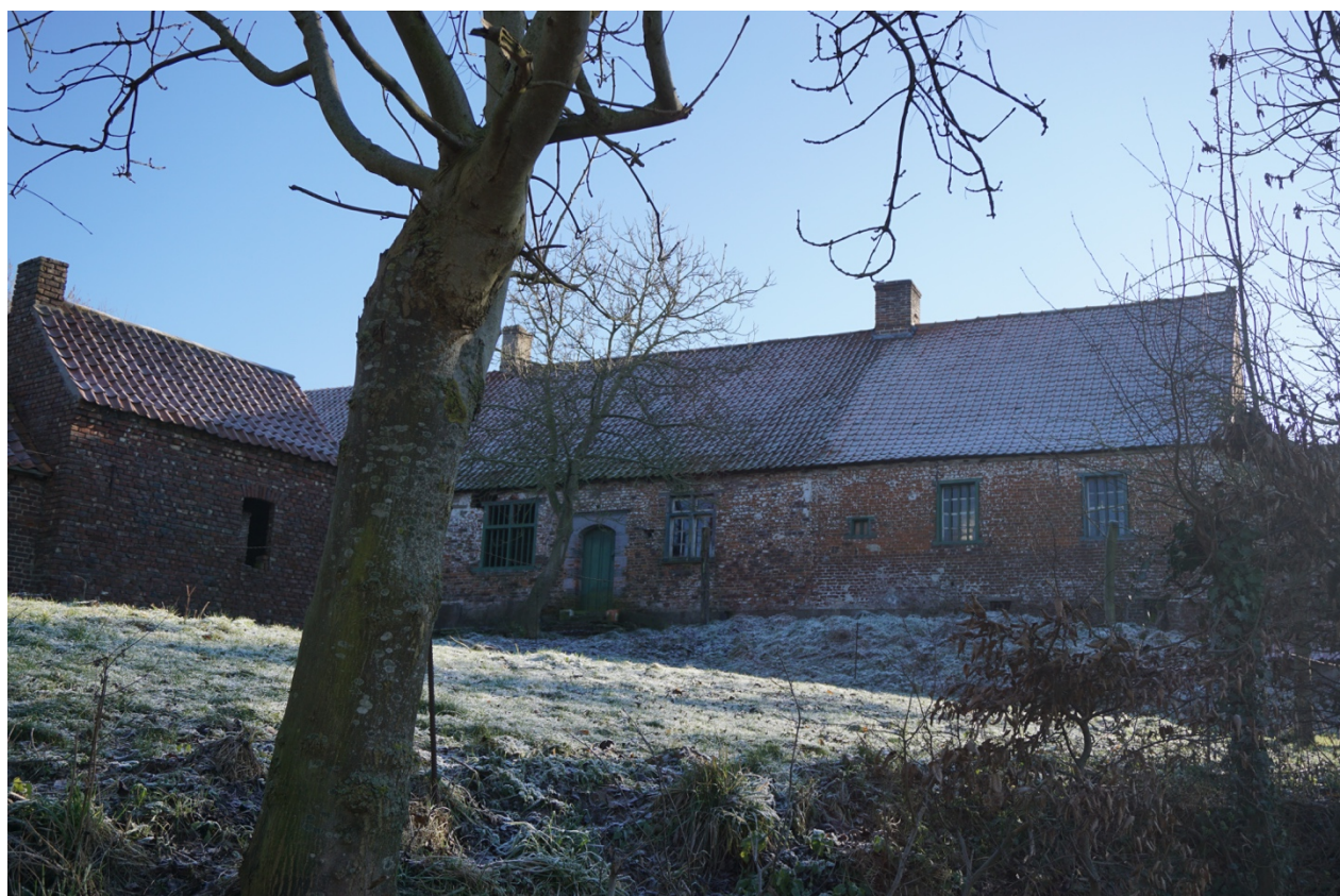
Foto 8 : het hof te Wylegem - noordgevel
