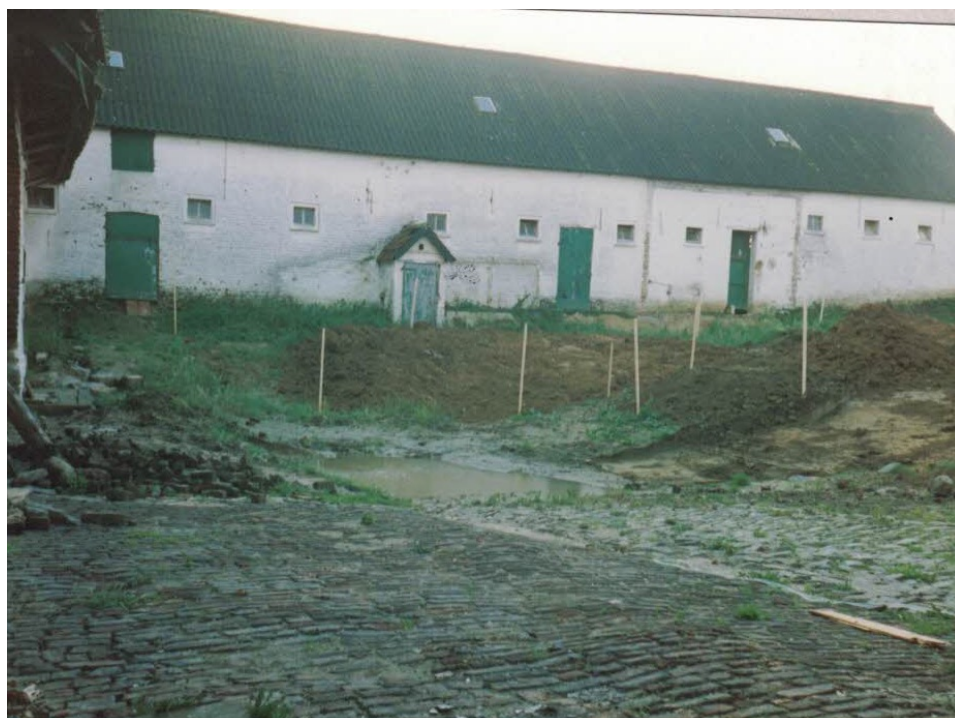
Foto 30 : oorspronkelijke verharding thv de poortdoorgang
