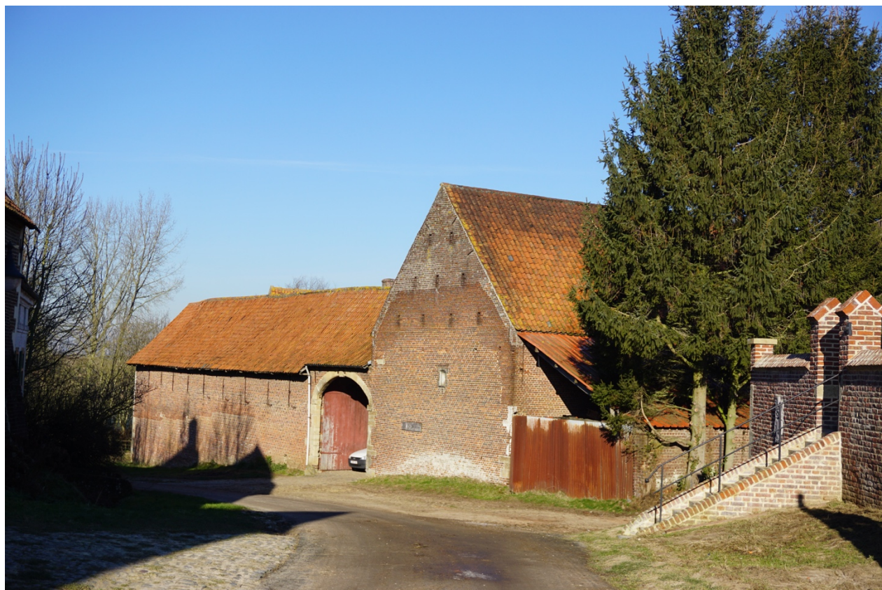
Foto 7 : het hof te Wylegem - straatgevel
