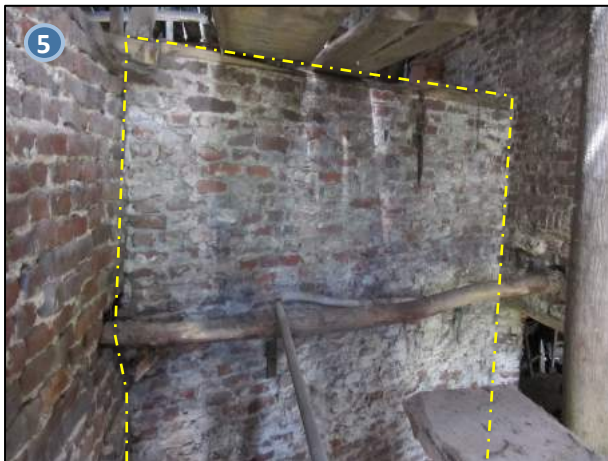
Foto 86 - toegemetsde doorgang van ketelhuis naar stallen
