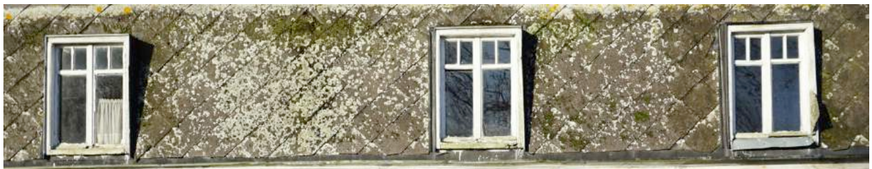
foto 29 - ramen eerste verdieping achtergevel
