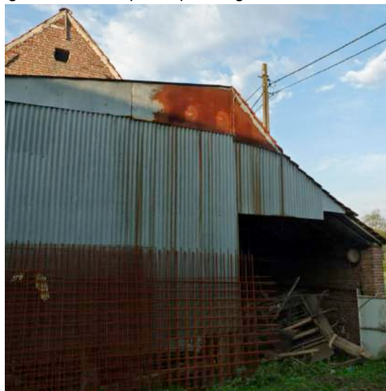
foto 44 - noordelijke aanbouw aan schuur.
