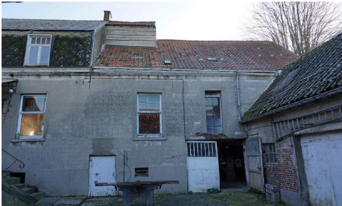
Foto 10 - zicht op voorgevel deel molen
