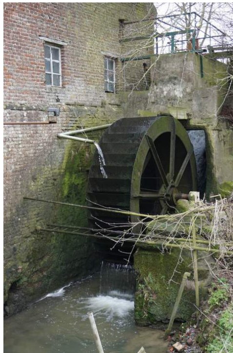
Foto 3 - het 'vernieuwde' waterrad en sluiswerk
