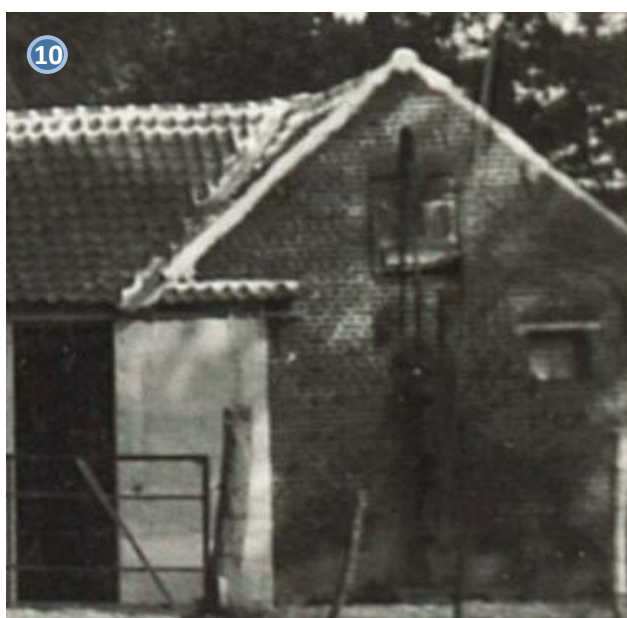
Foto 47- aalpompe aan gevel poortgebouw (straatkant)
