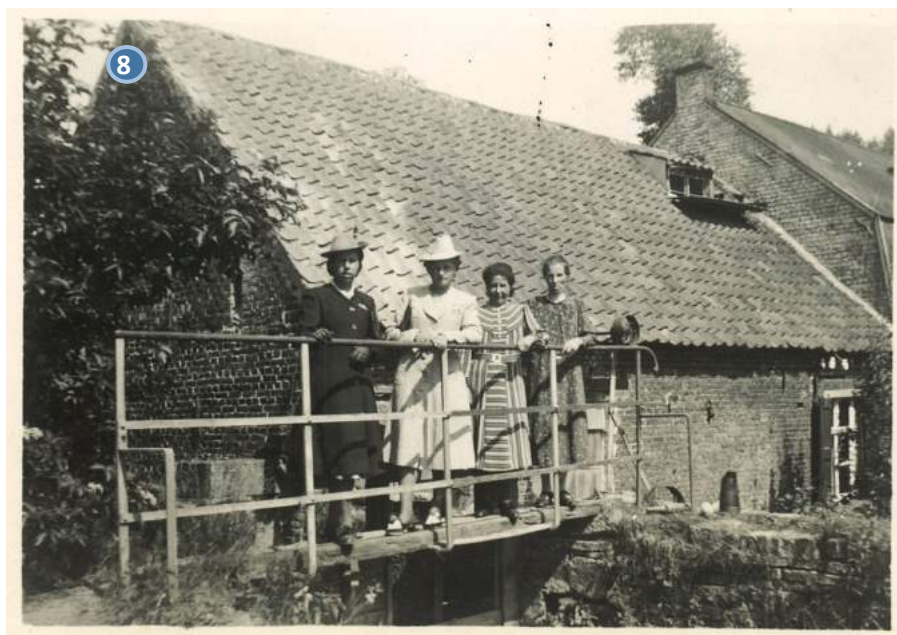
Foto 73 - zicht op de achtergevel van de molen en brug met sluiswerk (begin jaren '40)
