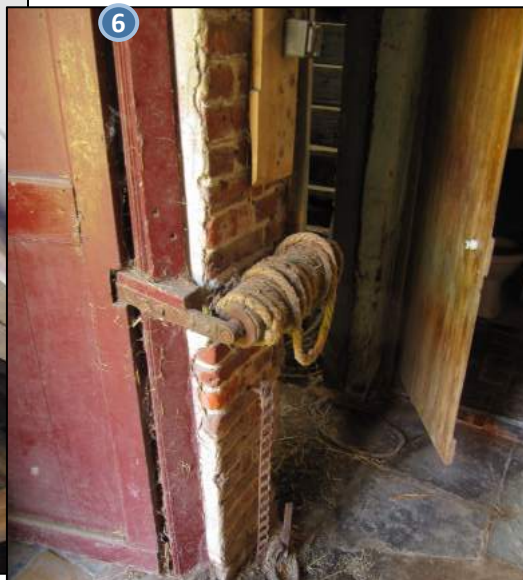
Foto 67 - windas voor het binnentrekken van karren
