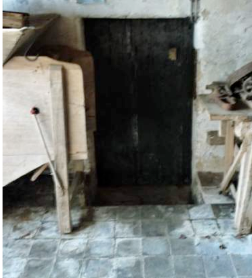
foto 101 - toegang tot kelder
