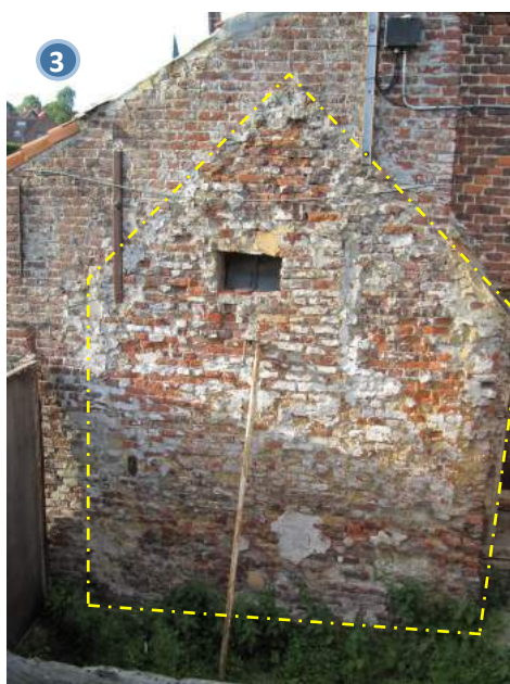
Foto 52 - Contouren van oude topgevel
