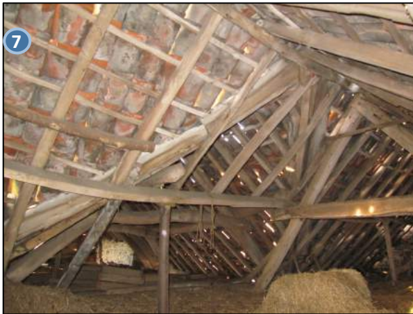
Foto 41 - gebinte poortgebouw, aansluiting overdekte doorgang
