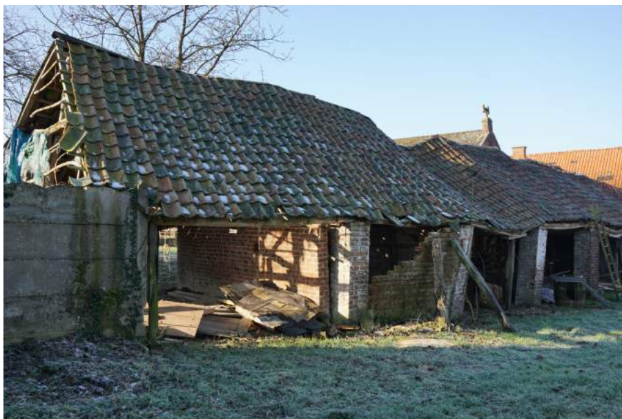
Foto 3b - zicht op de noordoostelijke zijde van de remise
