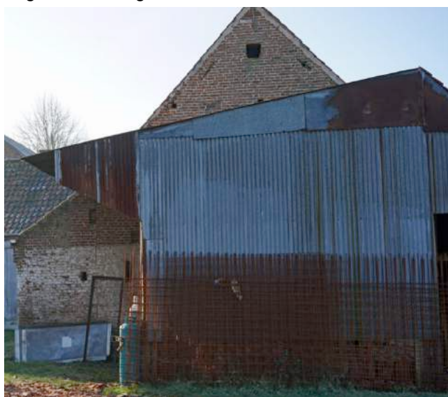
foto 43 - noordelijke aanbouw aan schuur
