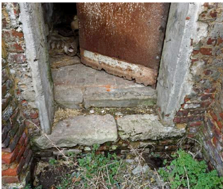
foto 55 - deuropening in zuidelijke gevel
