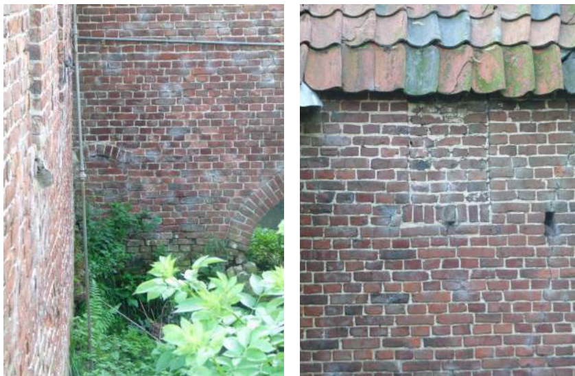
foto 67 en 68- bouwsporen in de westgevel van het voormalige ketelhuis
