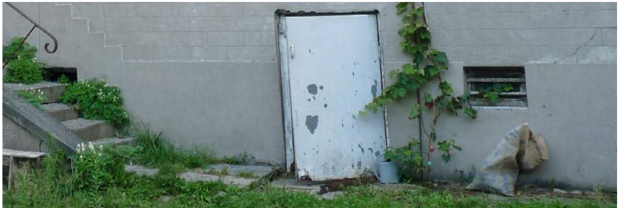
foto 14 - verluchttingsopeningen van de kelder en toegangsdeur tot de kelder
