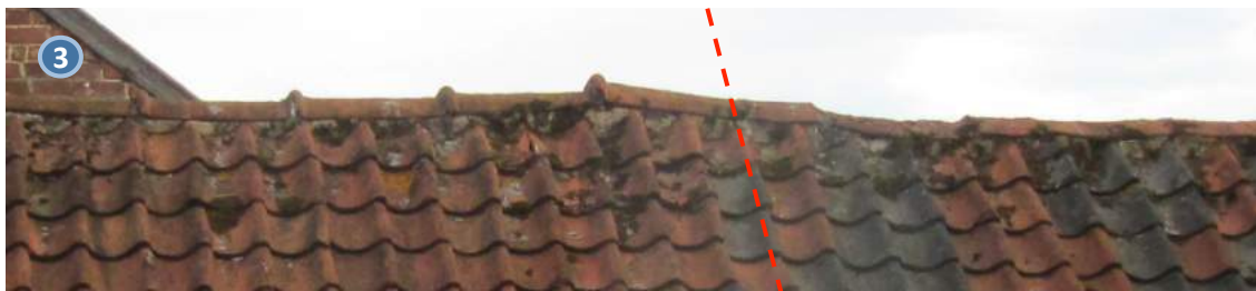
Foto 65 - verandering van nokpannen bij overgang van originele dakoversteek (rechts) naar de dakuitbreiding (links)
