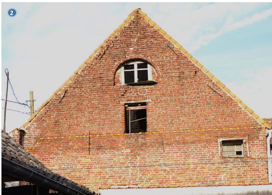
Foto 34 - bouwnaad van de opnieuw gemetste zuidelijke topgevel van de schuur.
