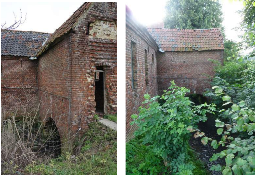
foto 65 en 66 - westgevel stookketellokaal (over de Traveinsbeek)
