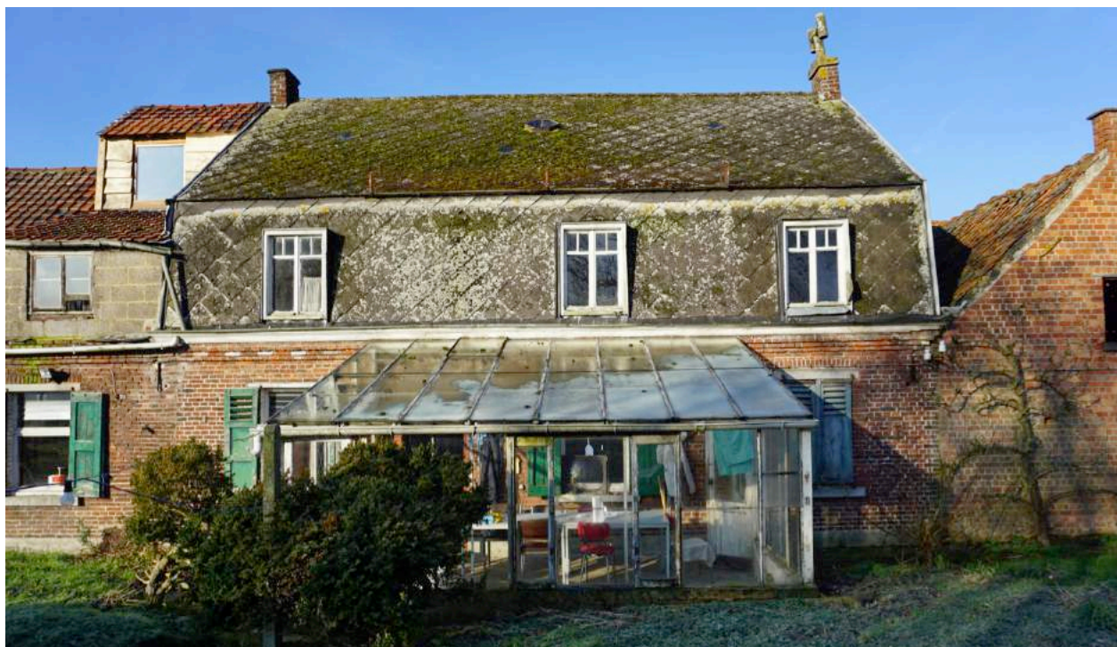
foto 21- achtergevel woning met aangebouwde veranda
