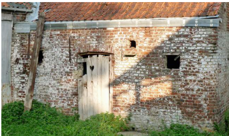
foto 48 - uitbreiding tegen oostgevel schuur
