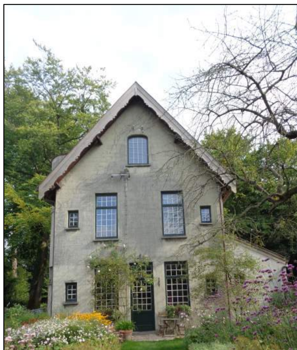
Foto 16 – voorgevel van de woning
