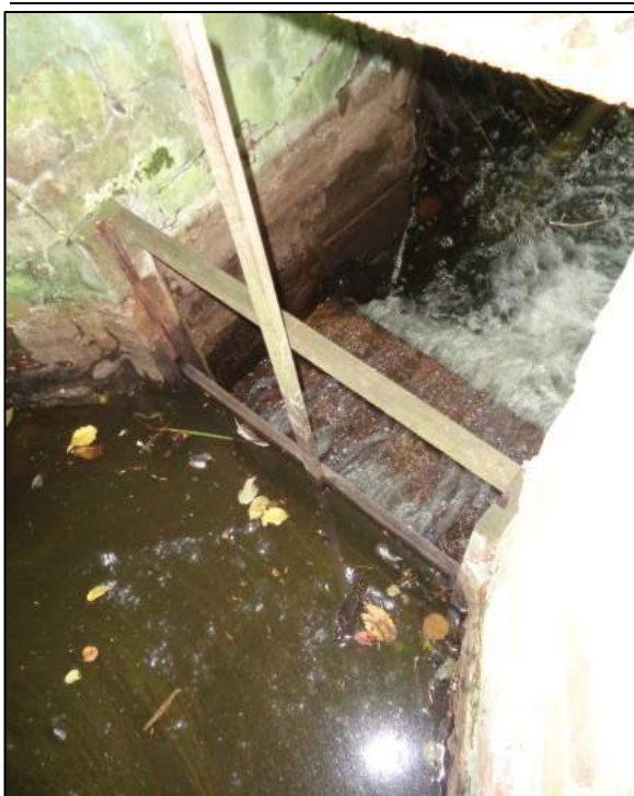
Foto 35 - de zelf geconstrueerde sluis t.h.v. het betonnen brugje
