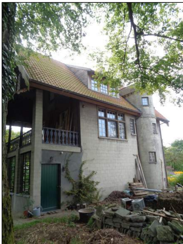
Foto 17 – zijgevel oost van de woning
