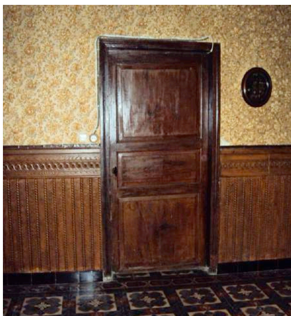
foto 85 - lambrisering en bewaarde paneeldeur
