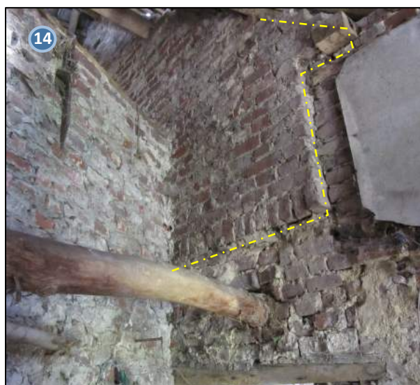
Foto 62 - verhoogde muur stallen & dicht gemetst ketelhuis
