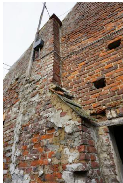
foto 56 - schouw in zuidelijke gevel
