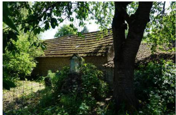
Foto 2 - bakstenen voorgevel schuurtje (noordzijde)
