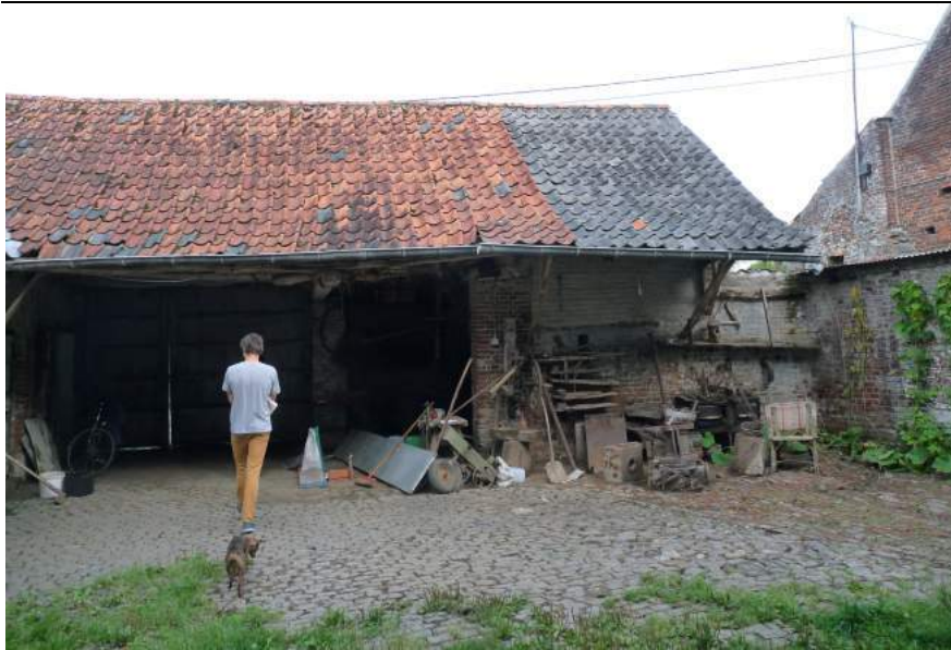
foto 72 - oostgevel poortgebouw ( zijde binnenkoer )
