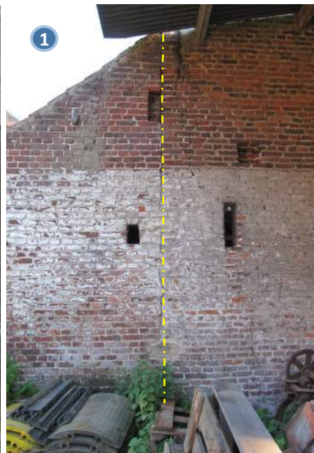
Foto 70 - Bouwnaad tussen schuur en uitbreiding
