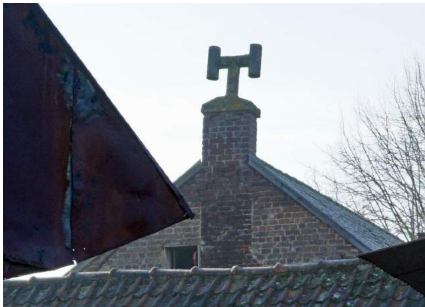
foto 34 - noordelijke topgevel woonhuis
