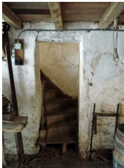
foto 102 - toegang tot de verdieping
