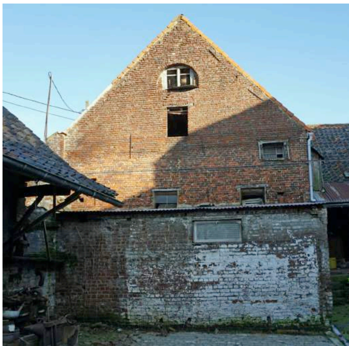
foto 52 - zuidgevel schuur en varkensstal
