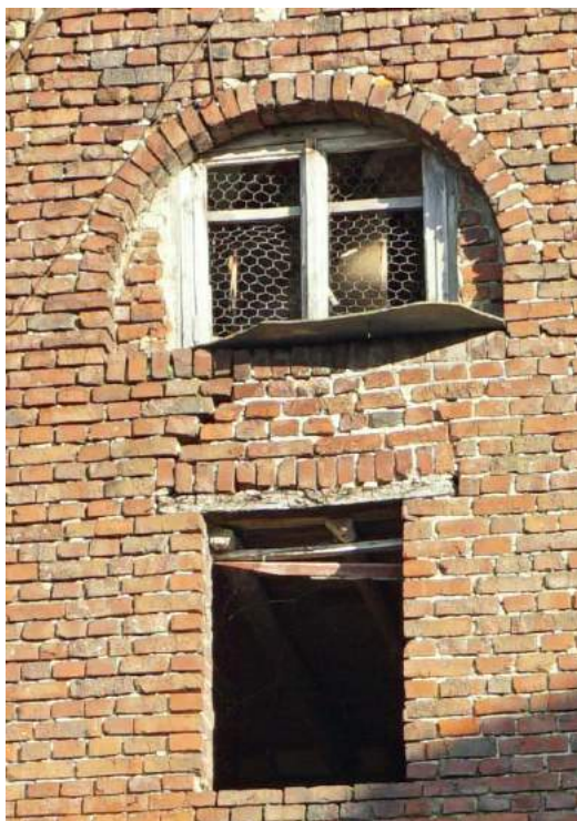
foto 58- raamopeningen in de top van de zuidgevel
