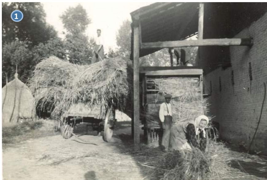
Foto 83 - dorsmachine onder een afdak gebouwd tegen de noordelijke topgevel van de schuur (C)
