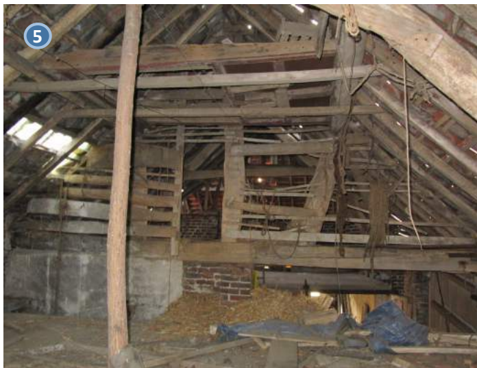
Foto 63 - resten van de topgevel van de oorspronkelijke dakoversteek
