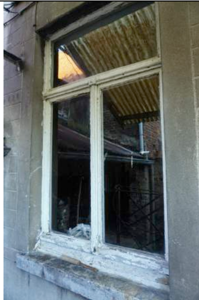
foto 16 - raam met 2 vleugels en bovenlicht
