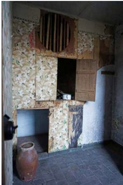
foto 91 - kamer aan westgevel
