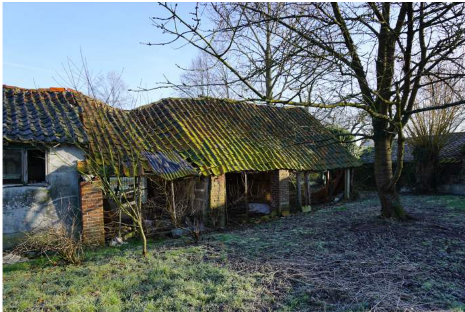
Foto 3c - zicht op de remise (zuidwestelijke zijde)
