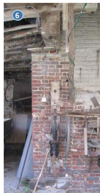
Foto 51 - steunpilaar voor moerbalk
