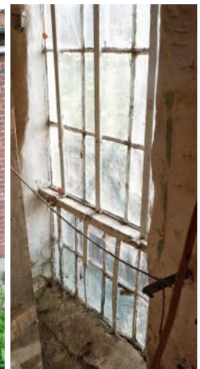
foto 32 - stalen raam binnenzijde
