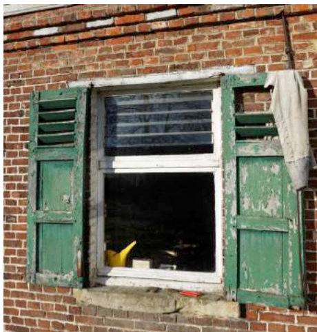
foto 27 - raam met houten ipv natuursteen linteel
