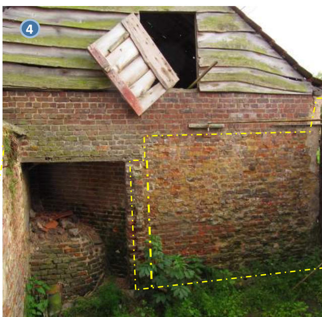
Foto 53 - Contouren oude topgevel en bouwsporen oude zijgevel
