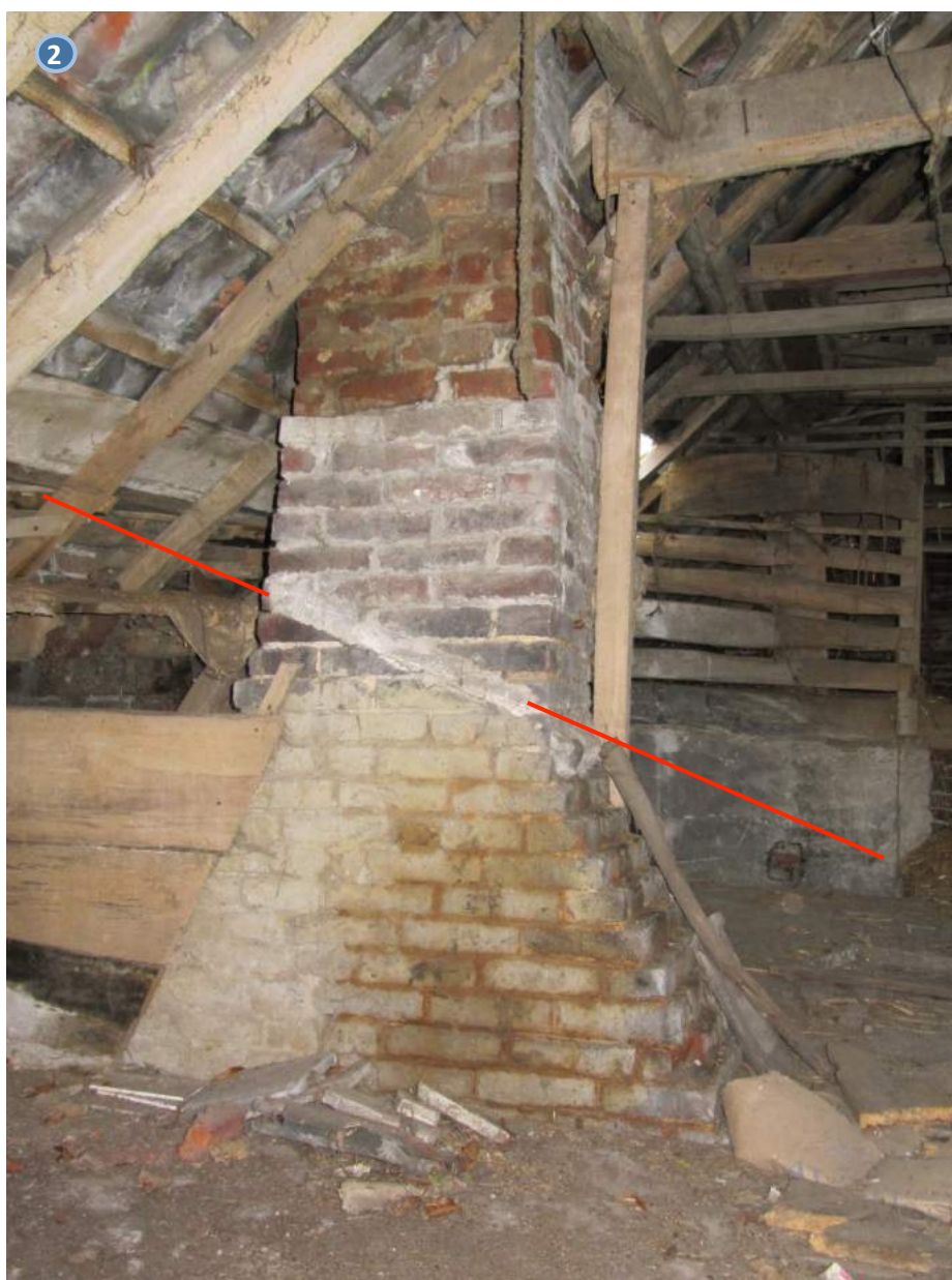
Foto 56 - schouw van de bakoven met sporen van het oude lessenaardak
