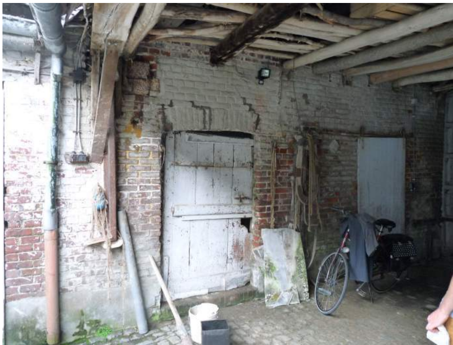
foto 61 - noordgevel machinegebouw thv poortdoorgang
