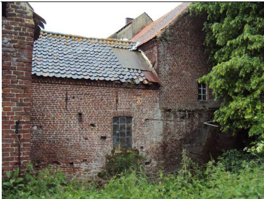
foto 62 - zuidgevel machinegebouw, aansluitend aan de molen
