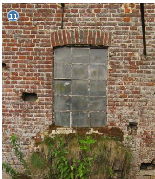
Foto 48 - raam met rollaag in watergevel
