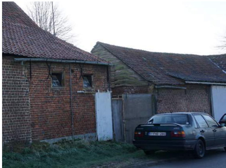
foto 74 - beplankte top noordgevel poortgebouw
