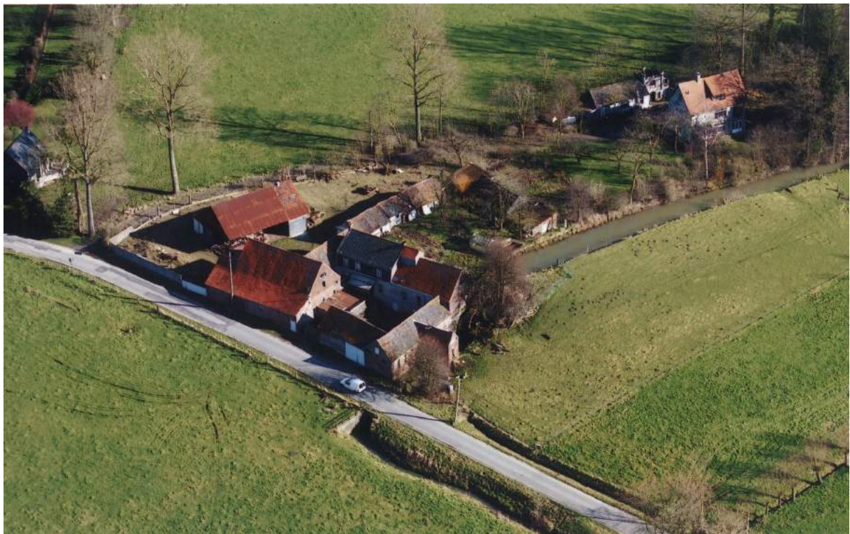
Foto 1 - luchtfoto van de site
