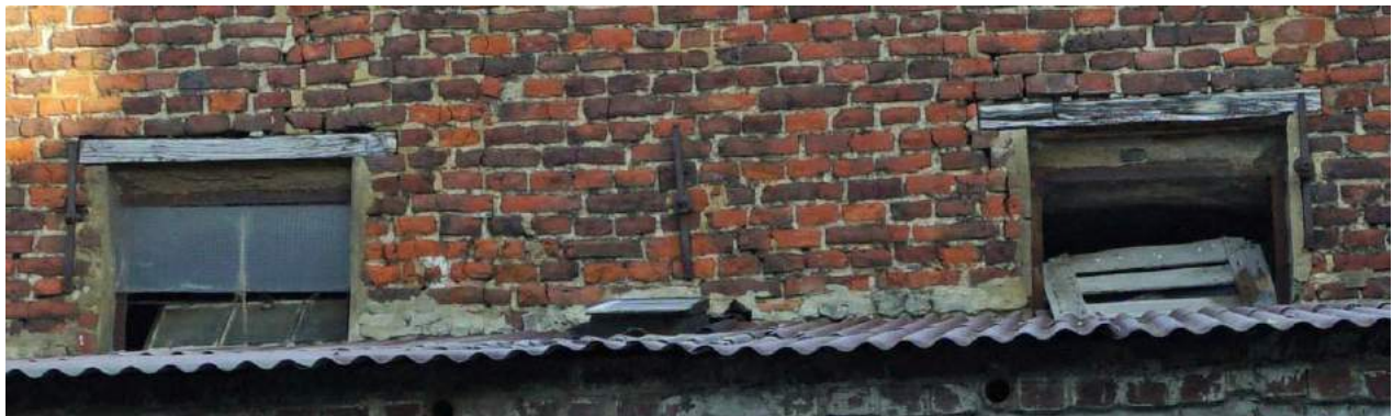
foto 57 - raamopeningen thv stallen zuidgevel
