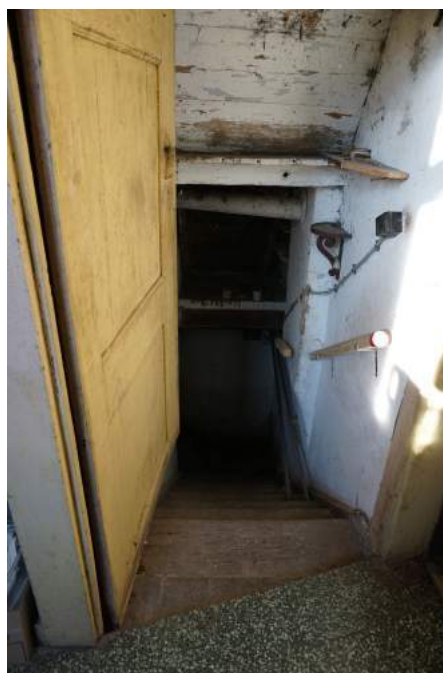
foto 90 - deur naar kelder
