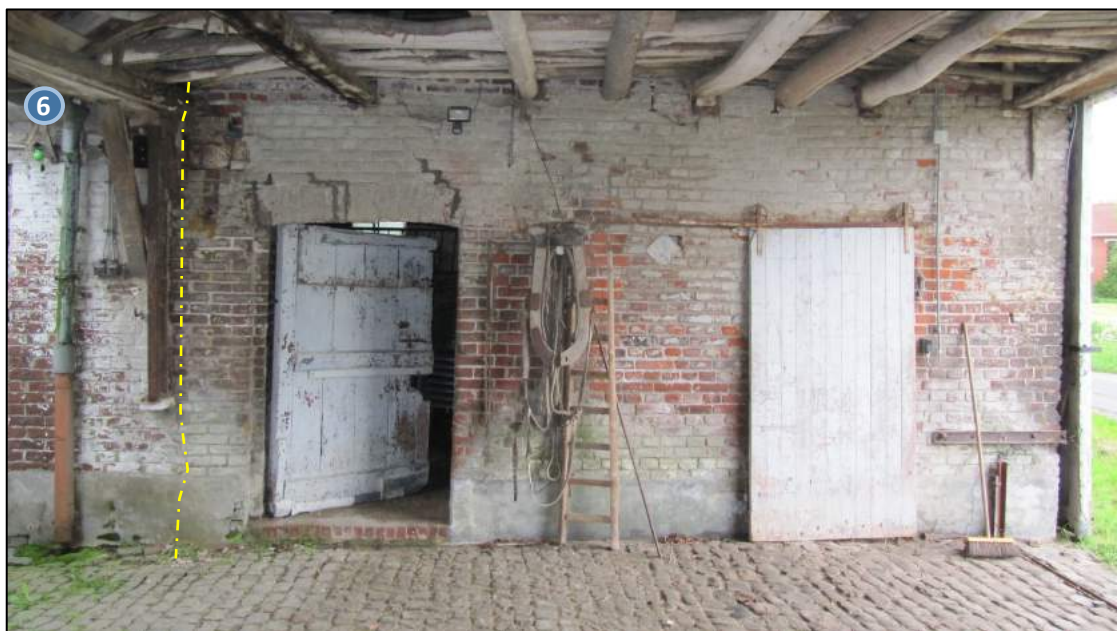
Foto 40 - gevel van het poortgebouw, kant binnenkoer, met aangeduide bouwnaad
