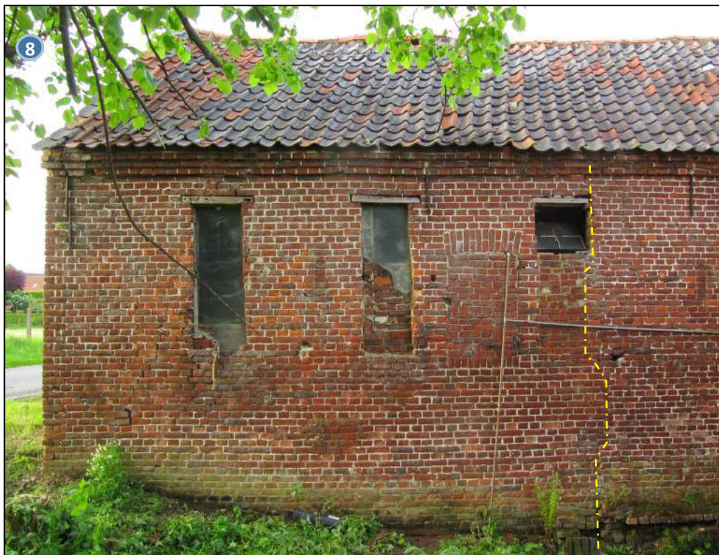
Foto 39 - gevel van het poortgebouw, kant beek, met aangeduide bouwnaad
