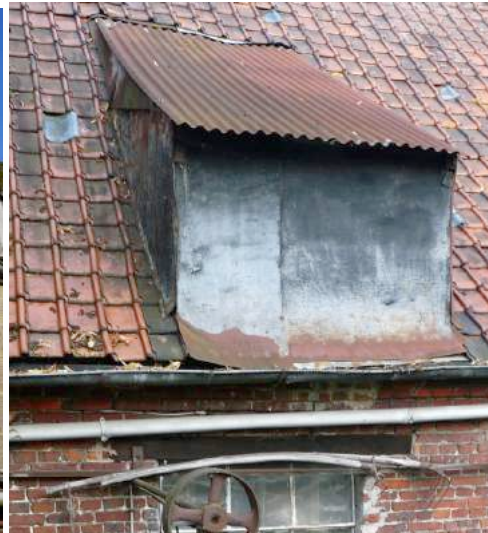
foto 40 - dakkapel in oostelijk dakvlak
