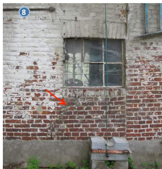
Foto 49 - raam met rollaag, vroeger vermoedelijk deur
