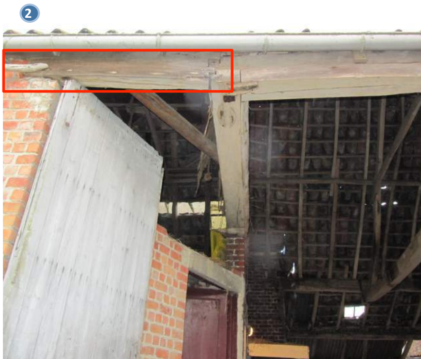
Foto 82 - verbinding tussen oude houten constructie oversteek (rechts) en melkhuis (links)
