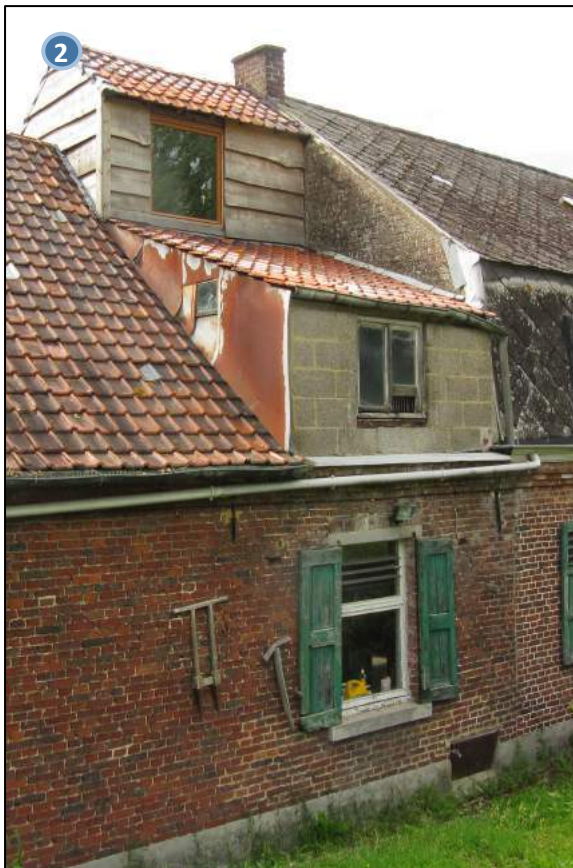
Foto 85 - uitbreidingen in het dak van woonhuis deel I (duivenhokken)
