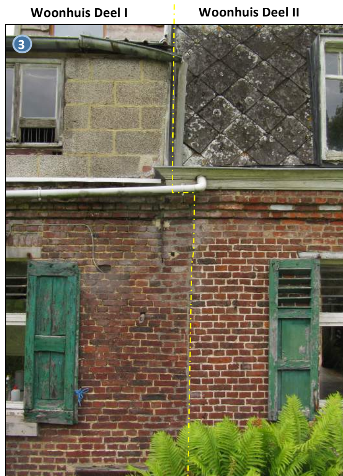
Foto 32 - bouwnaad tussen woongedeelte I en II
