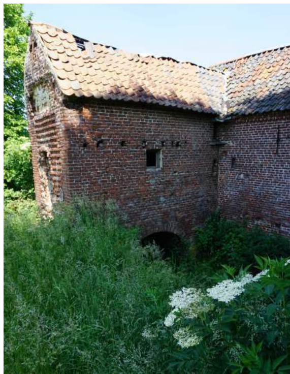
foto 64 - oostgevel stookketellokaal, over de beek
