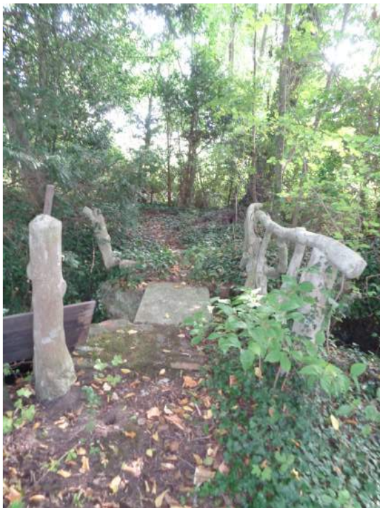
Foto 31 - het rechter bruggetje met betonnen takken
