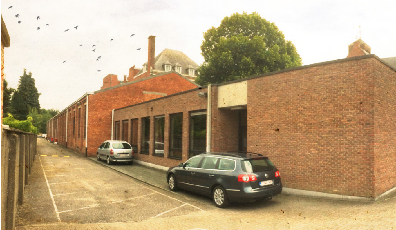
Figuur 57 sfeerbeeld zicht op fietsenstalling/ Gastenhofje en H-blok voor en na
