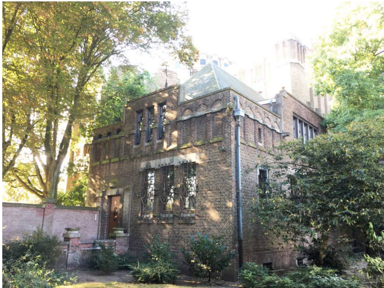
Figuur 8: Zijaanzicht langs de oostzijde van de voormalige sacristie in bestaande toestand
