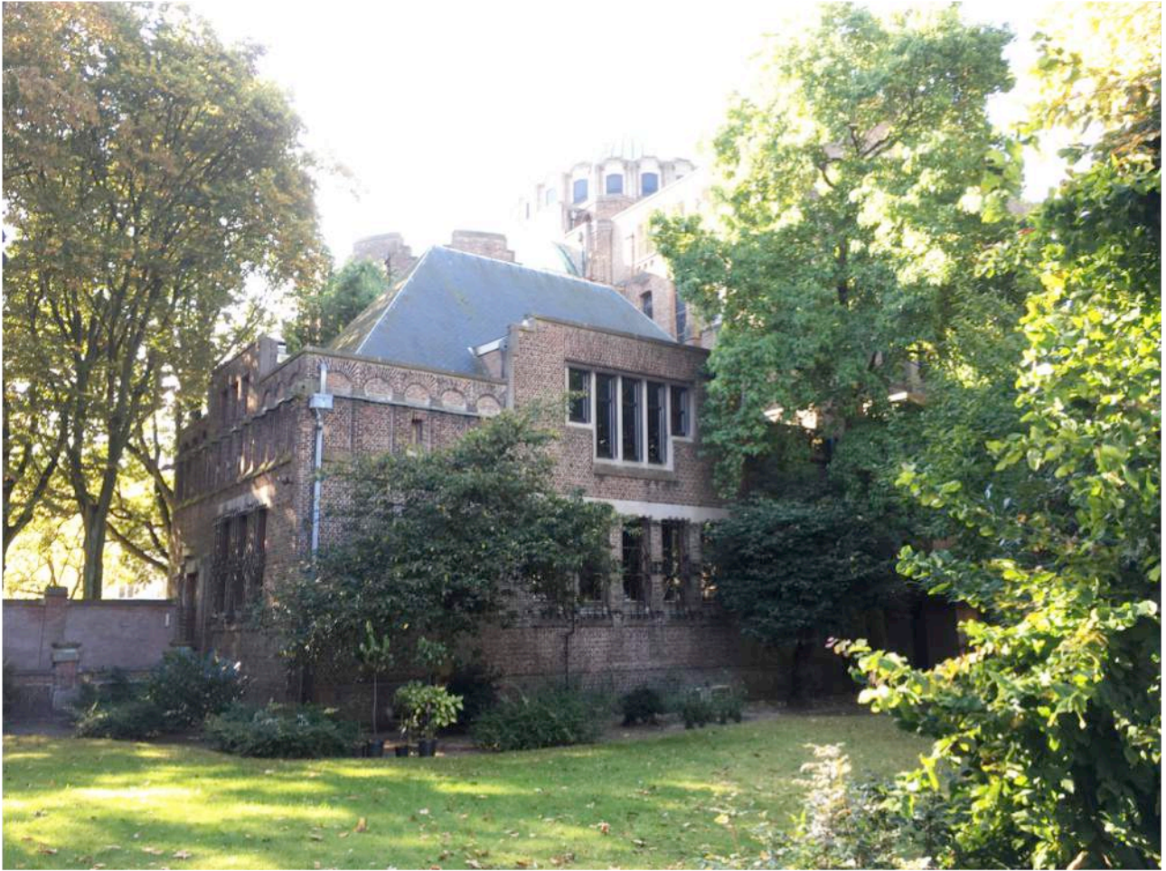
Figuur 24: Noordgevel van de voormalige sacristie in bestaande toestand
