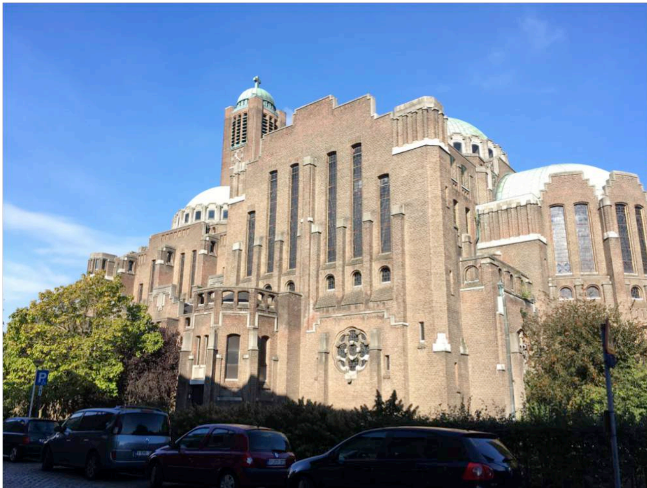
Figuur 15: Zuidgevel van de Kristus-Koningkerk in bestaande toestand
