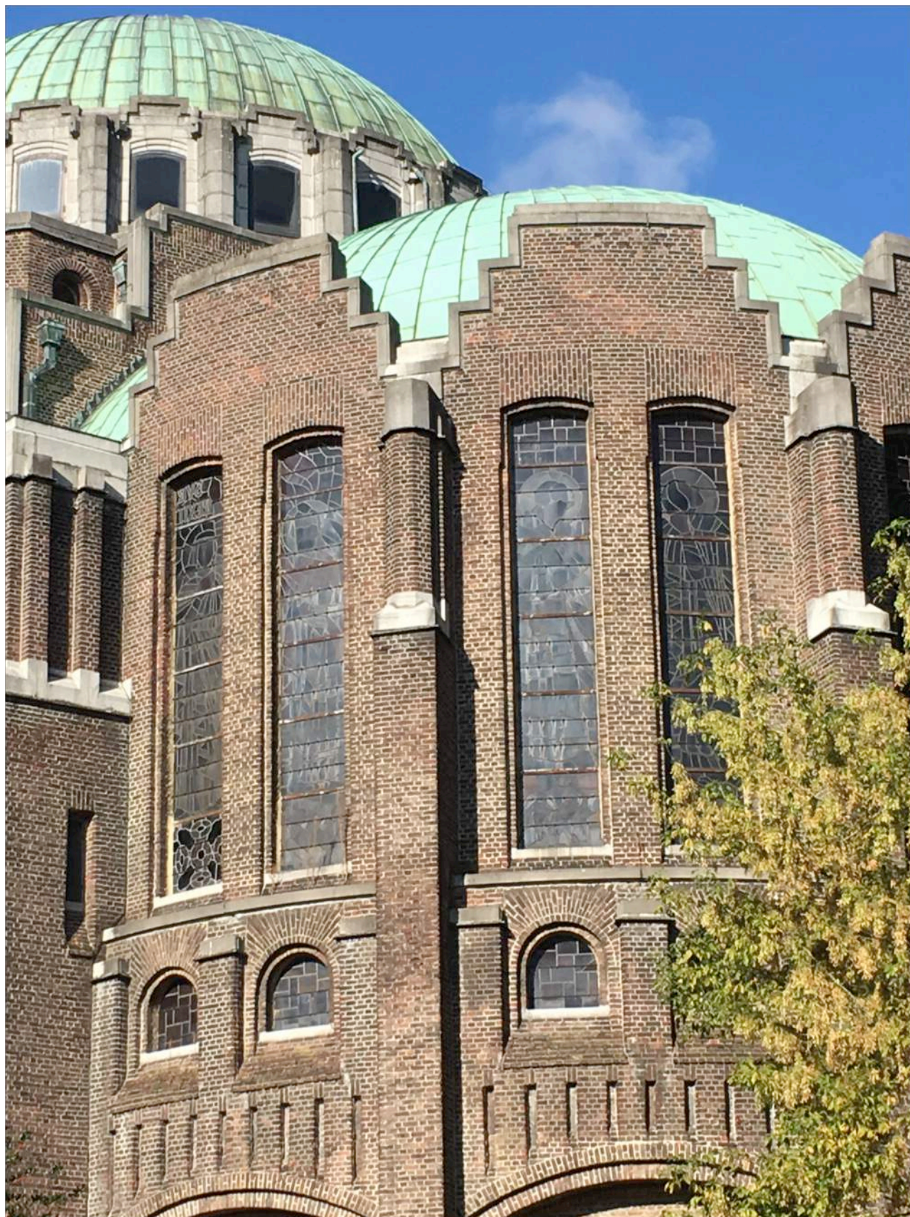
Figuur 18: Detail van de oostgevel van de Kristus-Koningkerk in bestaande toestand
