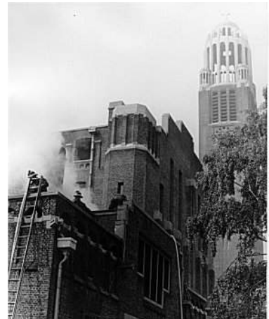
Brand van de bovenverdieping van de sacristie (huidig Expo-Rex).
