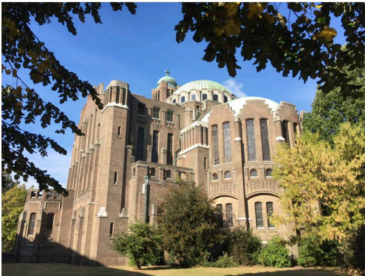
Figuur 17: Oostgevel van de Kristus-Koningkerk in bestaande toestand
