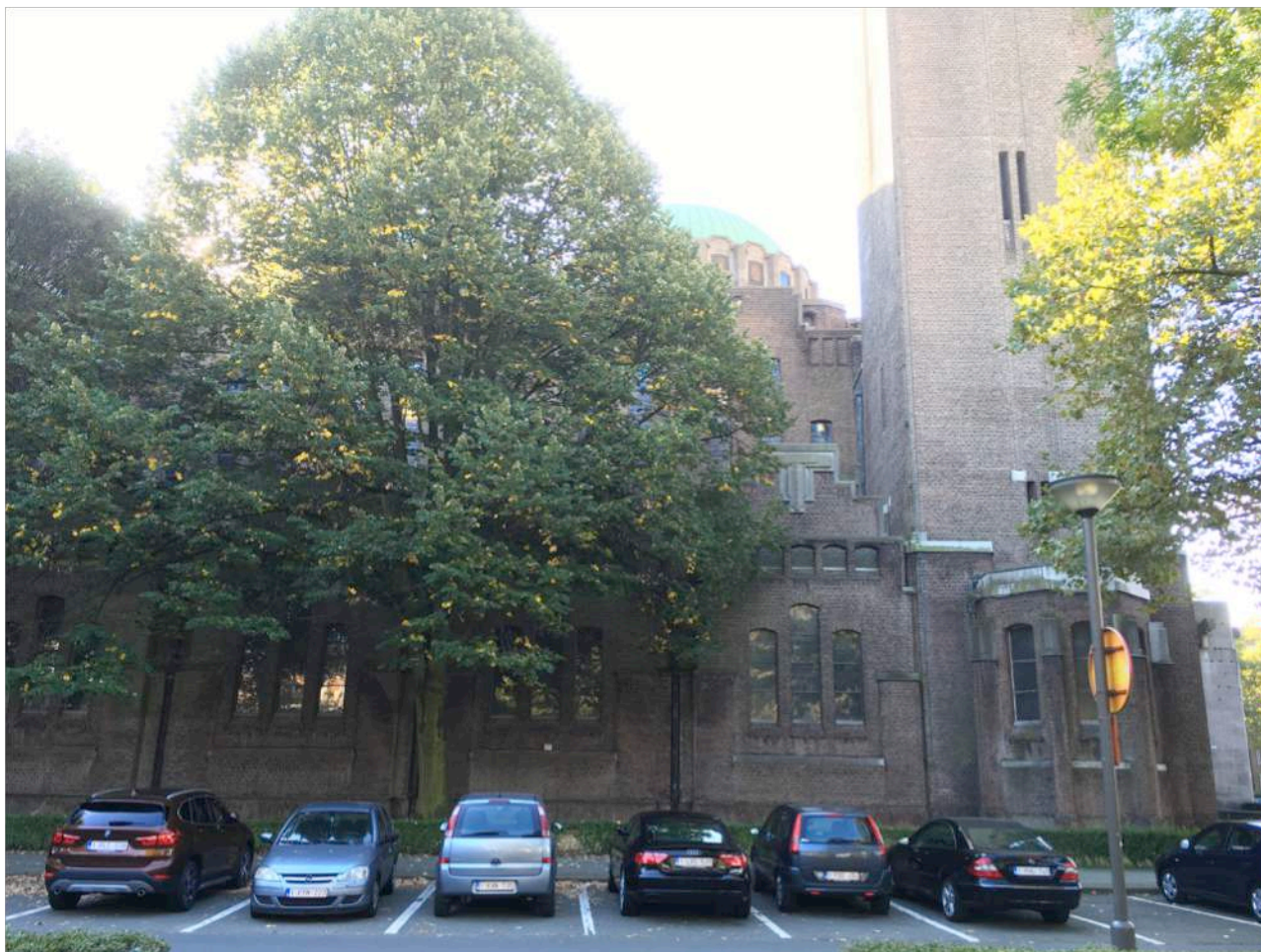
Figuur 20: Noordgevel van de Kristus Koningkerk in bestaande toestand
