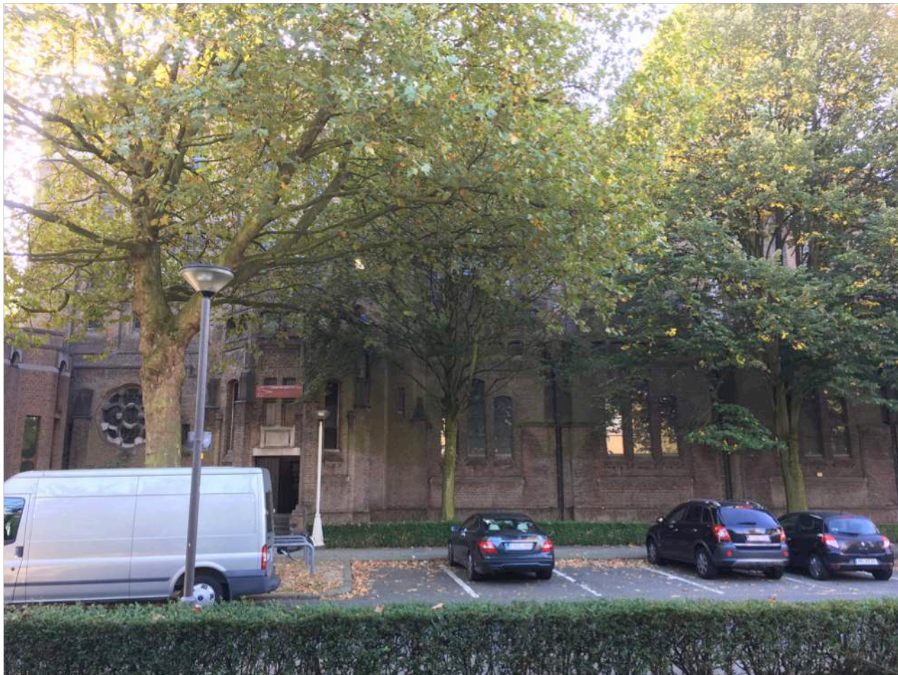
Figuur 21: Noordgevel van de Kristus Koningkerk in bestaande toestand met zicht op de zijtoegang
