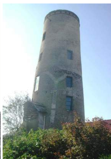
1948 – 2016 op heden nog slechts een molenromp aan de Kleine Molenstraat berging in betonplaten & golfplaten
