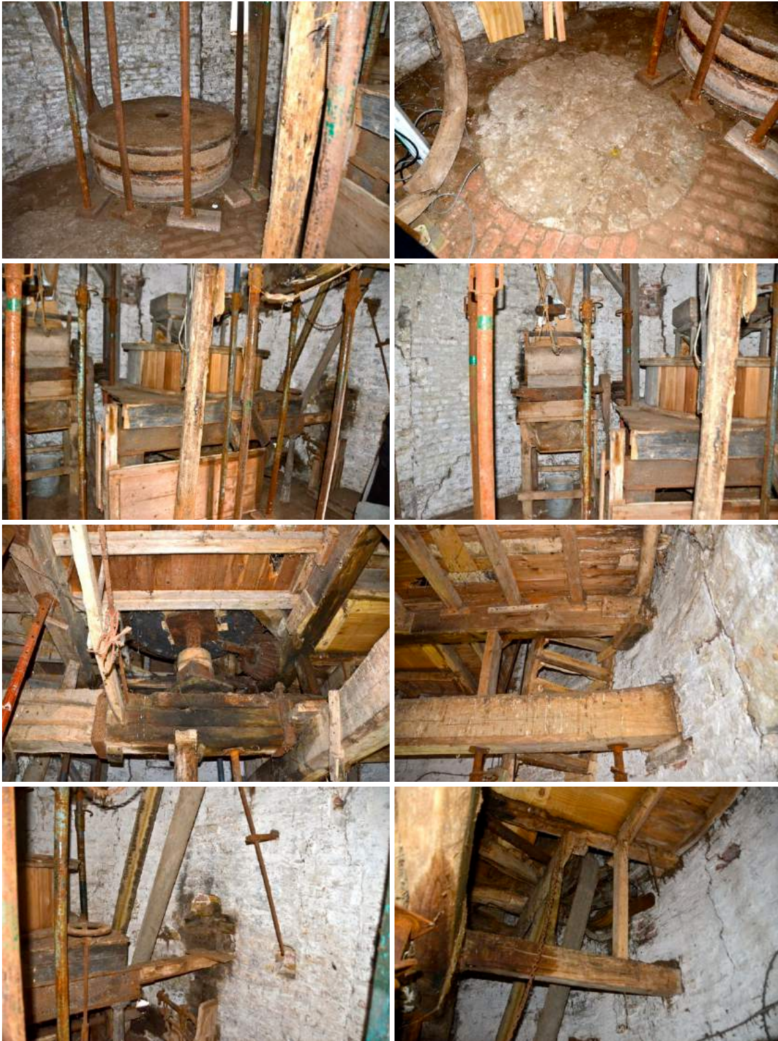
afb. 3.4 © architectuurstudio de schacht & partner(s) bv ovv bvba
