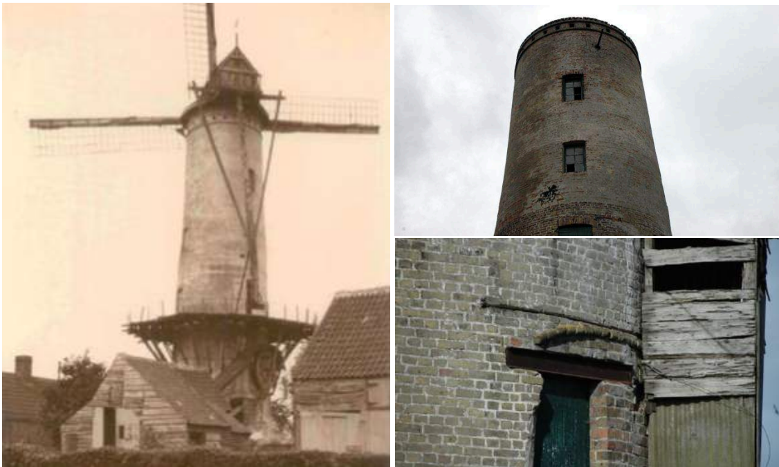
Zicht vanuit de Dorpsstraat, aanzicht oost Bemerk links de dubbele buitendeur, rechts de verbouwde toestand. afb. 3.33 links © ARCHIEF gemeente JABBEKE, Toeristische gids afb. 3.34 rechts © architectuurstudio de schacht & partner(s) bv ovv bvba
