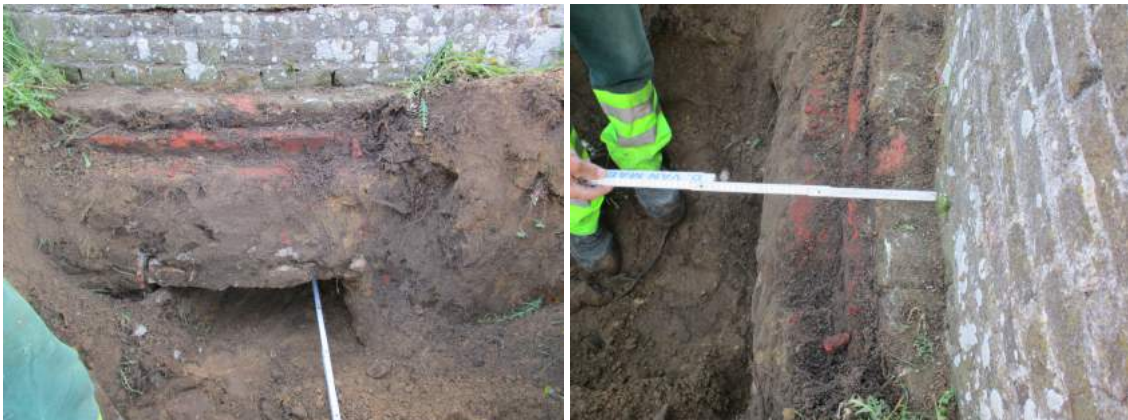
afb. 3.27 © architectuurstudio de schacht & partner(s) bv ovv bvba
