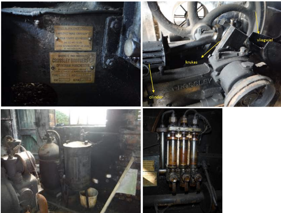
afb. 3.44 © Monumentenwacht West-Vlaanderen APB linksboven NAAMPLAATJE CROSSLEY BROTHERS LTD OPENHAM MANCHESTER rechtsboven CROSSLEY – DIESELMOTOR, 26 PK & 340 TOEREN PER MINUUT linksonder COMPRESSORVAT & OLIFILTEERVAT MET VOORRAAD IN BIJGEBOUW rechtsonder OLIEDRUPPELAAR, FILTER, WATERAFSCHEIDER, ...
