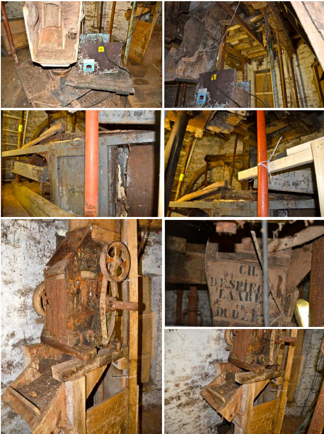
afb. 3.6 © architectuurstudio de schacht & partner(s) bv ovv bvba
