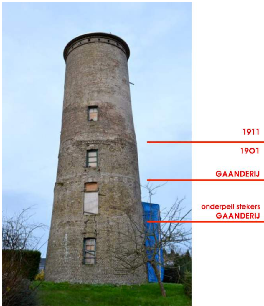
afb. 2.35 © architectuurstudio de schacht & partner(s) bv ovv bvba OVERDUIDELIJKE CHRONOLOGISCHE BOUWSPOREN IN DE MOLENROMP i.v.m. OPBOUW MOLEN VAN KERREBROECK IN MEERDERE FASES
