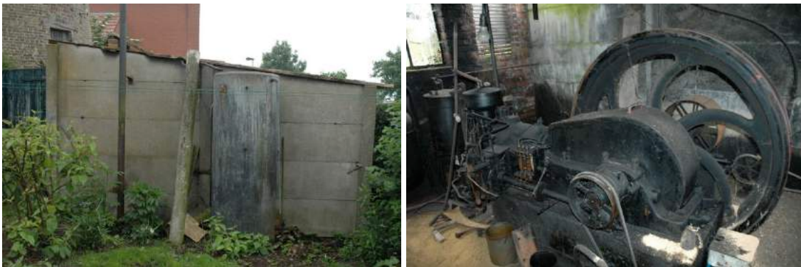
afb. 3.42 © ARCHIEF gemeente JABBEKE (boven) & © Monumentenwacht West-Vlaanderen APB (onder) BIJGEBOUW MET DIESELMOTOR (betonplaten & asbestcement golfplaten) CROSSLEY – DIESELMOTOR, 30 PK & 340 TOEREN PER MINUUT
