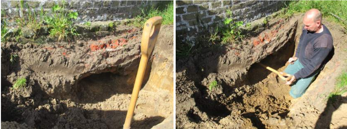
afb. 3.26 © architectuurstudio de schacht & partner(s) bv ovv bvba
