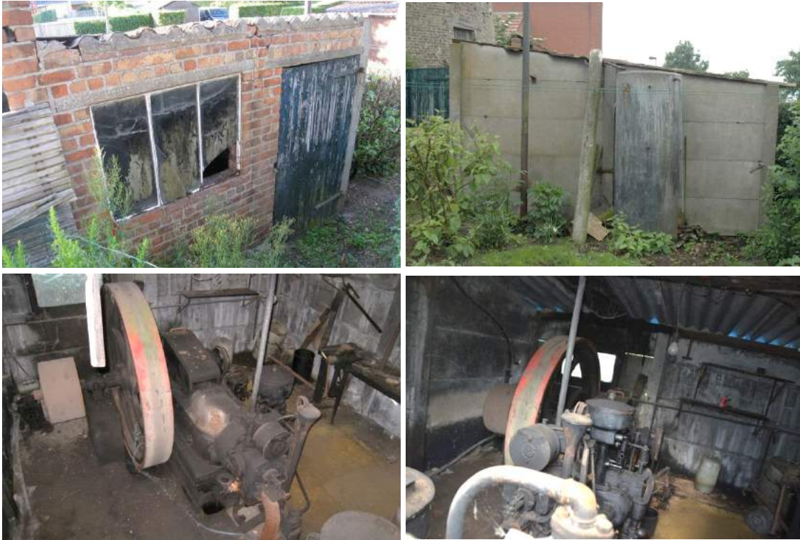
afb. 1.9 © architectuurstudio de schacht & partner(s) bv ovv bvba WAARDEVOLLE, MAAR NIET-BESCHERMEDE DIESELMOTOR MET BEHUIZING
