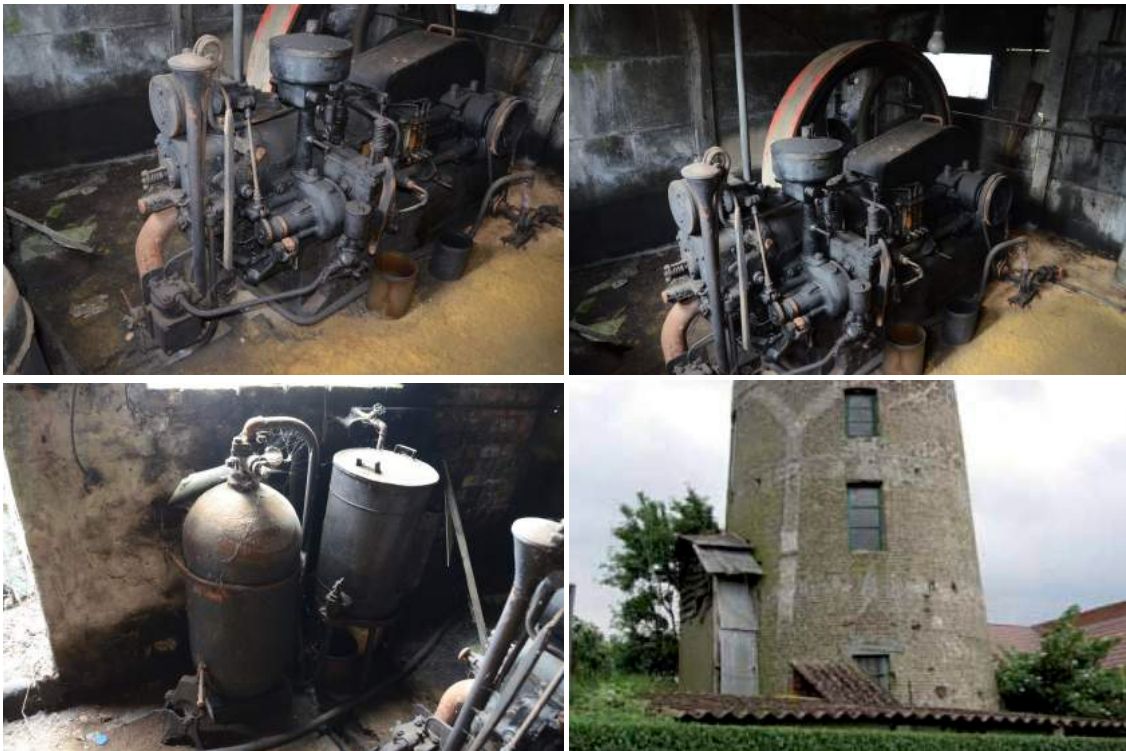
afb. 2.33 © architectuurstudio de schacht & partner(s) bv ovv bvba CROSSLEY - DIESELMOTOR IN EEN NIEUW BIJGEBOUW ( betonplaten ) 30 PK & 340 TOEREN PER MINUUT
