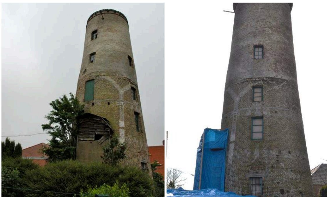
Aanzicht noord, vanaf het bijgebouw met dieselmotor afb. 3.32 © architectuurstudio de schacht & partner(s) bv ovv bvba
