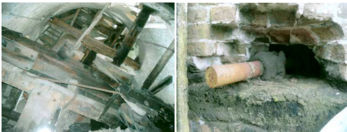
afb. 3.17 © Maarten OSSTYN, het West-Vlaams Molenblad Jaargang 32/1, 2016-1 links OP DE KONING IS ER DE HOUTEN LUITAFEL GEPLAATST, DIE DE HOUTEN LUIAS AANDRIJFT rechts AS ...
