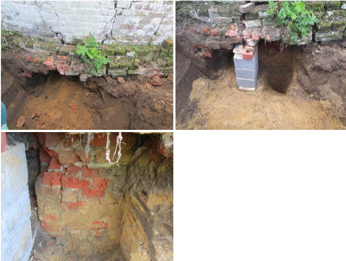
afb. 3.29 © architectuurstudio de schacht & partner(s) bv ovv bvba
