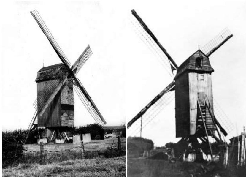
afb. 226 © www.molenechos.org foto : Stichting Levende Molens, Roosendaal / foto : Verzameling Ons Molenheem MOLEN HOLLEVOET ( = aangekochte Molen Rommel 1910 – 1951 ) links windweeg rechts voorweeg ( duidelijk een driezolder, bemerk de deur links onder de buitentrap )
