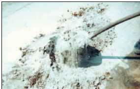
Strooi het zand open op de grond en strooi het bindmiddel erbovenop. Meng beide lagen door ze te verschoppen naar de andere helft van het oppervlak en opnieuw.
