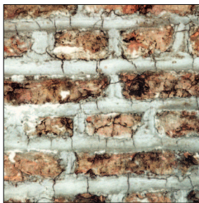
De kleine scheurtjes in het voegwerk werden veroorzaakt door vorst.
