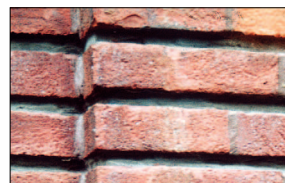
De combinatie van een verdiepte lintvoeg met een platvolle en gekleurde stootvoeg, vaak toegepast in de jaren '30.
