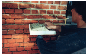
Plaats het bord tegen de gevel en druk met een voegijzer de mortel in de opening.
