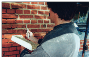
Druk de mortel zacht in de voeg, strijk ze glad en geef de voeg het geschikte profiel.
