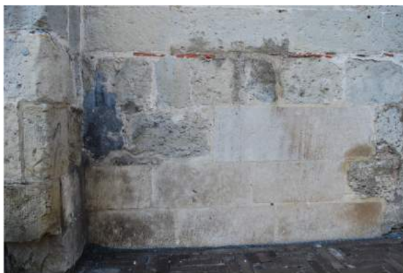
gezaagde kleidakpannen in de voeg
