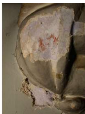
Links de intens paarse lakmoes op dekplaat en kraagsteen tussen transept en viering. De oorsprong of betekenis van de rode kleur op de kraagsteen is niet duidelijk, er lijkt geen vast patroon in te zitten en het is ook geen restant van een latere laag. Op andere plaatsen zoals de figuratieve kraagstenen en de wand van de zijbeuk (2 foto's rechts) is enkel een paarsig lichtgrijs te zien bij de oudere lagen.
