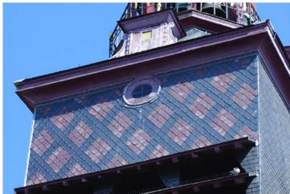
bekleding fumée-leien boven galmgaten
