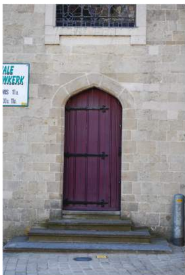
enkele deur noord
