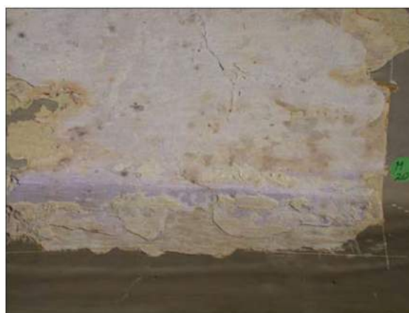
Links boven de intensiteit van de paarse kleur, rechts: de kleur op het gewelfvlak is lichter is dan op de rib.
