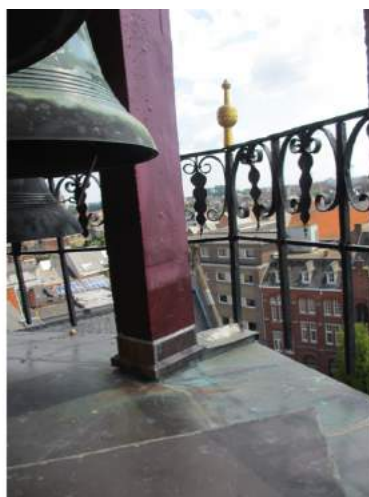
bekleding koper - aansluiting kolom
