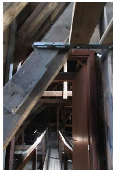
deur tussen toren en zolder
