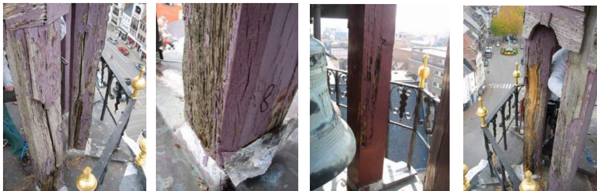
Afbeelding 34 | Foto's toestand houtstructuur lantaarn in 2008
