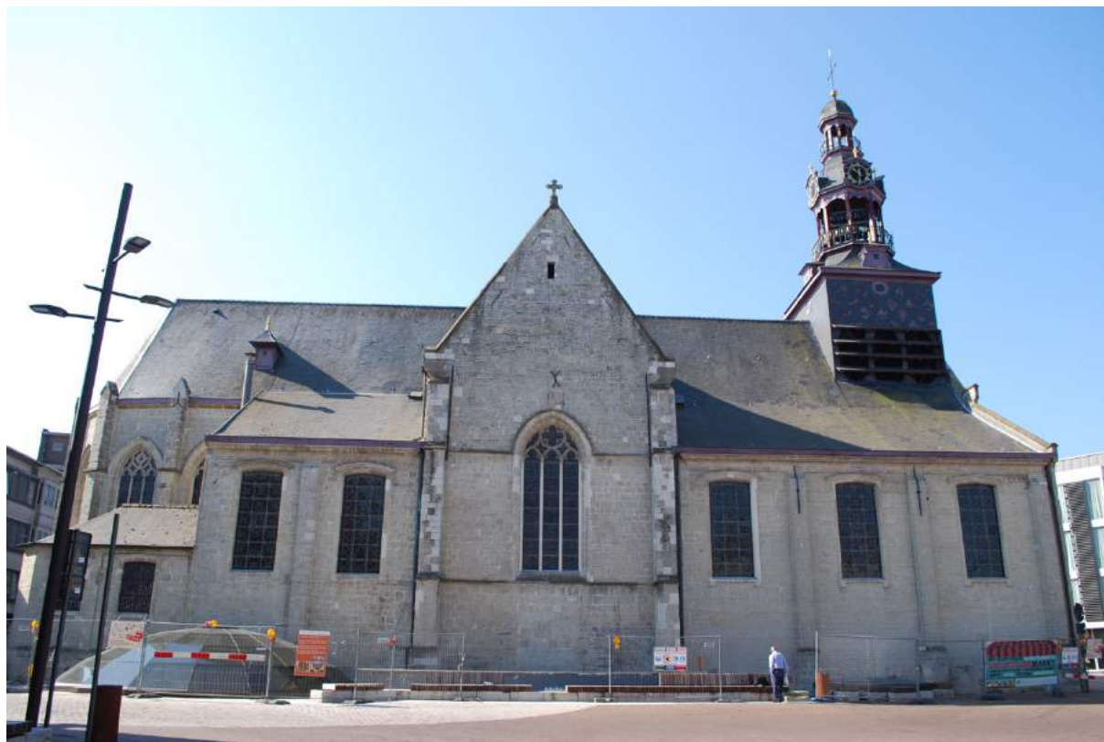
Afbeelding 60 | foto gevel noord
