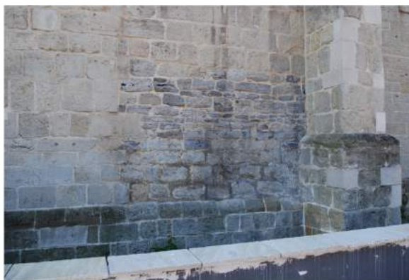
transept, zone Doornikse kalksteen
