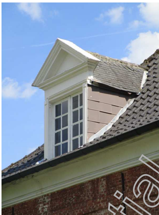
dakkapel bijgebouw Oostkant
