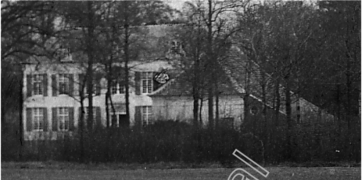
Deze foto toont het bijgebouw ten Zuiden van het kasteel met een eerste uitbreiding van de 19 e eeuw. Een “oeil de boeuf” is duidelijk zichtbaar. De tweede uitbreiding werd toegevoegd na 1908.
