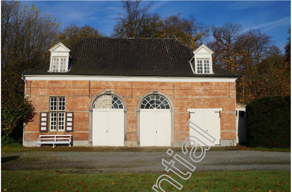
Bijgebouw (westen) met zandstenen kruiskozijnen aan de linkerkant en een poort toegevoegd in de 19 e eeuw aan de rechterkant.
