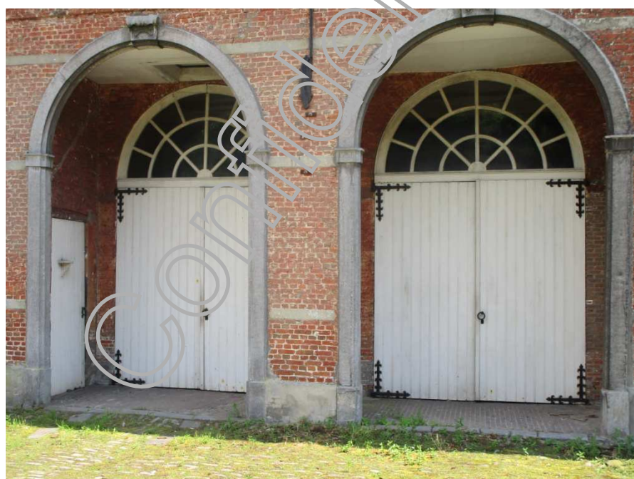
ingangspoorten bijgebouw Oostkant
