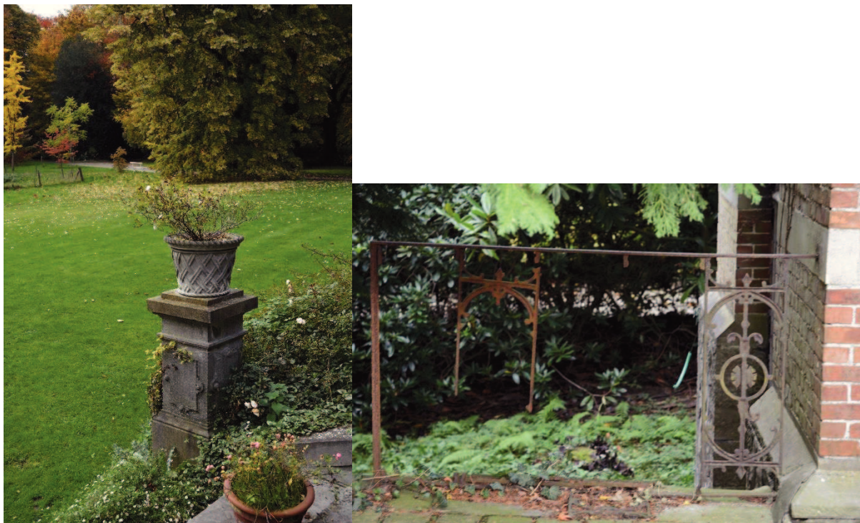
Natuurstenen sierstuk en deel van de sterk geërodeerde metalen leuning van het terras.
