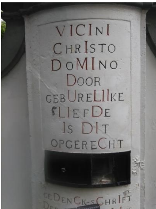
Afb. 32: detail van borstwering ter hoogte van vroegere toegang tot de ruïen
