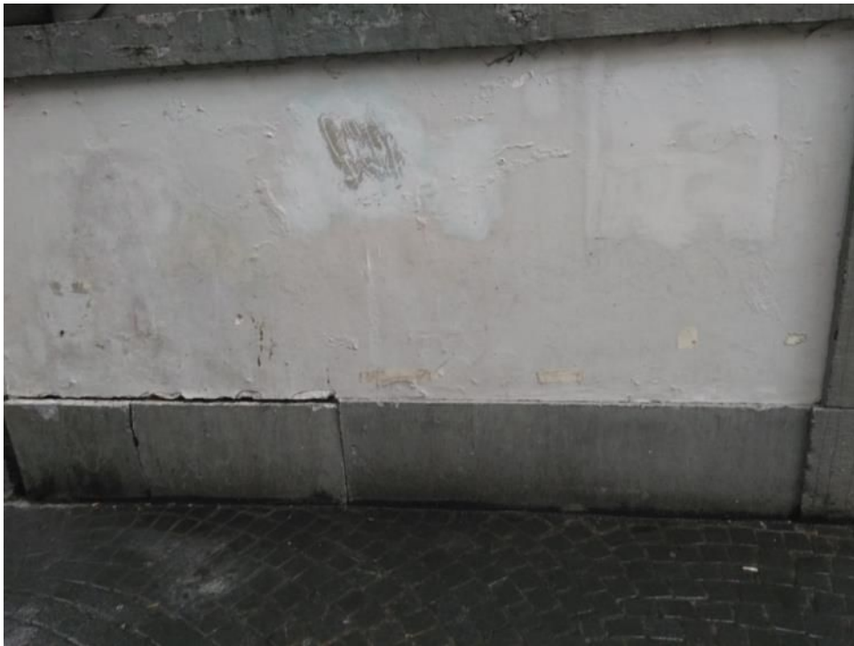
Afb. 31: detail van borstwering ter hoogte van vroegere toegang tot de ruïen
