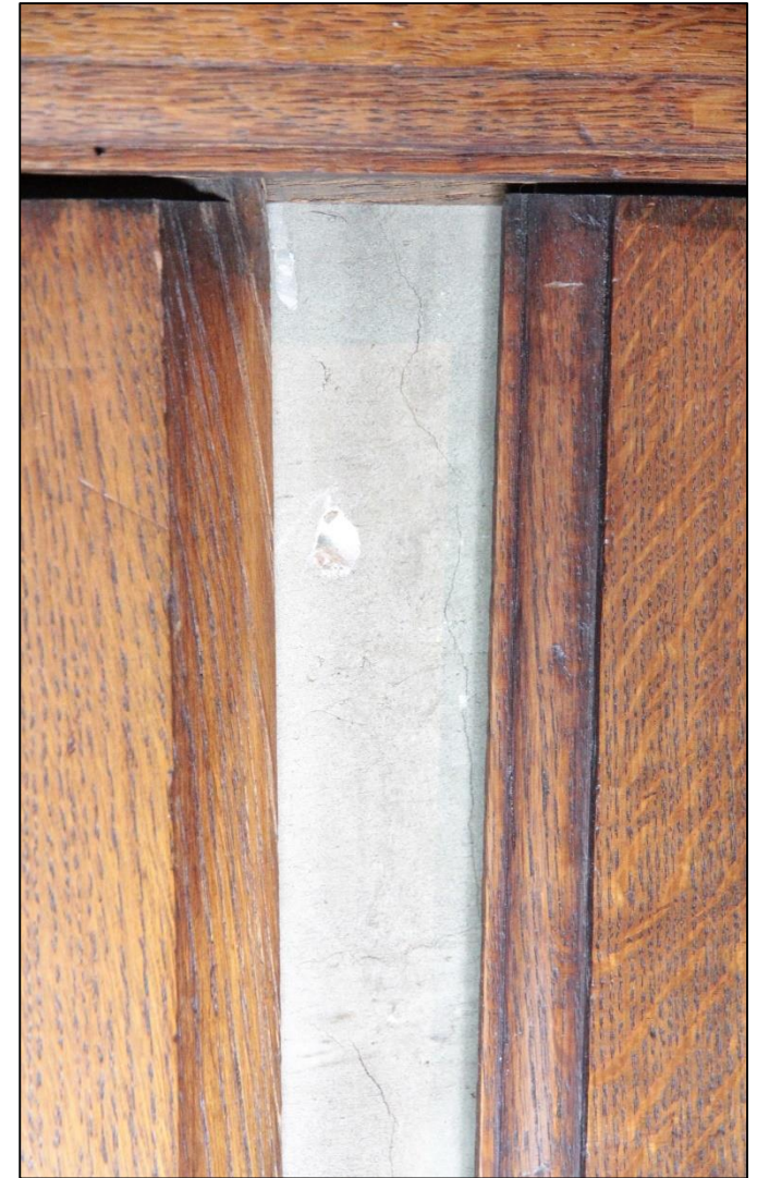
Achter de lambrisering blijkt de 19 de -eeuwse pleister door te lopen tot op het vloerniveau. Er is geen enkele afwerkingslaag aangebracht op de pleister. Pleister en lambrisering zijn in één fase te situeren.
