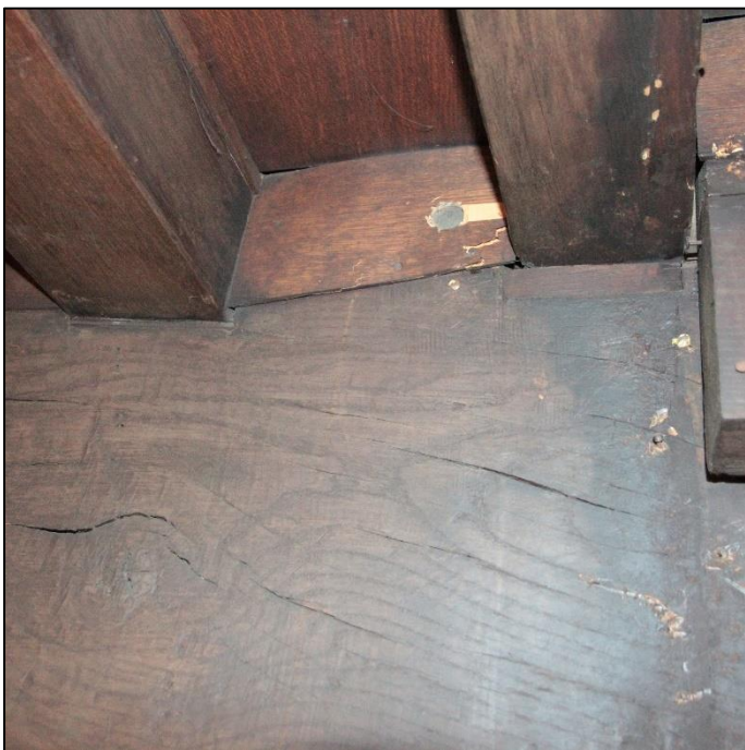
Draadnagels werden gebruikt om het plankje tussen de kinderbalken te bevestigen. Duidelijk is ook hoe de kinderbalken werden aangepast/gehermonteerd. De sponning waarin de rechtse kinderbalk wordt ingelaten werd verhoogd met een inzetstuk van ander hout
