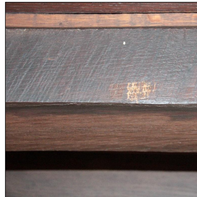
De onderzijde en zijkant van een kinderbalk. Aan de zijkant zijn de manuele zaagsneden en natuurlijke verdonkering van het hout nog zeer duidelijk. Aan onderzijde werd deze kinderbalk glad geschaaft op een later tijdstip, getuige ook de ongelijke verkleuring. Tengellat en spreidsel zijn lichter en warmer van kleur.
