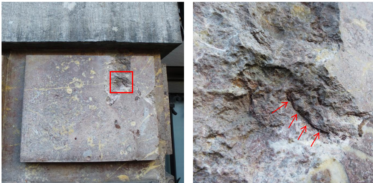
Figuur 2: Overzichtsbeeld (links) en detailbeeld (rechts) met zicht op een kleiachtig (rood getint) tussenlaagje (rode pijlen).
