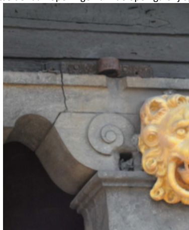
Afbeelding 50: detail van een roestend ankeroog thv de open galerij op de 2e verdieping (foto Origin)
