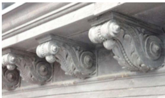
Afbeelding 74: zicht op de goetklossen die de uitkragende bakgoot ondersteunen (foto Origin)
