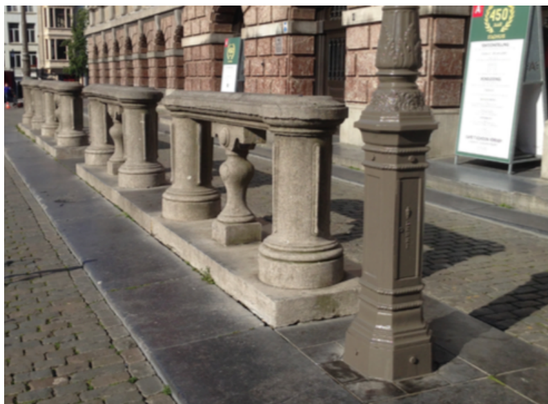
Afbeelding 9: buitenaanleg ontworpen door Pieter Dens in 1871
