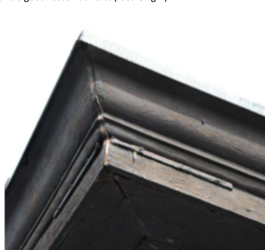
Afbeelding 76: zicht op een sterk aangetaste goetklos. Een zwam of een aantasting door houtbourende insecten heeft ervoor gezorgd dat een deel van de klos hol is geworden (foto Origin)
