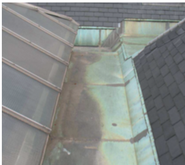
Afbeelding 69: zicht op een zakgoot met koperen bedekking (foto Origin)
