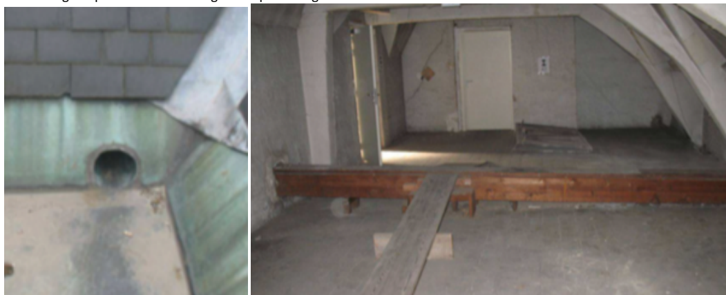
Afbeelding 80: zicht op een tapgat waardoor het water van de goten verder afgevoerd wordt naar de afvoerpijpen (foto Orgin)
