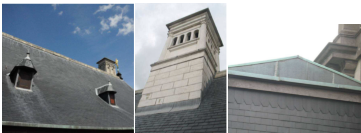
Afbeelding 63: zicht op de leibedekking van de dakvlakken van het Stadhuis (foto Origin)
