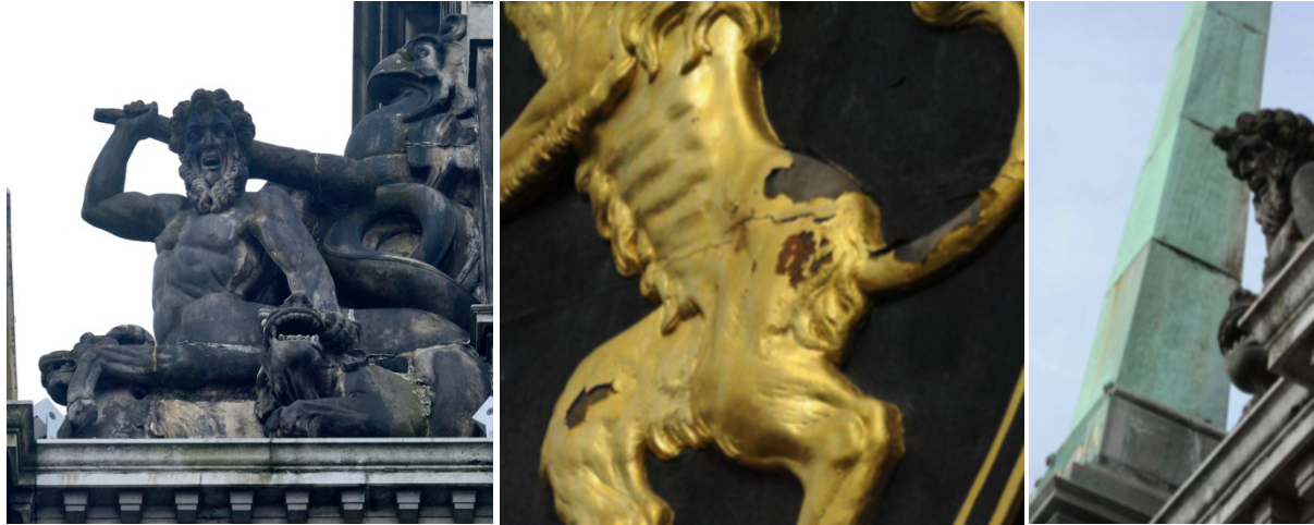
Afbeelding 56: zicht op een beeld uit Brentheimer zandsteen welke een roetzwarte kleur heeft verkregen (foto Georges De Kinder)
