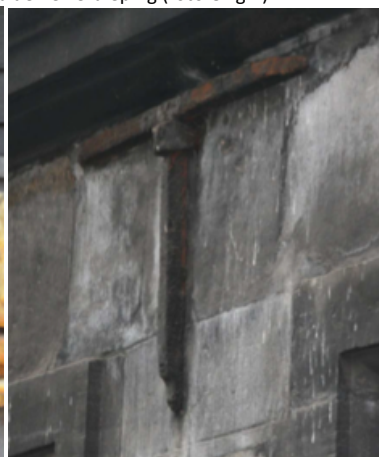
Afbeelding 51: zicht op een roestend ankeroog (vermoedelijk een oude vlaggenmasthouder) met schade aan de blauwe hardsteen tot gevolg (foto Origin)
