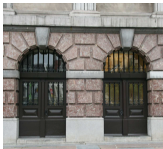
Afbeelding 29: zicht op twee dubbele deuren van de gelijkvloerse verdieping (foto Origin)
