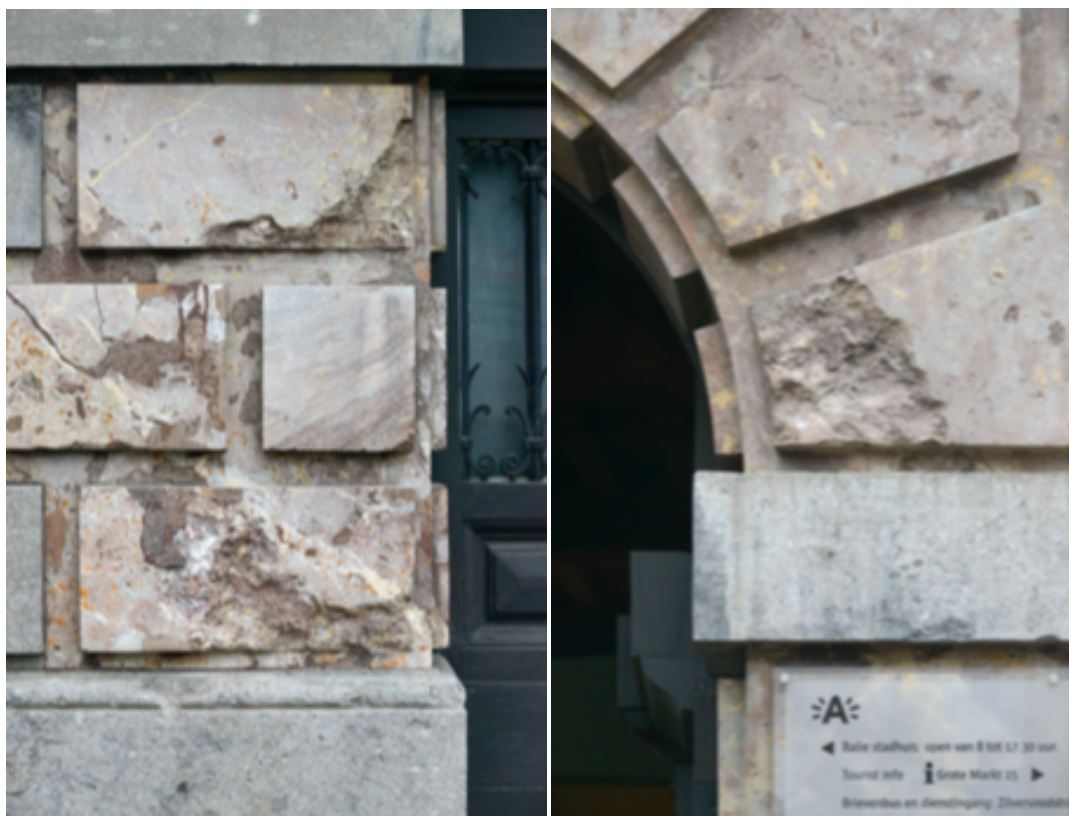
Afbeelding 13 & Afbeelding 14: afbrokkeling van de rode marmer
