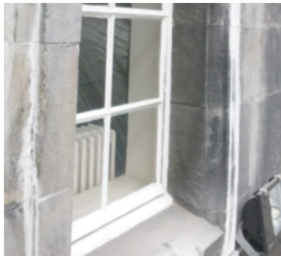
Afbeelding 33: voorbeeld van bolkozijn ingevuld met houten schrijnwerk thv de tweede verdieping, zijde binnenkoer, gevel oost en west
