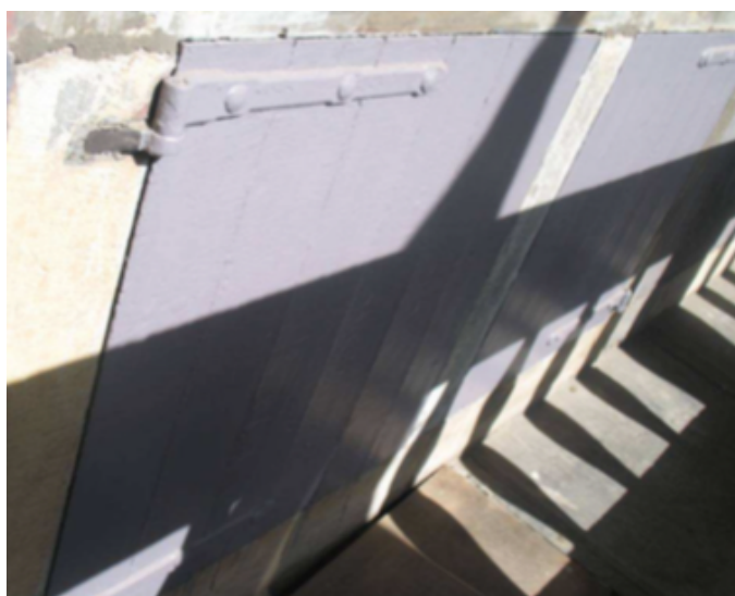
Afbeelding 45: zicht op houten beschilderde luiken thv de rondgang op de 2e verdieping (foto Origin)
