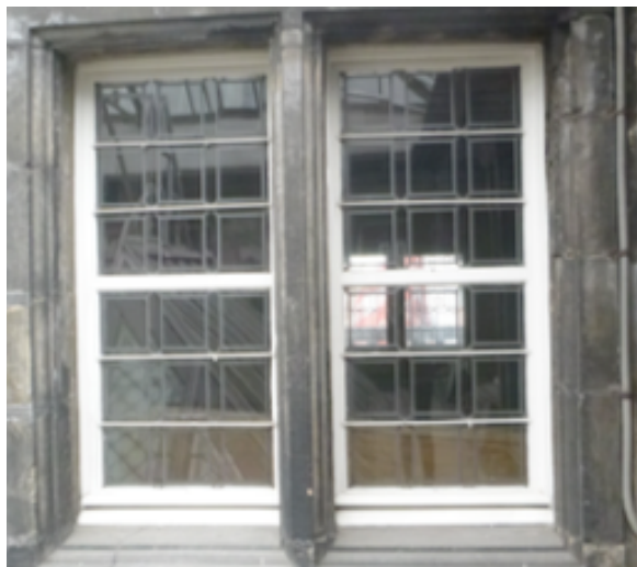
Afbeelding 33: voorbeeld van bolkozijn ingevuld met houten schrijnwerk thv de tweede verdieping, zijde binnenkoer, gevel oost en west
