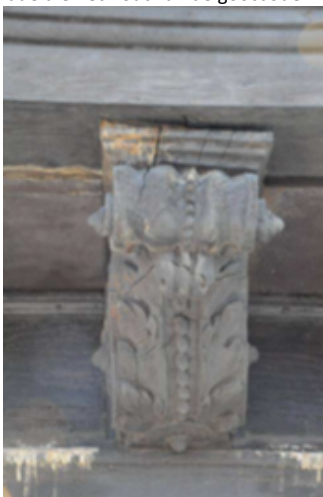
Afbeelding 76: zicht op een sterk aangetaste goetklos. Een zwam of een aantasting door houtbourende insecten heeft ervoor gezorgd dat een deel van de klos hol is geworden (foto Origin)
