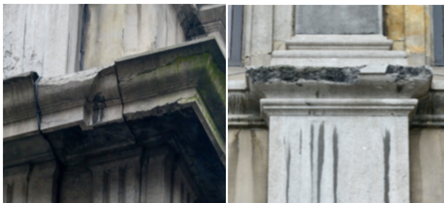
Afbeelding 11 & Afbeelding 12: afscheuring als gevolg van koolstofaders
