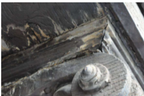
Afbeelding 74: zicht op de goetklossen die de uitkragende bakgoot ondersteunen (foto Origin)
