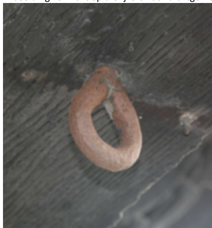
Afbeelding 50: detail van een roestend ankeroog thv de open galerij op de 2e verdieping (foto Origin)
