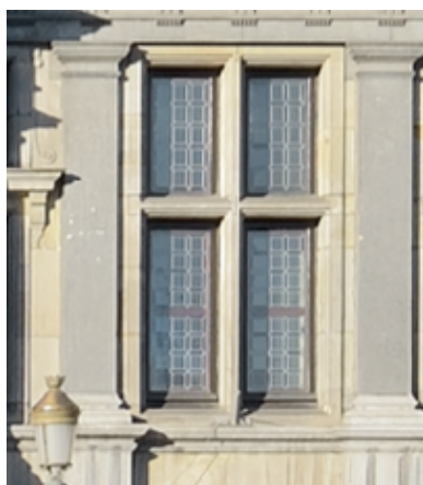
Afbeelding 30: voorbeeld van kruisraam op het schoon verdiep en op de eerste verdieping
