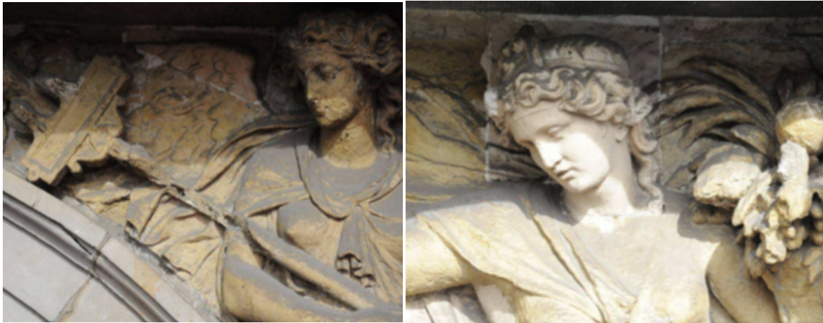
Afbeelding 59: zicht op beeldhouwwerk uit Avesnessteen in de zwikken. Het beeldhouwwerk heeft te kampen met materiaalverlies (foto Origin)
