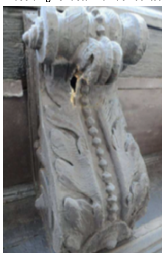
Afbeelding 76: zicht op een sterk aangetaste goetklos. Een zwam of een aantasting door houtbourende insecten heeft ervoor gezorgd dat een deel van de klos hol is geworden (foto Origin)
