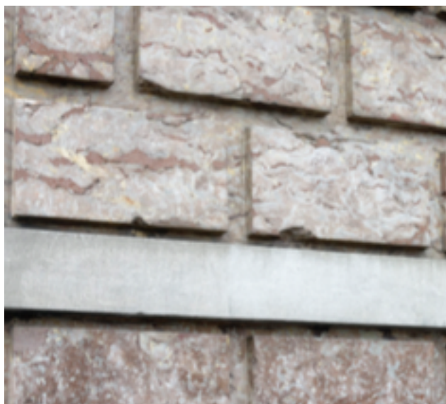
Afbeelding 21: restauratiemortels in de dof geworden marmer
