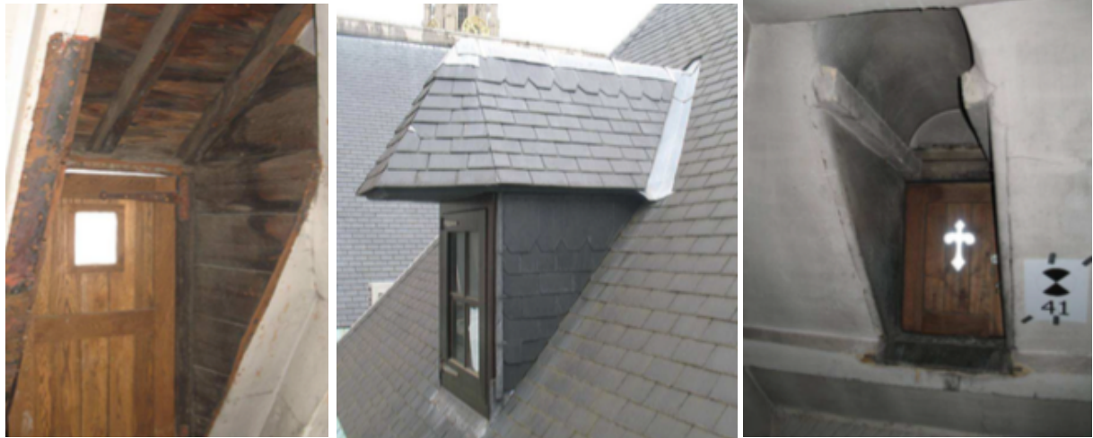
Afbeelding 83: zicht op een dakkapel langs de binnenzijde. De dakkapel is uit hout opgebouwd en wordt afgesloten met een deur (foto Origin)
