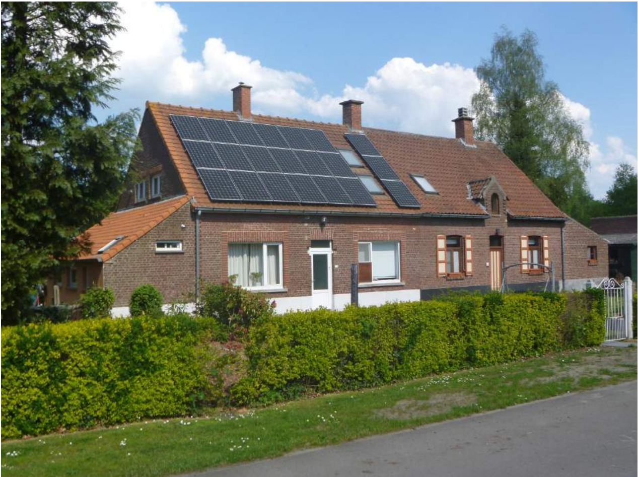
Afbeelding 3-232: Foto van de opzichterswoningen (Sint-Pietersveld 24-25) in 2016. Niet opgenomen in de inventaris.
