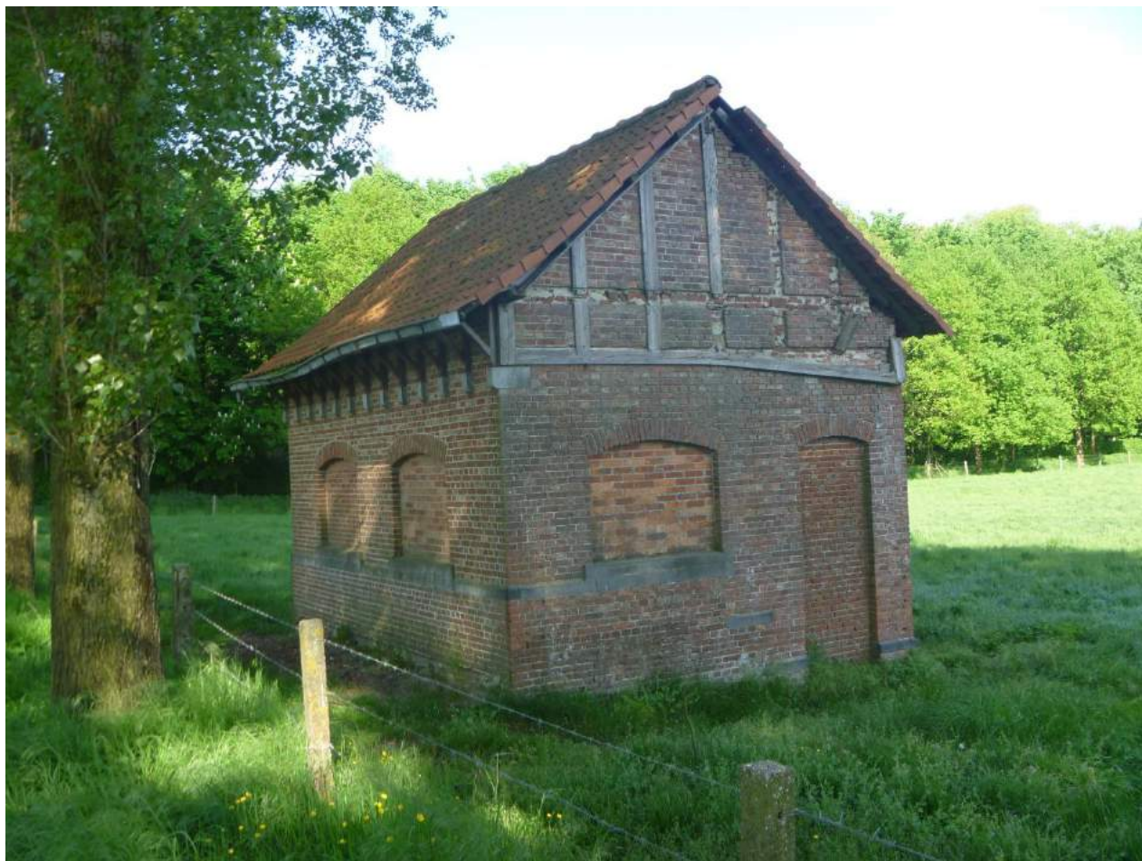
Afbeelding 3-196: Foto van het pompgebouw in het uitgebikt perceel, 2016 (Greenspot).
