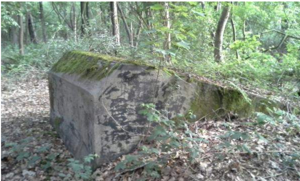
Afbeelding 3-170: betonnen ankerblok in kasteeldomein Carpentier
