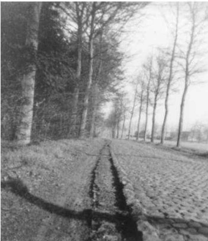
Afbeelding 2-28: Een stuk van de Vagevuurstraat/Bruggesteenweg in 1961, kort voor de heraanleg, aan de uiterste punt van de driehoek gevormd door het Ruiseleedse Sint-Pietersveld (rechts). Links de Vagevuurbossen, op de achtergrond rechts de Beernemse hoeve 't Lindeveld. Er is een zand- of grindstrook voor de fietsers, en tussen de kasseien nog een restant van de originele weg in veldsteen aangelegd hal-
