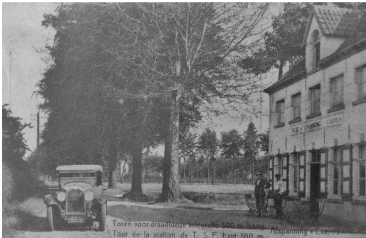
Afbeelding 2-143: Foto van de afspanning Caerels (Vagevuurstraat 37) die lag tussen restaurant Sint-Pietersveld en de sportterreinen van het ROG, anno 1928. Aan de rechterkant van de weg ligt Wingene, aan de linkerkant Ruiselede. De foto geeft het zicht langs de Vagevuurstraat richting het zuiden. De wagen staat geparkeerd langs de haag van de moestuin van de “hotellerie” van het ROG. De dikke rij beuken langs de Vagevuurstraat waren rond 1800 geplant door Petrus Geirnaert, die de enige landbouwer op het Sint-Pietersveld was. Zijn boerderij werd in 1836 opgenomen in de suikerbietenfabriek. In de verte – zie ook de naam van de postkaart – zien we twee torens van het Radiocentrum. Bron: De Ram, Ruiselede graag gezien: de oudste prentkaarten , foto 100.
