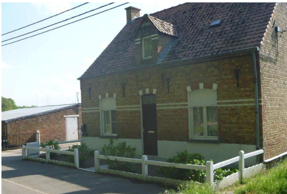
Afbeelding 3-247: Foto van de arbeiderswoning (Sint-Pietersveld 35) in 2016 (Greenspot).
