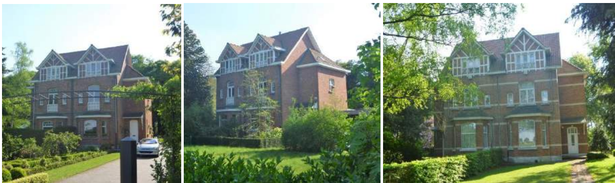
Afbeelding 3-205: Foto' van de bediendenwoningen (Vagevuurstraat 17-27) in 2016.
