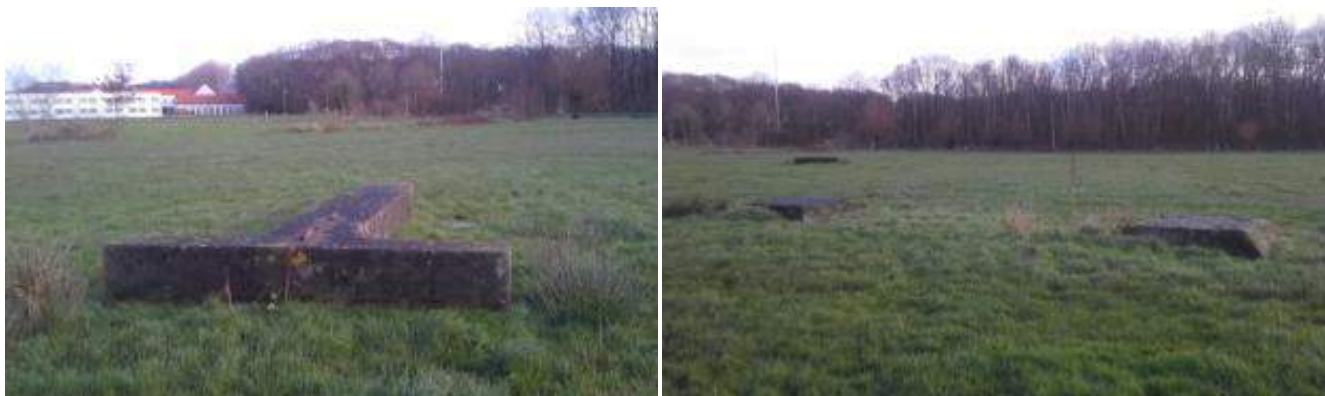
Afbeelding 3-171: betonnen ankervoet in deelzone 4 – foto rechts: 2 betonvoeten waar de antenne op stond.
