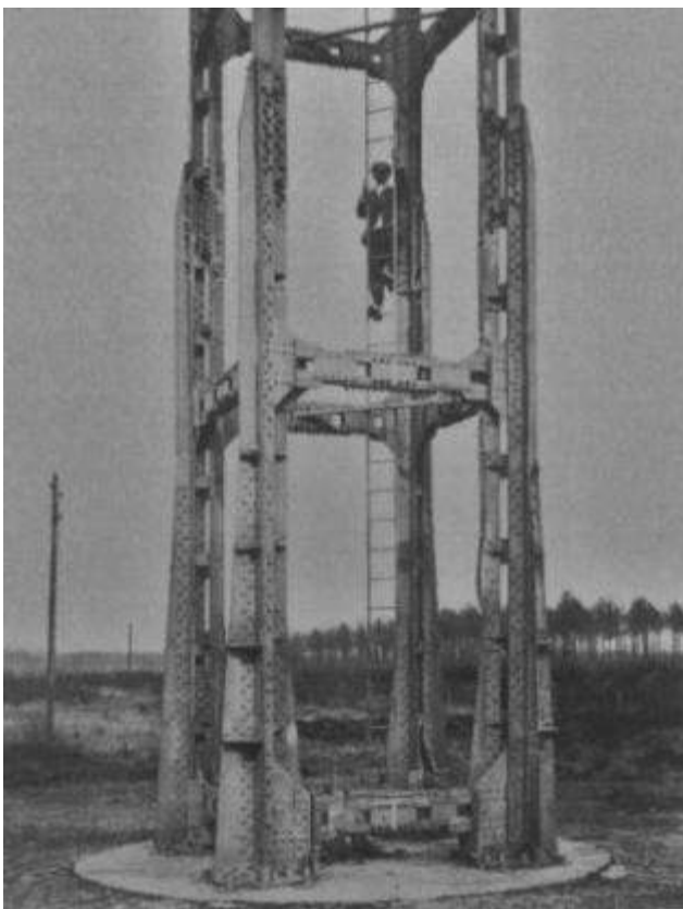
Afbeelding 2-63: De voet van een pyloon volgens het systeem-Vierendeel. Bron: Arnoys & Ghyselbrecht, Geschiedenis van het Zendcentrum SCRE te Ruiselede/Wingene en de dienst Belradio , p. 37.
