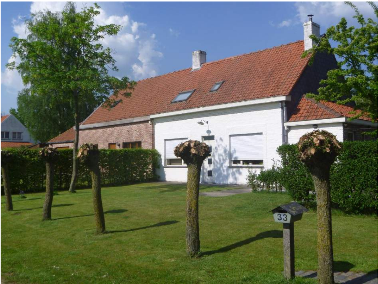
Afbeelding 3-237: Foto van de opzichterswoningen (Sint-Pietersveld 32-33) in 2016. Niet opgenomen in de inventaris.
