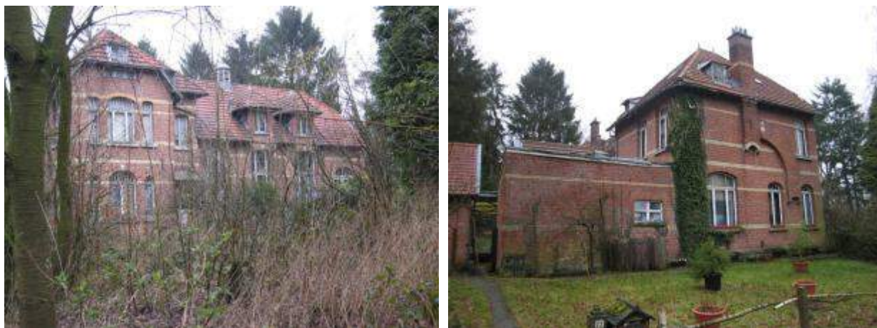
Afbeelding 3-189: Foto's van de onderwijzerswoning en het schoolgebouw (Sint Pietersveld 23; ID: 205743) in 2009. Bron: Inventarisatie Wingene (Gilté), https://inventaris.onroerendergoed.be/dibe/relict/205743 . © Vlaamse Gemeenschap
