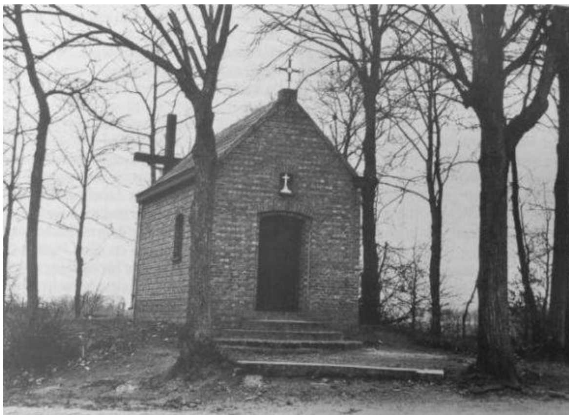
Afbeelding 2-43: Het Veldkapelleke in 1950 met de verdwenen ingang aan de straatkant, foto van Paul De Clerck. Let op het ijzeren kruis bovenop de tuitgevel, en de kleine calvarieberg in de nis. Ook lijkt de kapel
