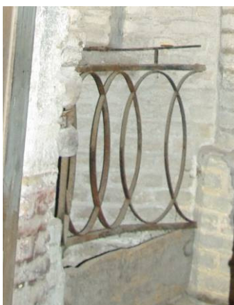
Figuur 91 : gebogen hekwerk – zelfde makelij – in de traptoren van de kerk
