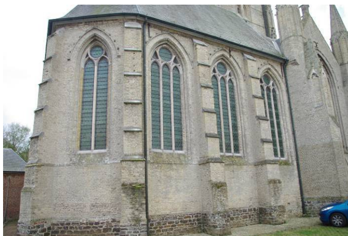
Figuur 14: gevelvlak zijkoor noord
