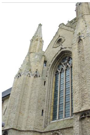
Figuur 18: zicht op traptoren, ingewerkt in de steunbeer, t.h.v. gevelvlak transept zuid
