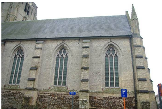
Figuur 11: noordgevel zicht 1
