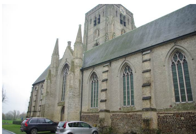
Figuur 12: noordgevel zicht 2
