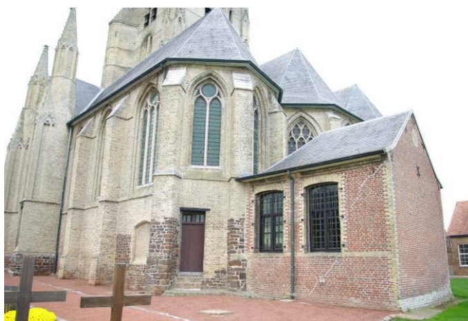
Figuur 16: oostgevel, met zicht op de aangebouwde sacristie
