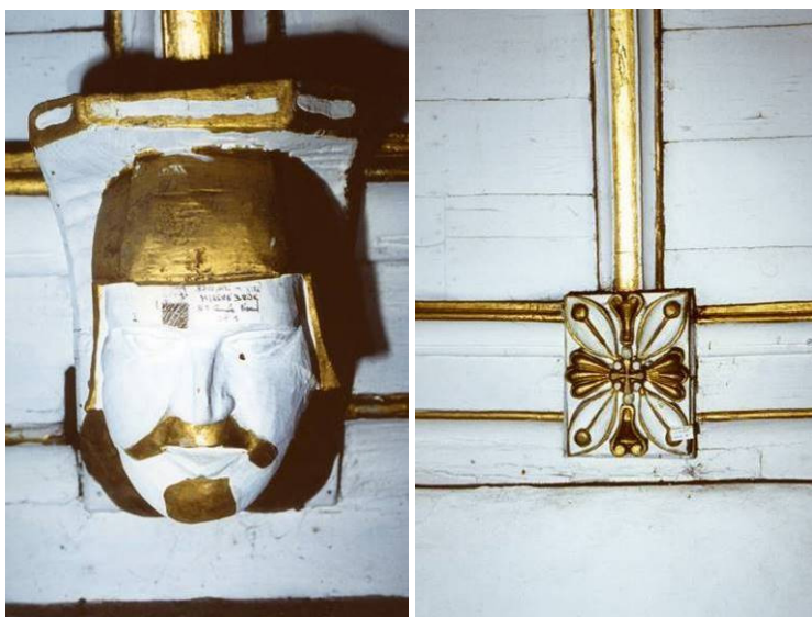
Figuur 33 en 34: figuratieve console (links) en later tegen afgezaagde balkkop aangebrachte decoratie (rechts) in de middenbeuk (foto's Lode Declercq 1999)
