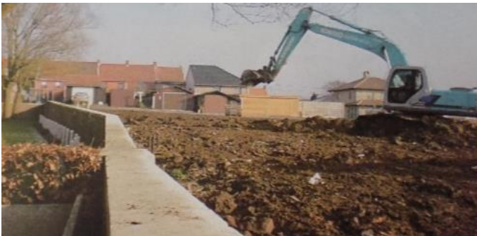
Figuur 4. Grondwerken naast Tuileries British Cemetery, 2009 12
