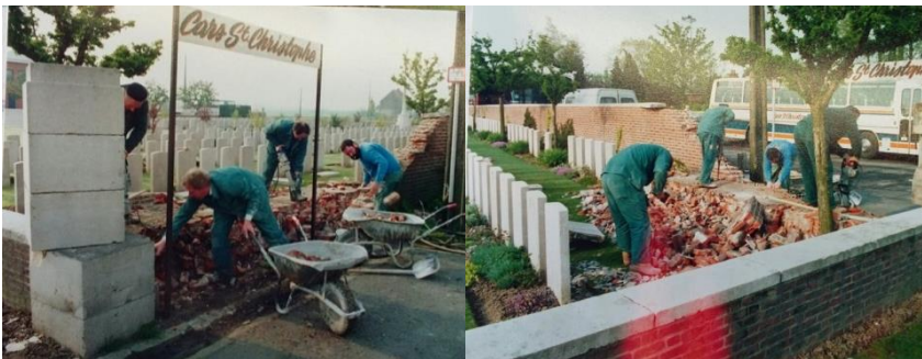
Figuur 4. Herstellen van de beschadigde muur (1990)
