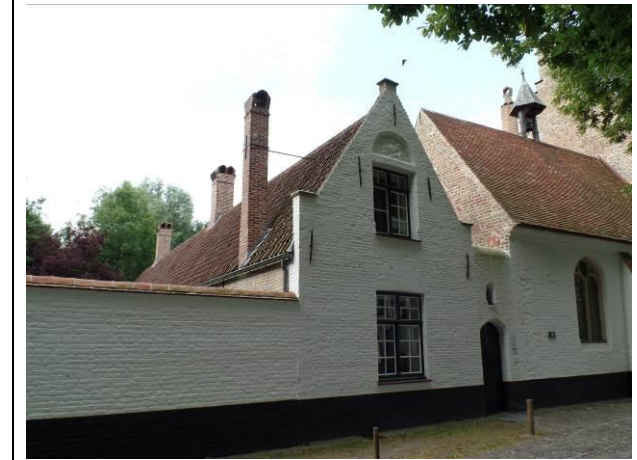
Achtergevel huisnr. 32 &amp; verder
