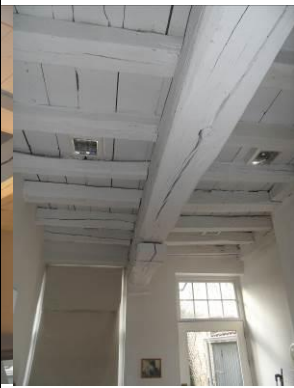
Nr. 50 - bewaarde balkenlaag
