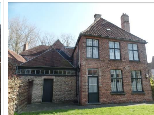
Achtergevel deel rechts
