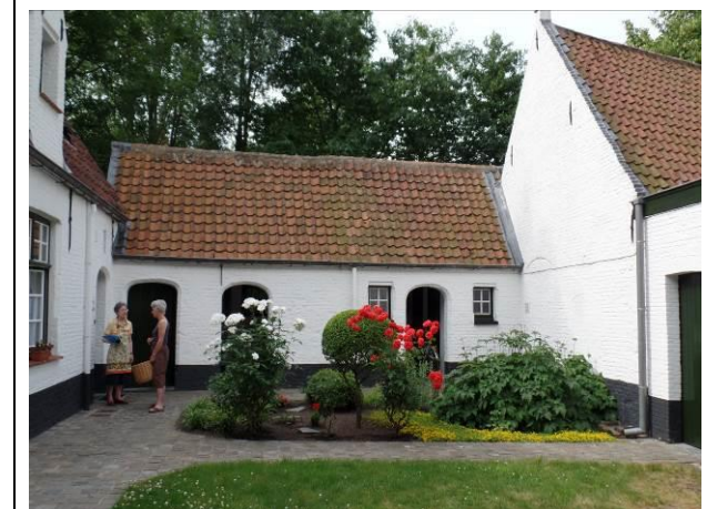
Zicht gevel vanaf binnengebied
