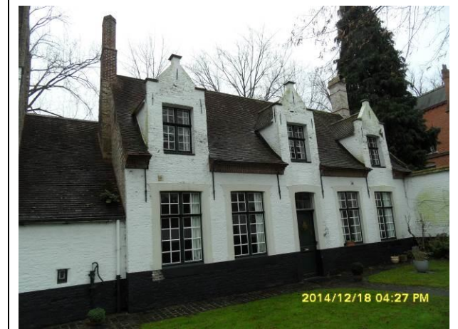
Voor – en linker zijgevel. De aanbouw hoort bij huis 15
