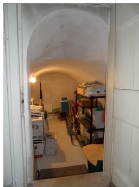
Zicht in kelder
