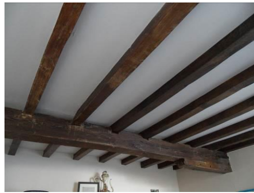
9C1 - Bewaarde balkenlaag
