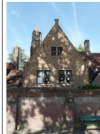
Achtergevel bovenverdieping – zicht vanaf Begijnenvest
