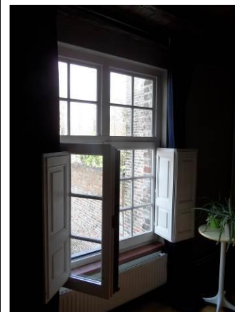
Raam verdieping achtergevel
