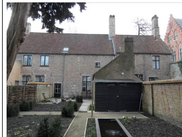
Achtergevel 52 A (rechts) + B (links)
