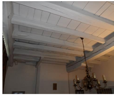
Nr. 50 - bewaarde balkenlaag
