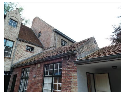
Achtergevel met zicht zijgevel / achtergevel nr.14
