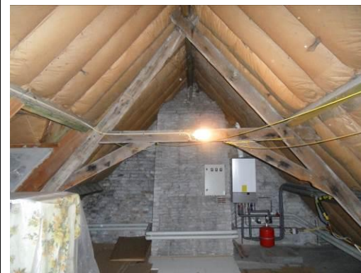
Dakconstructie met schaargebinte
