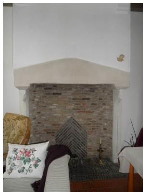
Schouw op begane grond
