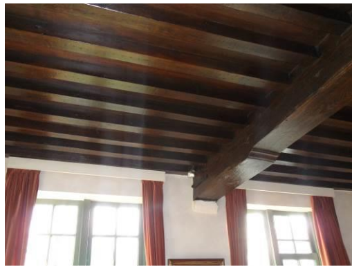
9C1 - Bewaarde balkenlaag
