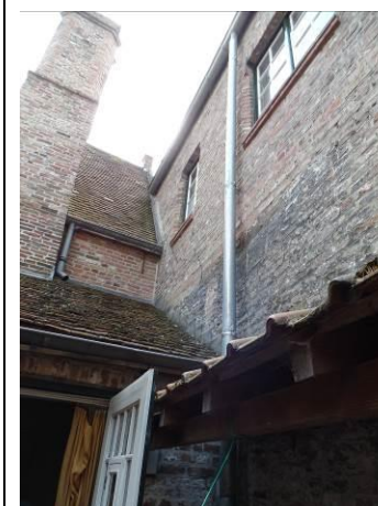
Linker zijgevel – linker gedeelte
