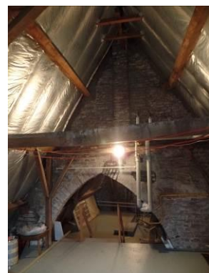
Bakstenen spitsboog zolder
