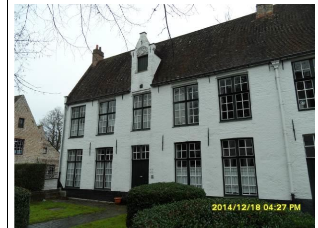
Voorgevel – zicht van rechterzijde
