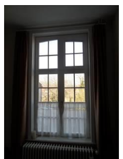
22 - achtergevel verdieping nieuw raam
