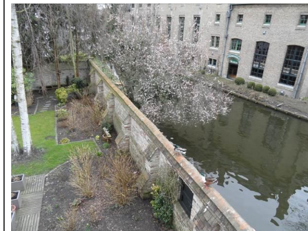
Achterzijde zicht op Reie vanaf verdieping
