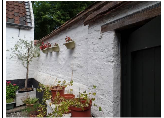
Zicht binnenzijde muur linker zijgevel (in steert)
