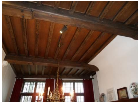
Bewaarde balkenlaag gelijkvloers
