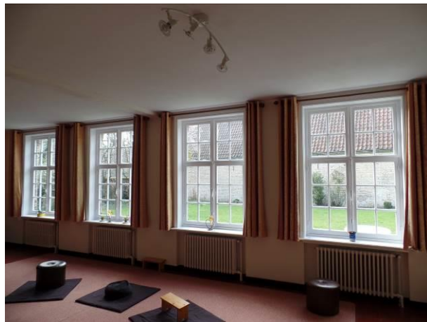
Rechter zijgevel gelijkvloers- opendraaiende ramen
