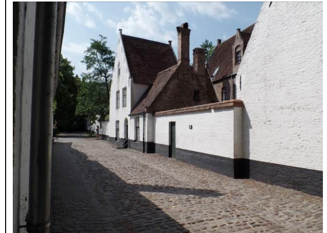
Zicht op rechterzijgevel
