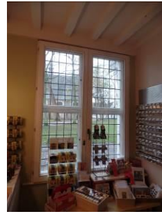
glas-in-lood-ramen met voorzetraam
