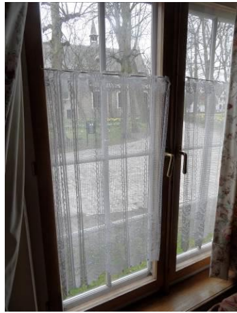
Voorgevel – schuiframen met voorzetramen
