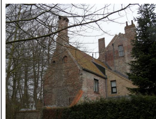
Rechter zijgevel met gedeelte achtergevel
