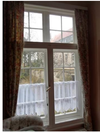
Achtergevel – opendraaiende ramen met voorzetramen
