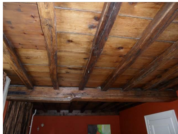
Bewaarde balkenlaag verdieping
