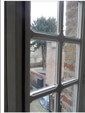
Achtergevel verdieping –enkelvoudige beglazing
