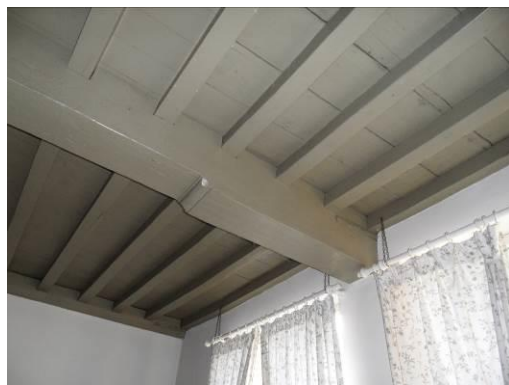
52B-bewaarde balkenlaag gelijkvloers
