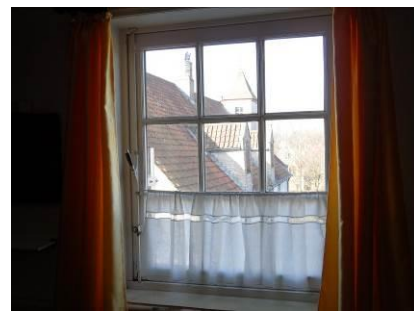
24 - zijgevel links verdieping
