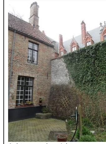
Achtergevel – zicht naar scheidingsmuur Prof. J. Sebrechtsstraat
