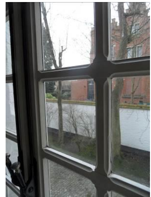
Voorgevel verdieping – opendraaiende ramen / enkelvoudige beglazing
