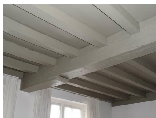
52B-bewaarde balkenlaag verdieping
