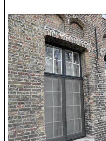
Zicht op raam achtergevel
