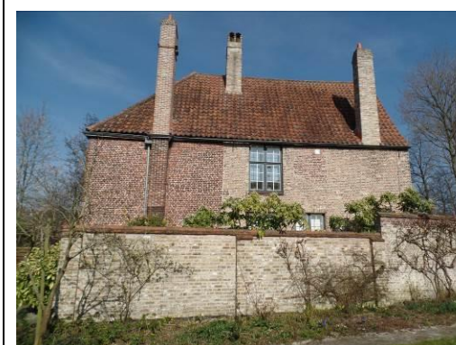
Linker zijgevel zicht scheidingsmuur nr. 22
