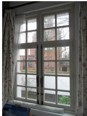
Voorgevel verdieping – opendraaiende ramen
