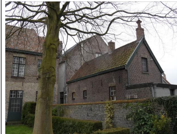
Rechter zijgevel en deels achtergevel
