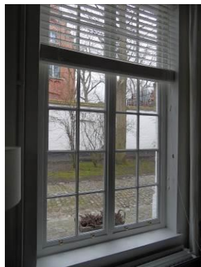
52A – gelijkvloers schuifraam enkelvoudige beglazing
