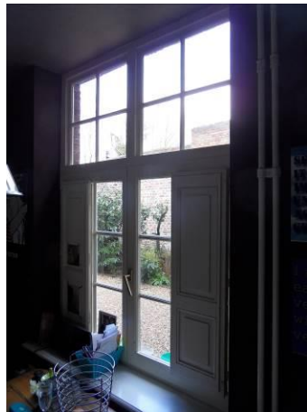
Opendraaiend raam bijgebouw
