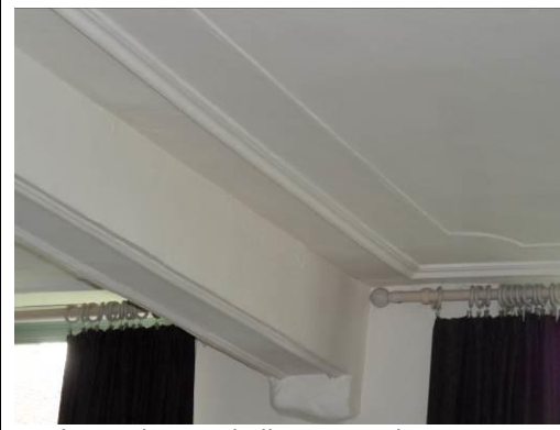
Bepleisterde moerbalk op console
