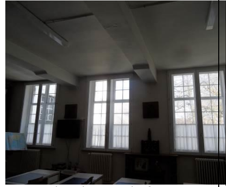
Voorgevel verdieping schuiframen met voorzetbeglazing gelijkvloers
