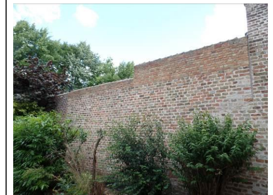
Scheidingsmuur / tuinmuur met huisnr. 10
