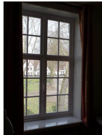
Voorgevel verdieping – opendraaiende ramen
