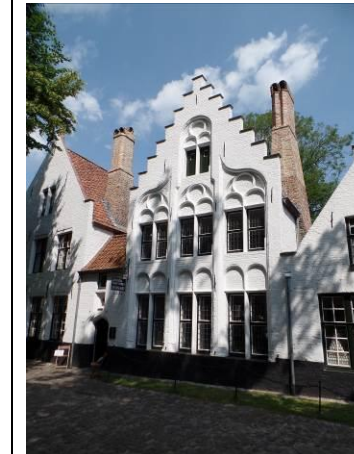
Voorgevel – vanaf rechterzijde
