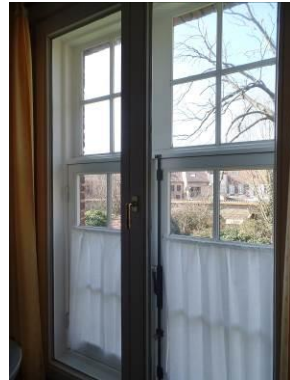
Achtergevel verdieping – opendraaiende ramen met voorzetramen
