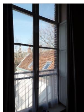
16C2 - Achtergevel verdieping
