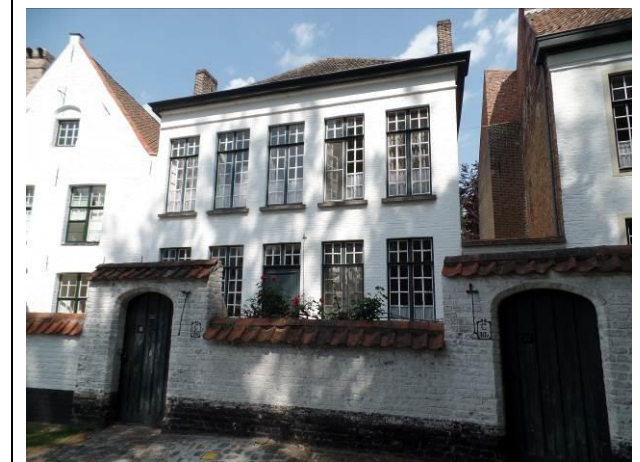
Voorgevel met voortuinmuur
