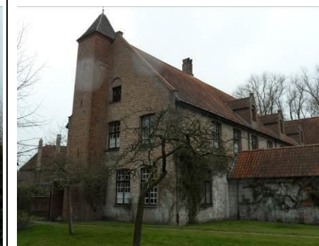
Linker zijgevel en achtergevel 24
