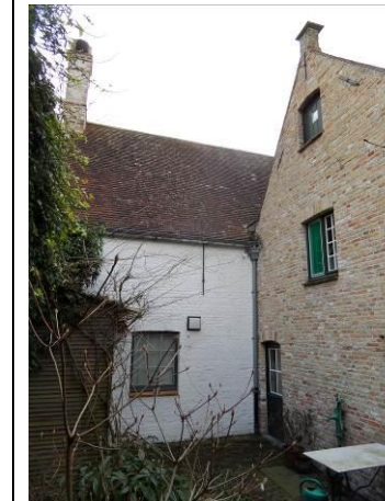
Linker zijgevel &amp; zicht achtergevel vanaf koer huis
