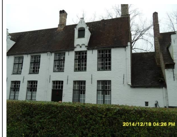
Voorgevel – zicht vanaf beluik
