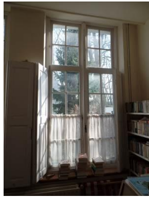
C1- voorgevel gelijkvloers
