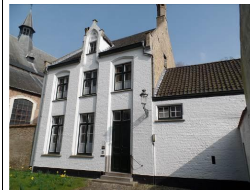
Voorgevel met rechter zijgevel
