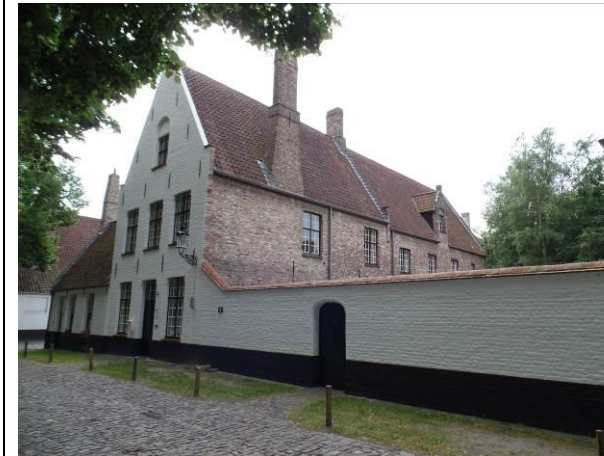
Voorgevel totaal met zicht op rechter zijgevel
