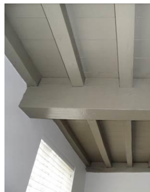
52A – bewaarde balkenlaag verdieping
