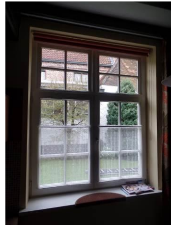
Nr. 36 - raam voorgevel
