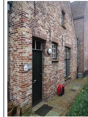
Achtergevel – inkom verdieping
