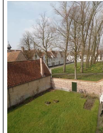
Zicht op tuin, voortuinmuur &amp; achtergevel Godshuizen
