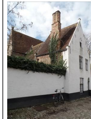
Voorgevel &amp; linker zijgevel
