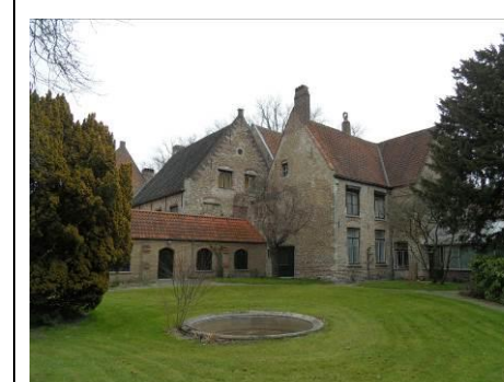
Achtergevel en rechter zijgevel
