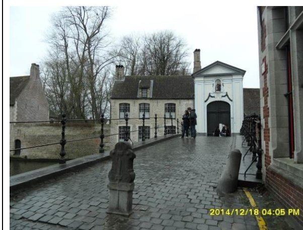
Brug – schamppaal zicht vanaf begin brug
