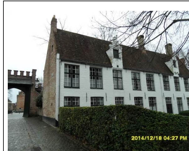
Voorgevel – zicht van linkerzijde
