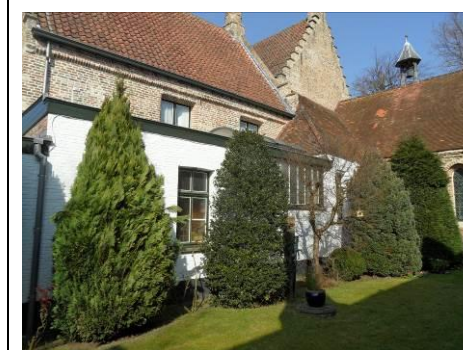
Linker zijgevel bijgebouw
