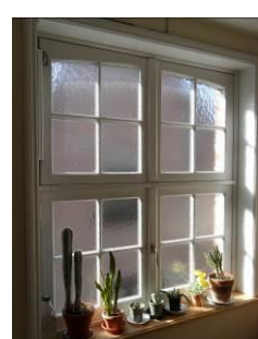
22 - zijgevel links verdieping 2
