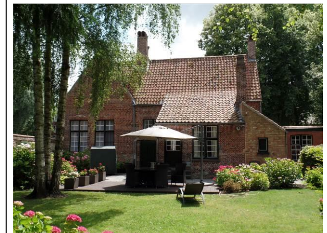
Achtergevel – gedeelte woonhuis
