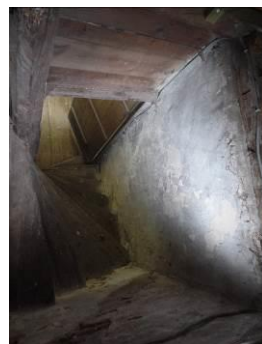
Zolder - trap naar verdieping 1
