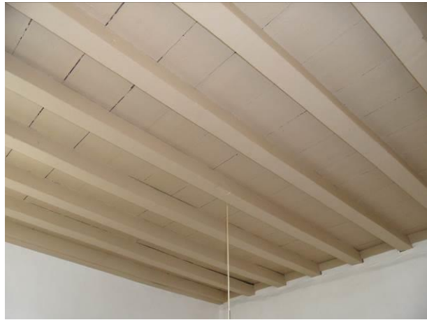
Gelijkvloers – bewaarde balkenlaag
