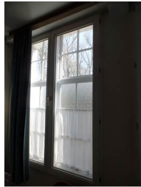
Voorgevel gelijkvloers – schuifraam met structuurbeglazing en voorzetraam
