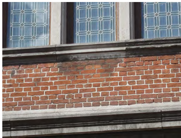
METSELWERK PLAATSELIJK AANGETAST DOOR VOCHTSCHADE, EEN FENOMEEN DAT VOORNAMELIJK TERUGKOMT ONDER DE BLAUWE HARDSTENEN LIJSTEN
