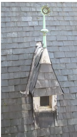
VERWEERD HOUTWERK DAKKAPEL
