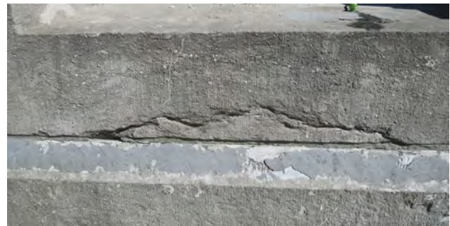
VAN LINKS NAAR RECHTS SCHADE AAN BLAUWE HARDSTEEN DOOR; UITGESPOELDE BRANDLAGEN, BARSTEN EN SCHEURTJES, HERSTEL MET WEINIG DUURZAME VOEGKIT EN OUDE HERSTELLINGEN
