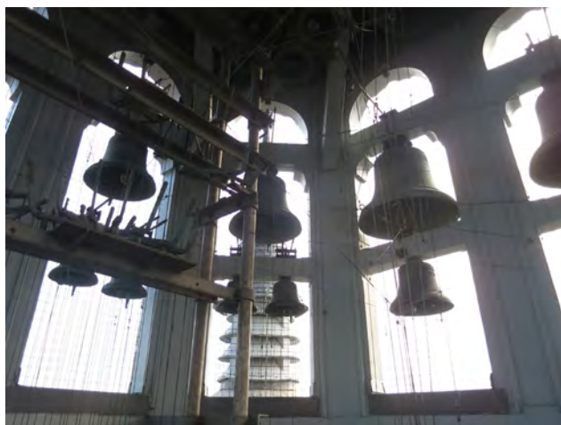
OPSTELLING VAN DE KLOKKEN
