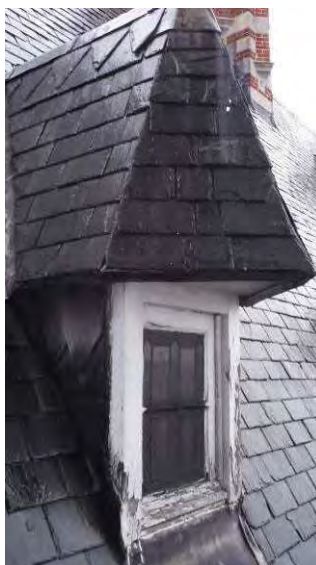
VERWEERD HOUTWERK DAKKAPEL
