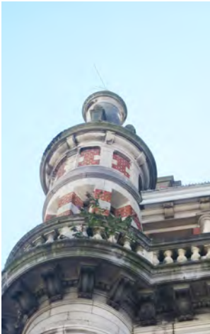
VAN LINKS NAAR RECHTS SCHADE AAN BLAUWE HARDSTEEN DOOR; VLINDERSTRIJK OP ÉÉN VAN DE HOEKTORENTJES EN MOSGROEI OP DE MONUMENTALE TRAP EN OP DE BORSTWEING VAN DE MEZZANINOVERDIEPING
