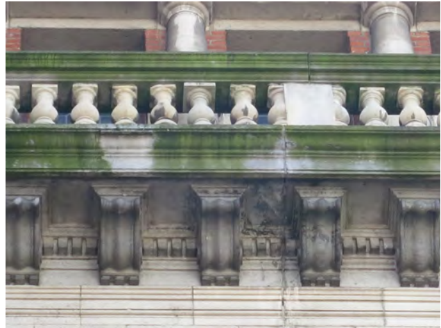
VAN LINKS NAAR RECHTS SCHADE AAN BLAUWE HARDSTEEN DOOR; VLINDERSTRIJK OP ÉÉN VAN DE HOEKTORENTJES EN MOSGROEI OP DE MONUMENTALE TRAP EN OP DE BORSTWEING VAN DE MEZZANINOVERDIEPING
