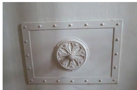
BOVEN: KERAMISCHE VERWARMINGSKANALEN INGE-METST IN DE VLOER, MIDDEN: BAKSTENEN VERWARMING-SCHACHT MET INGEWERKTE KERAMISCHE VERWARMING-SKANALEN, ONDER: KOPEREN MONDING TER AFWERKING VAN LUCHTUITGANGEN
