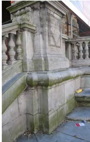
VAN LINKS NAAR RECHTS SCHADE AAN BLAUWE HARDSTEEN DOOR; VLINDERSTRIJK OP ÉÉN VAN DE HOEKTORENTJES EN MOSGROEI OP DE MONUMENTALE TRAP EN OP DE BORSTWEING VAN DE MEZZANINOVERDIEPING
