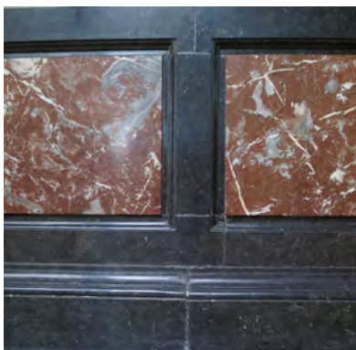
LAMBRISERING IN ROOD MARMER ST-RÉMY EN GEPOLIJSTE BLAUWE HARDSTEEN
