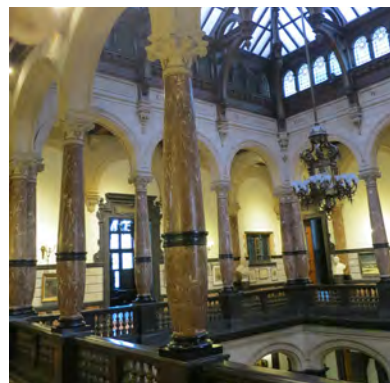
KOLOMMEN IN RODE MARMER VAN ST-RÉMY MET BASEMENT EN BANDEN IN ZWARTE MAR- MER VAN GOLZIN EN KAPITEEL VAN SAVONNIÈRE
