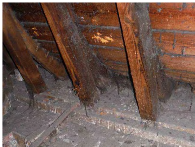
HOUTWERK TORENDAK MOGELIJK AANGETAST DOOR HOUTBOKTOR - FOTO MONUMENTENWACHT
