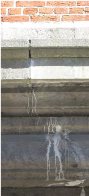
VAN LINKS NAAR RECHTS SCHADE AAN BLAUWE HARDSTEEN DOOR; UITGESPOELDE BRANDLAGEN, BARSTEN EN SCHEURTJES, HERSTEL MET WEINIG DUURZAME VOEGKIT EN OUDE HERSTELLINGEN
