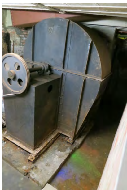
INSTALLATIE VAN HET ATELIER TOUSSAINT NYSSENNE
