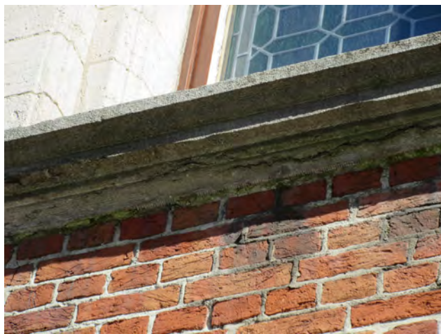
METSELWERK PLAATSELIJK AANGETAST DOOR VOCHTSCHADE, EEN FENOMEEN DAT VOORNAMELIJK TERUGKOMT ONDER DE BLAUWE HARDSTENEN LIJSTEN
