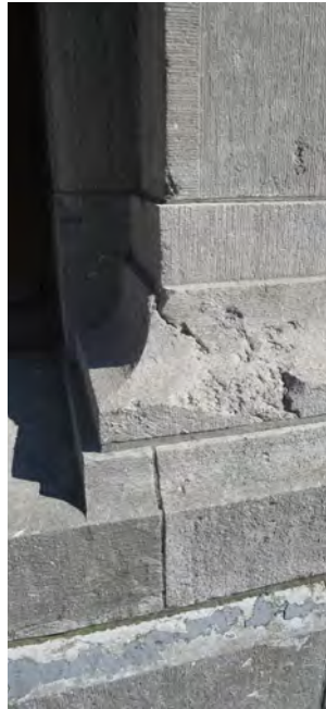
VAN LINKS NAAR RECHTS SCHADE AAN BLAUWE HARDSTEEN DOOR; UITGESPOELDE BRANDLAGEN, BARSTEN EN SCHEURTJES, HERSTEL MET WEINIG DUURZAME VOEGKIT EN OUDE HERSTELLINGEN
