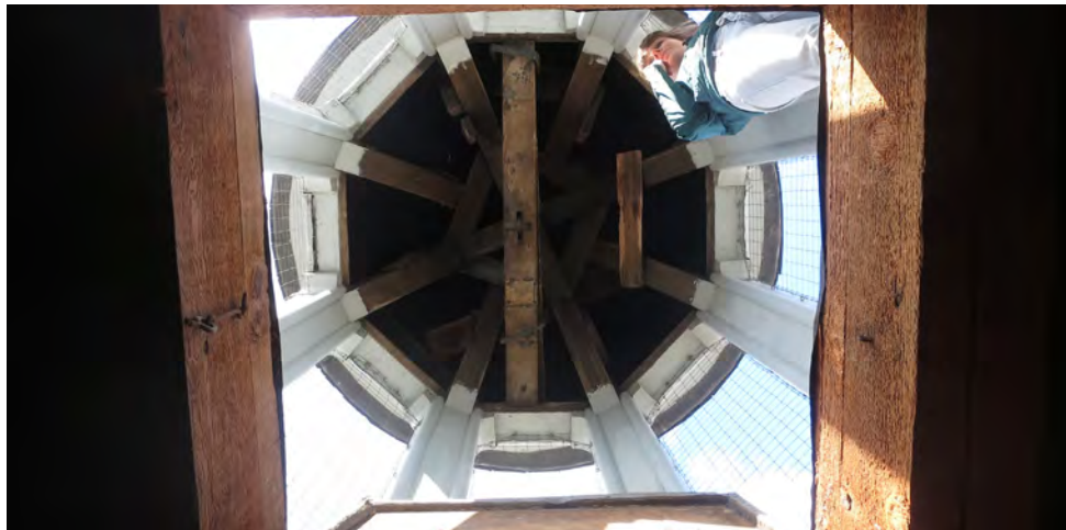
HOUTCONSTRUCTIE LANTAARN BEIAARDTOREN
