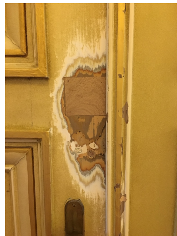
Foto – herstelling slotplaat binnendeur
