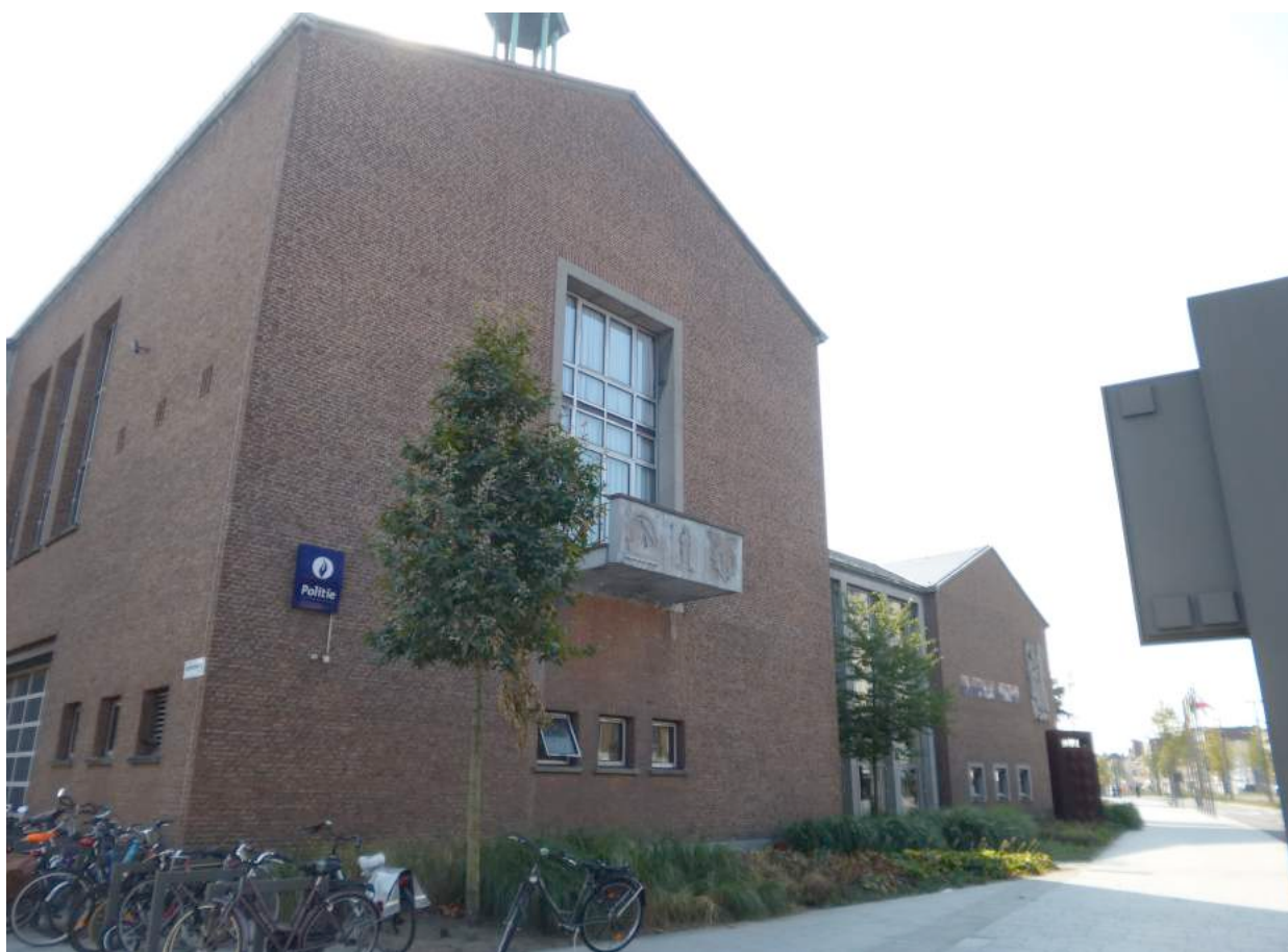
Foto 04: Aanzicht gevel Bredabaan
