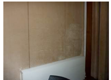
Foto aangetast wandbespanning (textiel)
