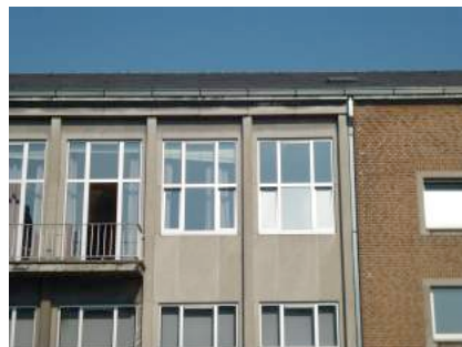
Foto gevelpartij - regenwaterafvoer, balkon en dak
