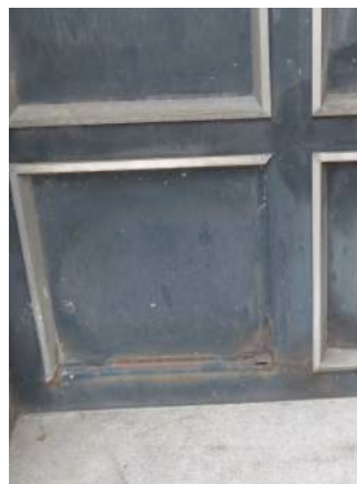
Foto verroest buitenschrijnwerk
