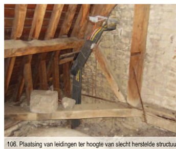
106. Plaatsing van leidingen ter hoogte van slecht herstelde structuur
