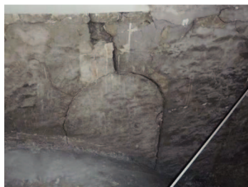
87. Aftekening van een dichtgemetseld Romaans raam in de wanden
