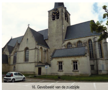
16. Gevelbeeld van de zuidzijde
