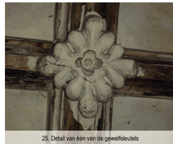
25. Detail van één van de gewelfsleutels
