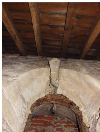
53. Sluitsteen van een van de Romaanse ramen die uit het metselwerk komt.
