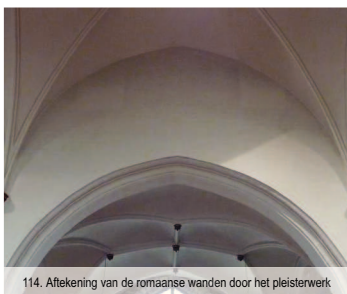
114. Aftekening van de romaanse wanden door het pleisterwerk
