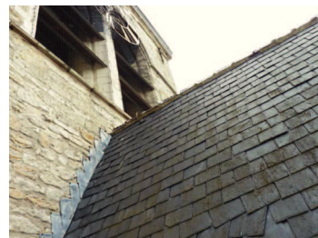
95. Aansluiting van het schip aan de toren met losliggende leien
