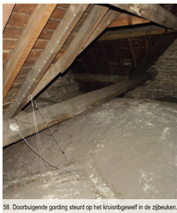
58. Doorbuigende gording steunt op het kruisribgewelf in de zijbeuken.
