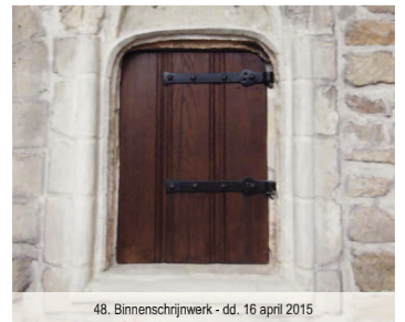
48. Binnenschrijnwerk - dd. 16 april 2015
