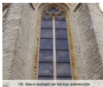
130. Glas-in-loodraam van het koor, exterieurzijde
