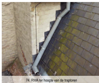
74. RWA ter hoogte van de traptoren
