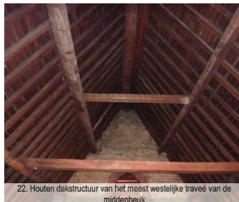
22. Houten dakstructuur van het meest westelijke travee van de middenbeuk
