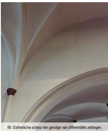
60. Esthetische scheur ten gevolge van differentieële zettingen.
