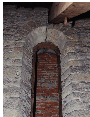
55. Romaanse raamopening met een ongelukkig geplaatst spantonderdeel.
