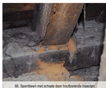
66. Spantbeen met schade door houtborende insecten
