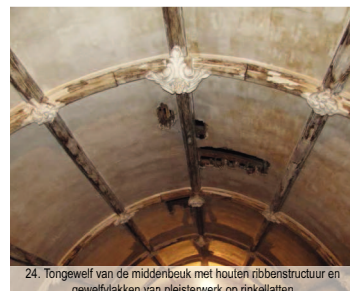
24. Tongewelf van de middenbeuk met houten ribbenstructuur en gewelfvlakken van pleisterwerk op rinkelatten
