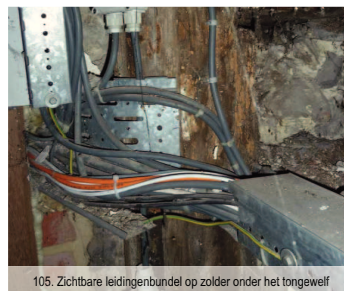
105. Zichtbare leidingenbundel op zolder onder het tongwelf
