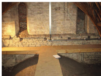
86. Loopbruggen in de dwarsbeuk voldoen niet aan veiligheidvoorschriften
