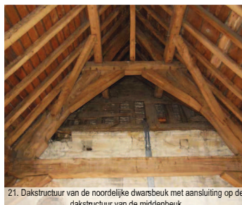
21. Dakstructuur van de noordelijke dwarsbeuk met aansluiting op de dakstructuur van de middenbeuk
