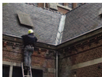
65. Foto van een inspectie (Foto Monumentenwacht vzw)
