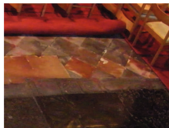
117. Impact van het schurend effect van de matten op de graven
