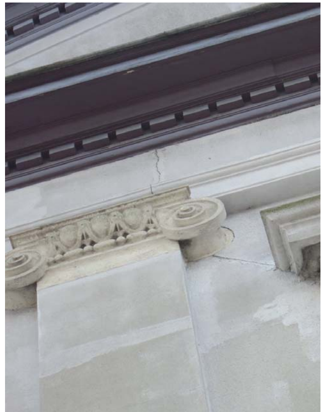
DETAIL WITTE STENEN ORNAMENT EN HOUTEN TANDLIJST AAN DE VOORGEVEL
