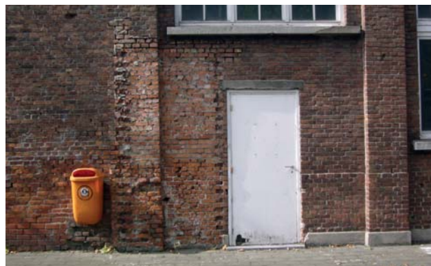
BESCHADIGD GEVELMETSSELWERK TURNZAAL
