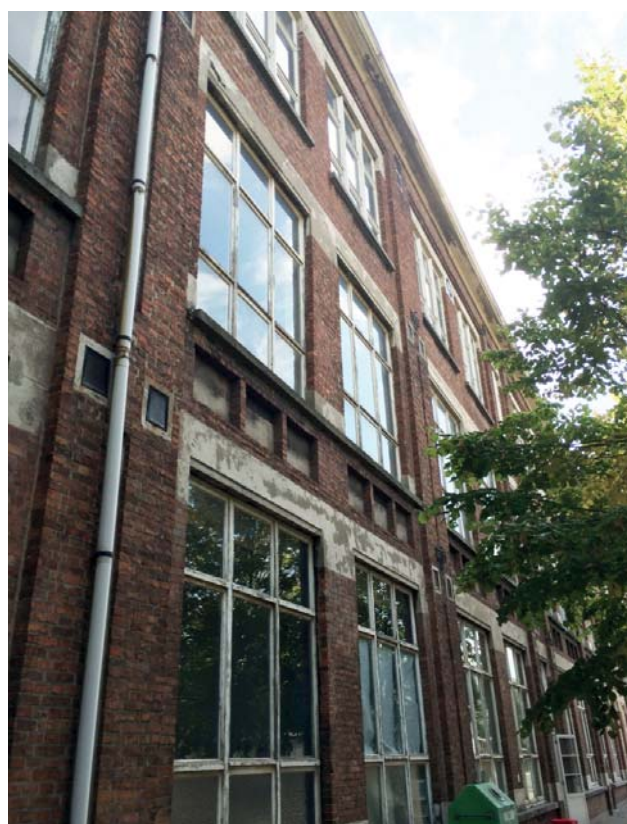
LICHT VERVULD BAKSTEEN PARAMENT EN GECEMENTEERDE GEVELVLAKKEN
