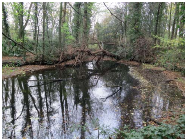
IJZEREN HANGBRUG MET VIJVER ZELZATE
