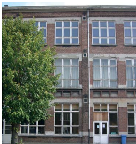
DE OPHOGING EN VERLENGING VAN DE KLASSENBAK GE- BEURDE MET ANDER TYPE BAKSTEEN
