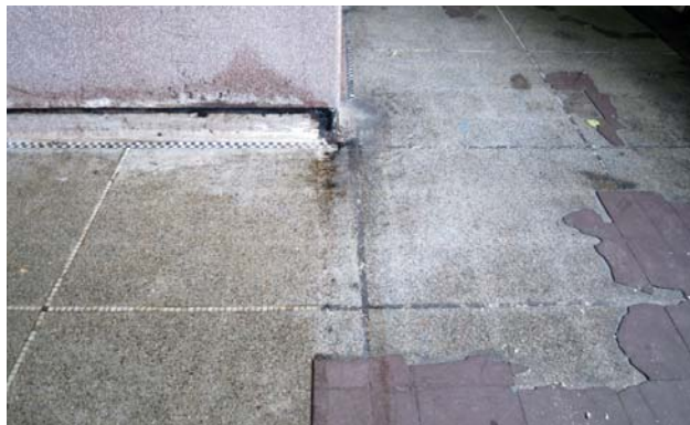
TESTZONE VERWIJDERING ASBESTVERLIJNDE VINYLTEGELS
