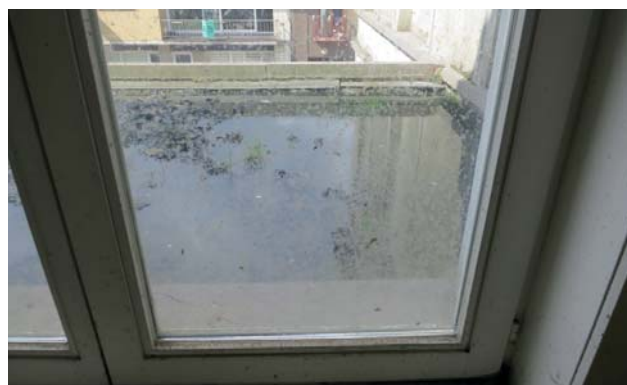
WATERPLAS OP HET PLAT DAK VAN HET LINKER OKSELPORTAAL
