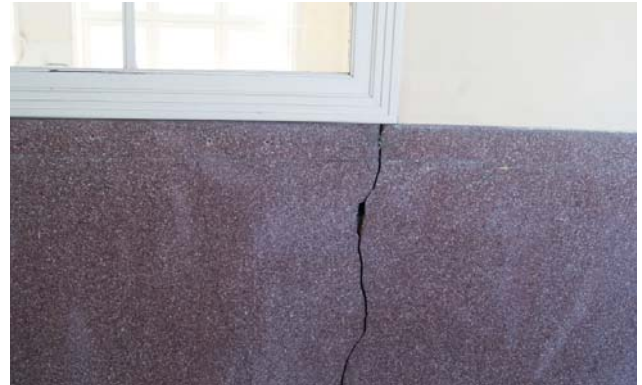
GEBARSTEN STEENTAPIJT LAMBRISERING
