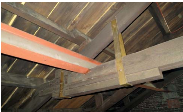
DETAIL LATERE VERSTEVIGING SPANTSTRUCTUUR
