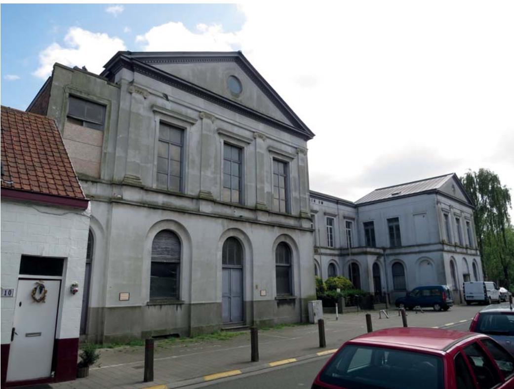
FOTO 2 - STRAATGEVEL BESCHERMD NEOCLASSICISTISCH MONUMENT
