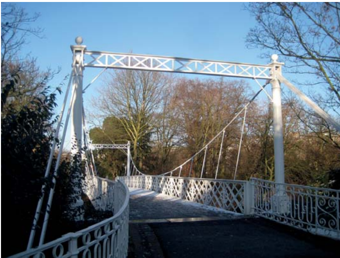
IJZEREN HANGBRUG - STADSPARK ANTWERPEN (1867-1869)
