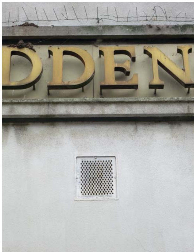
DETAIL VAN METALEN GEVELBELETTERING
