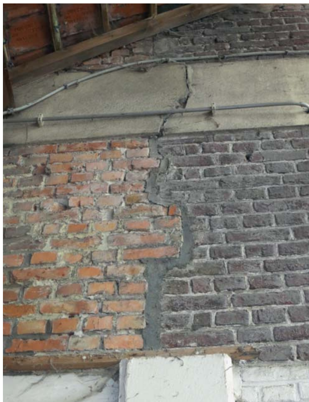
BOUWNAAD TER HOOGTE VAN DE LATER TOEGEVOEGDE LUIFEL
