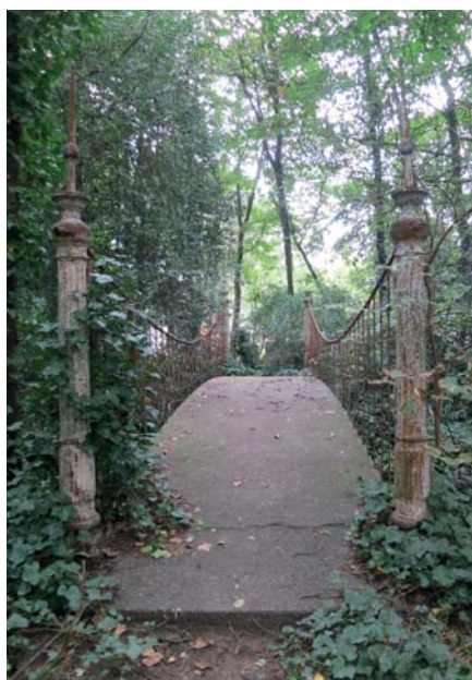
LINKS - HANGBRUG KASTEEL TER WALLE - uit; I.WOUTERS EN M. DE BOUW, 19e eeuwse sierbruggen in België, Bruggen (Nederlandse Bruggen Stichting), jrg. 6 (2008) 1, cover.
