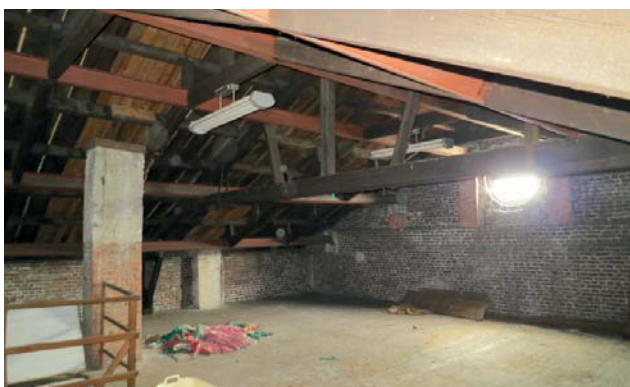
SPANTCONSTRUCTIE ZOLDER RECHTERZIJVLEUGEL
