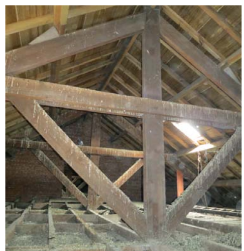
SPANTCONSTRUCTIE ZOLDER KLASSENBAK
