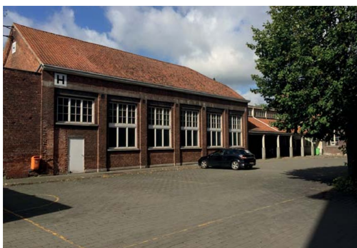
SPEELPLAATSGEVEL VAN DE TURNZAAL MET BOUWSPOR VAN EERDERE AANBOUW IN DE EERSTE TRAVEE
