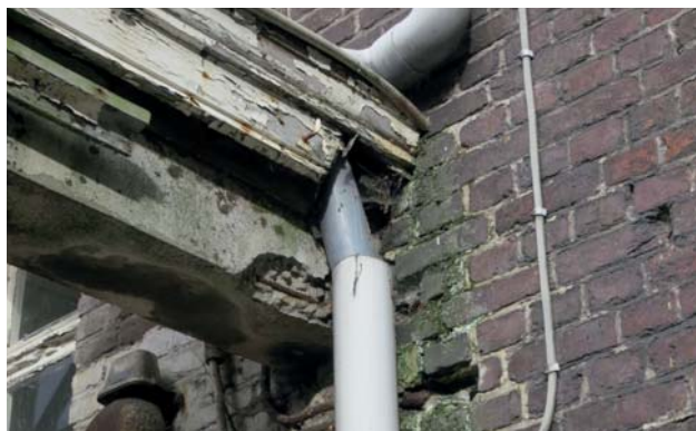
VERWEERD METSELWERK TER HOOGTE VAN AANSLUITING MET GOOT
