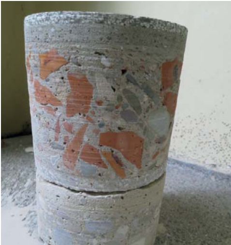
OPBOUW BETONNEN VERDIEPINGSVLOER KLASSENBAK
