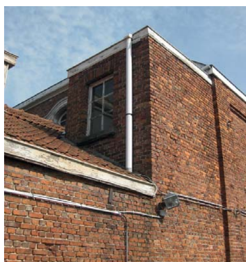
DETAIL VAN BAKSTEEN PARAMENT DE ACHTERGEVEL VAN DE OVERDEKTE LUIFEL EN TURNZAAL
