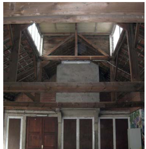
SPANTCONSTRUCTIE OVERDEKTE LUIFEL SPEELPLAATS
