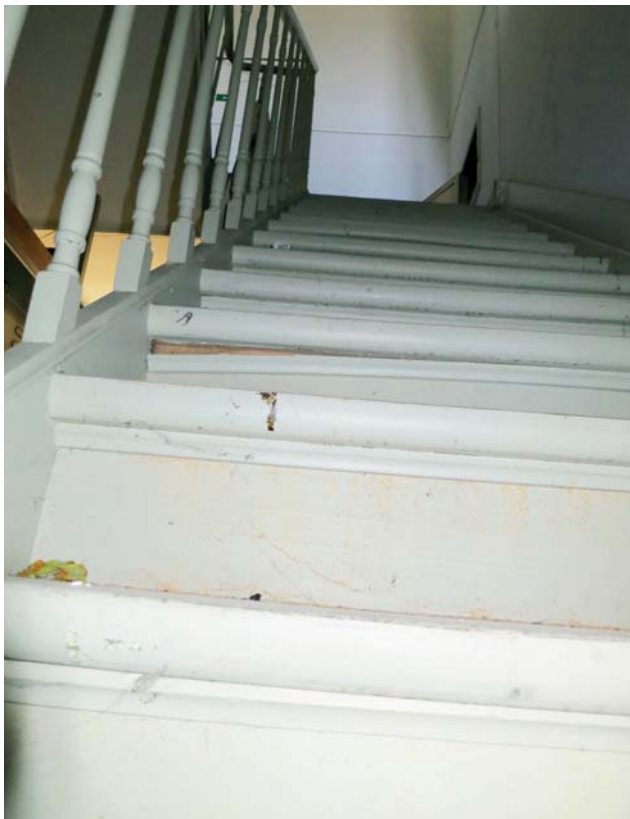
LOSHANGEND HOUTEN TRAPNEUSPROFIEL
