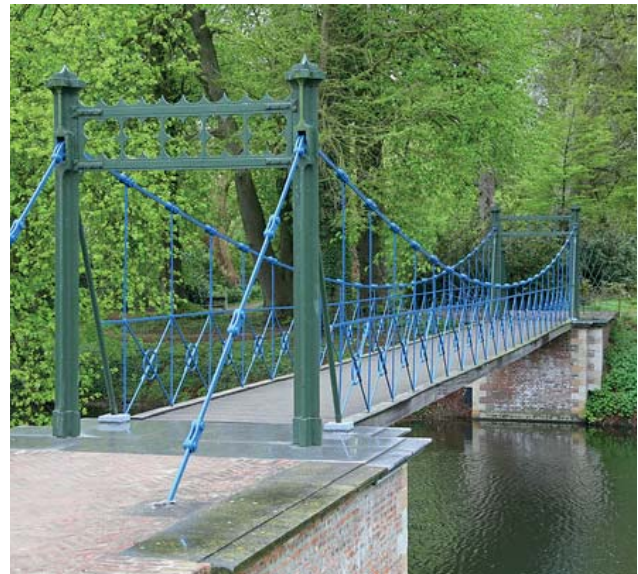
DE VOETGANGERSBRUG IN WISSEKERKE NA RESTAURATIE
