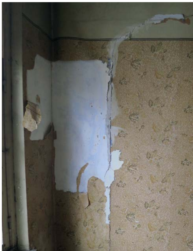
SCHEUR TER HOOGTE VAN OUDE MUUROPENING
