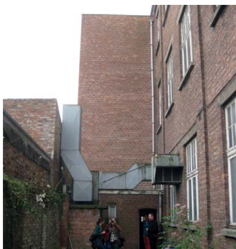
DE LATER TOEGEVOEGDE TRAPPENKOKER WERD OPGE- TROKKEN MET EEN ANDER TYPE BAKSTEEN
