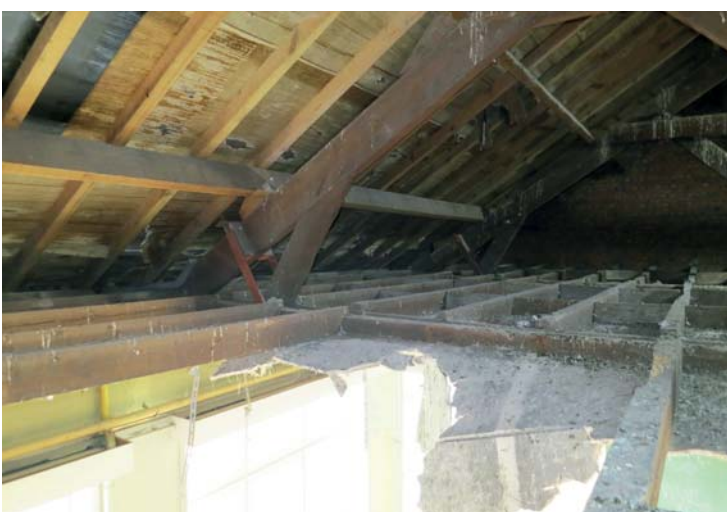
HOUTEN ROOSTERING ZOLDERVLOER KLASSENBAK
