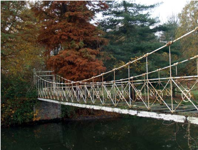
IJZEREN HANGBRUG - KASTEEL WISSEKERKE BAZEL (1824)
