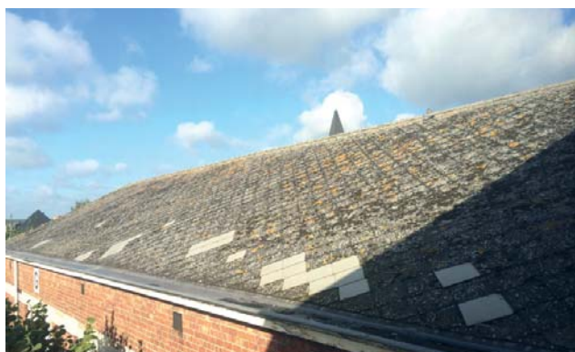
ASBESTCEMENT LEIEN EN ZINKEN GOOTBEKLEDING MIDDENVLEUGEL
