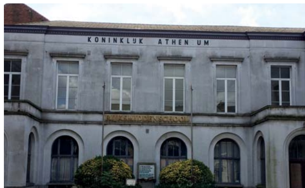
VOORGEVEL MET TWEE TYPES GEVELBELETTERING
