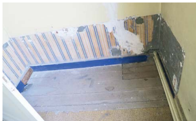
PLAATSELIJK HERSTELDE PLANKENVLOER
