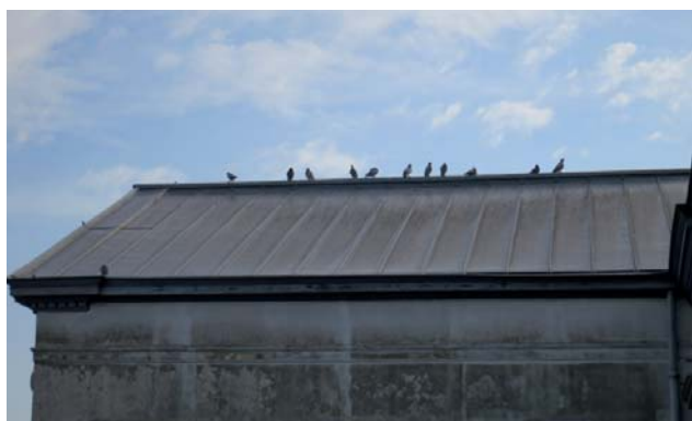
ZINKEN DAKBEDEKKING MET STAANDE NAAD VAN DE LINKERZIJVLEUGEL
