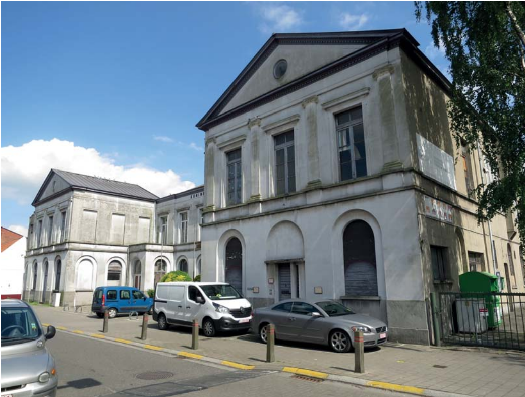
FOTO 1 - STRAATGEVEL BESCHERMD NEOCLASSICISTISCH MONUMENT
