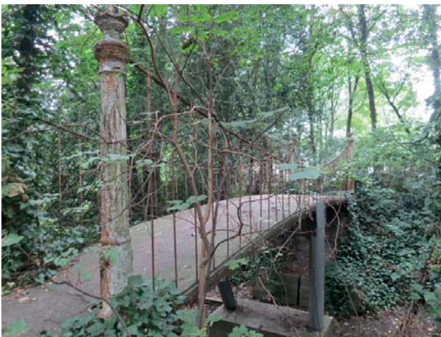
IJZEREN HANGBRUG ZELZATE
