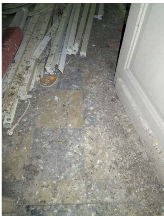
VERVUILDE CEMENTTEGELVLOER
