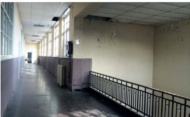
VERLAAGDE PLAFONDS EN AFBLADEREND SCHILDERWERK IN KLASSENBAK
