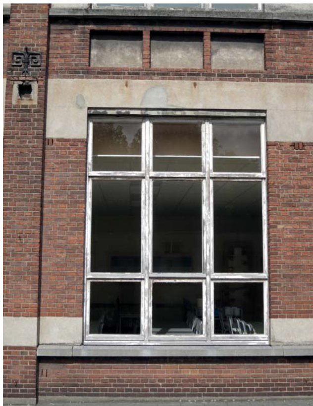
LICHT VERVULDE GECEMENTEERDE BANDEN EN -VLAKKEN
