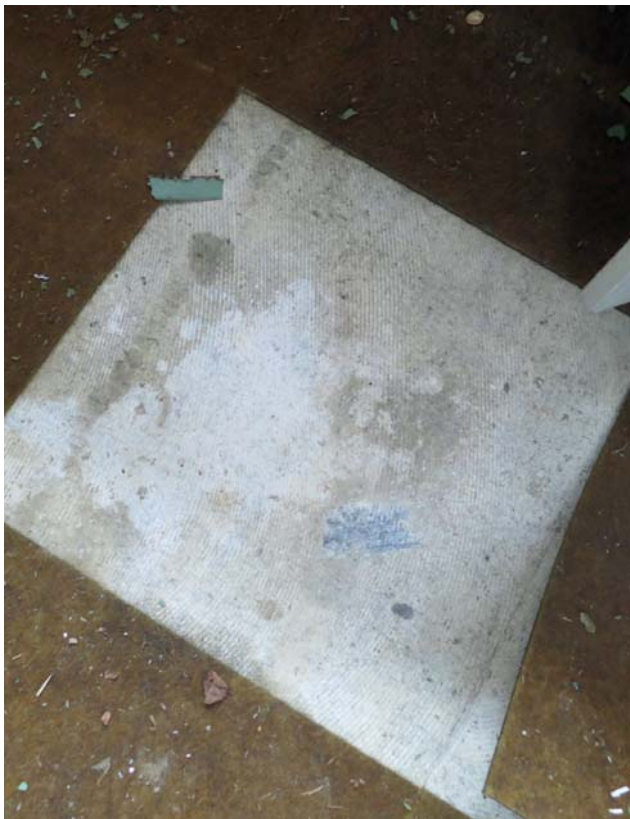
ORIGINELE TERRAZZO ONDER VERLIJNDE TAPIJTTEGELS
