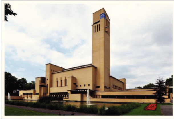
Afb. 37: Het raadhuis van Hilversum van architect Willem Dudok
