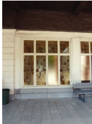
Afb. 47: Detail ramen gelijkvloers zijgevel klooster, anno 2015
