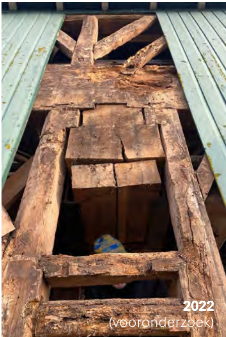
vangrecht Aansluiting middenlijst op steenbalk.
