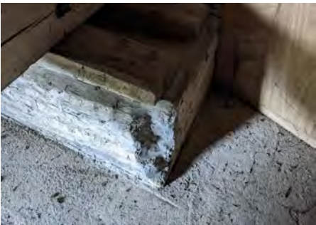
Laagteteerling met ontbrekende hoek (2022)
