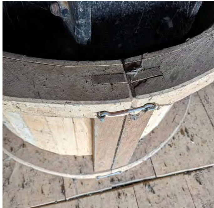
De molenstaak heeft op de buil- en meelzolder een ronde houten omkasting.
