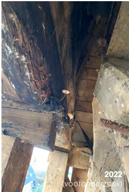
windweeg Zwaar aangetaste windplum.
