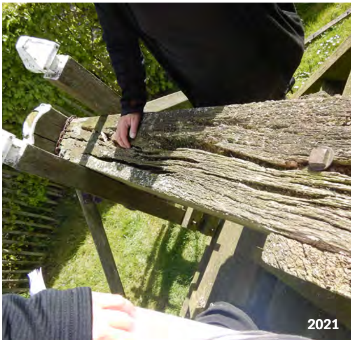
STAART De staart, om de molen te kruien, steekt in een raveelconstructie doorheen de trap. Deze gekromde eiken balk is begroeid met korstmos en momenteel bovenaf afgeschermd met plaatmateriaal op latwerk. Een foto van 2021 toont grote scheuren en zwaar beschadigd hout aan de bovenkant. De pennen op de kop van de staart zijn gescheurd.
