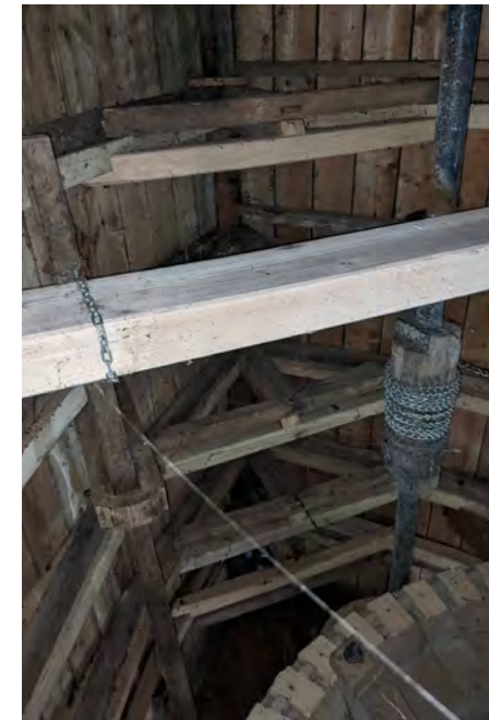
Het luitouw is intact en hangt tot op de builzolder.
