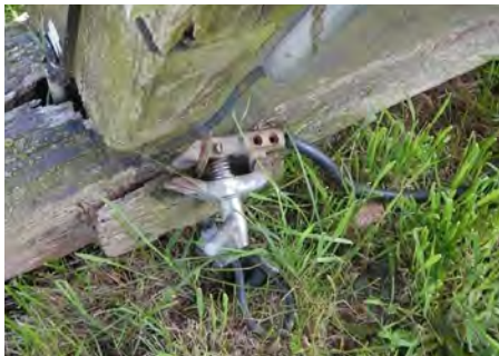
BLIKSEMBEVEILIGING Er is bliksemafleiding aanwezig op de windvaan en op het gevlucht. Er is niet geweten of deze nog in orde is. Monumentenwacht herbevestigde de klem onderaan de trap in 2021.
