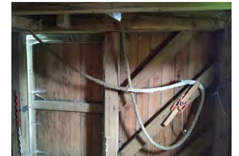
Het luitouw is intact en hangt tot op de builzolder.
