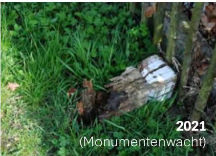
De houten kruipalen zijn in zeer slechte staat. De diameter van de kruipalen varieert en ligt tussen de 15,7 en 17,0m. Volgens beheersplannen van Freddy De Schacht is de inplantingscirkel voor kruipalen bij een houten staakmolen idealiter 18m. Er moet onderzocht worden of de cirkel hier best vergroot wordt of niet.
