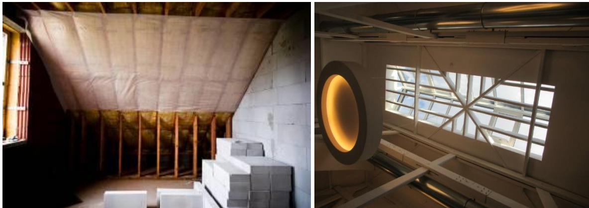
Figuur 13: Isolatie hellend dak langs binnenzijde
