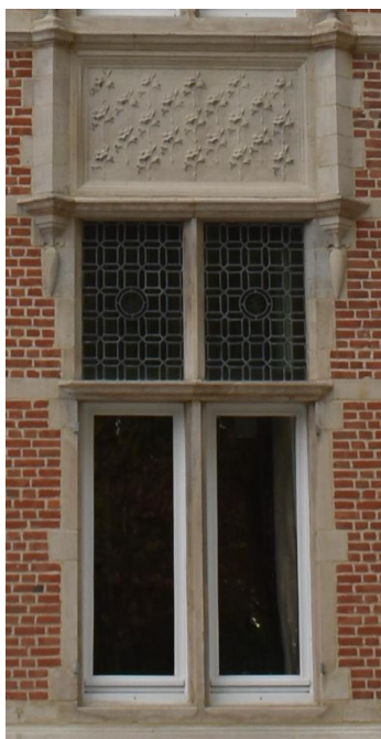
Figuur 37: Kruisvensters gelijkvloers voorgevel
