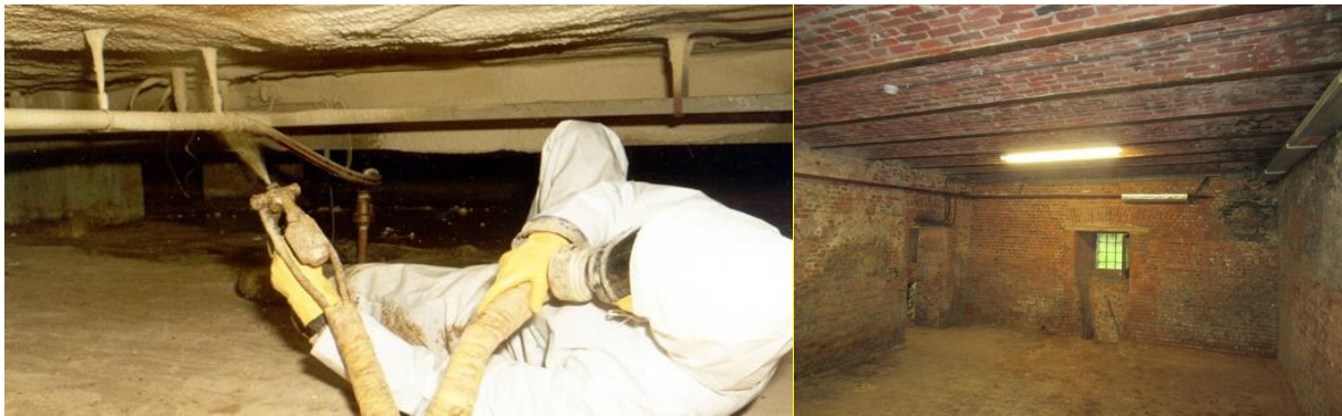
Figuur 16: Keldervloerisolatie: aanbrengen PU-schuim
