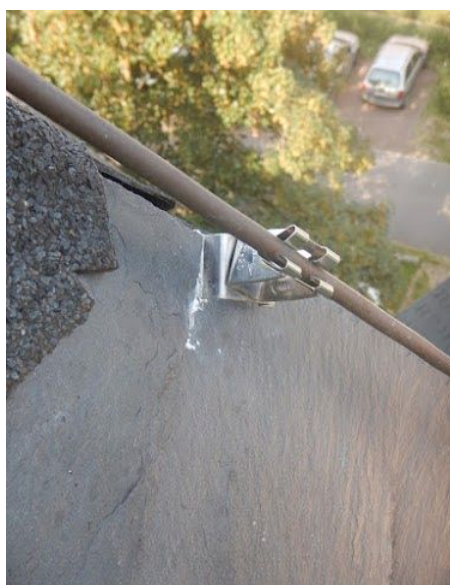
Niet-genagelde bevestiging (bevestiging met kit)
