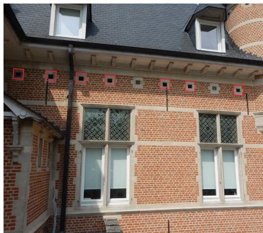
Vleugel [9]: niet-afgedichte stellinggaten
