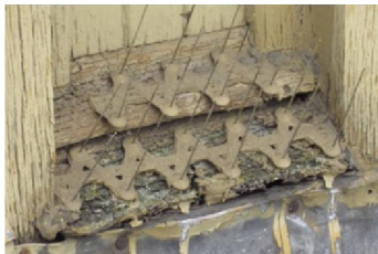
Stalen pennen: controleer regelmatig de bevestiging. ⑤
