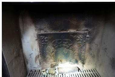
haardwand met plaat
