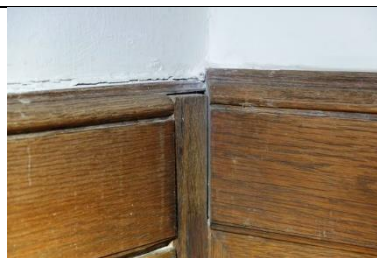
niveauverschil tussen deklatten
