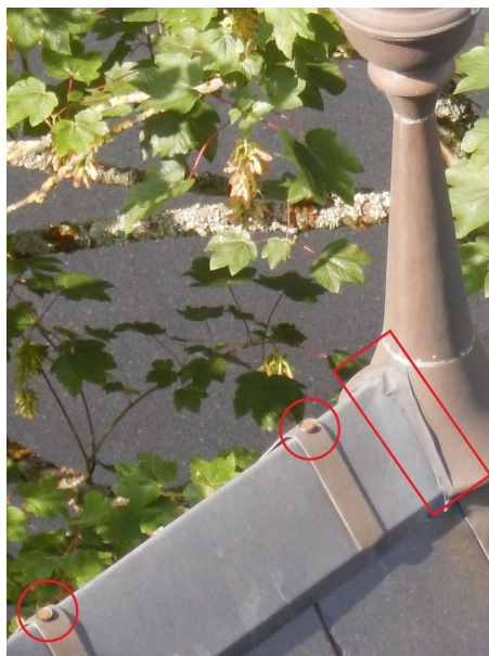
Dakkapel: de kit tussen de nok en de piron begint los te scheuren. Roestige nagels van de nokbeugels
