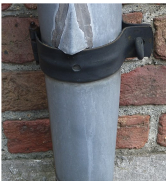
Controleer of de (scharnier-) beugels goed vast zitten.
