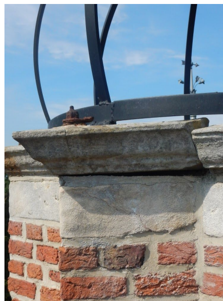
[5]-zuidwest: losliggende deksteen (vermoedelijk opgedrukt door een roestig anker)
