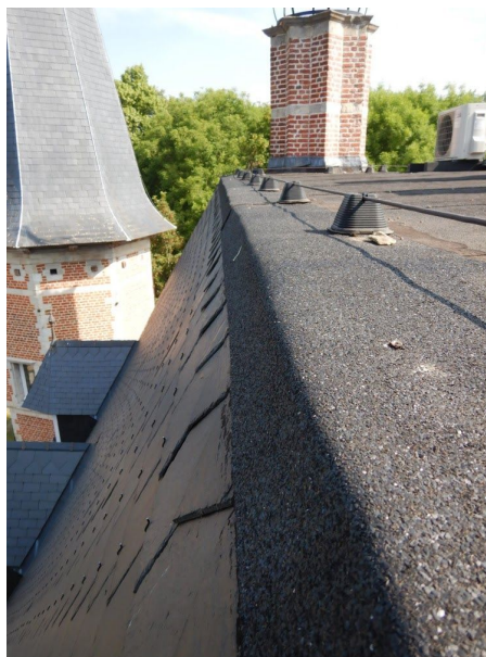
Dak [5]/[7]: de roofing van dak [5] werd over de bovenste rij leien gebrand
