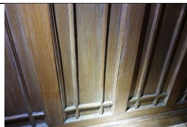
vervormde panelen
