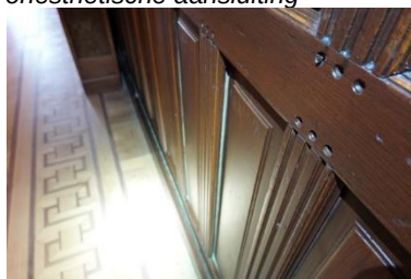
loszittende panelen met doorkijk naar de muur
