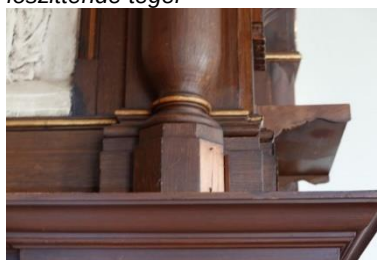
ontbrekend stuk lijstwerk
