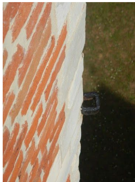
Toren [2]: ontbrekende schieter
