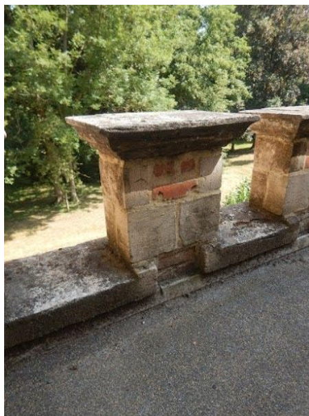
[15]-noord: verschillende dekstenen...
