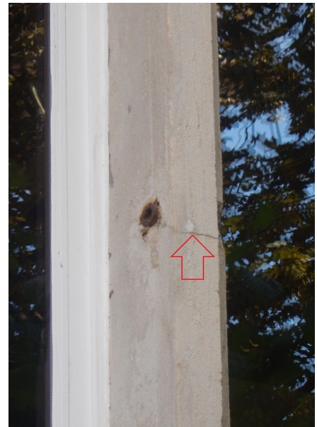
Vleugel [7]: ingescheurd moneel door roestig grendeloog
