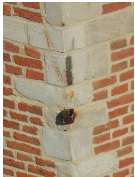
Toren [2]: ontbrekende schieter
