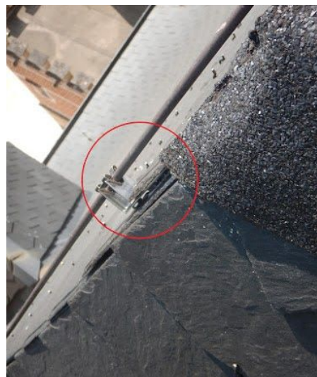
Niet-genagelde bevestiging (bevestiging met kit)
