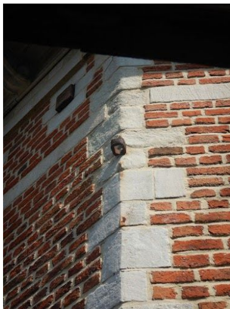
Toren [2]: ontbrekende schieter
