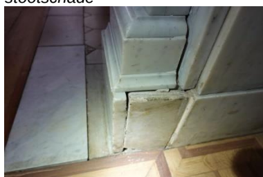
ontbrekend voegwerk onderaan en tussen haardbalk en blad
