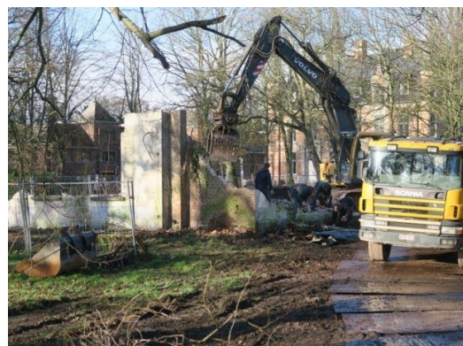
Boerderij en remises bij het kasteel (tijdens de afbraak)
