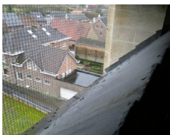
Plaats gaas aan de buitenzijde van de galmboarden zodat duiven niet op de galmboarden kunnen
