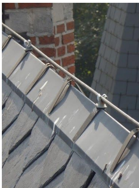
Dak [10]: opgedrukte nokbeugels...
