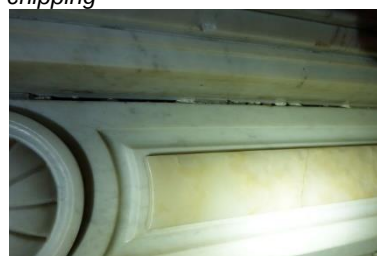
ontbrekend voegwerk onderaan en tussen haardbalk en blad
