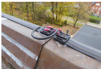
Schrikdraad met elektromagnetisch pulssysteem. ④
