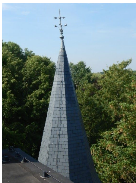
Toren [1]: scheefstaande bekroning
