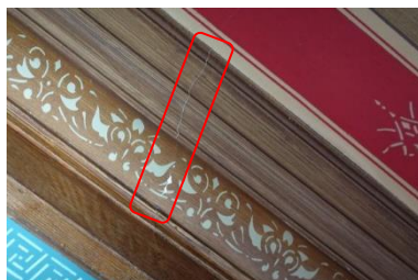
barst met afschilfering
