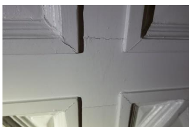
craquelures in de verflaag
