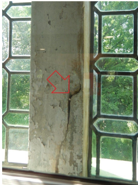
Vlaamse gevel [13]: ingescheurd moneel van bovenlicht
