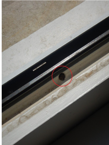
Vleugel [11]: verstopt condensafvoertje raam
