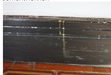
druipsporen op de houten plint
