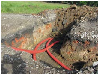
Een bodemingreep: het aanleggen van nutsleidingen
