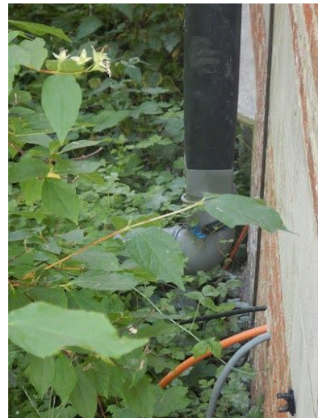
Dak [7]: provisoire aanpassing van de monding van één van de afvoeren
