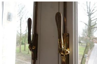
vervormd sluitwerk
