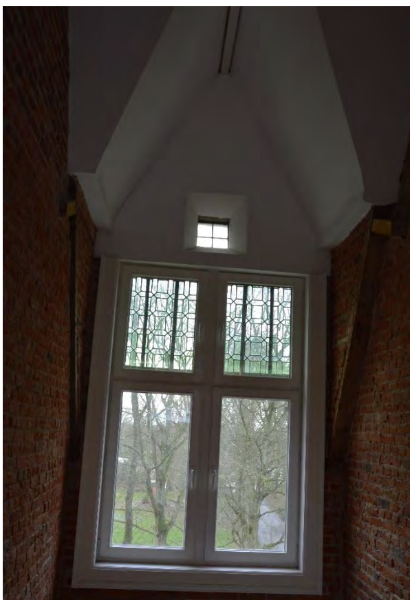
Fig. 217 - Het hoogste raam (dakkapel), met steigergat.
