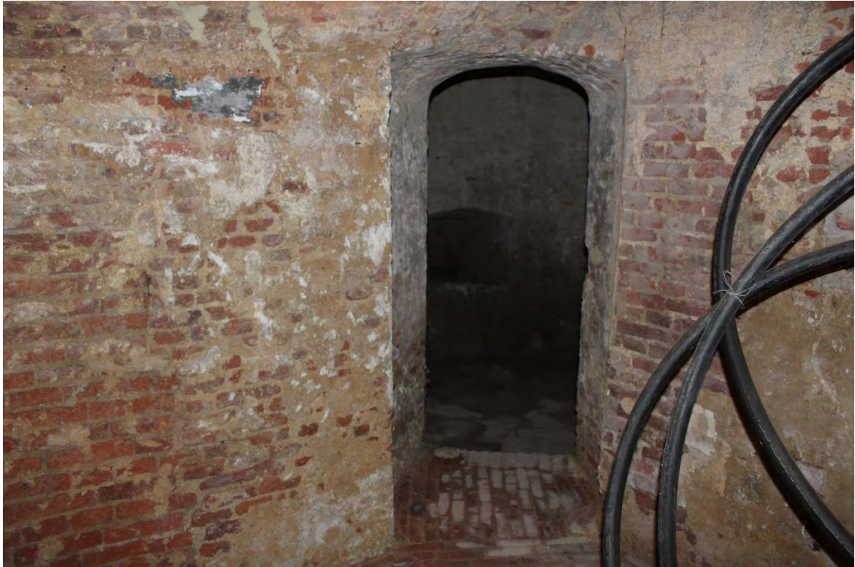
Fig. 89 - Doorgang van kelder -110 naar de kelder van de NW-hoektoren.
