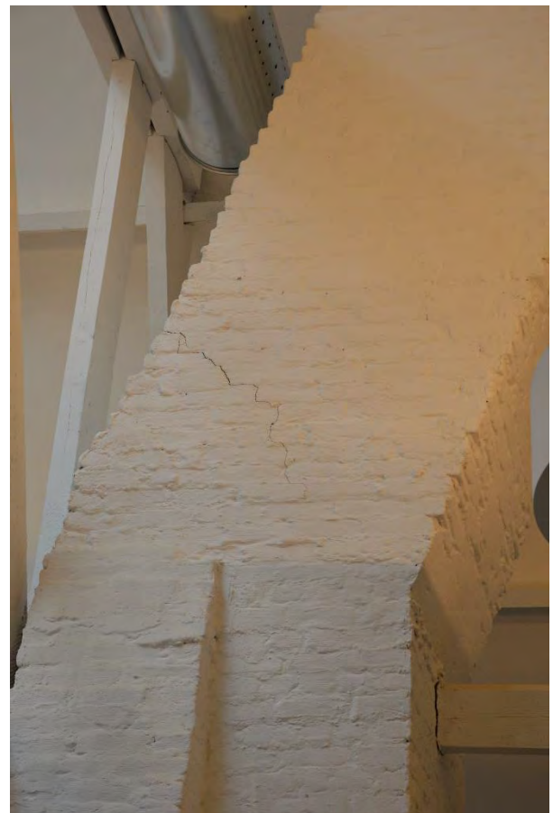
Fig. 229 - Verstevinging van de koppelingen van de Fig. 230 - Bakstenen schoorsteenkanaal, met scheur. horizontale balkenstructuur.
