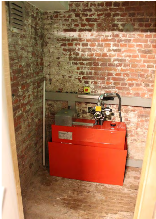
Fig. 74 - De machinekamer van de personenlift, in het lokaaltje achteraan kelder -103.
