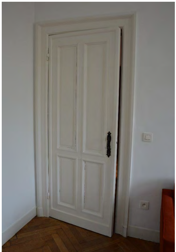
Fig. 206 - De toegangsdeur, interieurzijde.
