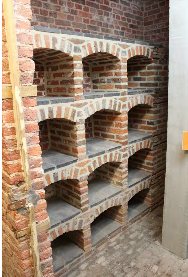
Fig. 79 - De wijnrekken (zonder erfgoedwaarde) in kelder -105.
