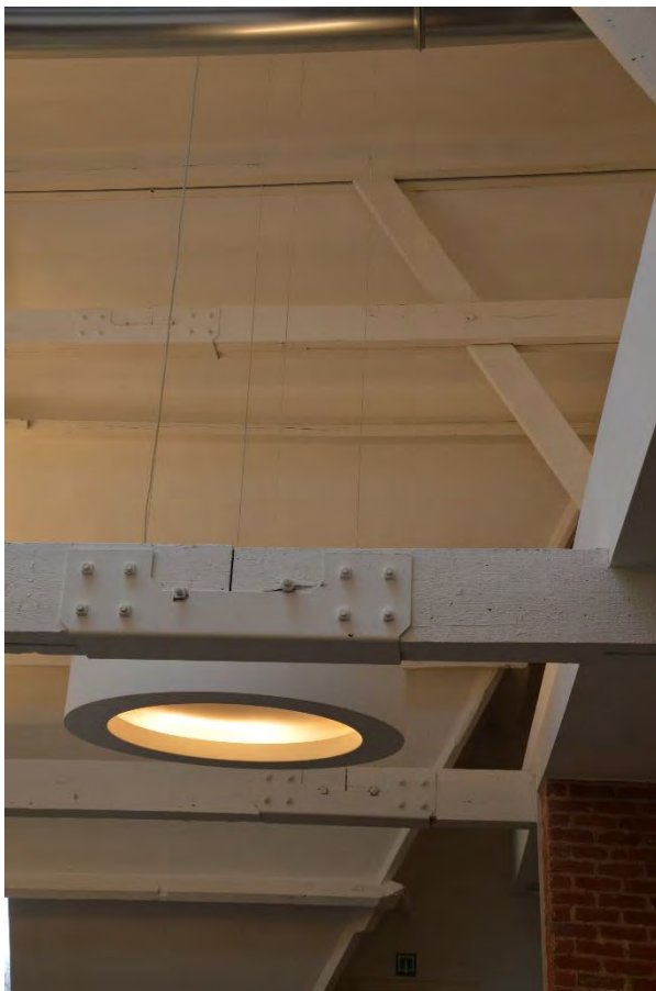
Fig. 229 - Verstevinging van de koppelingen van de Fig. 230 - Bakstenen schoorsteenkanaal, met scheur. horizontale balkenstructuur.
