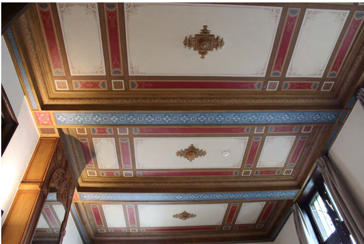
Fig. 129 - Polychroom beschilderd stucplafond van lokaal 009.
