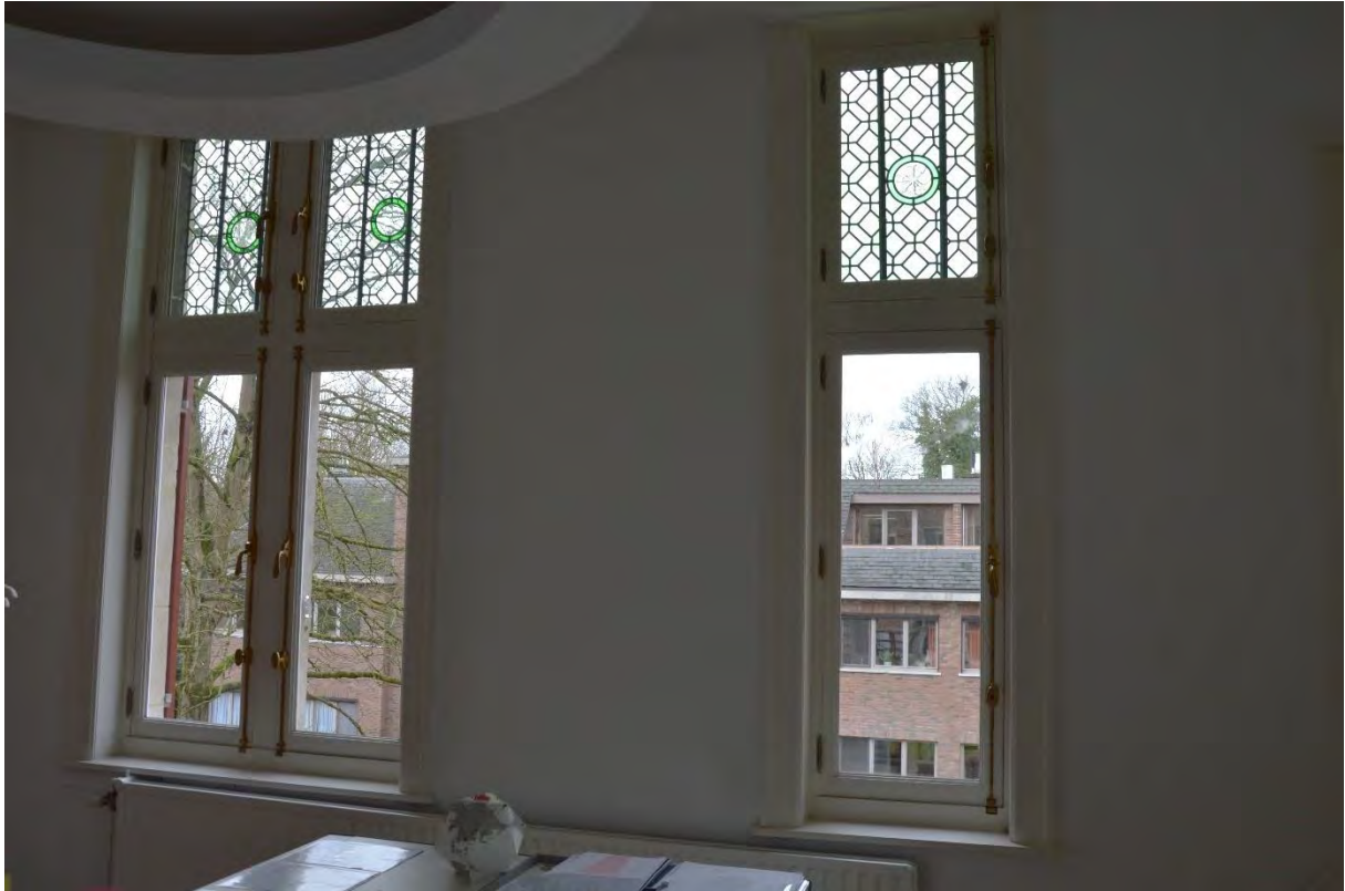
Fig. 204 - Lokaal 112, zicht naar het westen.
