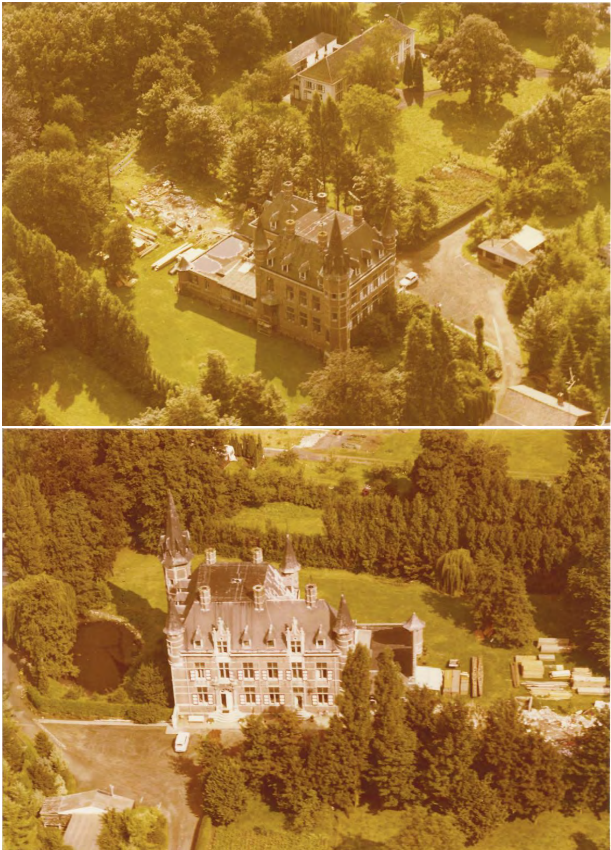
Fig. 34 - Deze twee foto's dateren van later (eind jaren 1970 of in de jaren 1980?). Op de bovenste foto is het dienstgebouw uit de vroege 19 de eeuw te zien. Op de onderste foto zien we het kasteel. Het bijgebouw ten oosten van het kasteel was op dat moment zopas gesloopt, de bouwmaterialen liggen verspreid op het gras. De vijver ten westen van het kasteel is goed herkenbaar.
