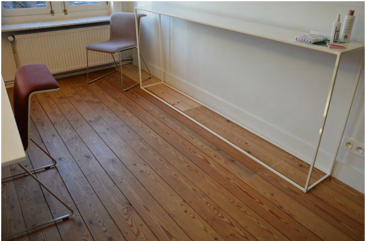
Fig. 215 - De plankenvloer en de vernieuwde planken t.h.v. de noordelijke wand.
