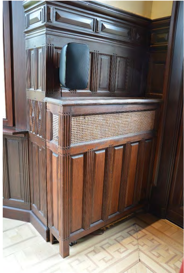
Fig. 160 - Eén van de radiatoromkastingen.
