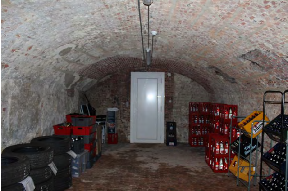
Fig. 86 – Kelder -109, zicht naar het zuiden. Samen met de aanpalende kelder (-110) is dit één van de restanten van het oude kasteel.
