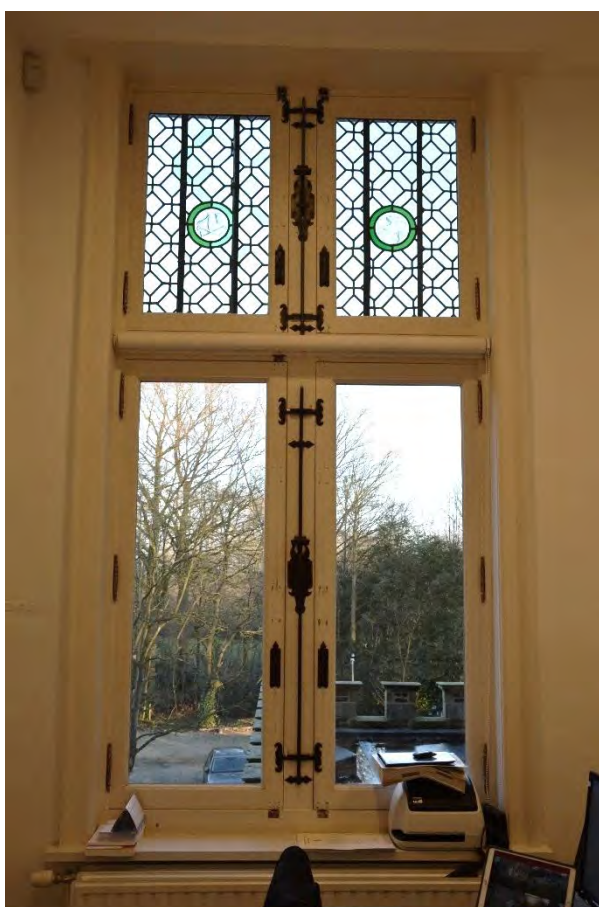
Fig. 197 - Het vernieuwde kruiskozijn met gerecupereerde oorspronkelijke spanjoletsluiting.
