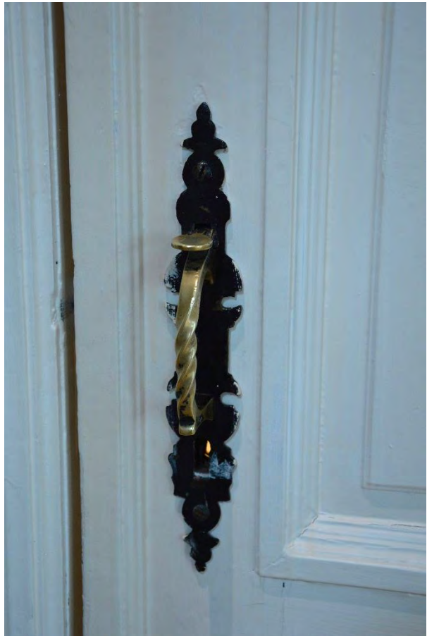
Fig. 169 – Detail van de paneeldeur met oorspronkelijke koperen deurkruk.
