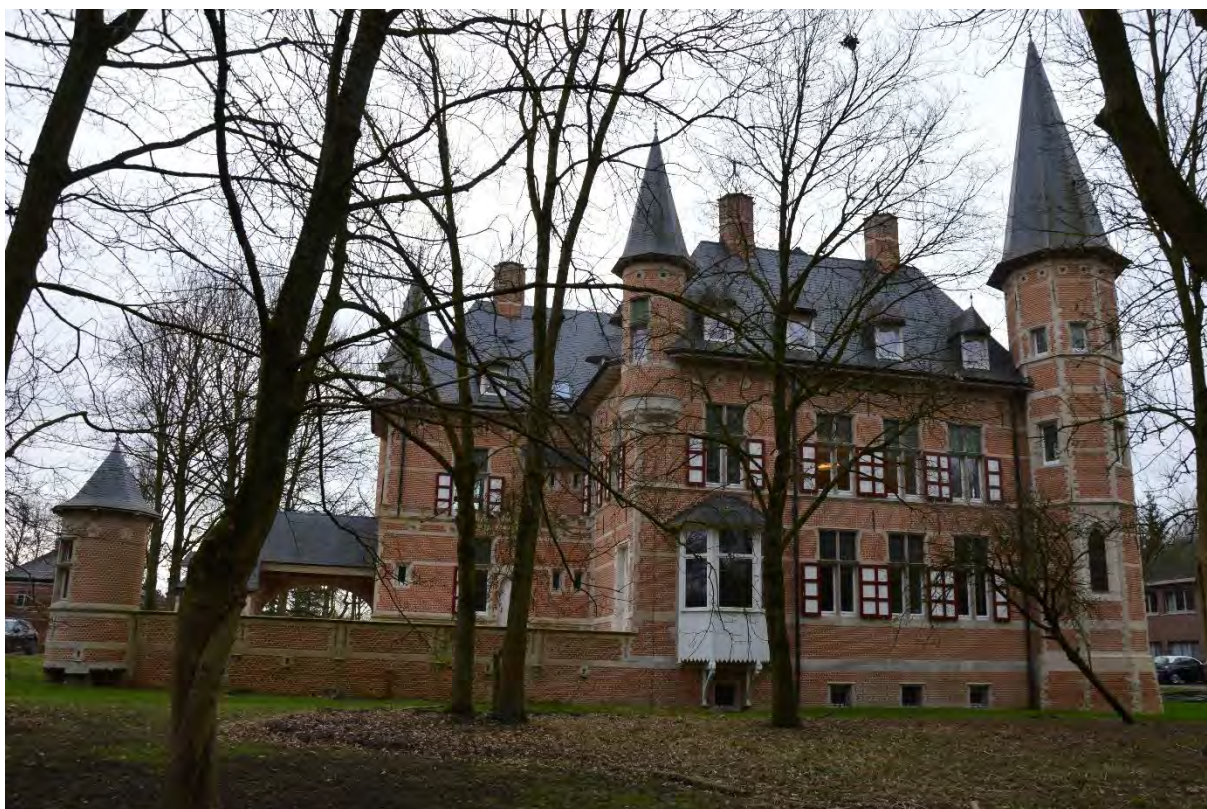
Fig. 49 - De achtergevel van het kasteel.
