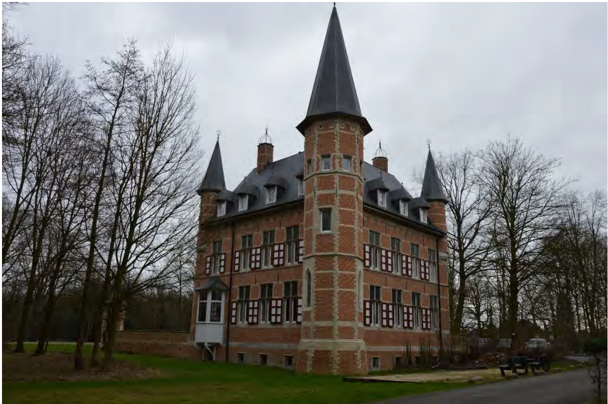
Fig. 50 - De noord- en westgevels van het kasteel en de noordwestelijke hoektoren.
