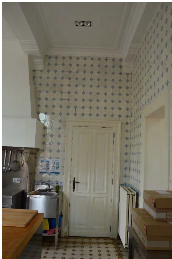
Fig. 101 - Interieur van de keuken, deur naar de gang (lokaal 007)
