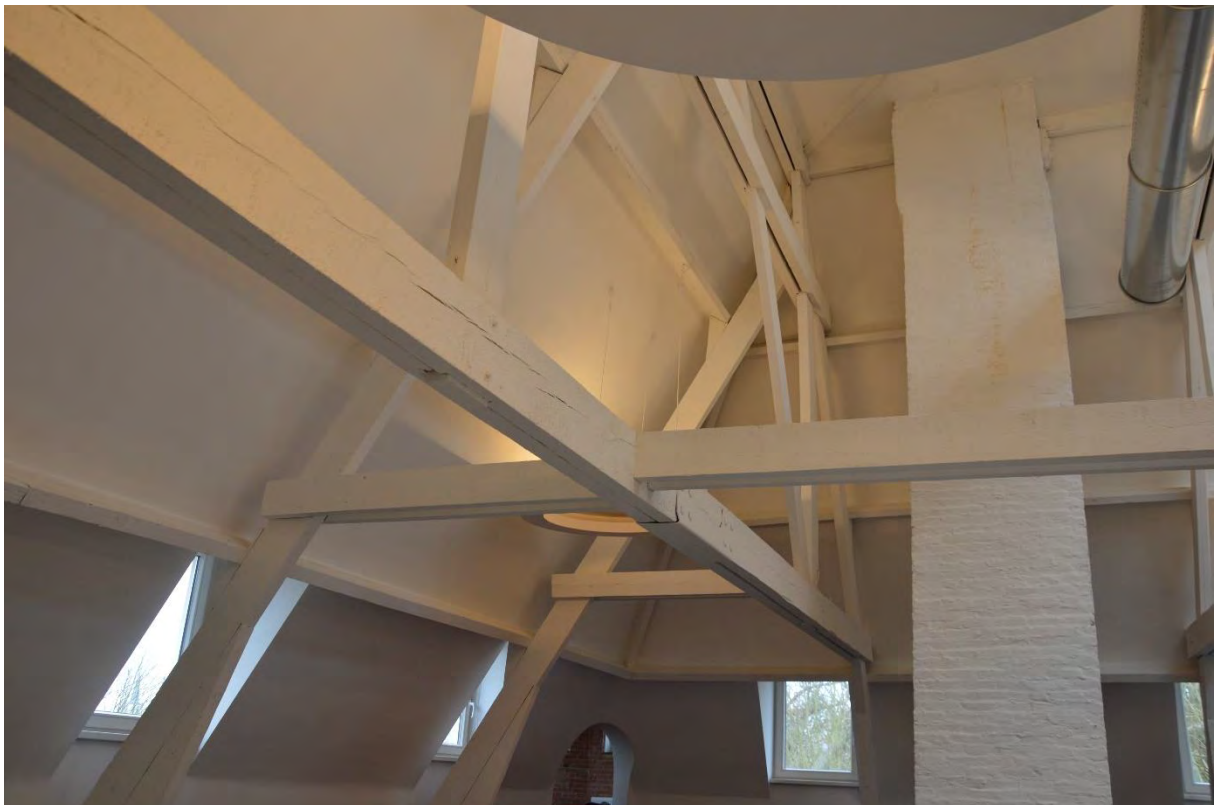
Fig. 227 - Zicht op de historische dakconstructie en een bakstenen schoorsteenvolume.
