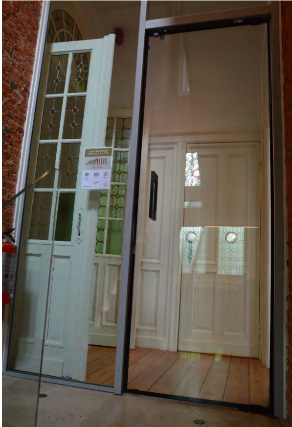
Fig. 161 - De overloop op de eerste verdieping.
