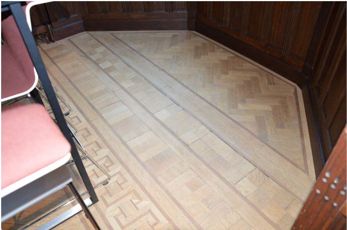
Fig. 156 - De parketvloer van de erker.
