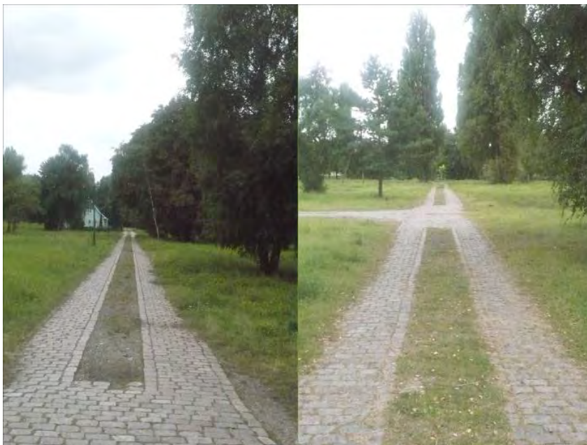
Voorbeeld van weg met twee verharde kasseistroken
