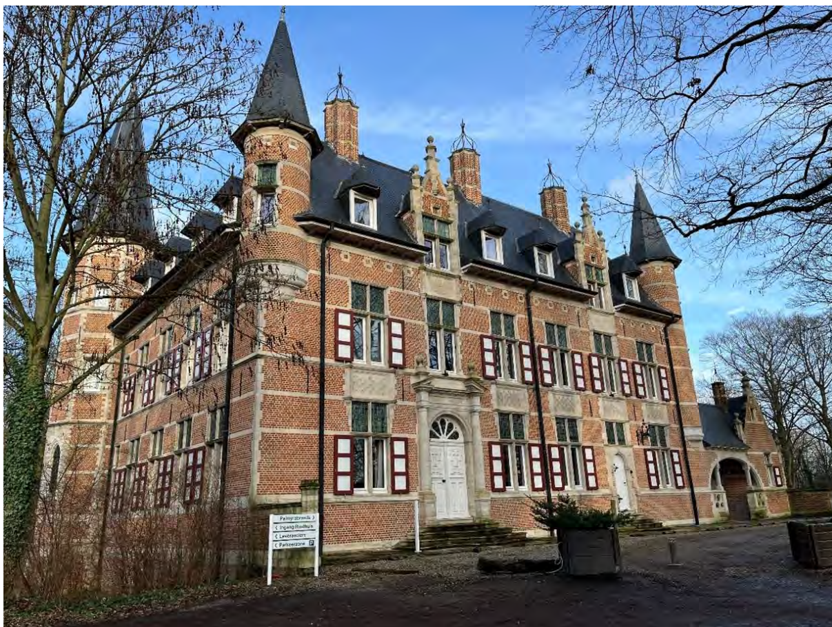
Fig. 48 - Zicht op de west- en zuidgevels van het kasteel.
