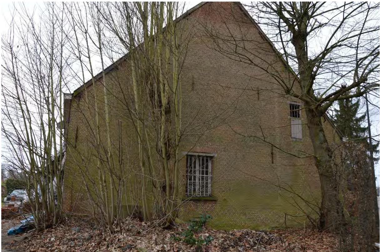
Fig. 240 - De noordelijke zijgevel van de boerenwoning.
