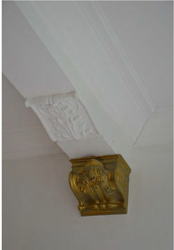
Fig. 190 - Console en balksleutel van één van de moerbalken van het plafond.
