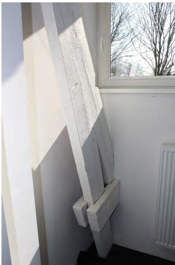
Fig. 223 - Een spantbeen van de historische dakconstructie.
