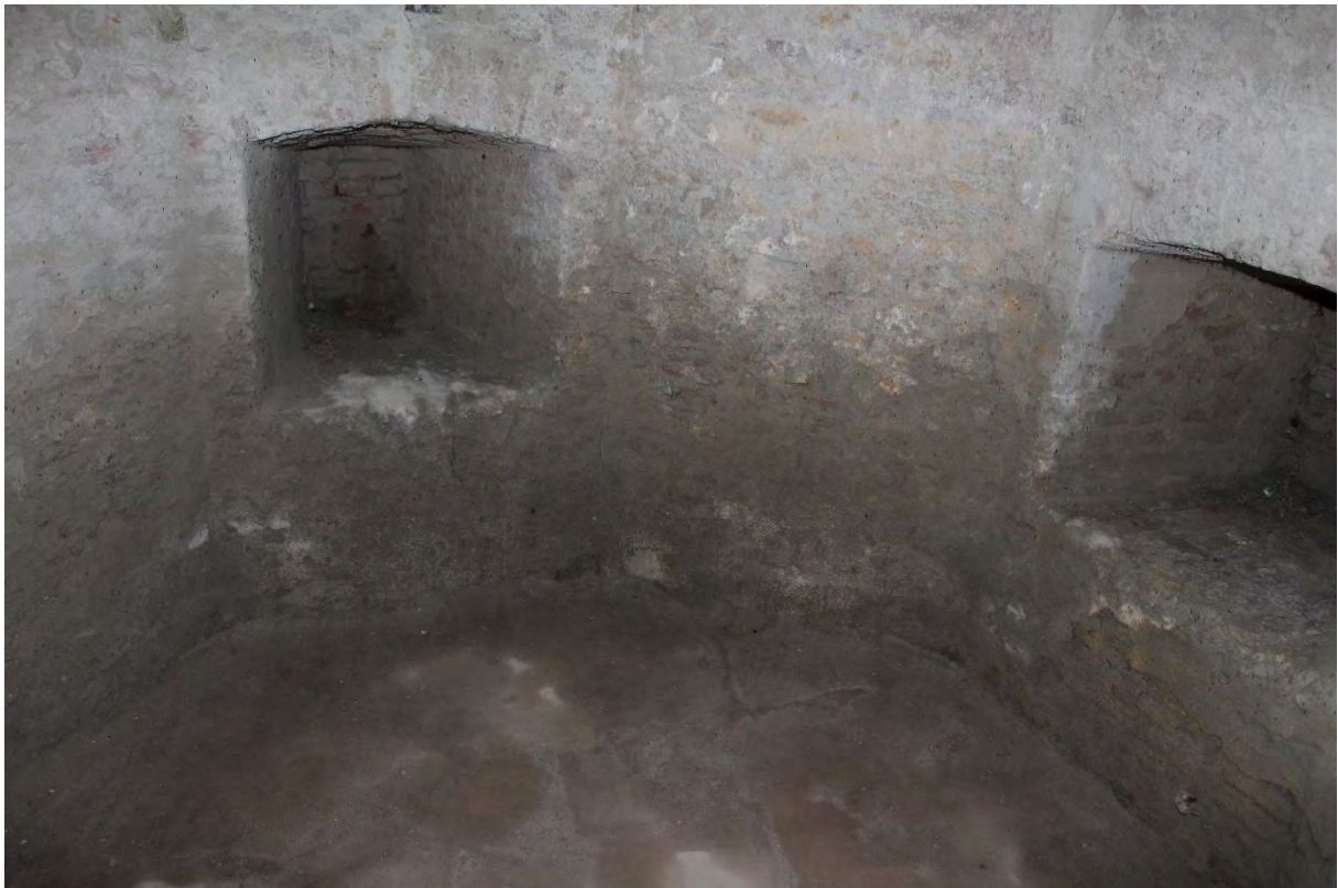
Fig. 90 - Interieur van de kelder van de noordwestelijke hoektoren.
