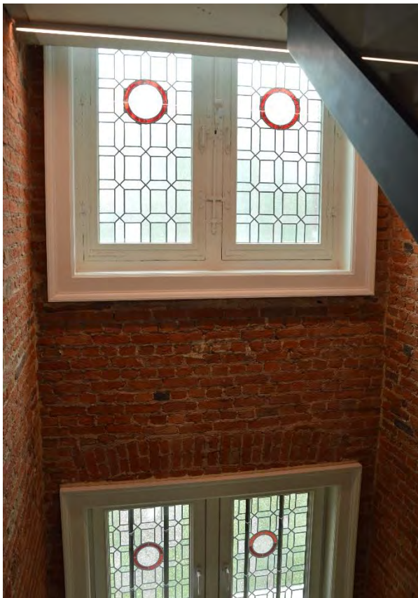
Fig. 163 - Het bolkozijn (onder) en kruiskozijn (boven).
