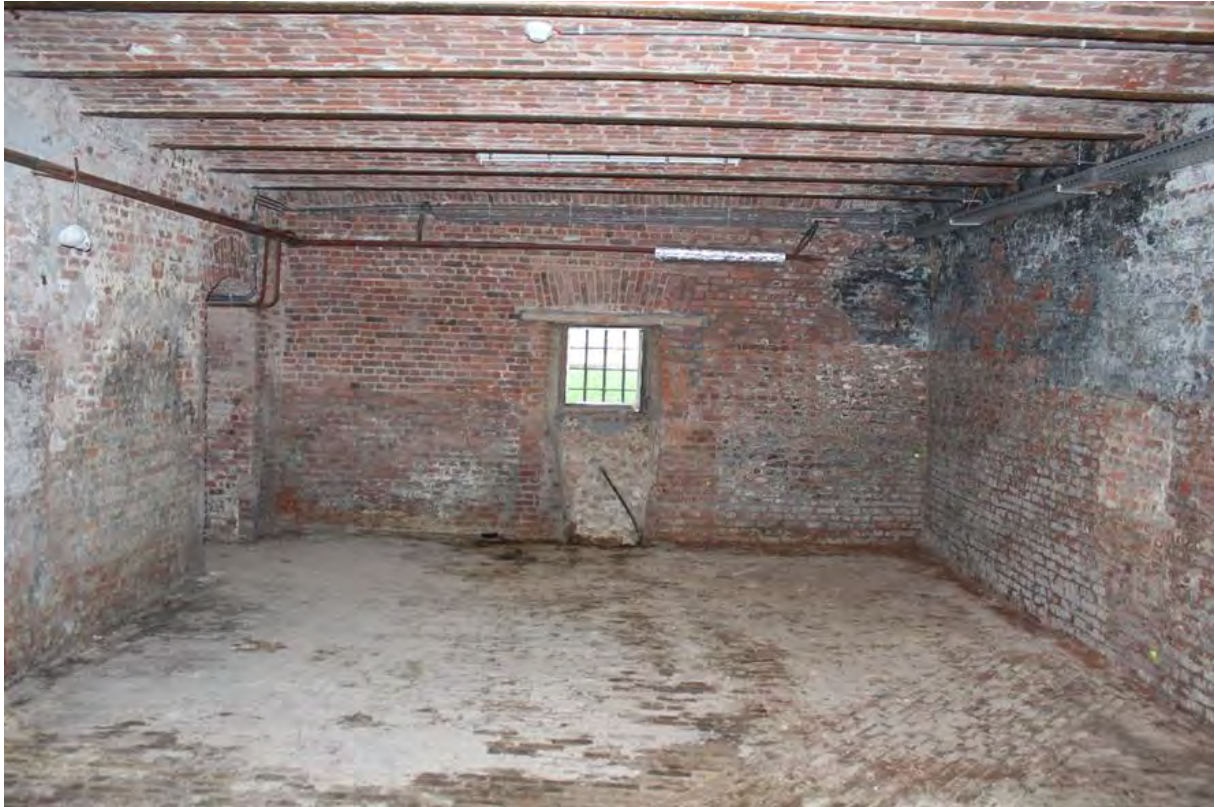
Fig. 83 - Kelderruimte -1.07, zicht naar het noorden.
