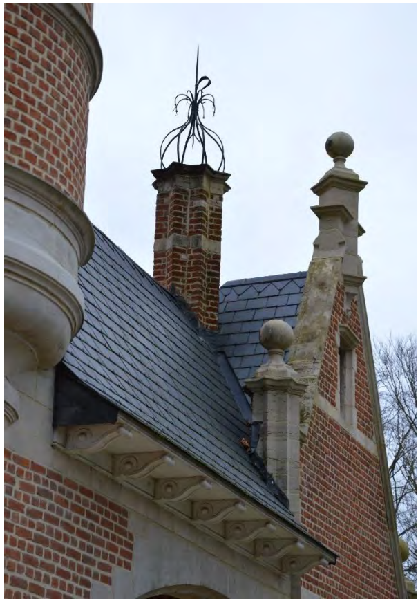
Fig. 66 - Poortgebouw, detail klossen en dakafwerking.
