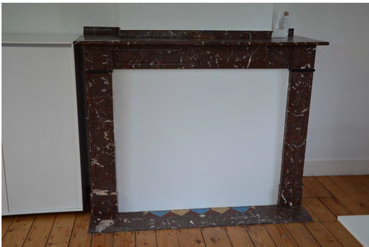
Fig. 173 – Zicht op de eenvoudige schoorsteenmantel in 'Rouge Royal' marmer en de grenenhouten plankenvloer.
