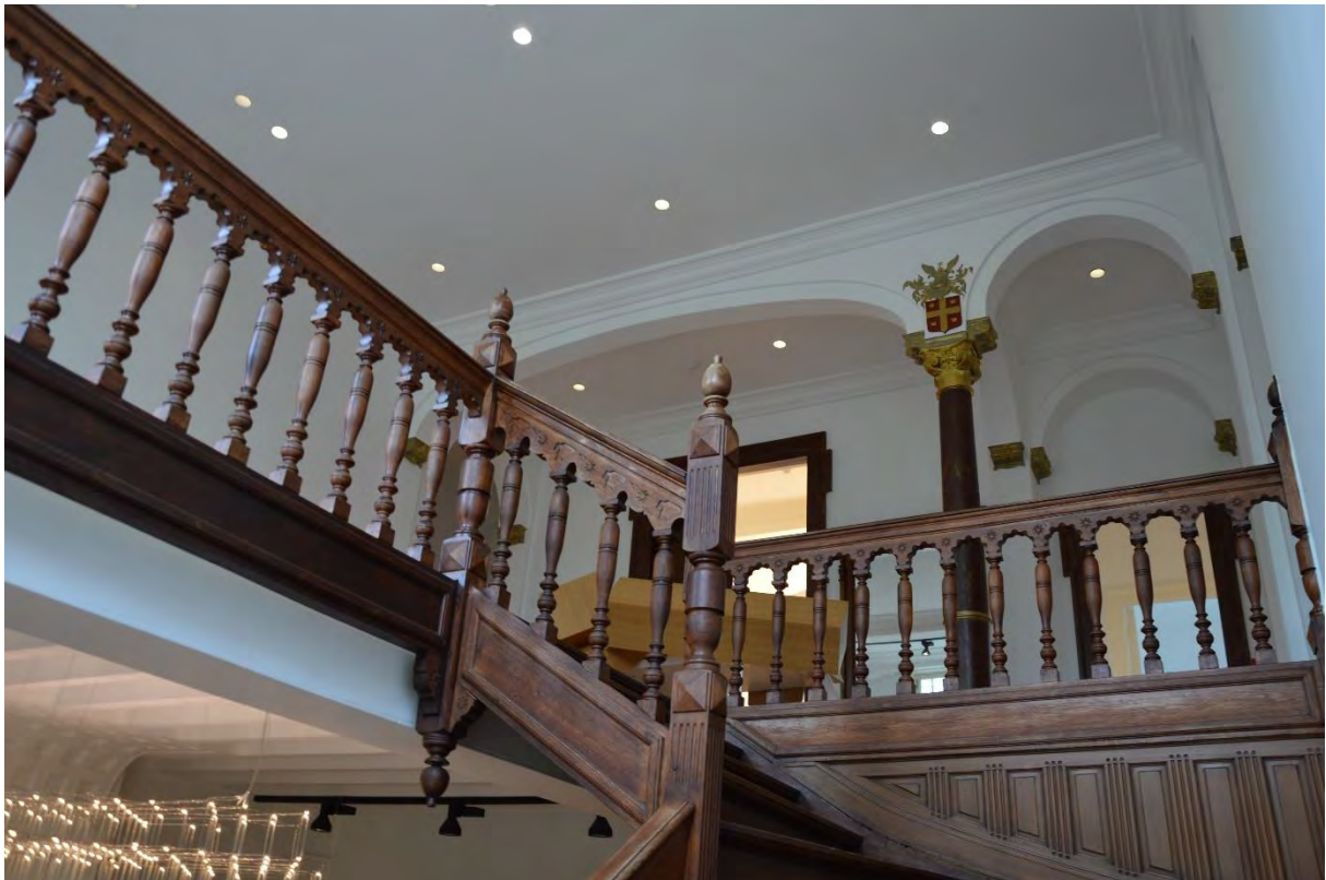
Fig. 112 - Zicht naar de overloop, boven de inkomhal.
