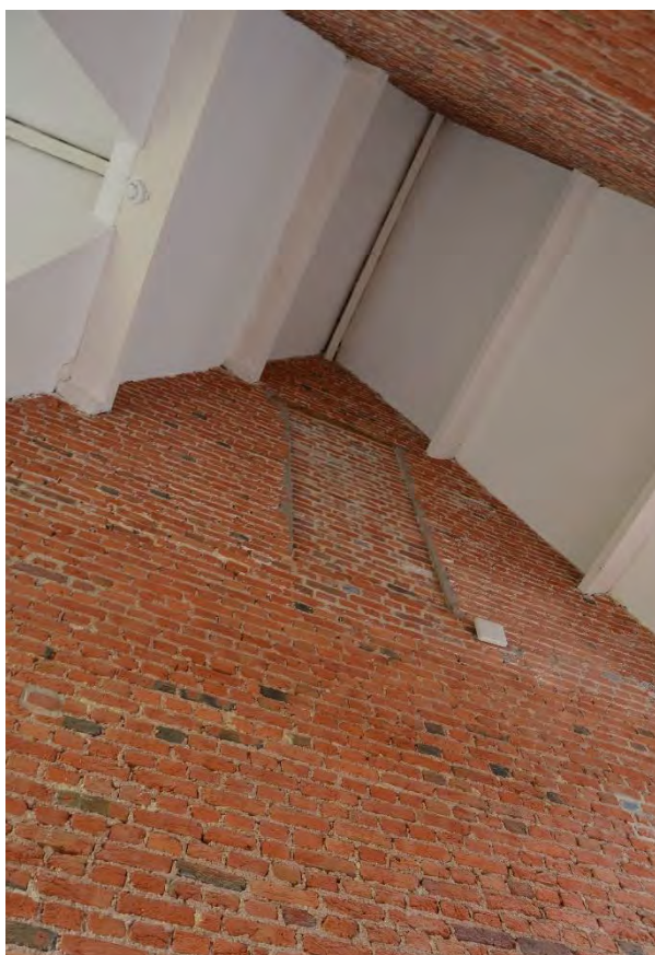
Fig. 218 - Dichtgemaakte opening aan de westzijde.
