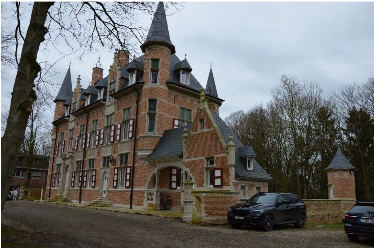
Fig. 4 - Voorgevel van het kasteel, met vooraan rechts de voormalige portierswoning.
