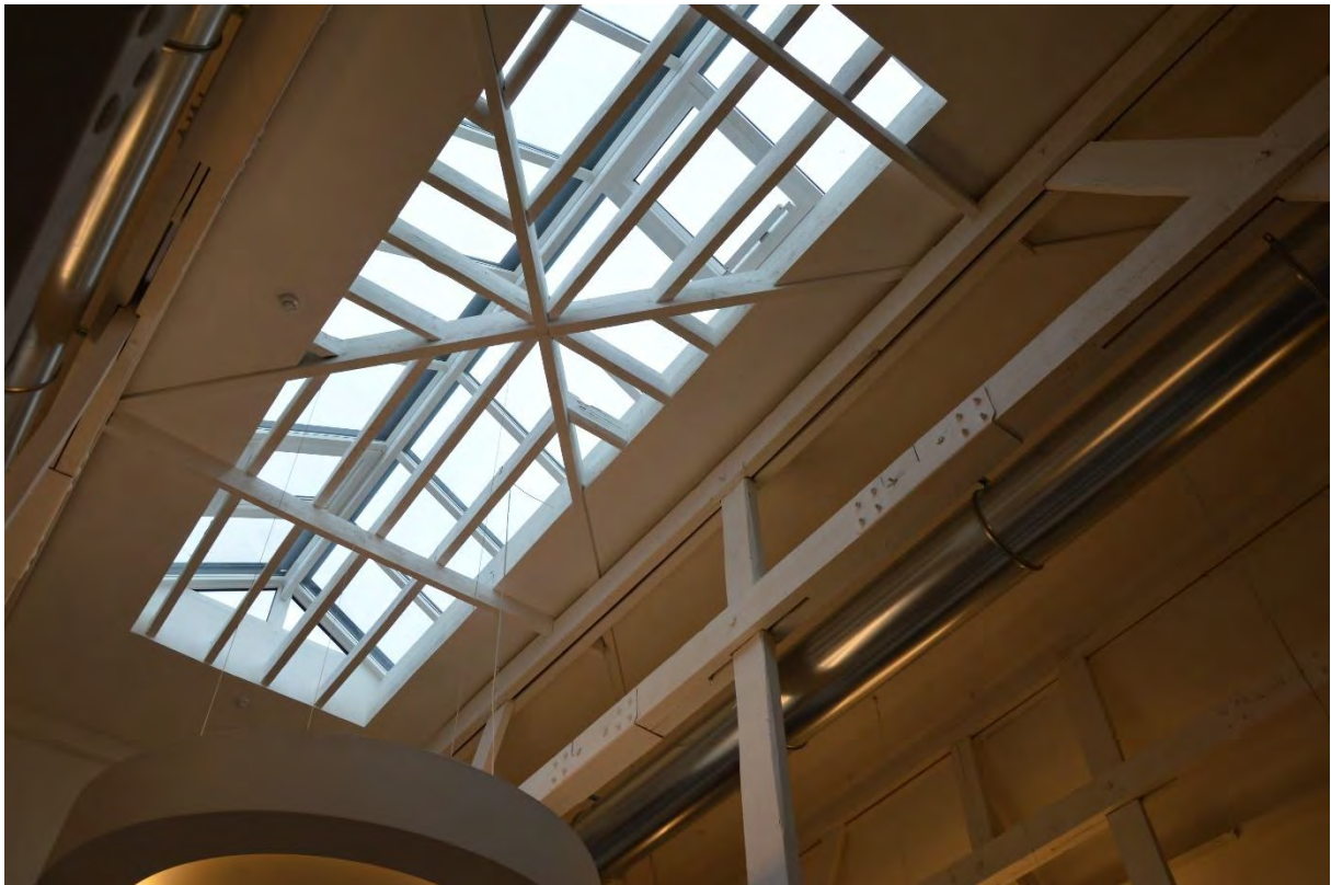
Fig. 228 - Zicht op de kruisvormige dakconstructie van het plat dak, met lichtstraat.
