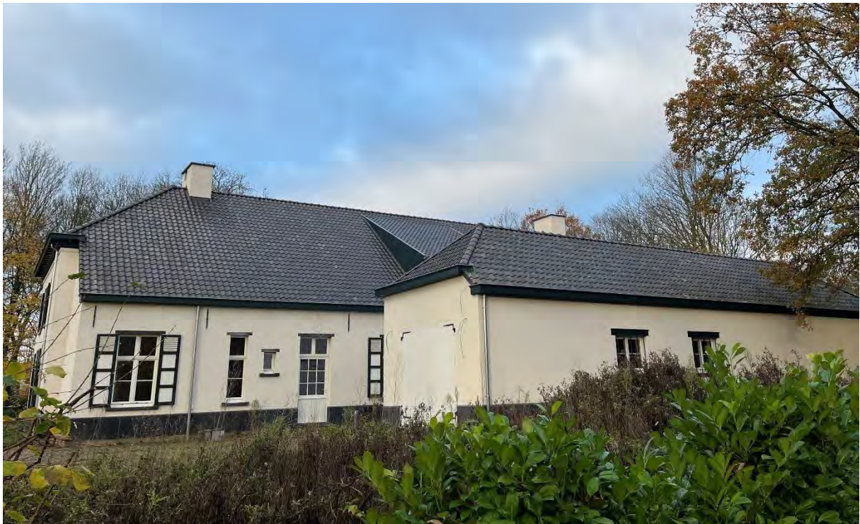
Fig. 235 - Achterzijde (oostzijde) van het dienstgebouw.
