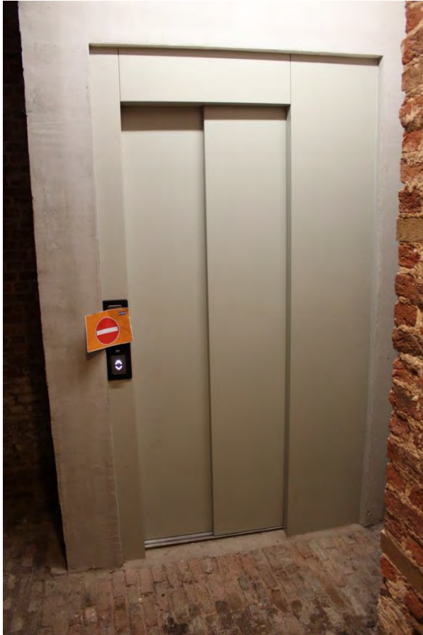
Fig. 78 - Kelder -1.05, een wijnkelder waar bij de recente restauratie een lift werd ingebracht.
