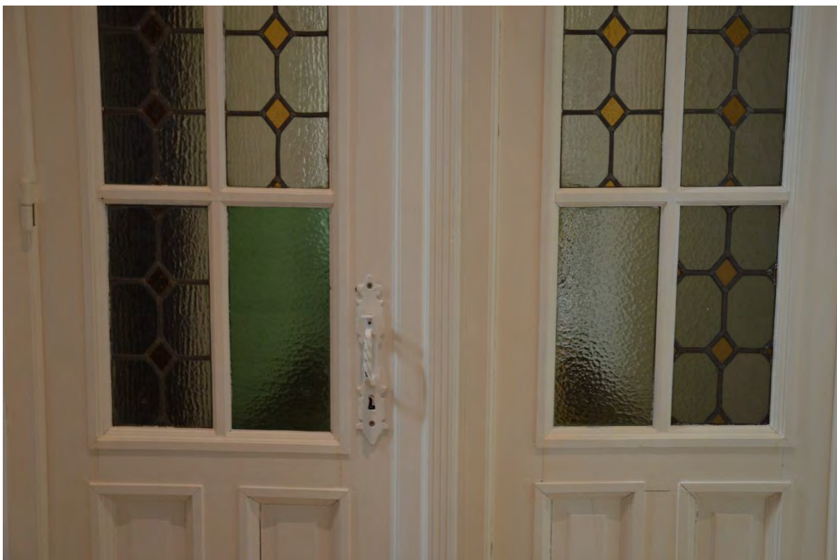
Fig. 167 - Detail van de dubbele deur, met origineel beslag en twee vervangen glaspanelen.
