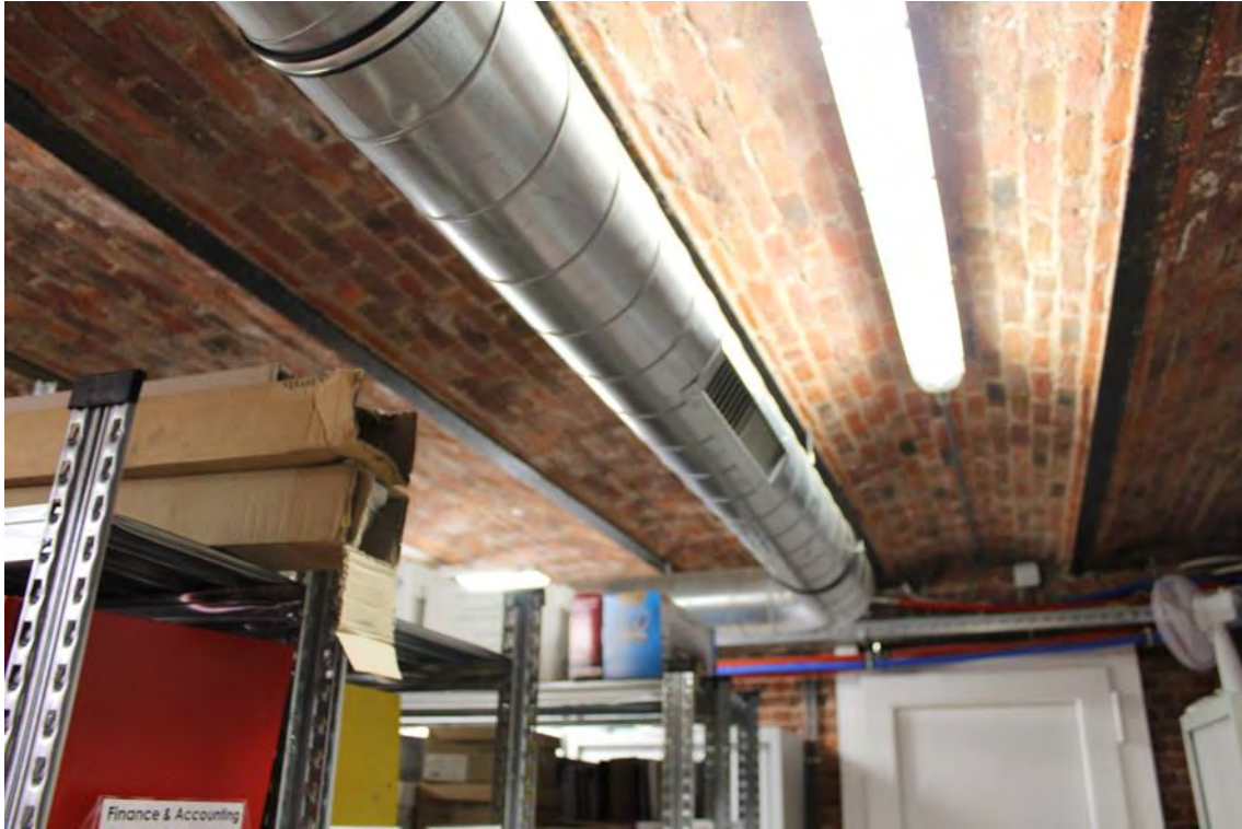
Fig. 71 - Kelder -102: zicht op het plafond met troggewelven.
