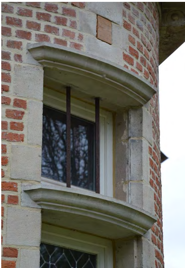
Fig. 56 - Detail van een venster in de NW-hoektoeren.
