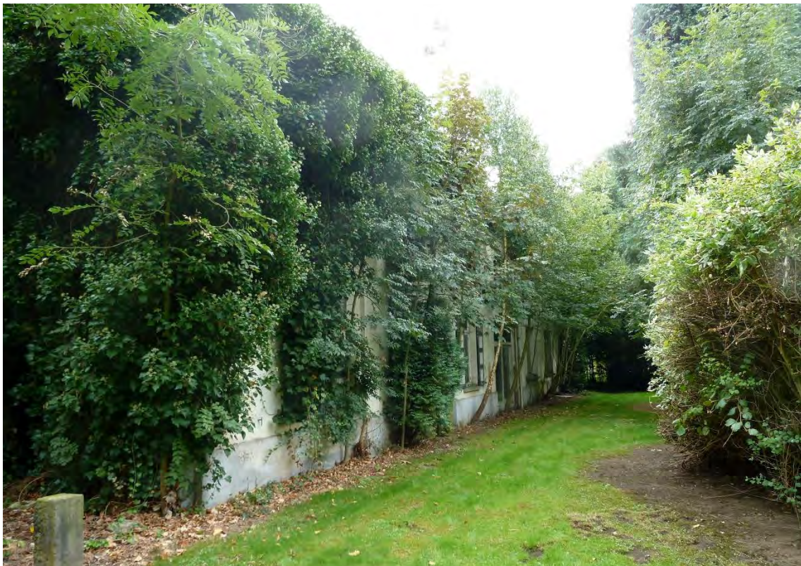
Fig. 41 - De remise was jaren overwoekerd door planten en bomen (Foto 2012, EON architectenbureau).
