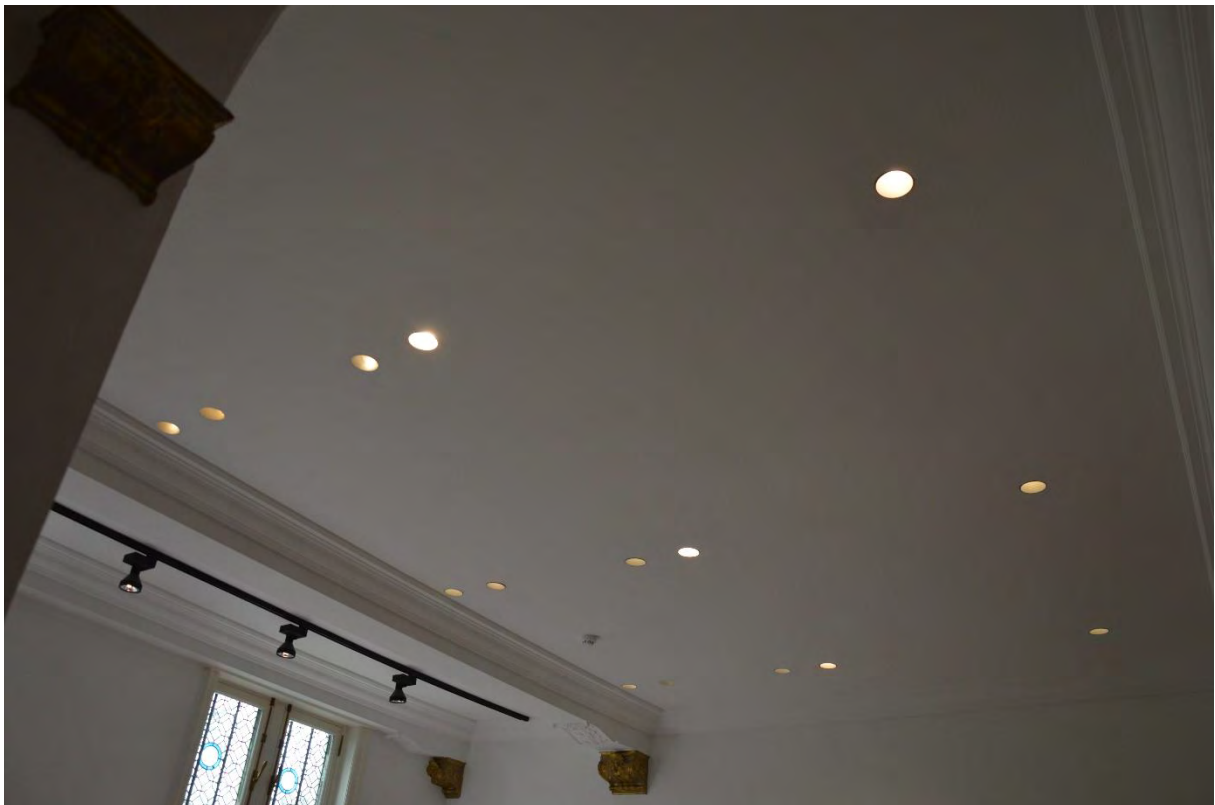
Fig. 188 - Het plafond met moerbalken.
