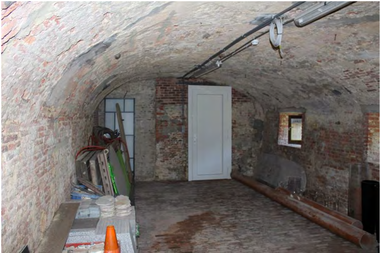
Fig. 87 - Kelder -110 op de noordoostelijke hoek van het kasteel, zicht naar het zuiden. Deze kelder vormt samen met de aanpalende kelder (-109) een restant van het oude kasteel.
