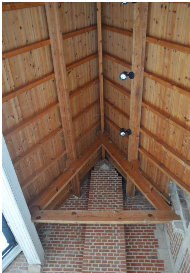
Fig. 68 - De dakconstructie van het poortgebouw.
