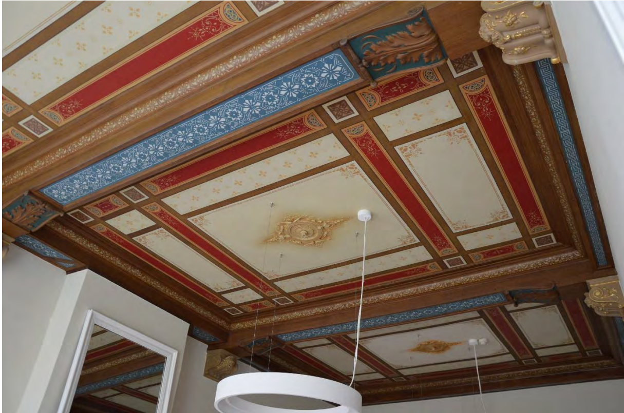
Fig. 148 - Het gepolychromeerd stucwerkplafond.
