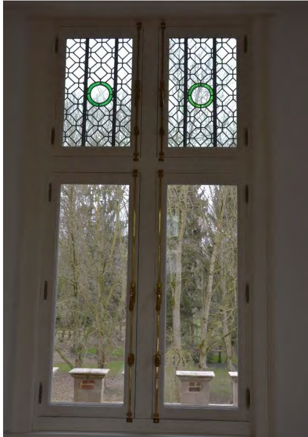
Fig. 175 - Vernieuwd kruiskozijn en spanjoletten.
