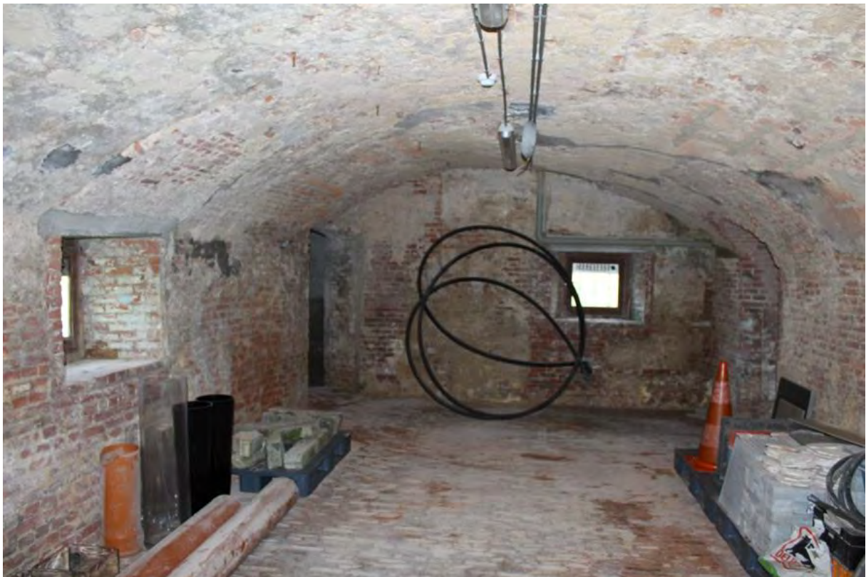
Fig. 88 - Dezelfde kelder -110, zicht naar het noorden. Links achteraan in beeld is de toegang tot de kelder van de NW-hoektoren.
