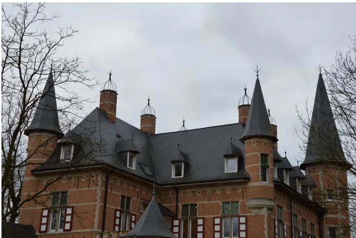
Fig. 59 - Overzicht van de speelse dakvormen van het kasteel, gezien vanaf het noordoosten.
