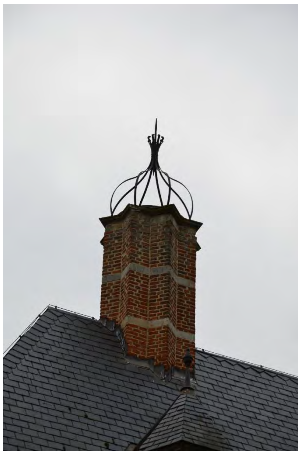
Fig. 64 – Eén van de schoorstenen.
