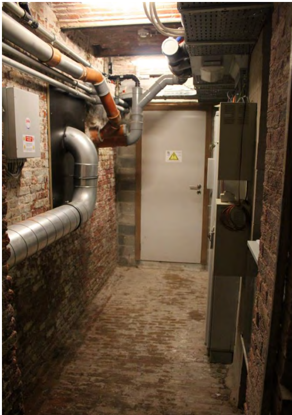
Fig. 73 - Kelder - 103 (technisch lokaal), zicht naar het oosten.
