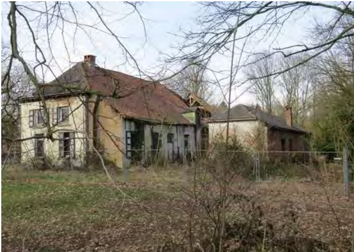
Fig. 40 - Het woonhuis met stalling in 2018 (bron: Agentschap Onroerend Erfgoed).
