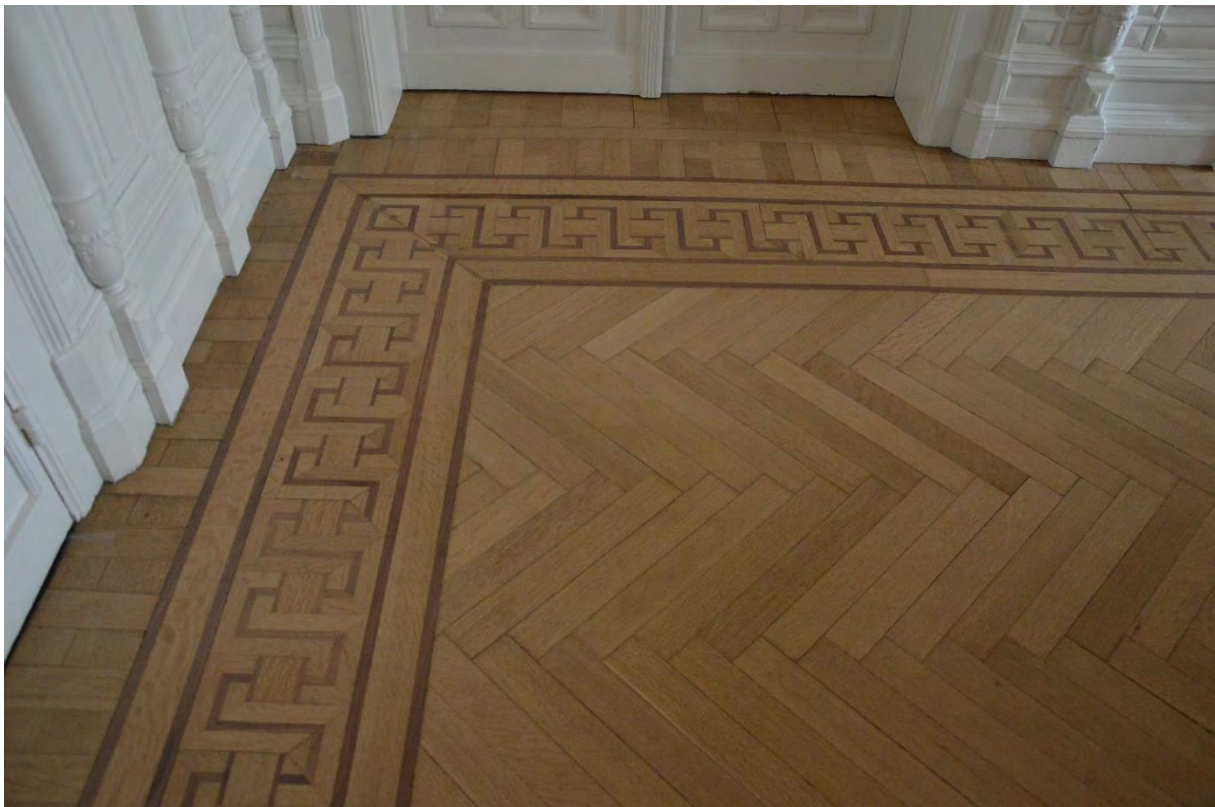
Fig. 149 - De parketvloer, met visgraatmotief en decoratieve boord met meandermotief.
