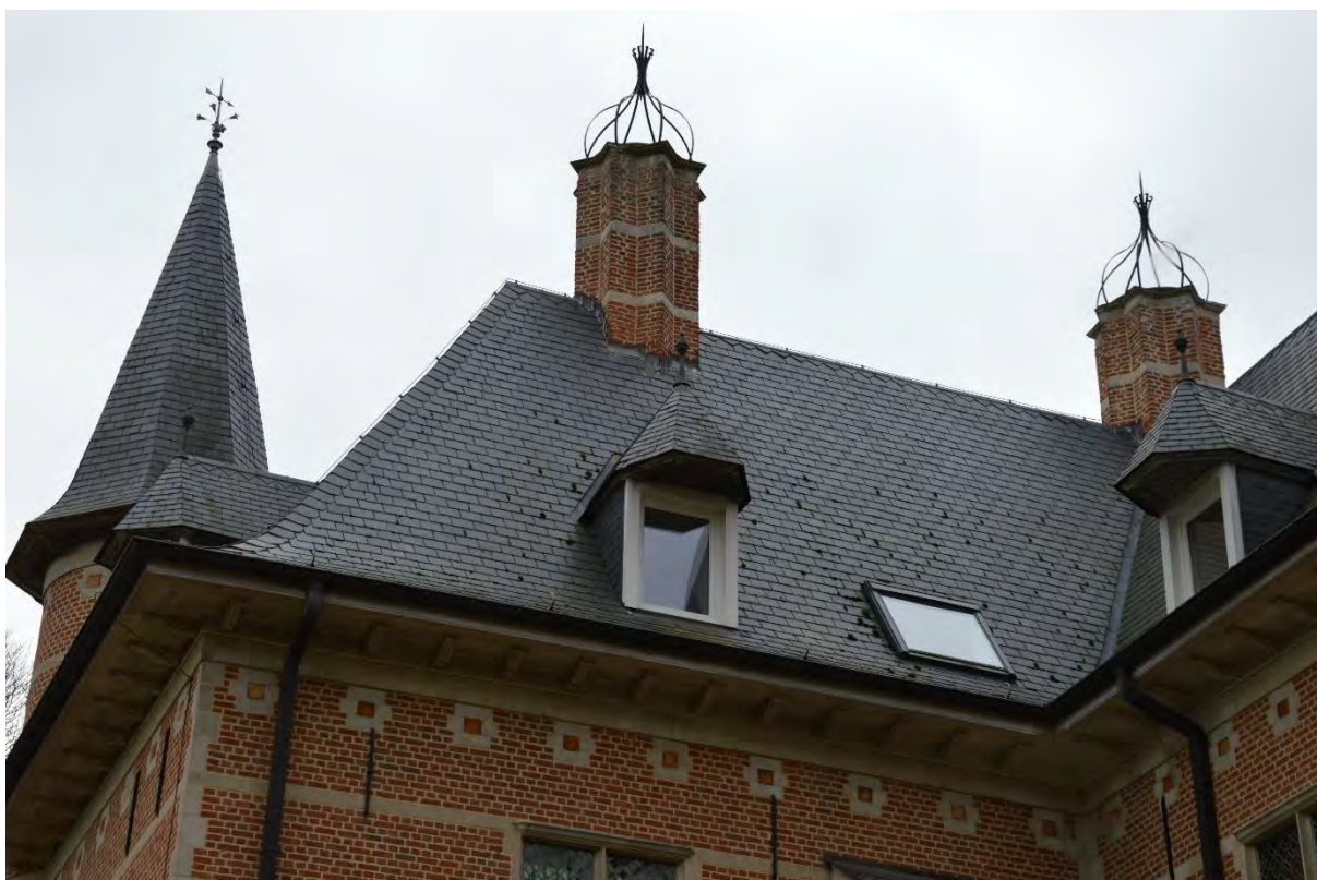
Fig. 60 - Detail van de bedaking. Het hedendaags dakvlakraam is te situeren boven de traphal van de voormalige diensttrap.
