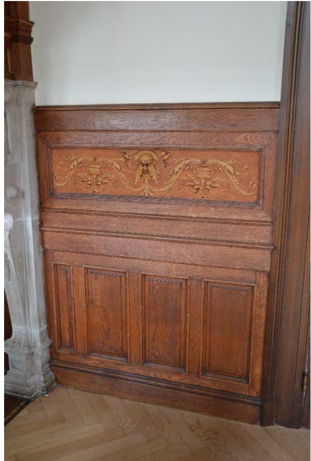
Fig. 133 – De lambrisering in lokaal 010.
