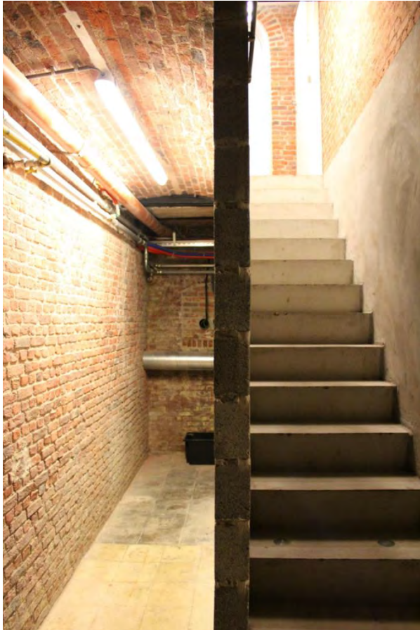
Fig. 70 - Kelder, lokaal -101. Zicht naar het zuiden.
