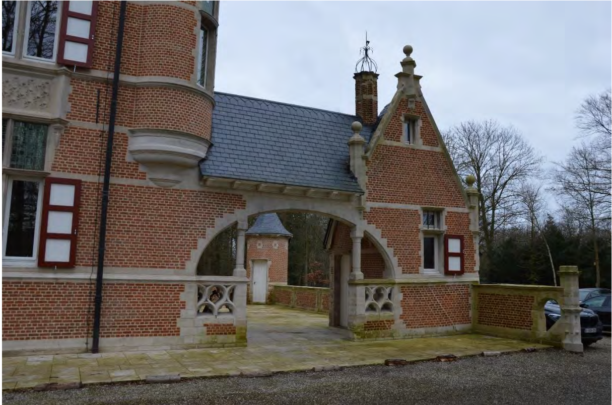
Fig. 52 - Het poortgebouw naar de binnenkoer.
