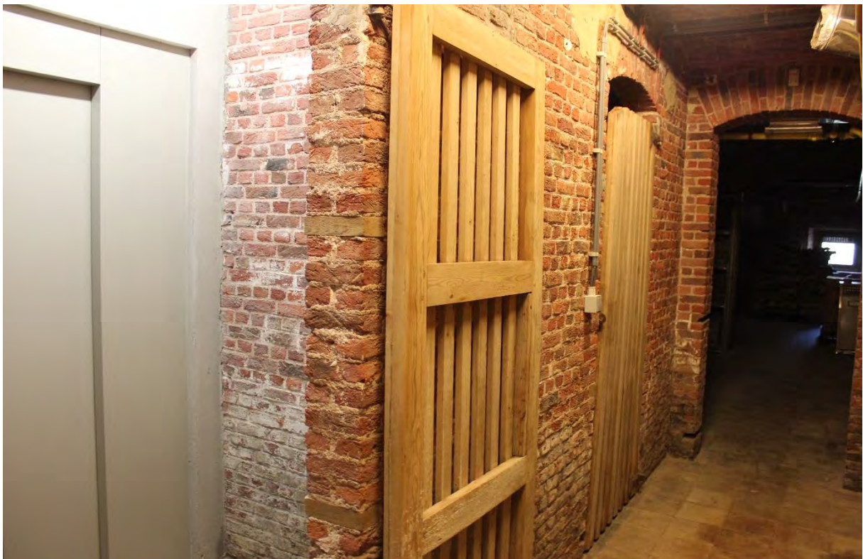
Fig. 82 - Dezelfde gang. Zicht op verbinding met de kelder -105 met de personenlift.
