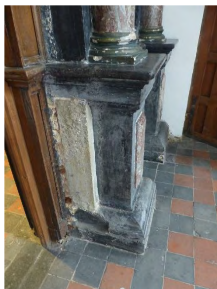
Figuur 145 (rechts) kapel, oksaal: Onafgewerkte zijkant van de nissen naast de toegangsdeur (AS, 17.10.2023)
