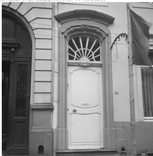
Figuur 537 (links) eerste ziekenzaal, W: Schouderboogvormige deur met waaier, gerecupereerd uit Nieuwstraat 10 (AS, 17.10.2023)
