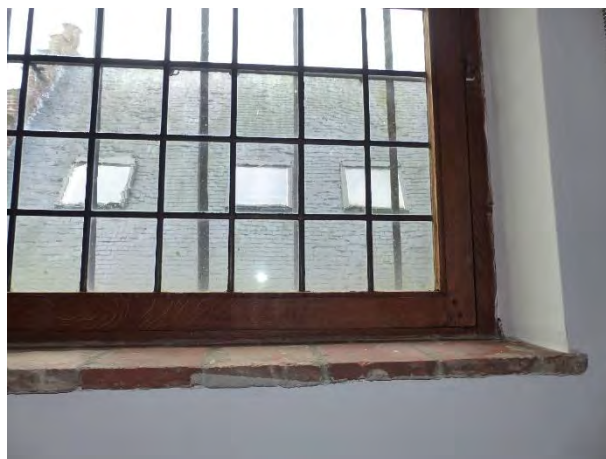
Figuur 468 (links) klooster, 1.04: In de kamers op de eerste verdieping zijn verschillende venstertabletten uitgevoerd met aardewerktegels (AS, 17.10.2023)
