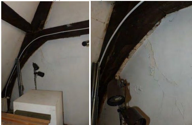
Figuur 287 (links), Figuur 288 (midden) en Figuur 289 (rechts) klooster, 2.01: Diverse barsten in de oostgevel (AS, 17.10.2023)
