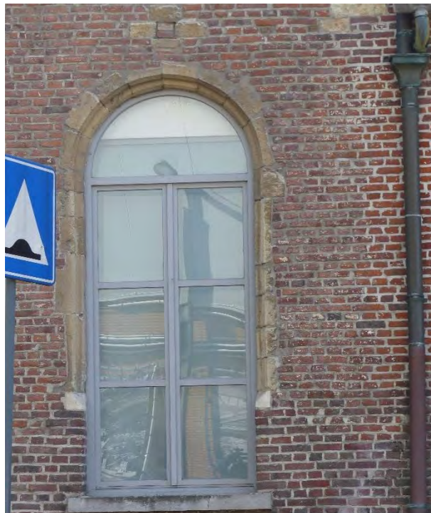
Figuur 611 (links) derde ziekenzaal, Z: Doorlopende natuurstenen dorpel op de verdieping is vernieuwd tot de achtste travee (AS, 17.10.2023)
