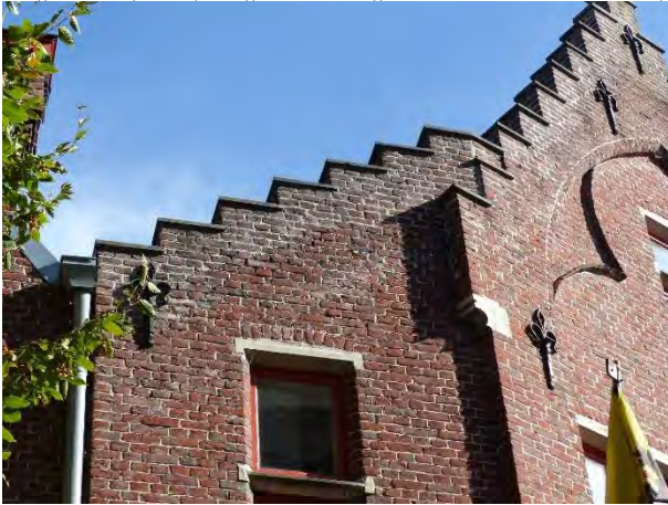
Figuur 640 (links) en Figuur 641 (rechts) neogotische vleugel noord, W: Vochtschade trapgevels (AS, 17.10.2023)
