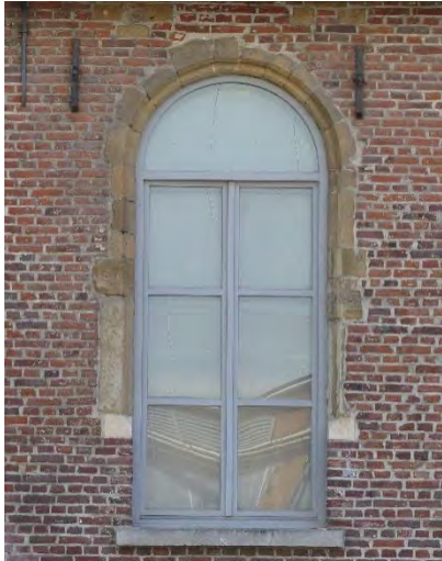
Figuur 571 (links) en Figuur 572 (midden) tweede ziekenzaal, O: Kalkzandstenen raamomlijsting en kalkzandstenen elementen boven de ramen (AS, 17.10.2023)
