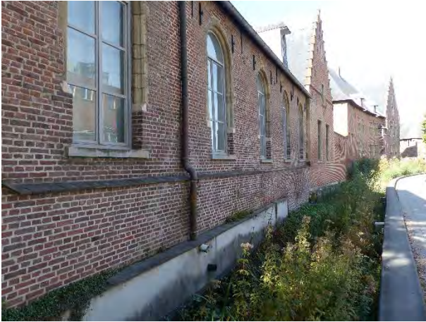
Figuur 567 (links) tweede ziekenzaal, O: Verjongend metselwerk (AS, 17.10.2023)
