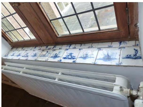
Figuur 472 (links) en Figuur 473 (rechts) klooster, 1.01: Venstertablet in Delftse tegels (AS, 17.10.2023)
