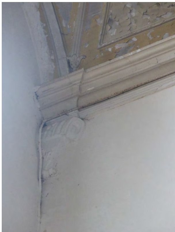
Figuur 135 (links) en Figuur 136 (rechts) kapel, schip: Detail barsten in stucwerk en afbladderen verf (AS, 17.10.2023)
