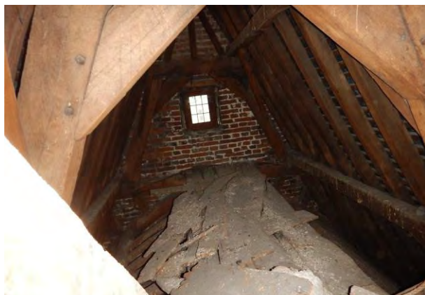
Figuur 106 (links) kapel, dakstructuur: Loopplanken vol houtafval (Monumentenwacht, 2021)
