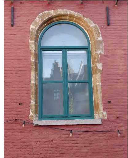
Figuur 571 (links) en Figuur 572 (midden) tweede ziekenzaal, O: Kalkzandstenen raamomlijsting en kalkzandstenen elementen boven de ramen (AS, 17.10.2023)
