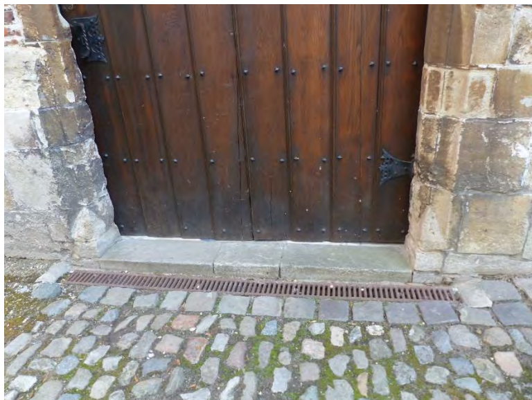
Figuur 252 (links) en Figuur 253 (rechts) Klooster, pandgang, W: Beplanking gespleten. Aan de binnenzijde is buitenlicht zichtbaar onder de deur en tussen de twee deurvleugels (AS, 17.10.2023)
