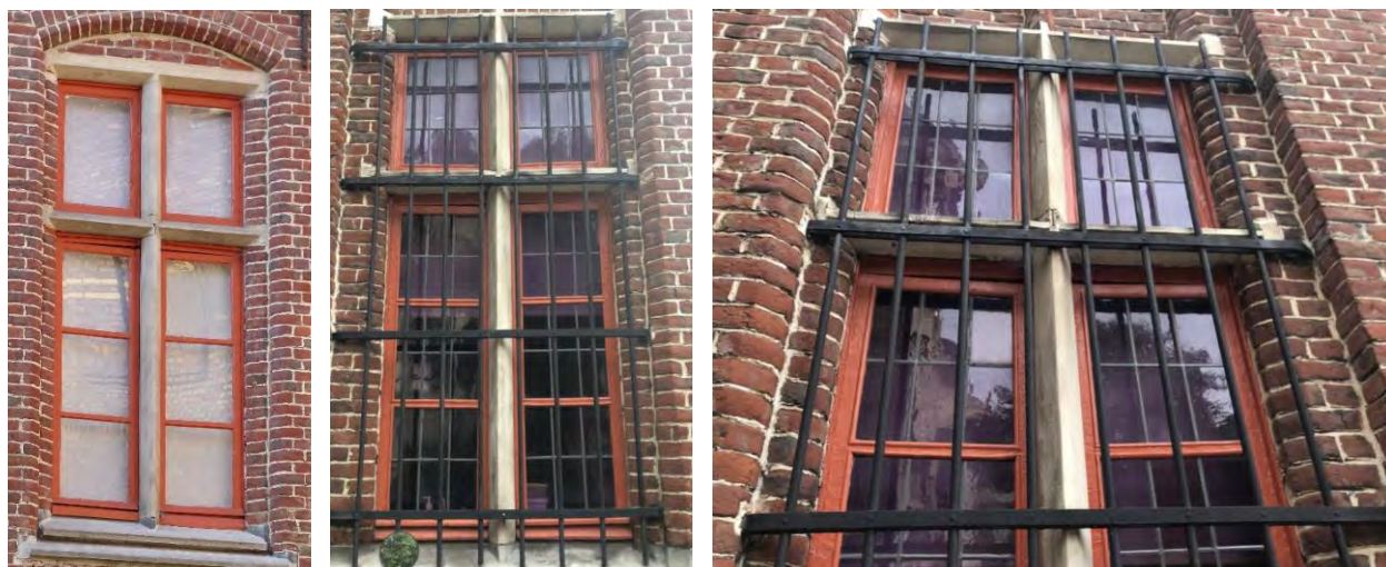
Figuur 691 (links) neogotische vleugel noord, O: Verzakte raamvleugels (AS, 17.10.2023)
