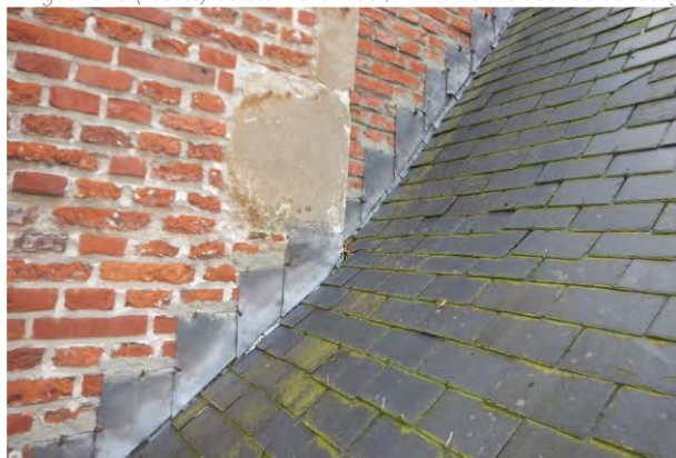
Figuur 517 (links) eerste ziekenzaal, N(W): Aansluiting van het dak met de westgevel van de kapel (Monumentenwacht, 2021)
