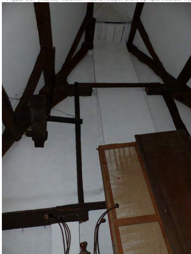
Figuur 238 (links) en Figuur 239 (rechts) Klooster, noordvleugel: Dakstructuur met ingeklemde takel in westgevel (AS, 17.10.2023)
