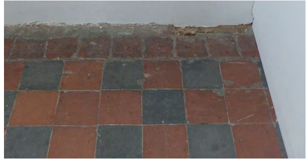
Figuur 138 (rechts) kapel, schip: Randafwerking met handgevormde kleinere rode Boomse tegel, wellicht ouder dan de rest van de vloer (AS, 17.10.2023)
