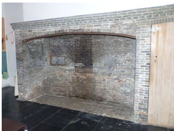
Figuur 391 (links) en Figuur 392 (rechts) klooster, 0.04: Schouwmantel in voormalige keuken (AS, 17.10.2023)
