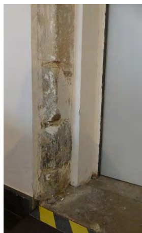
Figuur 549 (links), Figuur 550 (midden) en Figuur 551 (rechts) eerste ziekenzaal, 0.31: Kalkzandstenen deuromlijsting tussen ziekenzaal en kapel (AS, 17.10.2023)
