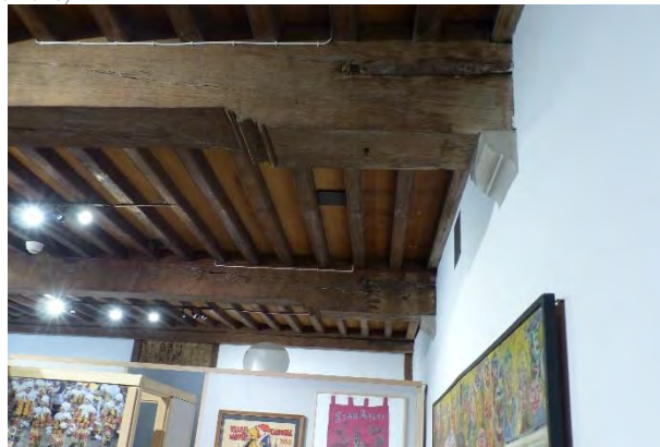
Figuur 318 (links) en Figuur 319 (rechts) klooster, 1.01: Oude (?) vochtschade aan de balkkoppen (AS, 17.10.2023)
