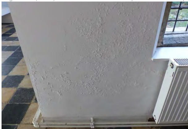
Figuur 292 (links) en Figuur 293 (rechts) klooster, 0.09 (Z): In elke hoek van de pandgang is er schade aan het pleisterwerk door vochtdoorslag ter hoogte van de regenpijpen (AS, 17.10.2023)
