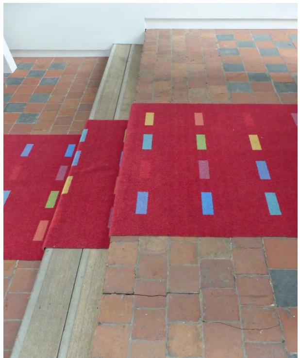
Figuur 138 (rechts) kapel, schip: Randafwerking met handgevormde kleinere rode Boomse tegel, wellicht ouder dan de rest van de vloer (AS, 17.10.2023)
