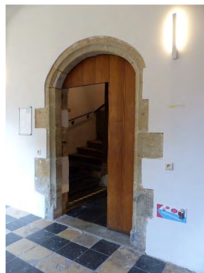
Figuur 429 (midden) en Figuur 430 (rechts) klooster, 0.03: Nieuwe opgeklampte deur met apart paneel (AS, 17.10.2023)
