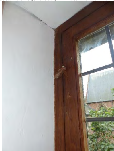
Figuur 267 (links), Figuur 268 (midden) en Figuur 269 (rechts) Klooster, pandgang noord, Z: Binnenzijde raam met detail hang- en sluitwerk (AS, 17.10.2023)
