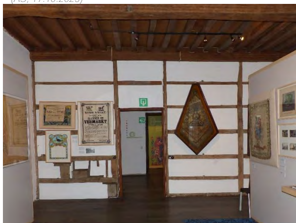
Figuur 344 (links) en Figuur 345 (rechts) klooster, 1.04: Vakwerkwand tussen vertrek en traphal (AS, 17.10.2023)
