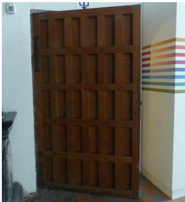
Figuur 141 (links) en Figuur 142 (rechts) kapel: Opgeklampte eikenhouten deur (AS, 17.10.2023)
