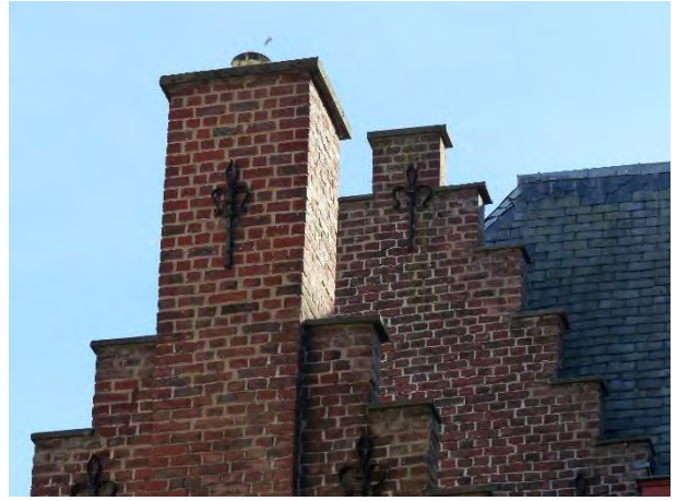
Figuur 639 (rechts) neogotische vleugel noord, N: Vochtschade trapgevels (AS, 17.10.2023)
