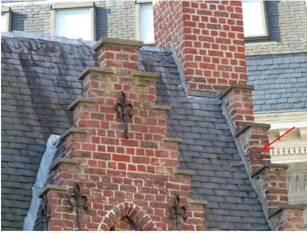
Figuur 638 (links) neogotische vleugel noord, O: Vochtschade trapgevels (AS, 17.10.2023)
