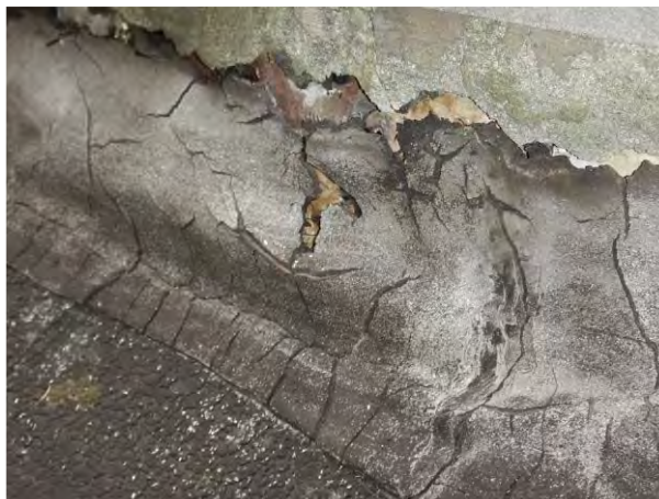
Figuur 219 (links) Klooster, pandgang zuid: Roofing op plat dak (Monumentenwacht, 2021)
