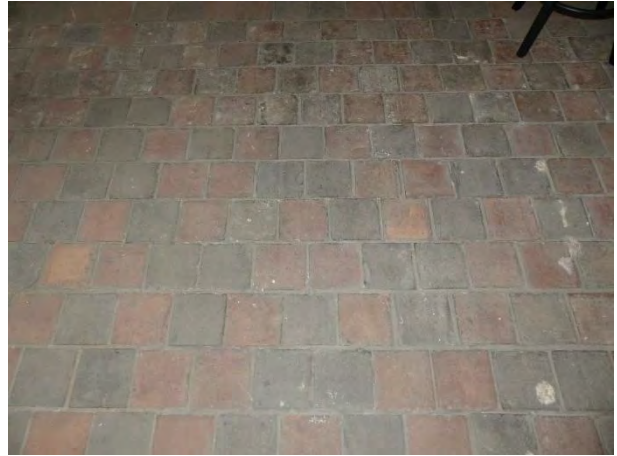
Figuur 375 (links) en Figuur 376 (rechts) klooster, 2.02: Ongeglazuurde rode en grijsblauwe aardewerktegels in ruitpatroon, vermoedelijk origineel. Sterk vervuild. Er komen afgebrokkelde en afgesleten tegels voor (AS, 17.10.2023)
