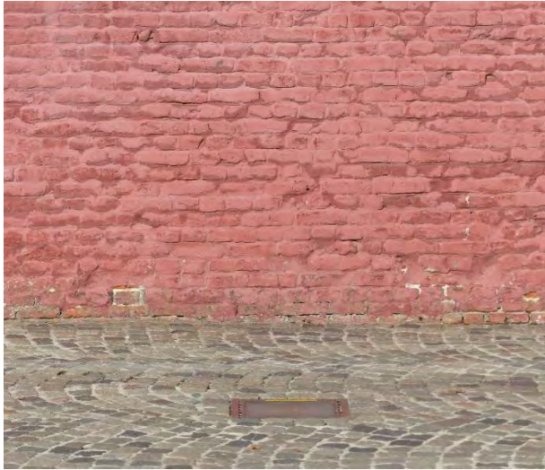
Figuur 601 (links) derde ziekenzaal Z: Vochtschade door opspattend en/of opstijgend vocht (AS, 17.10.2023)
