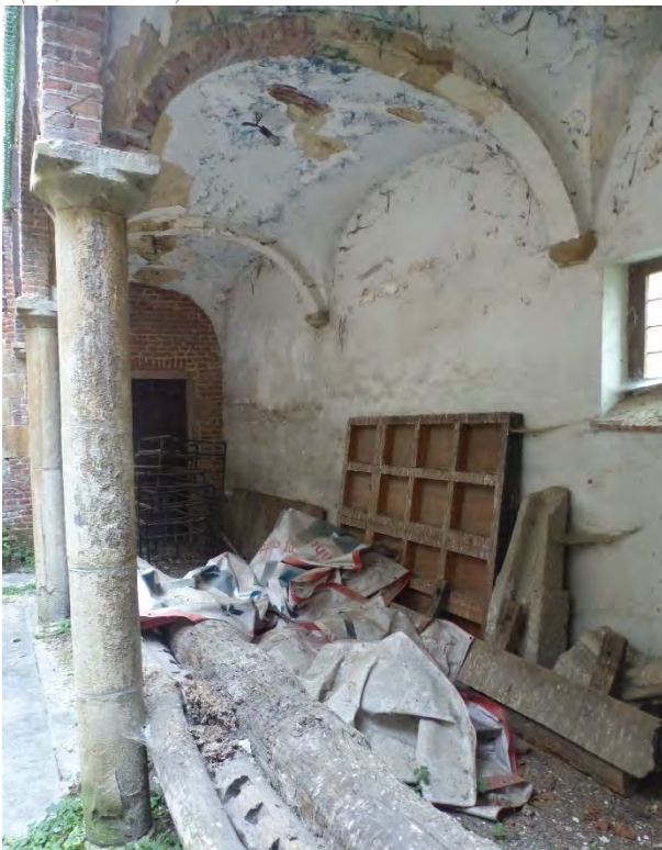
Figuur 203 (links) en Figuur 204 (rechts) Galerij, galerij: Detail verwerking kalkzandstenen kolommen en pleisterwerk gewelven en westgevel (AS, 17.10.2023)
