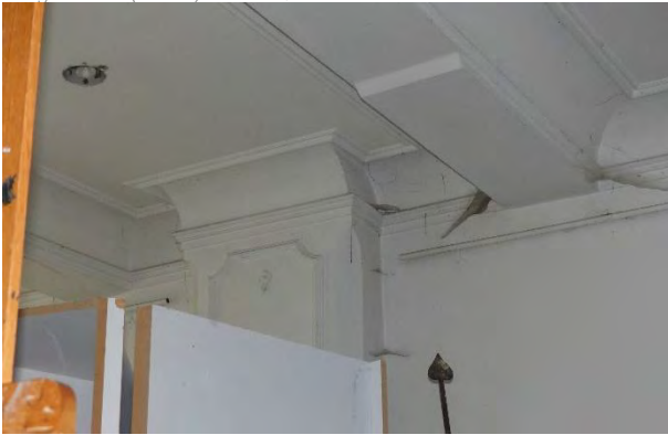
Figuur 326 (links) klooster, 0.06: Gepleisterd plafond met stuclijsten op het gelijkvloers in de oostvleugel (AS, 17.10.2023)
