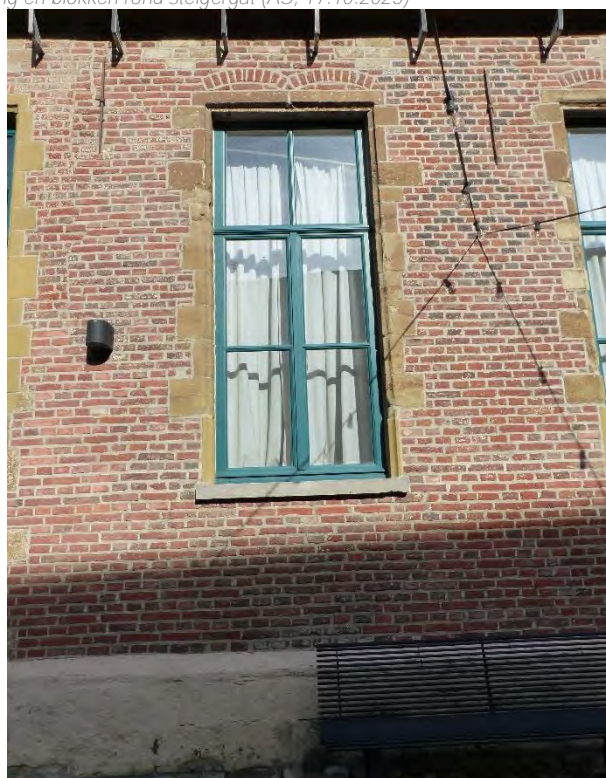
Figuur 506 (links) en Figuur 507 (rechts) eerste ziekenzaal, Z: Kalkzandstenen raamomlijstingen en plint (AS, 17.10.2023)
