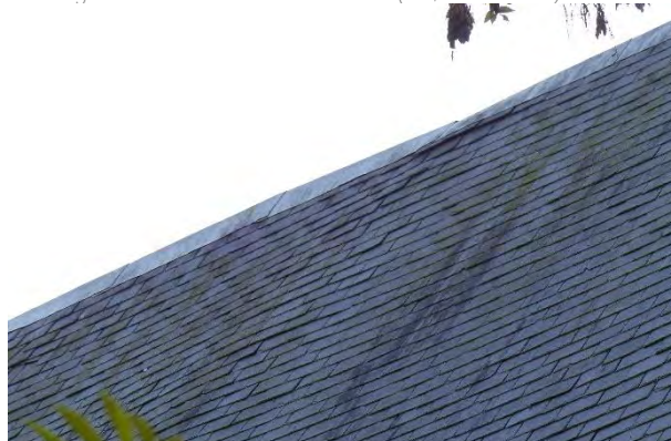
Figuur 515 (links) eerste ziekenzaal, N: Verschillende uitgeschoven en ontbrekende leien (AS, 17.10.2023)
