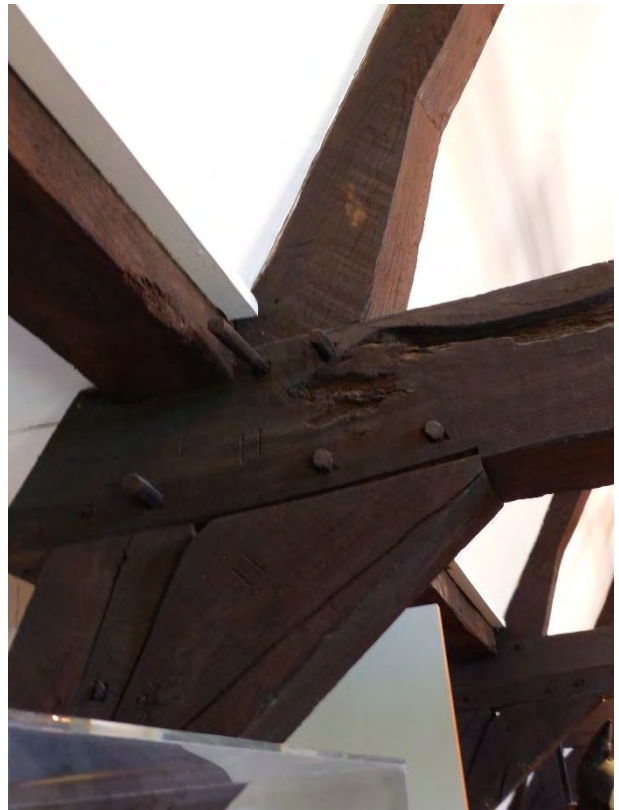
Figuur 532 (rechts) eerste ziekenzaal, 1.31: Telmerken, oude aantastingen en vernieuwde onderdelen (AS, 17.10.2023)
