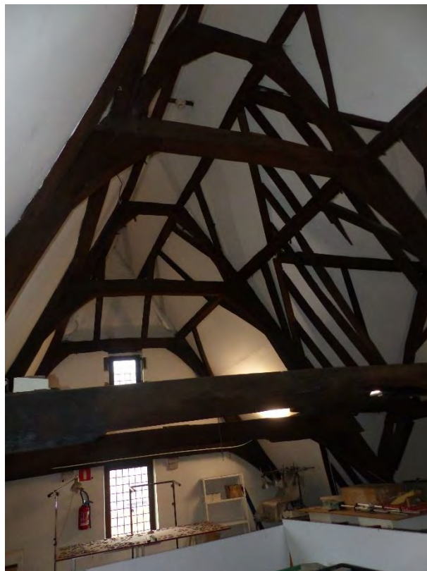
Figuur 236 (links) Klooster, noordvleugel: Verankering spant aan muurplaat (AS, 17.10.2023)
