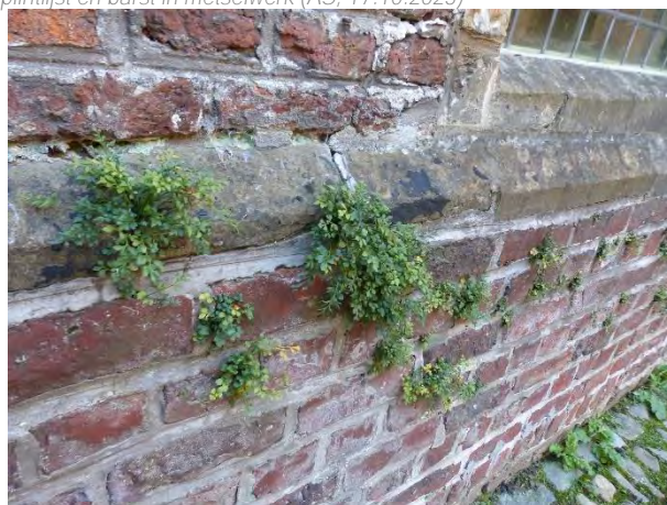
Figuur 190 (links) Pandgang noord, Z: Verwering plint en natuurstenen plintlijst en barst in metselwerk (AS, 17.10.2023)
