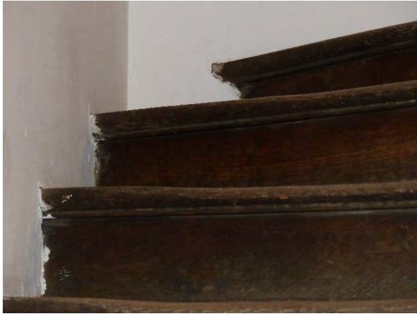
Figuur 403 (links) klooster, 0.03: Uitgesleten traptreden (AS, 17.10.2023)
