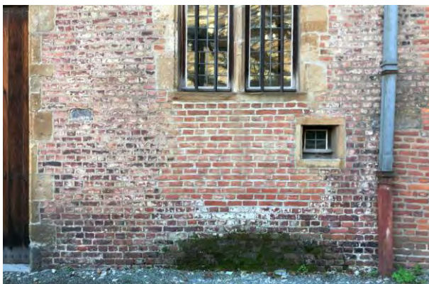
Figuur 166 (links) Klooster, noordvleugel, N: Metselwerk van de plint is sterk beschadigd. Door aanwezigheid van vocht treedt er lokaal mosvorming op (AS, 17.10.2023)
