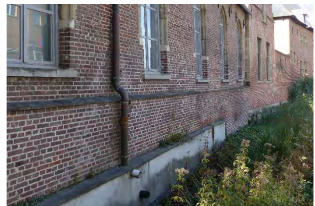
Figuur 618 derde ziekenzaal, O: Regenpijp in koper (AS, 17.10.2023)
