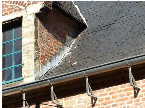
Figuur 519 (links) eerste ziekenzaal, Z: Aansluiting met getrapte dakkapel (AS, 17.10.2023)
