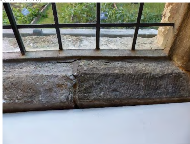
Figuur 272 (links) en Figuur 273 (rechts) Klooster, pandgang west, O: Onderzijde glas-in-loodpaneel aangestreaken met nieuwe mortel, maar deze vertoont alweer barsten door vochtschade (AS, 17.10.2023)
