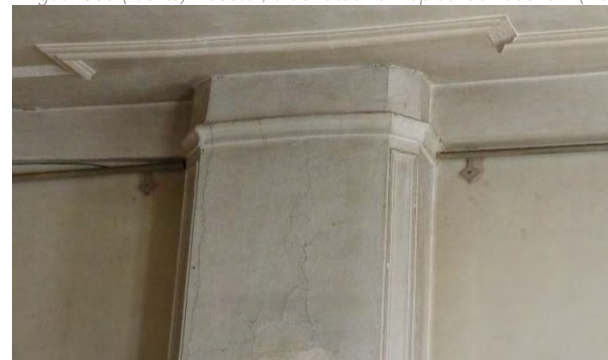
Figuur 386 (links) klooster, 0.07: Eenvoudig stucwerk dat op verschillende plaatsen scheuren vertoont. Vermoedelijk zit een grote oppervlakte pleisterwerk los (AS, 17.10.2023)
