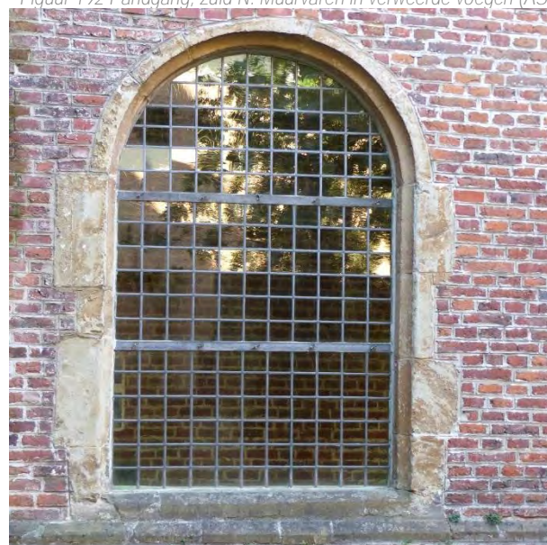
Figuur 193 (links) Pandgang, zuid N: Verwering kalkzandstenen negblokken rond ramen gelijkvloers (AS, 17.10.2023)
