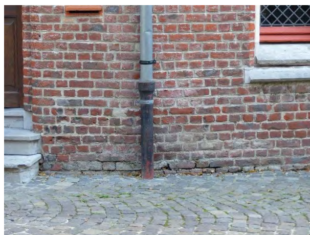
Figuur 676 (rechts) neogotische vleugel zuid, W: Gietijzeren stampijp en geblutste regenpijp (AS, 17.10.2023)
