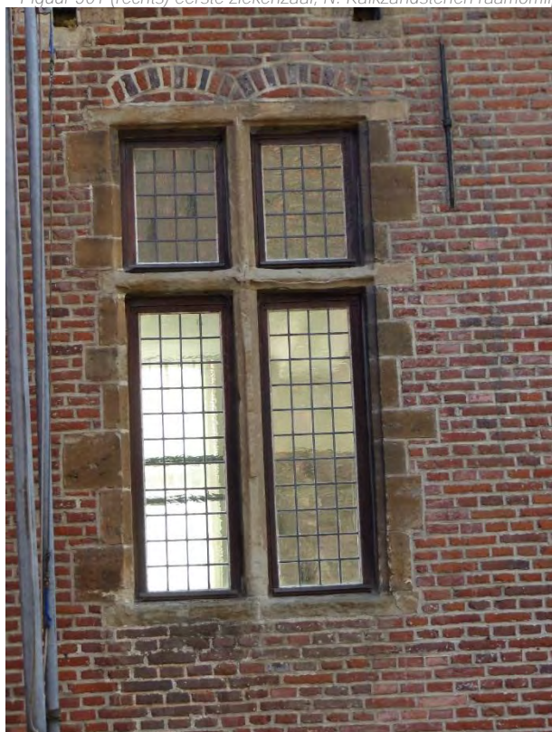
Figuur 502 (links) en Figuur 503 (rechts) eerste ziekenzaal, N: Kalkzandstenen raamomlijstingen gelijkvloers (AS, 17.10.2023)
