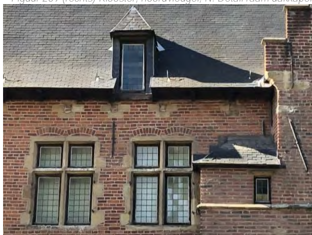
Figuur 260 (links) Klooster, oostvleugel, O: Verschillende types ramen. Mastiek bij de raamvleugel van de dakkapel zeer dik uitgevoerd (AS, 17.10.2023)
