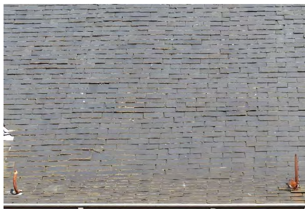
Figuur 513 (links) en Figuur 514 (rechts) eerste ziekenzaal, Z: Verschillende uitgeschoven en ontbrekende leien (AS, 17.10.2023)
