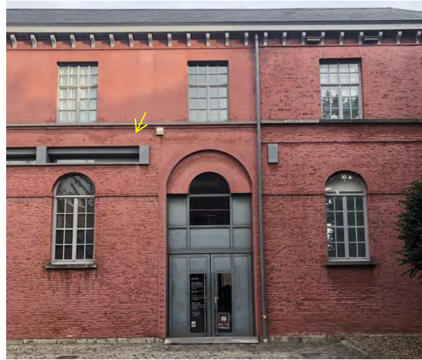
Figuur 601 (links) derde ziekenzaal Z: Vochtschade door opspattend en/of opstijgend vocht (AS, 17.10.2023)
