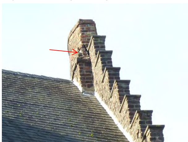
Figuur 646 (links) neogotisch vleugel zuid, pastorie, N: Grote barst in schouw door vochtschade (AS, 17.10.2023) Figuur 647 (rechts) neogotische vleugel zuid, ziekenzalen: Vochtschade aan schouw door ontbreken deksteen (17.10.2023)
