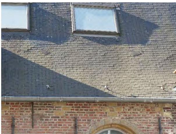
Figuur 574 (links) tweede ziekenzaal, O: Vershoven en ontbrekende leien (AS, 17.10.2023)
