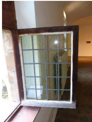
Figuur 264 (links) Klooster, pandgang west, O: Enkele vleugel met bovenlicht. Afwerkingslaag volledig verweerd (AS, 17.10.2023)
