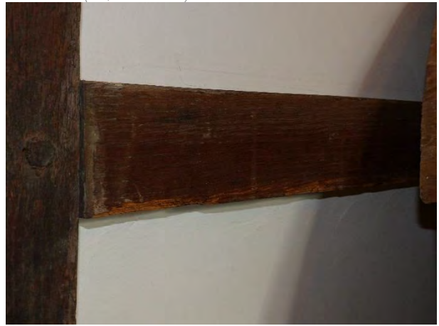
Figuur 338 (links) klooster, 0,5.02: Detail vakwerkwand met mogelijks actieve aantasting door houtborende insecten (AS, 17.10.2023)
