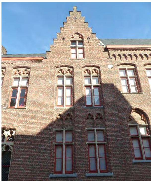
Figuur 696 (links) neogotische vleugel zuid, pastorie, W: Kruisramen in de voorgevel (AS, 17.10.2023)
