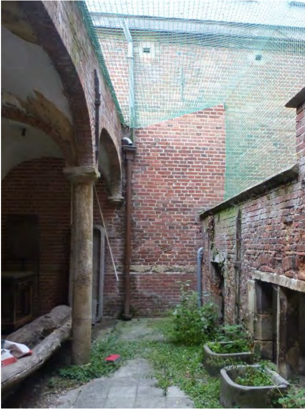
Figuur 488 (links) en Figuur 489 (rechts) eerste ziekenzaal, N(O): Vocht- en vorstschade aan het metselwerk van de noordgevel ten oosten van de kapel (AS, 17.10.2023)
