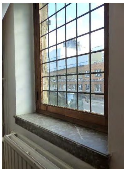
Figuur 476 (links) klooster, 0.08, Figuur 477 (midden) klooster, 1.06 en Figuur 478 (rechts) klooster, 1.07: Venstertablet in rode marmer (AS, 17.10.2023)
