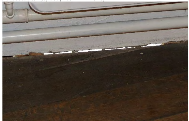
Figuur 380 (links) klooster, 1.05: Er zijn allerlei openingen gemaakt in de vloer voor de doorvoer van leidingen (AS, 17.10.2023)
