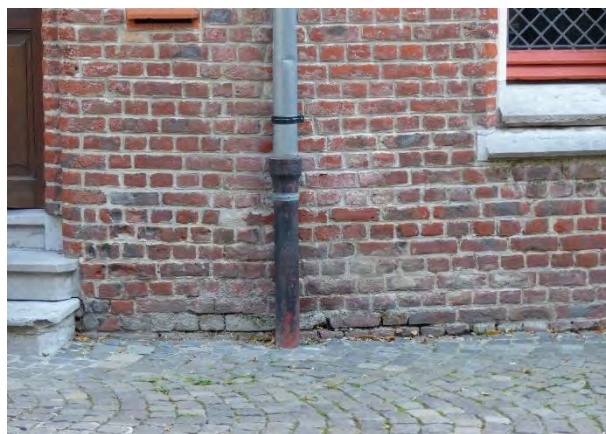
Figuur 631 (links) neogotische vleugel noord, W: Schade door opstijgend vocht, vervuild metselwerk en gebarsten dorpel (AS, 17.10.2023)
