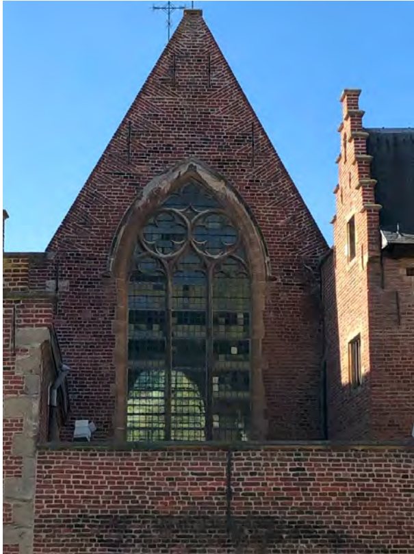
Figuur 82 (links) kapel: Oostgevel (AS, 17.10.2023)
