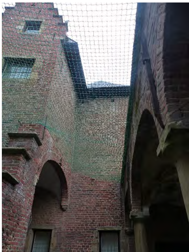
Figuur 183 (links) Klooster, oostvleugel, Z: Verweerde voegen ter hoogte van aansluiting plat dak galerij (AS, 17.10.2023)
