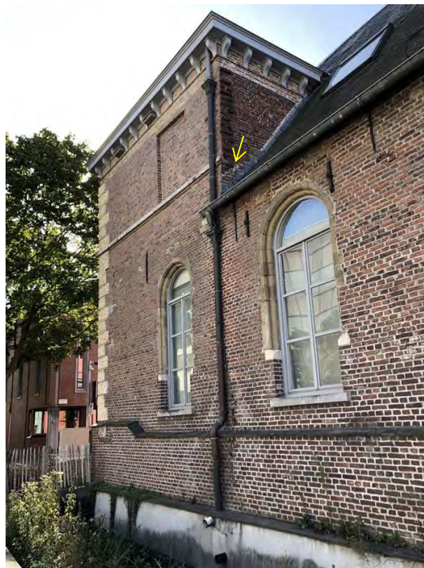
Figuur 605 (links) derde ziekenzaal, O: Zoutuitbloeiingen en biodeterioratie rond regenpijp (AS, 17.10.2023)
