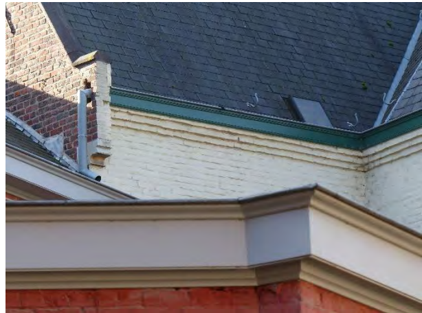
Figuur 616 (rechts) derde ziekenzaal en beeldengalerij, N: Detail aansluiting met opgaand metselwerk en bakgoten bij het hellend dak van de derde ziekenzaal en dakrand van het plat dak van de beeldengalerij (AS, 17.10.2023)
