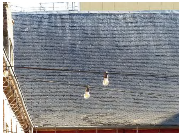
Figuur 574 (links) tweede ziekenzaal, O: Vershoven en ontbrekende leien (AS, 17.10.2023)
