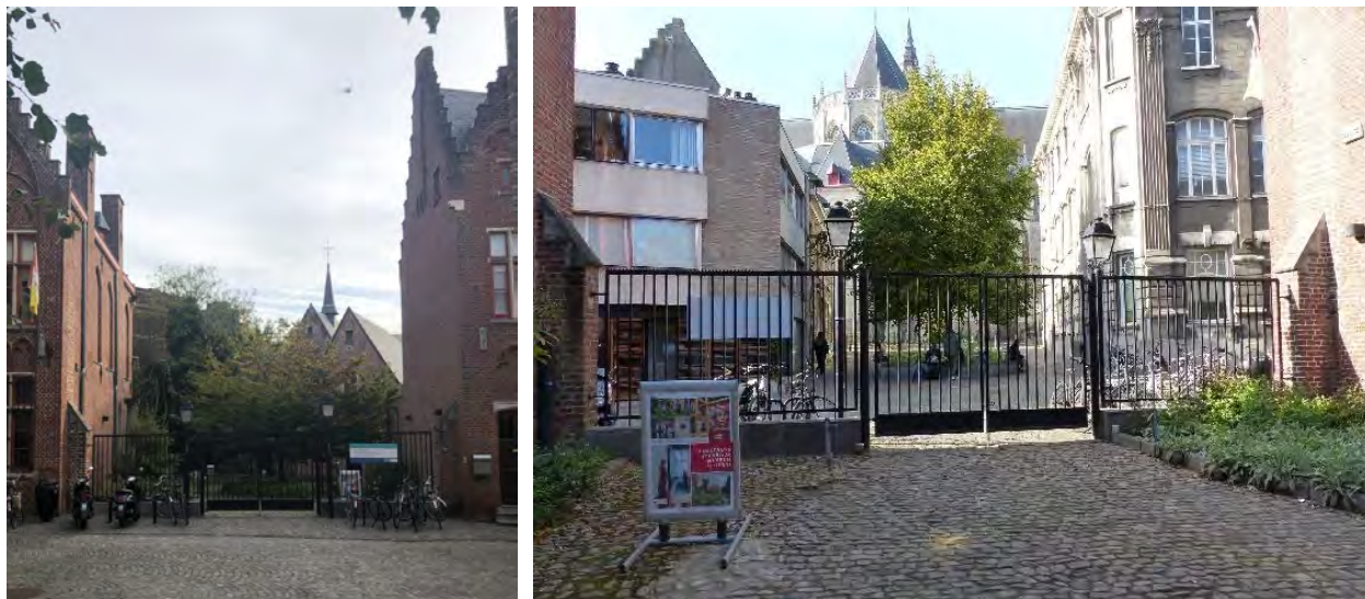
Figuur 703 (links) omgevingsaanleg binnengebied: Toegang tot de site vanaf het openbaar domein (AS, 26.09.2023)
