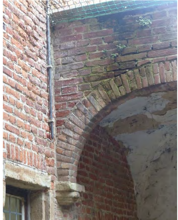
Figuur 201 (links) en Figuur 202 (rechts) Galerij, galerij: Korboggen op natuurstenen kolommen. Detail uitspoeling voegen en biodeterioratie (AS, 17.10.2023)
