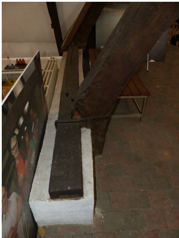
Figuur 236 (links) Klooster, noordvleugel: Verankering spant aan muurplaat (AS, 17.10.2023)
