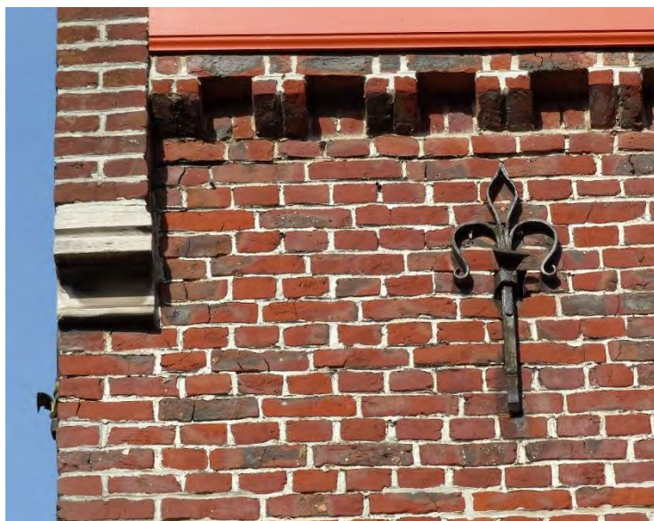
Figuur 644 (links) neogotische vleugel noord, Z: Veel bakstenen zijn gebarsten doordat ze te hard gebakken zijn (AS, 17.10.2023) Figuur 645 (rechts) neogotische vleugel noord, Z: Vocht- en vorstschade aan schouw (AS, 17.10.2023)
