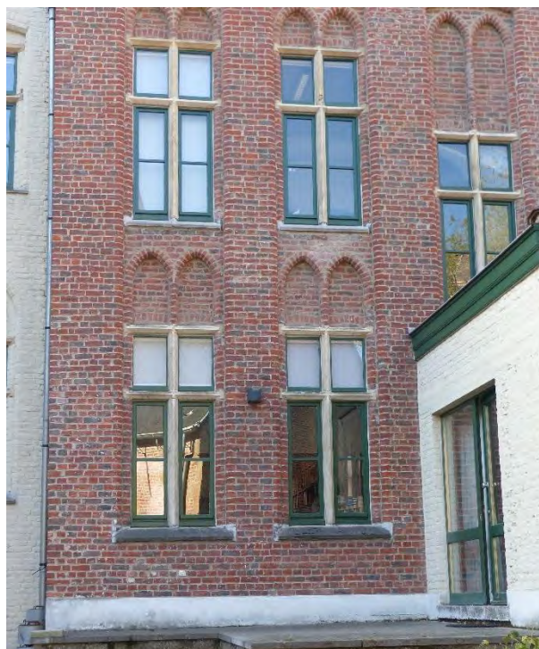
Figuur 696 (links) neogotische vleugel zuid, pastorie, W: Kruisramen in de voorgevel (AS, 17.10.2023)
