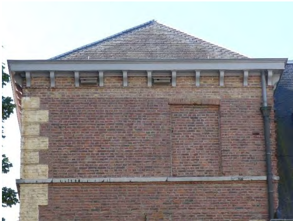
Figuur 615 (links) derde ziekenzaal, W: Hoekkeperafwerking (AS, 17.10.2023)
