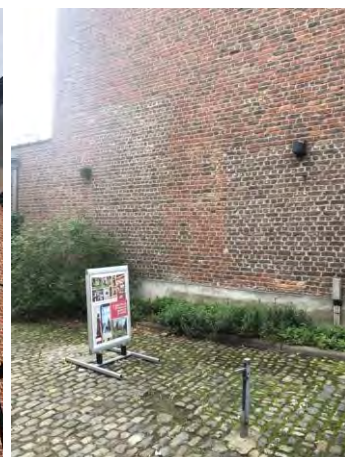
Figuur 633 (links) neogotische vleugel zuid, W: Schade door opstijgend vocht ter hoogte van overgang tussen pastorie en vijfde ziekenzaal en gekaleide plint van de ziekenzalen (AS, 17.10.2023)
