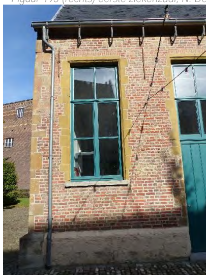
Figuur 494 (links) en Figuur 495 (midden) eerste ziekenzaal, Z: Pathologie plint zuidgevel (AS, 17.10.2023)
