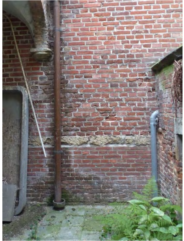
Figuur 488 (links) en Figuur 489 (rechts) eerste ziekenzaal, N(O): Vocht- en vorstschade aan het metselwerk van de noordgevel ten oosten van de kapel (AS, 17.10.2023)
