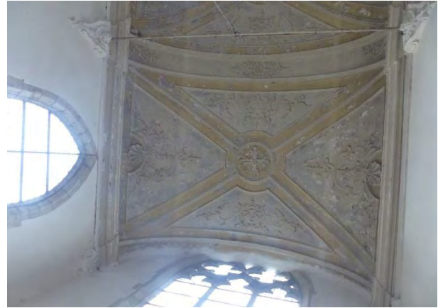
Figuur 131 (links) kapel, zolder: structuur van het oorspronkelijke en van het huidige gewelf (Monumentenwacht, 2021) Figuur 132 (rechts) kapel, schip: onderzijde van het tongewelf uit 1733 (AS, 17.10.2023)
