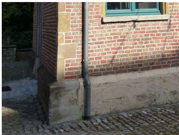
Figuur 524 (links) en Figuur 525 (rechts) eerste ziekenzaal, Z: Zinken regenpijpen met gelaste naden (AS, 17.10.2023)
