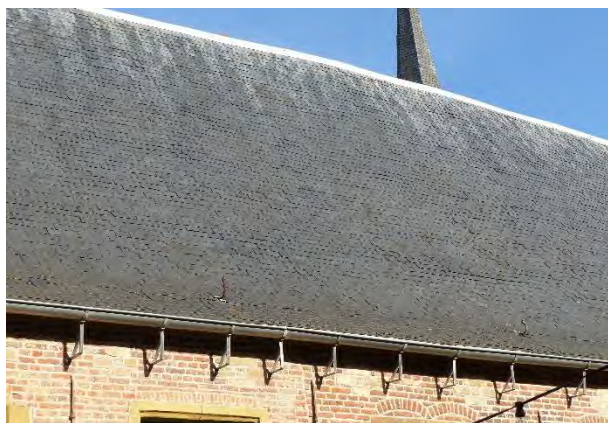
Figuur 513 (links) en Figuur 514 (rechts) eerste ziekenzaal, Z: Verschillende uitgeschoven en ontbrekende leien (AS, 17.10.2023)
