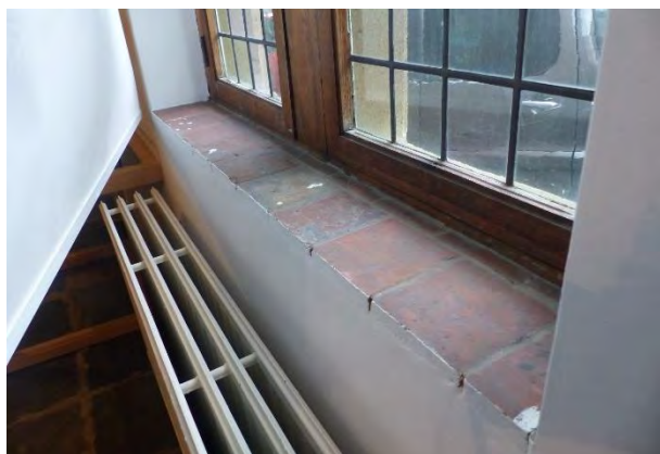
Figuur 466 (links) klooster, 0.05: Van de middelste tegels is de oppervlaktelaag verwerd (AS, 17.10.2023)
