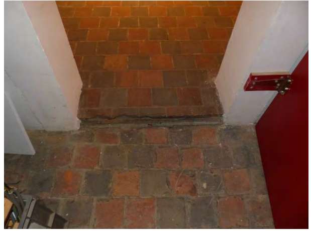
Figuur 368 (links) klooster, 1.09 (O): Vervuilde aardewerktegels. Losgekomen voegen (AS, 17.10.2023)
