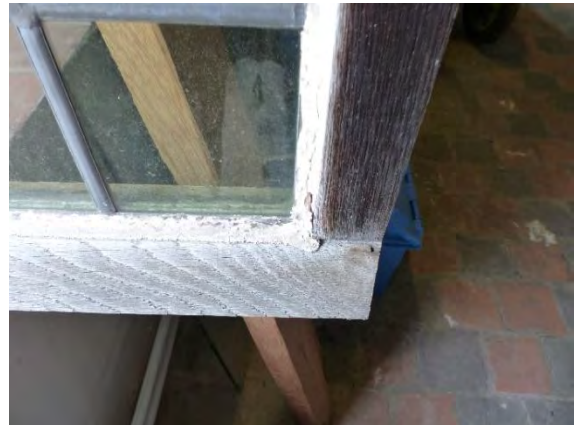
Figuur 264 (links) Klooster, pandgang west, O: Enkele vleugel met bovenlicht. Afwerkingslaag volledig verweerd (AS, 17.10.2023)
