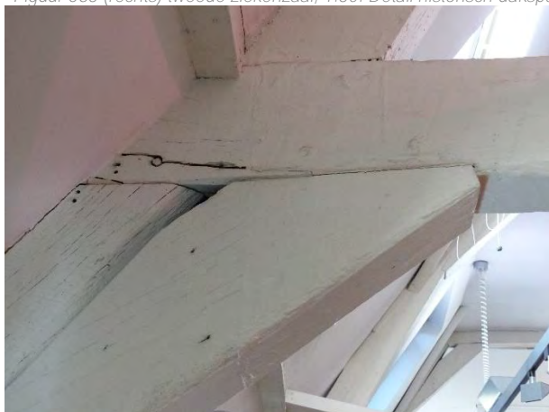
Figuur 584 (links) tweede ziekenzaal, 1.30: Barsten in hout door corrosie-expansie (AS, 17.10.2023)
