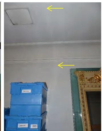
Figuur 283 (midden) en Figuur 284 (rechts) klooster, 1.09(Z): Barst die doorloopt van de noordgevel van de zuidelijke pandgang, over het plafond tot de gemene muur met de kapel, vermoedelijk structureel (AS, 17.10.2023)
