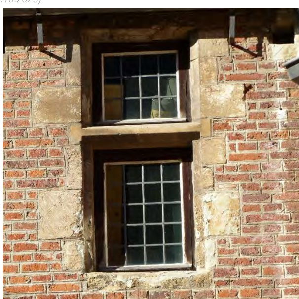
Figuur 193 (links) Pandgang, zuid N: Verwering kalkzandstenen negblokken rond ramen gelijkvloers (AS, 17.10.2023)
