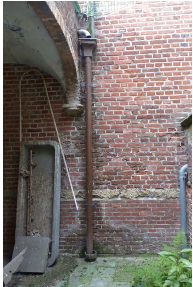
Figuur 227 (linksboven) Pandgang zuid: Sterk verweerde tapbuis in plat dak (Monumentenwacht, 2021)
