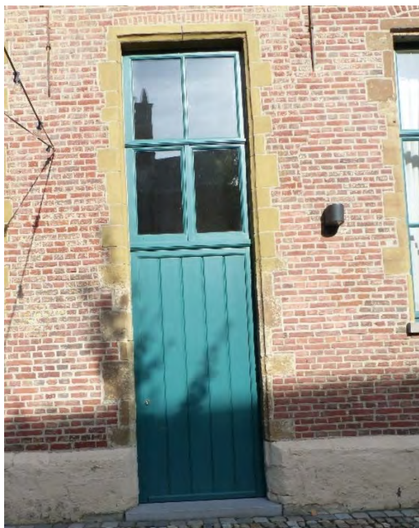
Figuur 535 (links) en Figuur 536 (rechts) eerste ziekenzaal. Z: Opgeklampte houten deur in de zuidgevel (AS, 17.10.2023)
