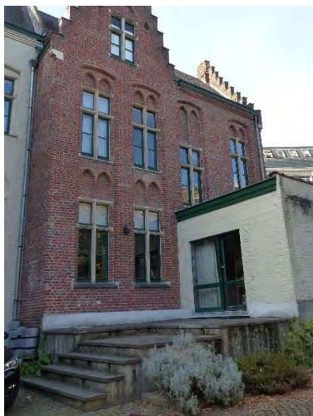
Figuur 700 (links) en Figuur 701 (rechts) neogotische vleugel zuid, pastorie, O: Terras in breuksteen op gecementeerde sokkel (AS, 17.10.2023)
