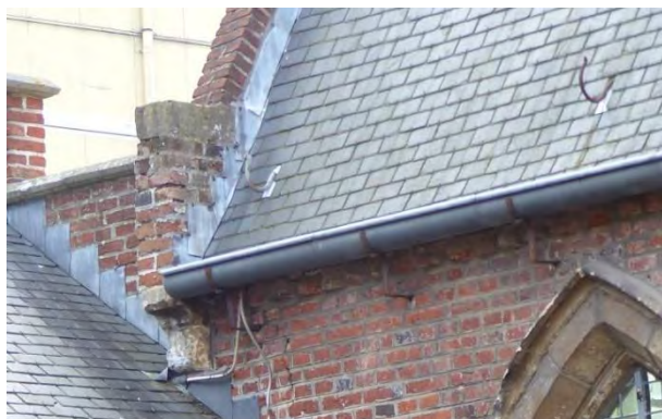
Figuur 100 (links) kapel, N: Aansluiting noordelijk dakvlak met oostgevel (AS, 17.10.2023)
