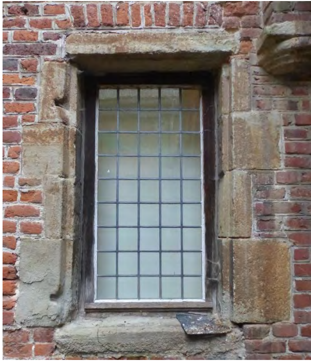
Figuur 262 (links) Klooster, oostvleugel, Z: Afwerkingslaag volledig verweerd (AS, 17.10.2023)
