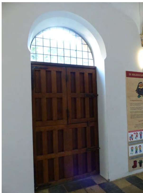
Figuur 254 (links) en Figuur 255 (rechts) Klooster, pandgang, O: Verweerde afwerkingslaag van de toegangsdeur tot de kloostertuin (AS, 17.10.2023)
