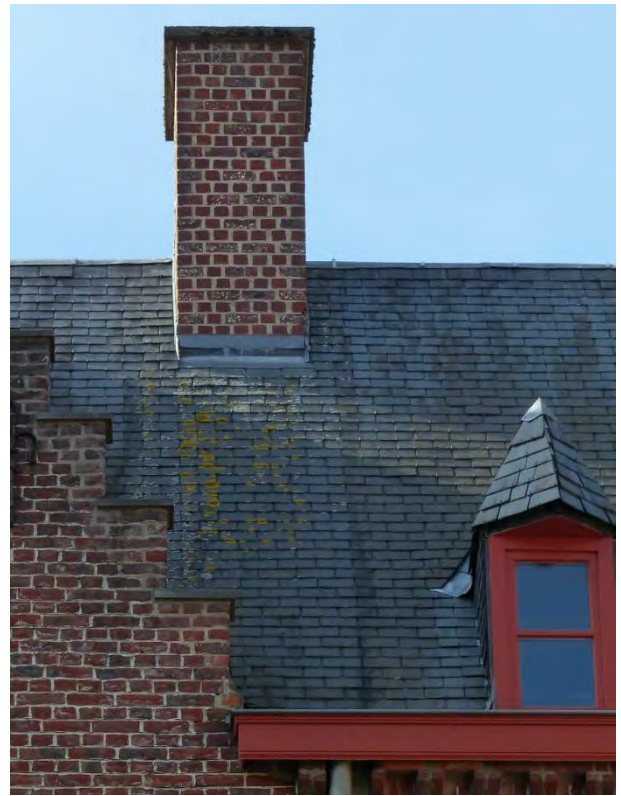
Figuur 663 (links) en Figuur 664 (rechts) neogotische vleugel noord, O: Grote zones hersteld met gehaakte leien. Loden slabben nok vervormd, beugels zitten los of staan open (AS, 17.10.2023)
