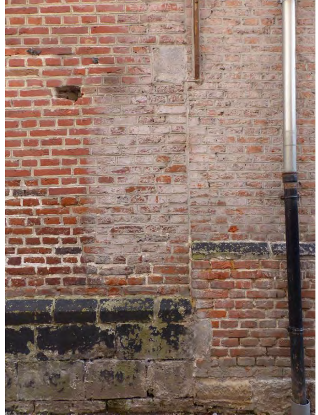
Figuur 174 (links) Klooster, noordvleugel, Z-W: Voegen topgevel (W) uitgespoeld (AS, 17.10.2023) Figuur 175 (rechts) Klooster, noordvleugel, W: Diverse bouwsporen (AS, 17.10.2023)
