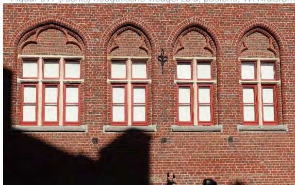
Figuur 698 (links) neogotische vleugel zuid, vierde ziekenzaal, Z: Drieliicht en kruisramen in de voorgevel (AS, 17.10.2023)
