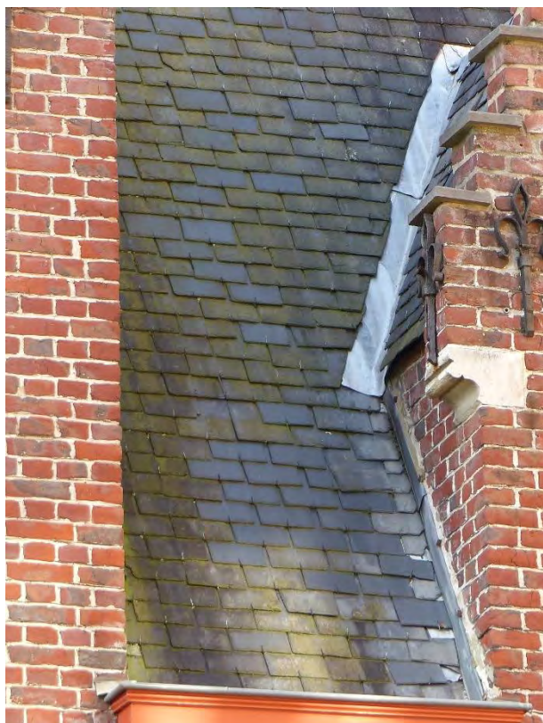
Figuur 667 (links) neogotische vleugel noord, aanbouw, O: Aansluiting met opgaand metselwerk met loden slabben en gecorrodeerde krammen. Lokaal ontbreken leien (AS, 17.10.2023)
