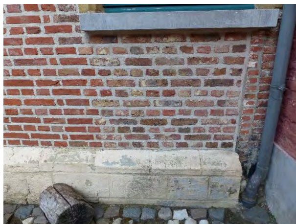
Figuur 524 (links) en Figuur 525 (rechts) eerste ziekenzaal, Z: Zinken regenpijpen met gelaste naden (AS, 17.10.2023)
