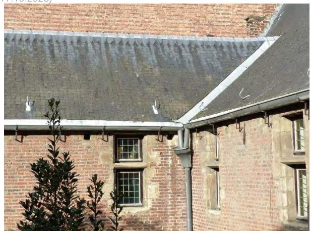
Figuur 213 (links) Klooster, oostvleugel en pandgang oost, W: Schadepatroon daken (AS, 17.10.2023)
