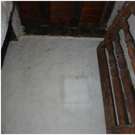
Figuur 324 (links) klooster, 0.04: Vermoedelijk nog oorspronkelijk pleisterwerk in de bewaarplaats voor vlees boven de schouw van de keuken (AS, 17.10.2023)
