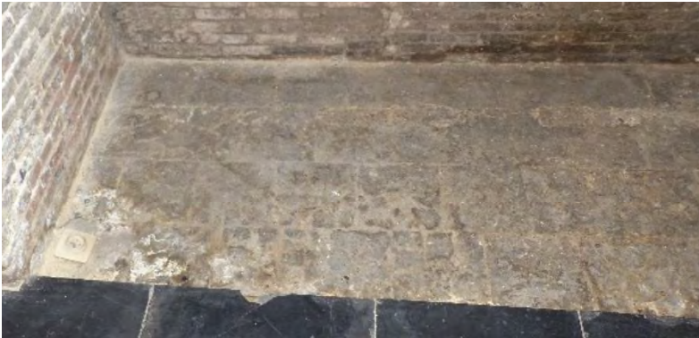
Figuur 363 (links) klooster, 0.04: De haard in de keuken is voorzien van een vloer in ongeglazuurde blauwgrijze aardewerktegels. De tegels zijn sterk beschadigd (AS, 17.10.2023)
