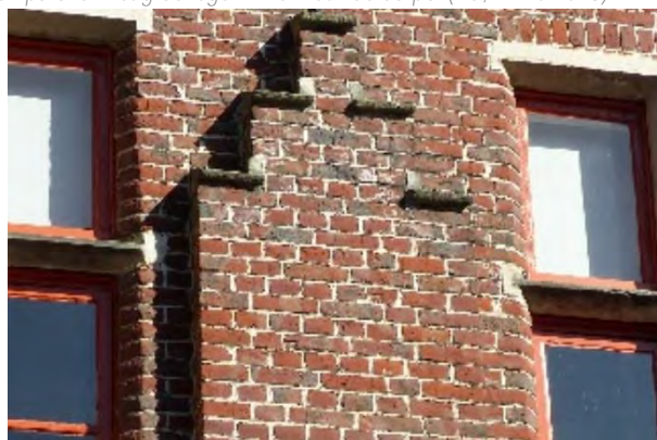
Figuur 656 (links) neogotische vleugel zuid, trappenhuis, N: Verweerde raamdorpels (AS, 17.10.2023)
