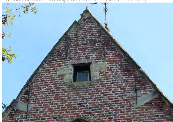
Figuur 88 (links) en Figuur 89 (rechts) kapel, W: Detail puntgevel. Verweerd voegwerk en gecorrodeerde gevelankers. Verweerde dekstenen (AS, 17.10.2023)
