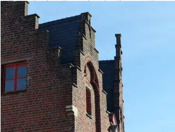
Figuur 642 (links) en Figuur 643 (rechts) neogotische vleugel zuid, pastorie: Vochtschade trapgevels (AS, 17.10.2023)
