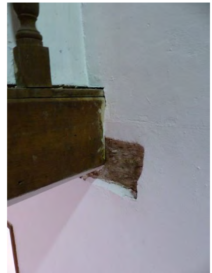
Figuur 418 (rechts) klooster, 2.08: Op zolder rust de borstwering op een ingemetselde houten console (AS, 17.10.2023)
