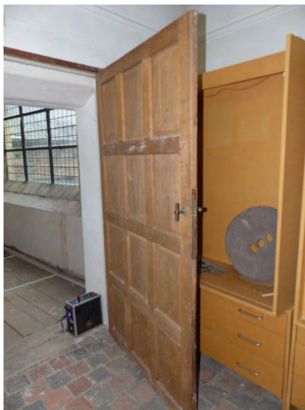
Figuur 141 (links) en Figuur 142 (rechts) kapel: Opgeklampte eikenhouten deur (AS, 17.10.2023)
