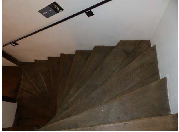
Figuur 406 (rechts) klooster, 0.03: Bovenzicht trap van gelijkvloers naar eerste verdieping (AS, 17.10.2023)
