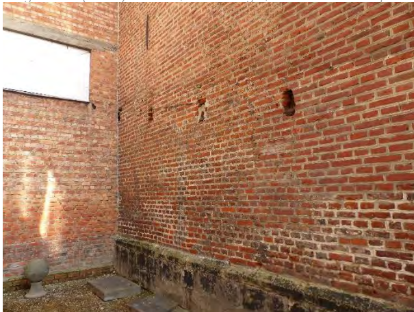
Figuur 176 (links) Klooster, noordvleugel, W: Gepekte natuurstenen plint. Lacunes in metselwerk (AS, 17.10.2023) Figuur 177 (rechts) Klooster, noordvleugel, W: Natuurstenen dekstenen en consoles verweerd (AS, 17.10.2023)
