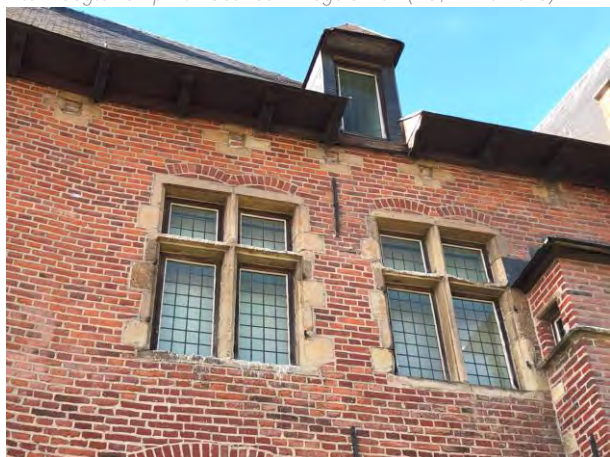
Figuur 185 (links) Klooster, oostvleugel, O: Verwerking dorpels, kruismonelen en negblokken (AS, 17.10.2023)
