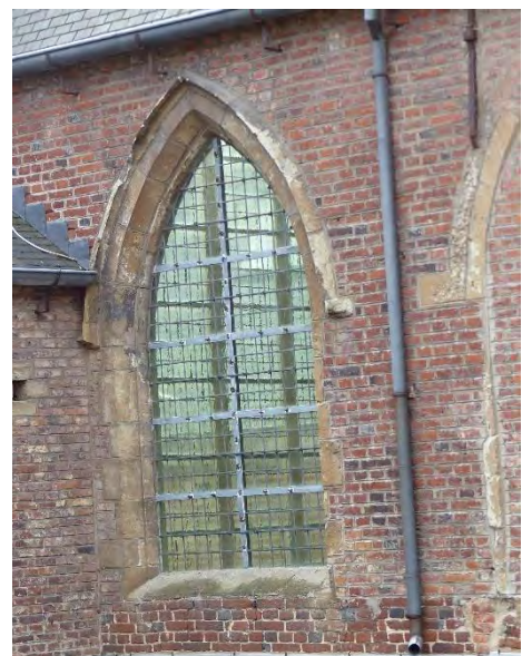
Figuur 90 (links) kapel, N: Natuurstenen raamomlijsting schilfert af. Herstellingen met cementmortel (AS, 17.10.2023)
