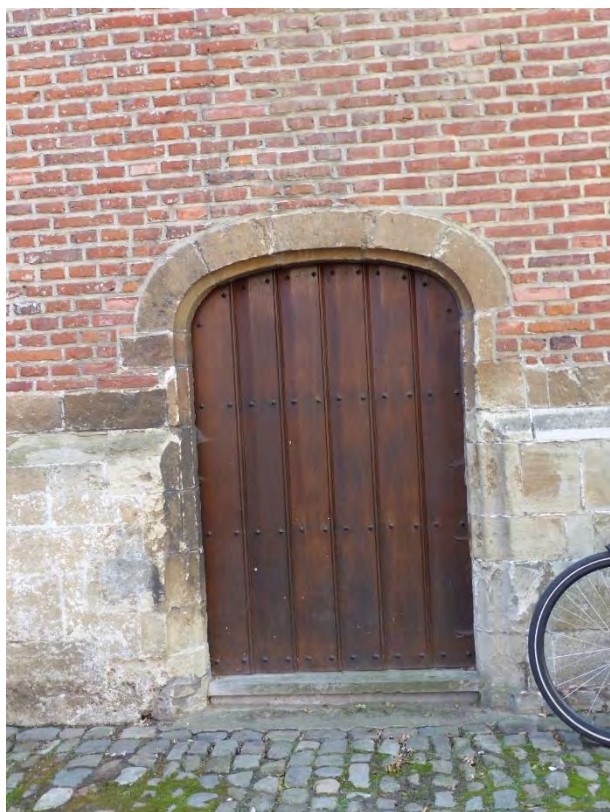
Figuur 500 (links) eerste ziekenzaal, N: Kalkzandstenen plint en deuroplijsting (AS, 17.10.2023)
