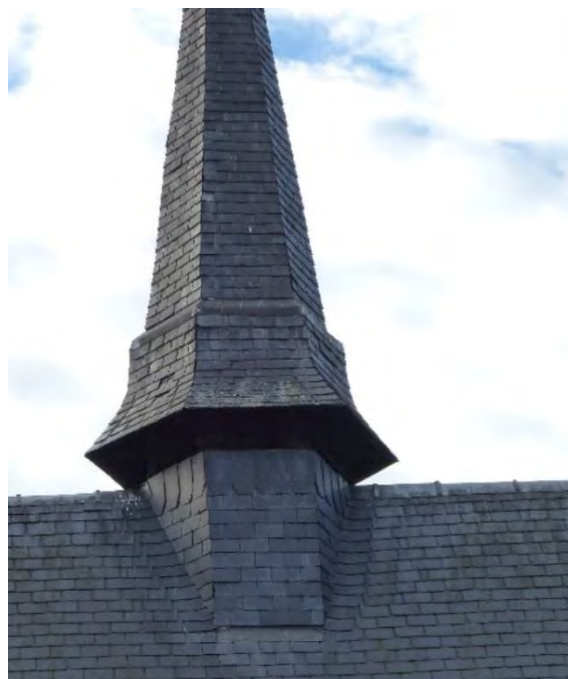
Figuur 96 (links) kapel, N: Zadeldak bedekt met natuurleien en aansluiting met westelijke puntgevel (AS, 17.10.2023)
