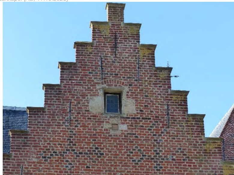
Figuur 497 (links) eerste ziekenzaal, O: Vervuiling metselwerk oostgevel (AS, 17.10.2023)
