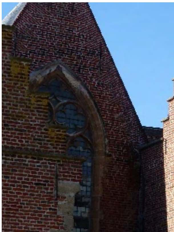
Figuur 84 (links) kapel, O: Vochtschade t.h.v. schouderstukken en vervuiling t.h.v. regenwaterafvoer (AS, 17.10.2023)
