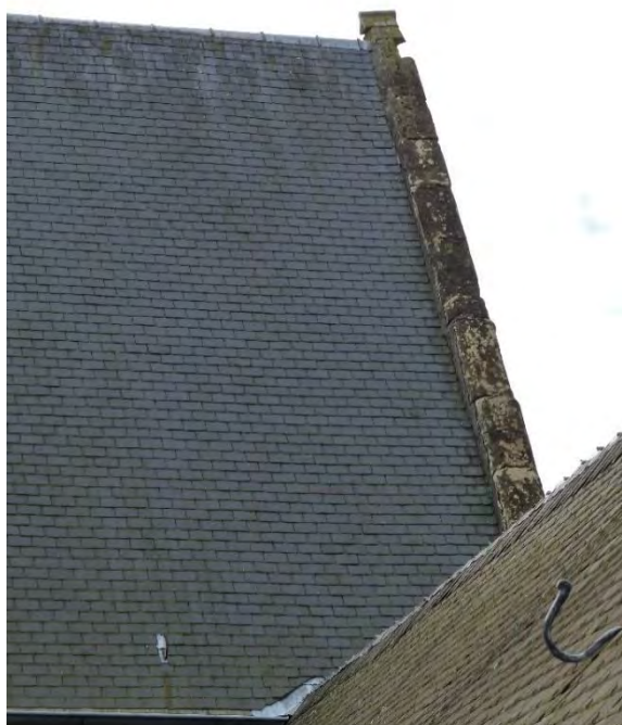
Figuur 96 (links) kapel, N: Zadeldak bedekt met natuurleien en aansluiting met westelijke puntgevel (AS, 17.10.2023)
