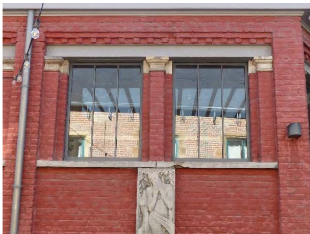
Figuur 609 (links) beeldengalerij, N: Detail metselwerk rond ramen. Lokaal lacunes in het parement (AS, 17.10.2023)
