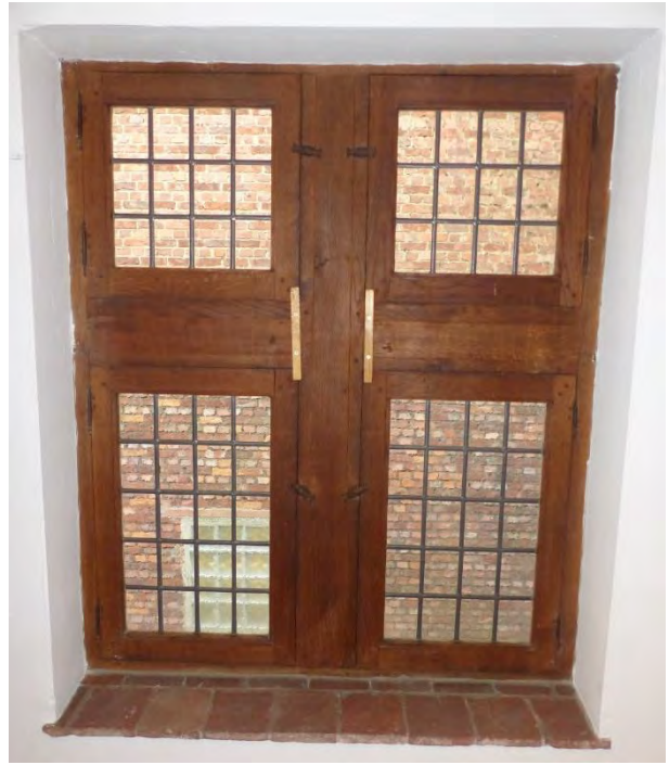
Figuur 262 (links) Klooster, oostvleugel, Z: Afwerkingslaag volledig verweerd (AS, 17.10.2023)
