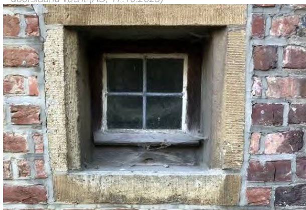
Figuur 258 (links) Klooster, noordvleugel, N: Enkele vleugel, afwerkingslaag volledig verweerd (AS, 17.10.2023)
