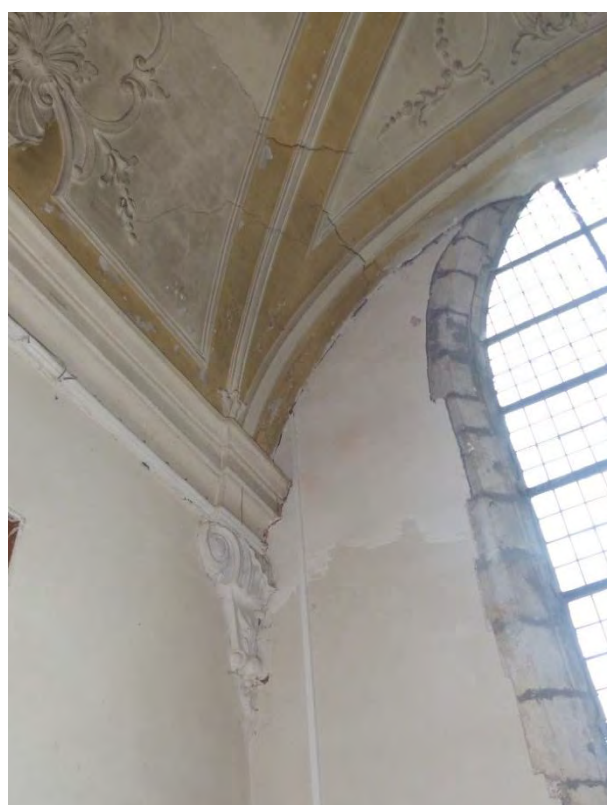
Figuur 135 (links) en Figuur 136 (rechts) kapel, schip: Detail barsten in stucwerk en afbladderen verf (AS, 17.10.2023)
