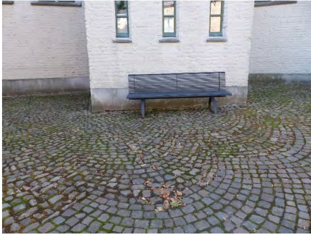
Figuur 650 (links) neogotische vleugel zuid, ziekenzalen, N: Gecementeerde plint vertoont sporen van vocht (AS, 17.10.2023)
