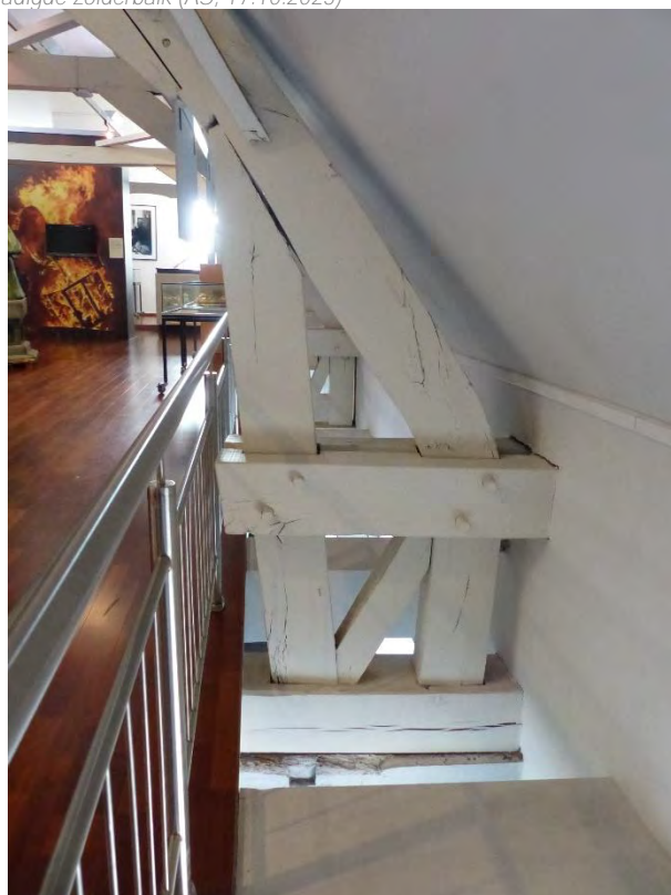
Figuur 582 (links) tweede ziekenzaal, 1.30: Historisch dakspant met verschillende vervangingen (AS, 17.10.2023)
