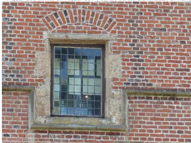
Figuur 508 (links) eerste ziekenzaal, O: Cordonlijst en omlijsting raam eerste verdieping (AS, 17.10.2023)
