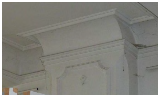
Figuur 384 (links) klooster, 0.05: Vrij eenvoudig stucwerk. De afwerking is vermoedelijk niet oorspronkelijk, aangezien in het interieur gotische elementen terug te vinden zijn (AS, 17.10.2023)
