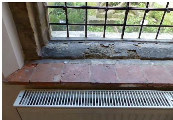
Figuur 466 (links) klooster, 0.05: Van de middelste tegels is de oppervlaktelaag verwerd (AS, 17.10.2023)
