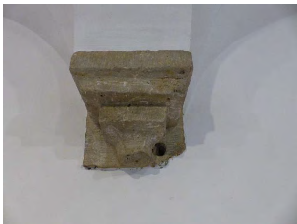
Figuur 308 klooster, 1.09 (O): Doorboring in kraagsteen pandgang oost op de eerste verdieping (AS, 17.10.2023)
