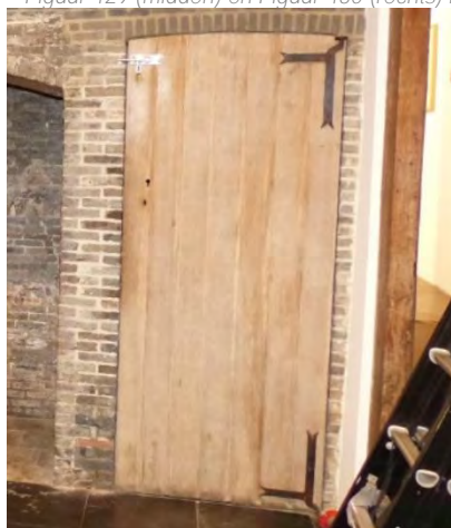
Figuur 431 (links) klooster, 0.04: Kelderdeur met smeedijzeren geheng, plaatselijk gecorrodeerd (AS, 17.10.2023)
