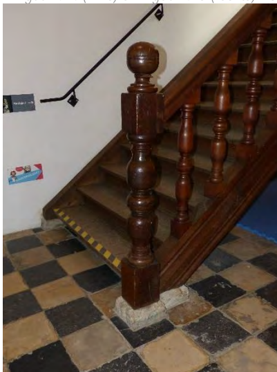
Figuur 416 (links) klooster, 0.08: De trapboom rust op een console in blauwe hardsteen (AS, 17.10.2023)
