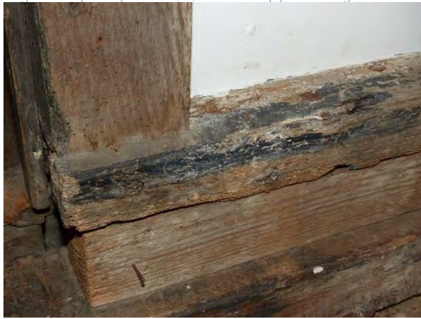
Figuur 338 (links) klooster, 0,5.02: Detail vakwerkwand met mogelijks actieve aantasting door houtborende insecten (AS, 17.10.2023)
