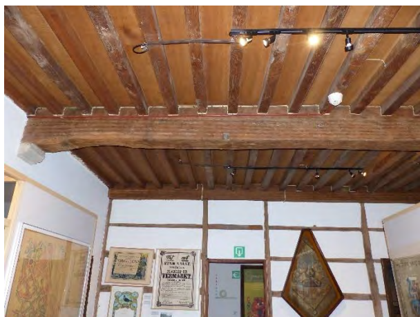
Figuur 320 (links) klooster, 1.04: Zichtbare roostering in de noordvleugel (AS, 17.10.2023)
