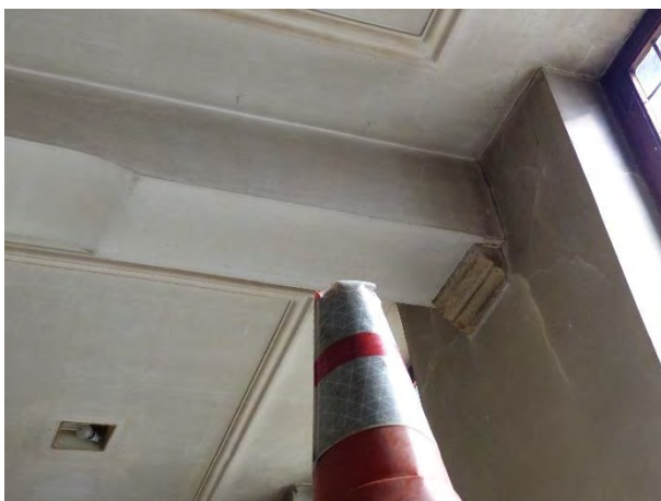
Figuur 282 (links) klooster, 0.07: Barst onder natuurstenen console, vermoedelijk structureel (AS, 17.10.2023)
