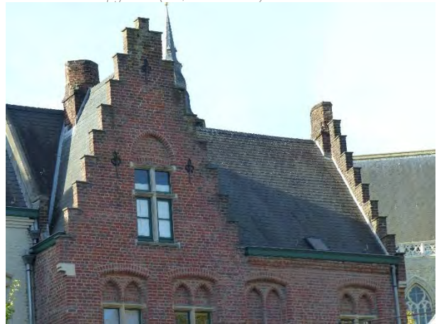
Figuur 642 (links) en Figuur 643 (rechts) neogotische vleugel zuid, pastorie: Vochtschade trapgevels (AS, 17.10.2023)
