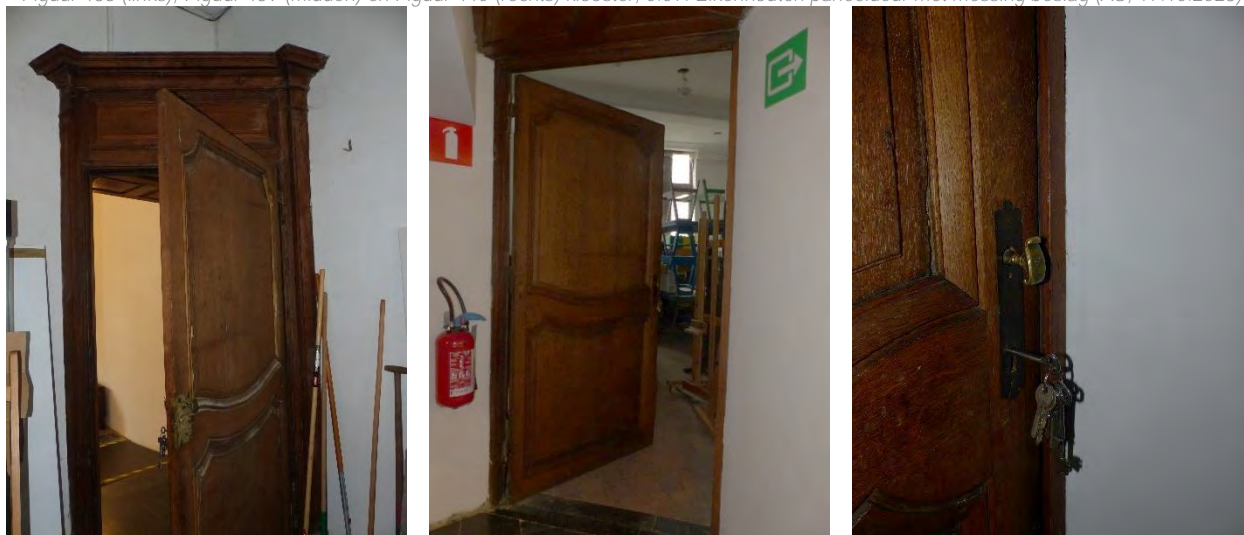
Figuur 441 (links), Figuur 442 (midden) en Figuur 443 (rechts) klooster, 0.06: Eikenhouten paneeldeur met messing beslag (AS, 17.10.2023)
