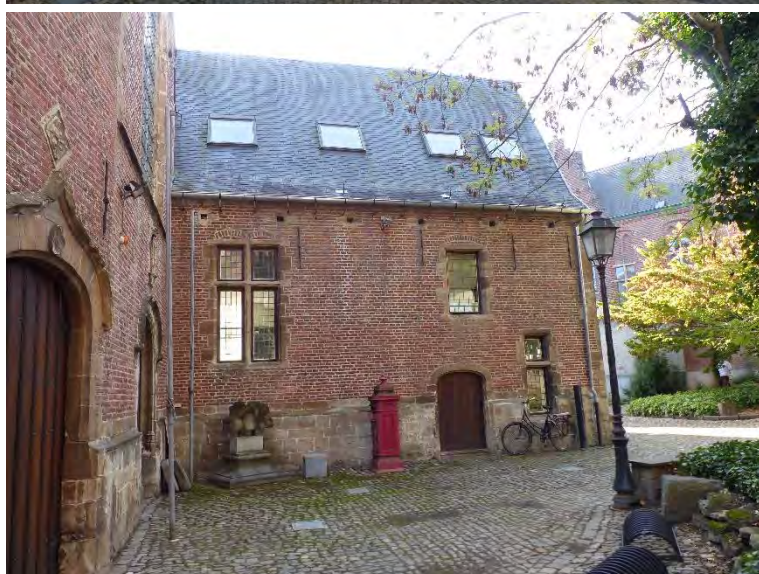
Figuur 22 Klooster en kapel (links) en eerste ziekenzaal (rechts), zicht vanuit binnengebied (AS, 17.10.2023)
