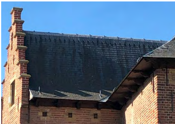
Figuur 211 (links) Klooster, oostvleugel, O: Schadepatroon daken (AS, 17.10.2023)
