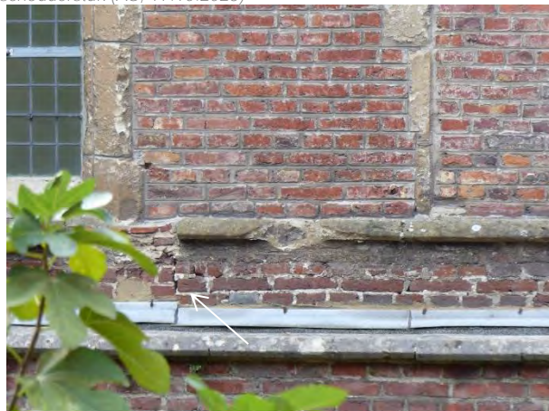
Figuur 86 (links) kapel, N: Vochtig metselwerk boven loszittende traploketten (AS, 17.10.2023)
