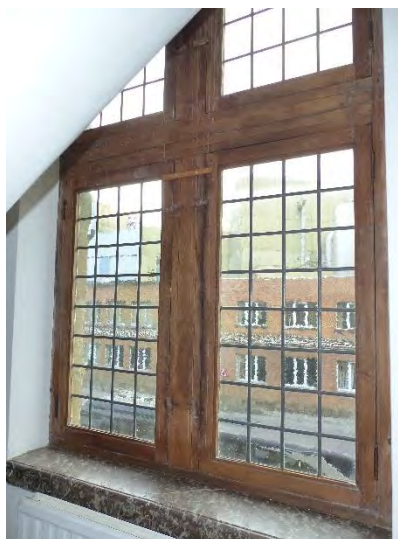
Figuur 476 (links) klooster, 0.08, Figuur 477 (midden) klooster, 1.06 en Figuur 478 (rechts) klooster, 1.07: Venstertablet in rode marmer (AS, 17.10.2023)
