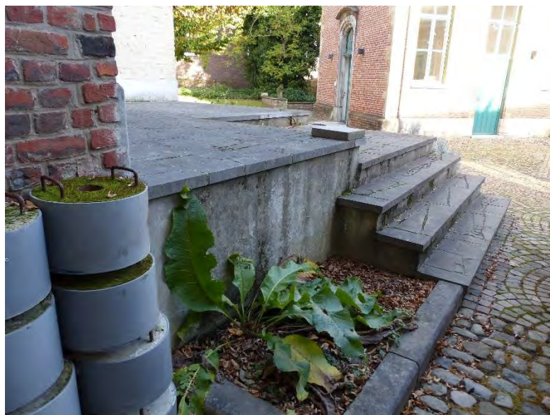
Figuur 700 (links) en Figuur 701 (rechts) neogotische vleugel zuid, pastorie, O: Terras in breuksteen op gecementeerde sokkel (AS, 17.10.2023)
