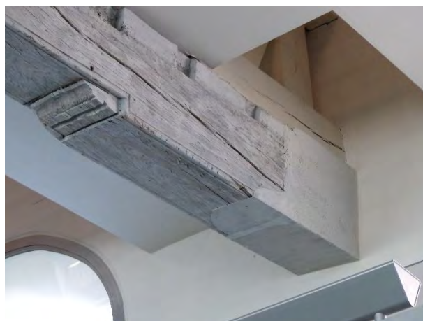
Figuur 580 (links) tweede ziekenzaal, 0.30: Zolderbalken zijn zwaar beschadigd door brand in 1979 (AS, 17.10.2023)
