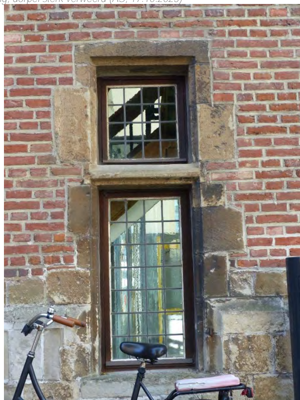
Figuur 502 (links) en Figuur 503 (rechts) eerste ziekenzaal, N: Kalkzandstenen raamomlijstingen gelijkvloers (AS, 17.10.2023)
