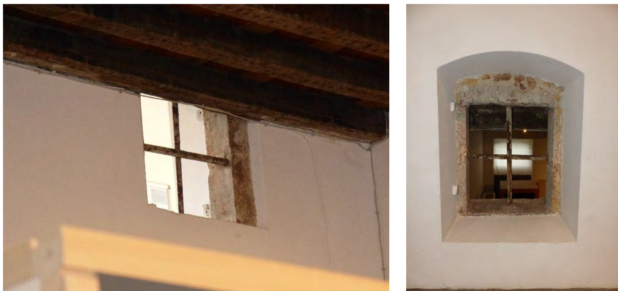
Figuur 453 (links) klooster 0.05 en Figuur 454 (rechts) klooster, 1.09: Opening met diefijzer (AS, 17.10.2023)
