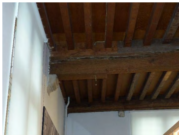
Figuur 322 (links) en Figuur 323 (rechts) klooster, 1.05: De moerbalken zijn deels vervangen (AS, 17.10.2023)
