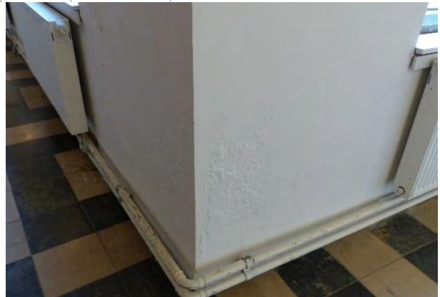
Figuur 292 (links) en Figuur 293 (rechts) klooster, 0.09 (Z): In elke hoek van de pandgang is er schade aan het pleisterwerk door vochtdoorslag ter hoogte van de regenpijpen (AS, 17.10.2023)
