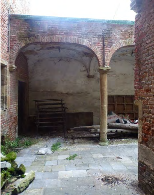
Figuur 201 (links) en Figuur 202 (rechts) Galerij, galerij: Korboggen op natuurstenen kolommen. Detail uitspoeling voegen en biodeterioratie (AS, 17.10.2023)
