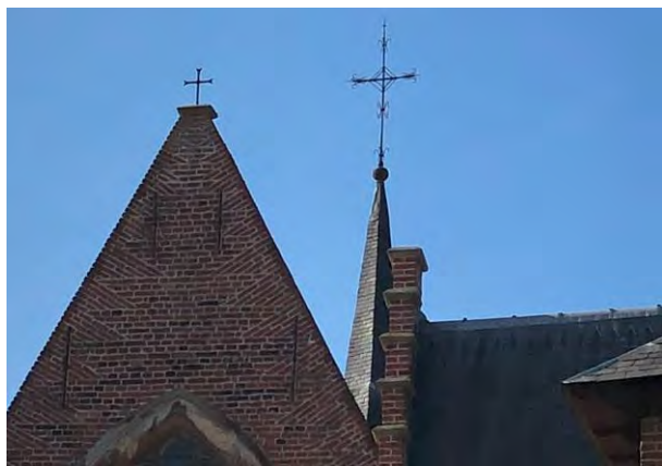
Figuur 104 (links) kapel, O: Topbekroning oostgevel en dakruiter (AS, 17.10.2023)
