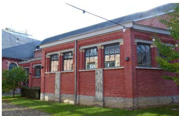
Figuur 607 (links) beeldengalerij, N: Rozerood gekaleid metselwerk op grijs gekaleide plint (AS, 17.10.2023)
