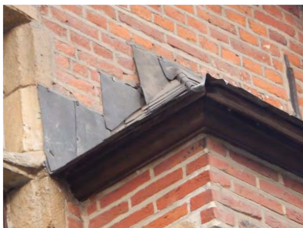
Figuur 215 (links) Klooster, oostvleugel, O: Opgewaaid traploket boven erker (Monumentenwacht, 2021)
