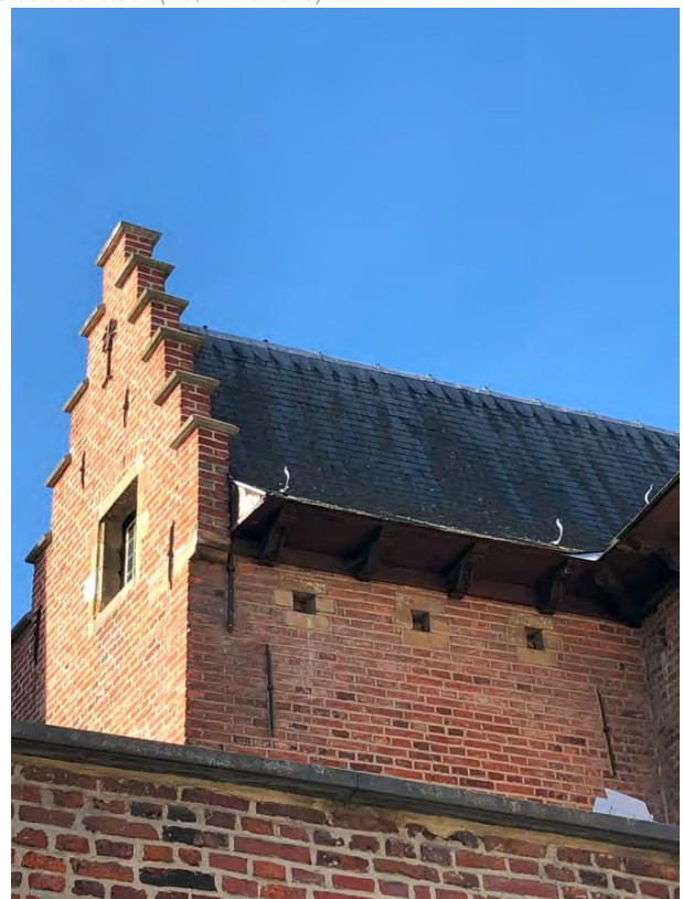
Figuur 181 (links) Klooster, oostvleugel, O: Metselwerk erker sterk vervuild en lokaal herstellingen met andere kleur baksteen. Kalf van het onderste kruismoneel (recent) vernieuwd (AS, 17.10.2023)
