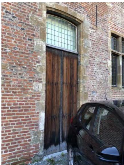
Figuur 248 (links) en Figuur 249 (rechts) Klooster, noordvleugel, N: Vernislaag afgesleten over de volledige oppervlakte van de deur, waardoor aan de binnenzijde sporen van waterinfiltratie zichtbaar zijn. De beplanking is lokaal gespleten (AS, 17.10.2023)
