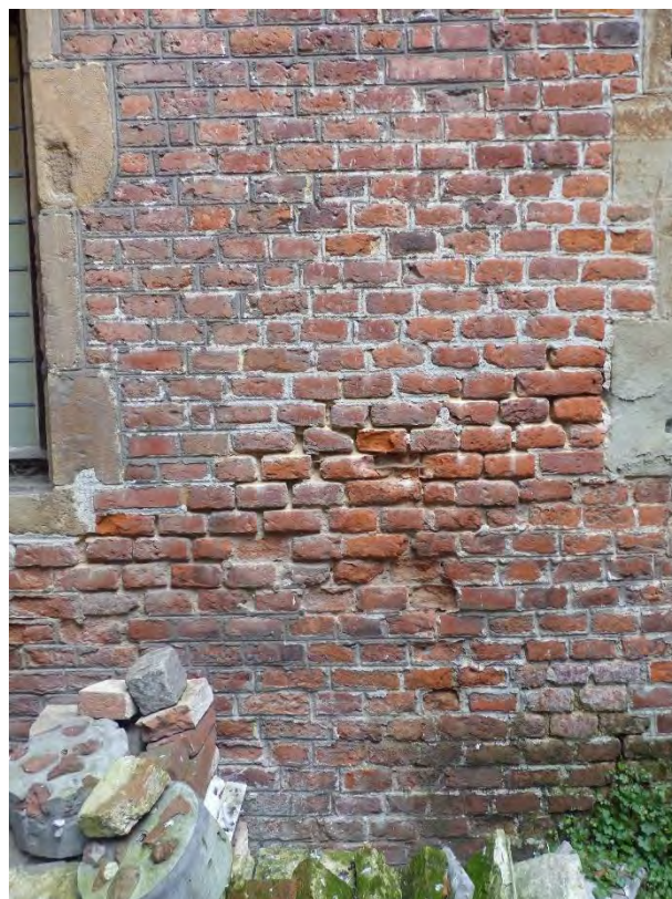
Figuur 183 (links) Klooster, oostvleugel, Z: Verweerde voegen ter hoogte van aansluiting plat dak galerij (AS, 17.10.2023)
