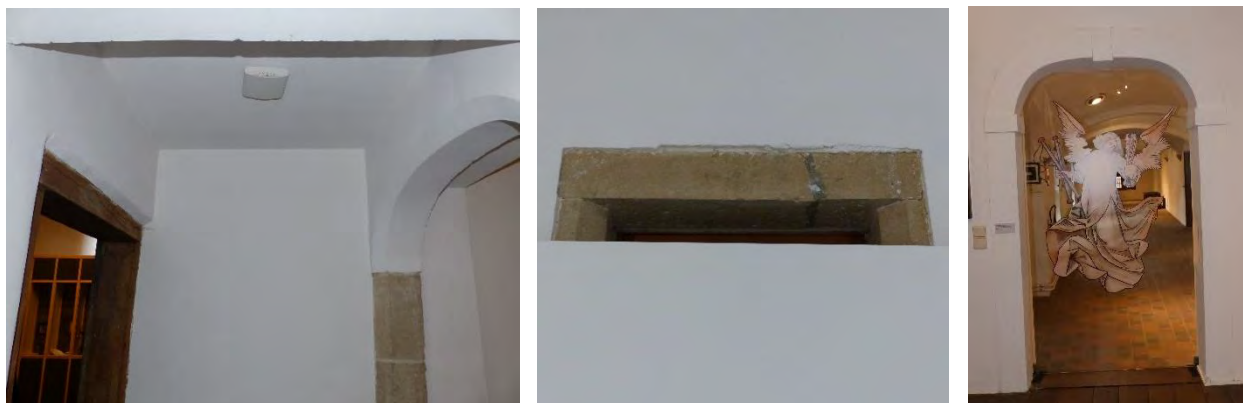
Figuur 444 (links) klooster, 0.04 en 0.05: Houten deuromlijsting naar voormalige keuken en natuurstenen en gepleisterde deuromlijsting naar voormalige refter (AS, 17.10.2023)
