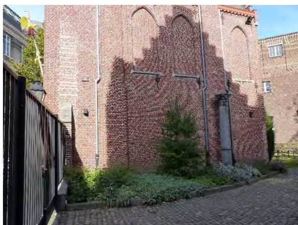
Figuur 675 (links) neogotische vleugel noord, Z: Zinken regenpijpen (AS, 17.10.2023)
