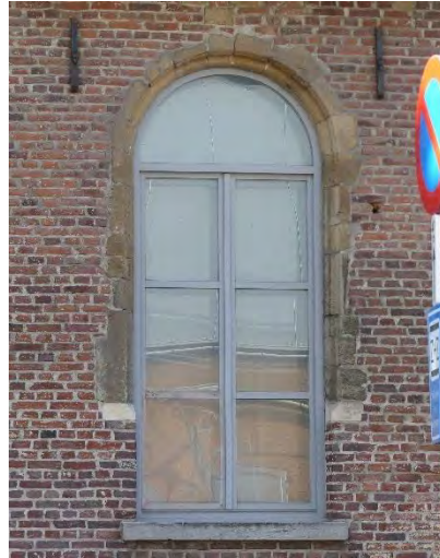
Figuur 571 (links) en Figuur 572 (midden) tweede ziekenzaal, O: Kalkzandstenen raamomlijsting en kalkzandstenen elementen boven de ramen (AS, 17.10.2023)
