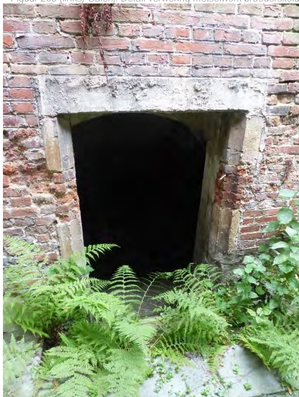
Figuur 207 (links) Galerij, broederskelder: Detail verwerking metselwerk en kalkzandstenen deuromlijsting (AS, 17.10.2023)
