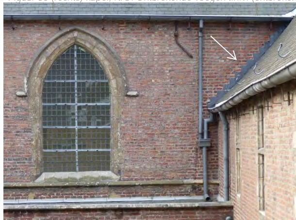
Figuur 86 (links) kapel, N: Vochtig metselwerk boven loszittende traploketten (AS, 17.10.2023)
