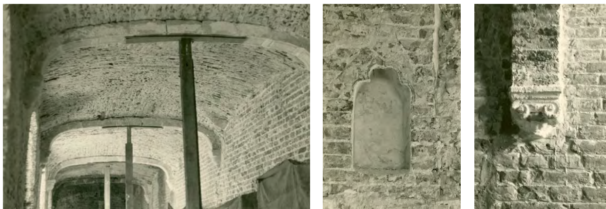
Figuur 63 (links) Het pleisterwerk van de wanden en de plafonds van de pandgang werd verwijderd (S.N., Restauratie – Oud-Hospitaal – Oude Vismarkt – Aalst, 1959-1964, © SAA: nr. Oud-Hospitaal.055.)
