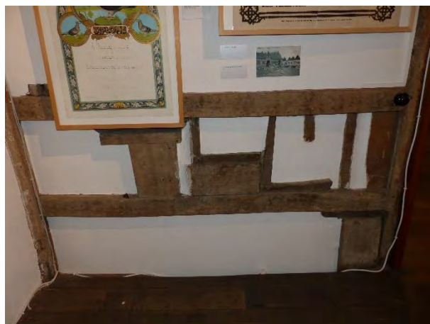
Figuur 344 (links) en Figuur 345 (rechts) klooster, 1.04: Vakwerkwand tussen vertrek en traphal (AS, 17.10.2023)
