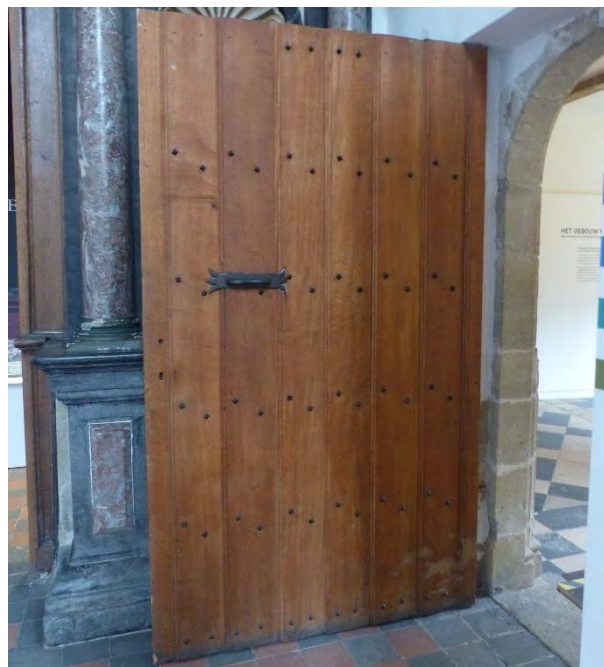
Figuur 141 (links) en Figuur 142 (rechts) kapel: Opgeklampte eikenhouten deur (AS, 17.10.2023)
