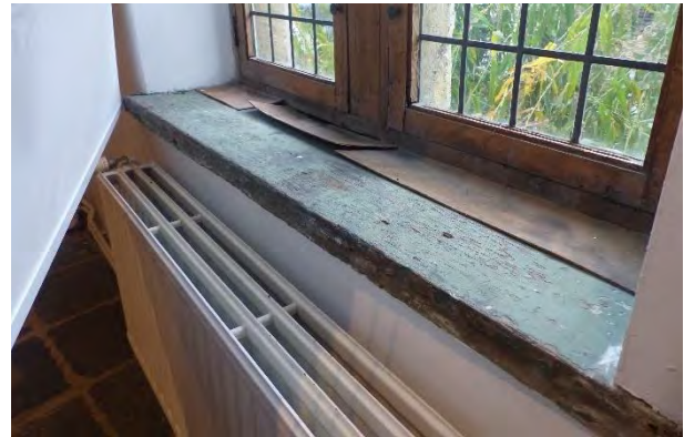
Figuur 459 (links) en Figuur 460 (rechts) klooster, 0.05: Houten venstertabletten met olijfgroene verweerde afwerkingslaag in de voormalige refter (0.05) (AS, 17.10.2023)
