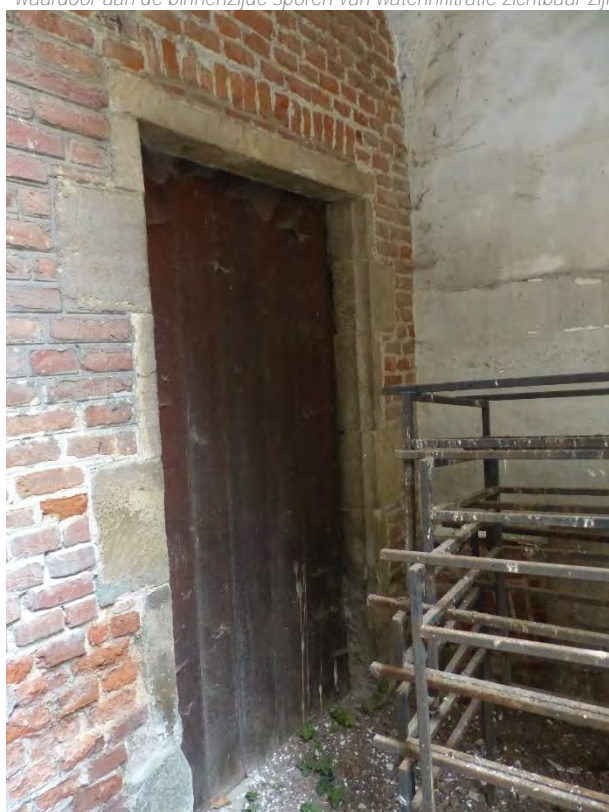
Figuur 250 (links) en Figuur 251 (rechts) Klooster, oostvleugel, Z: Vernislaag afgesleten, vooral aan de onderzijde (AS, 17.10.2023)
