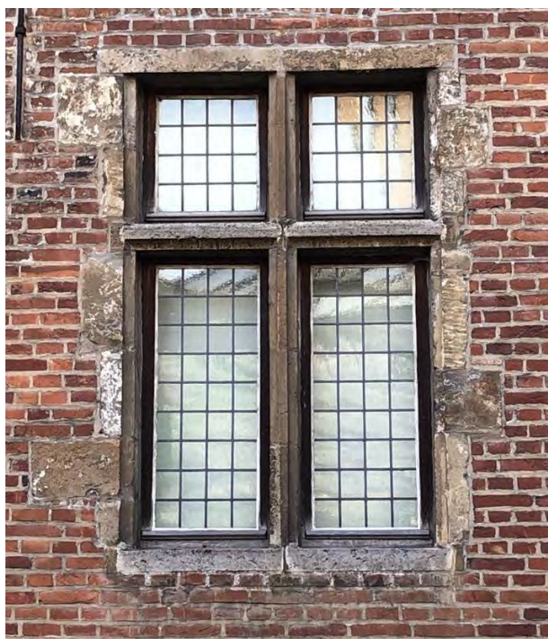
Figuur 256 (links) Klooster, noordvleugel, N: Kruisraam, afwerkingslaag volledig verweerd aan de buitenzijde (AS, 17.10.2023)
