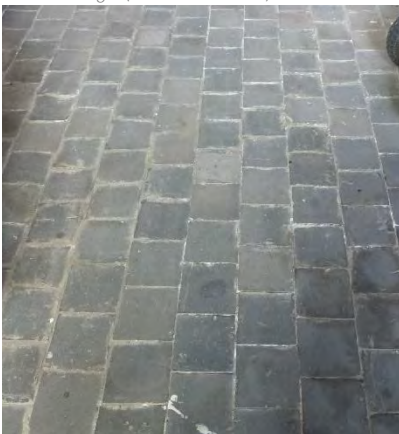
Figuur 365 (links) klooster, 0.07: Ongeglazuurde blauwgrijze aardewerktegels van circa 14 x 14 cm. De tegels zijn gelegd in banen met een verspringend patroon. Er komen afgesleten en gebarsten tegels voor. Lokaal zijn de tegels vervuild door verplekken (AS, 17.10.2023)
