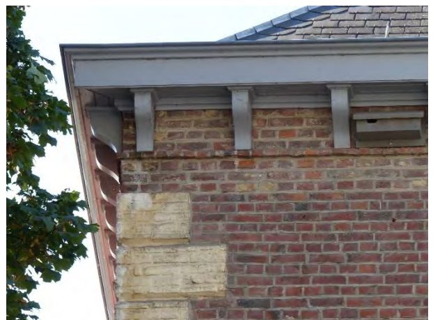
Figuur 617 derde ziekenzaal, O: Detail bakgoot (AS, 17.10.2023)
