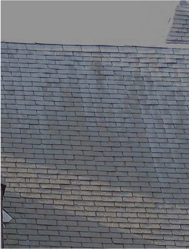
Figuur 663 (links) en Figuur 664 (rechts) neogotische vleugel noord, O: Grote zones hersteld met gehaakte leien. Loden slabben nok vervormd, beugels zitten los of staan open (AS, 17.10.2023)
