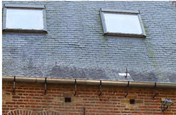
Figuur 515 (links) eerste ziekenzaal, N: Verschillende uitgeschoven en ontbrekende leien (AS, 17.10.2023)
