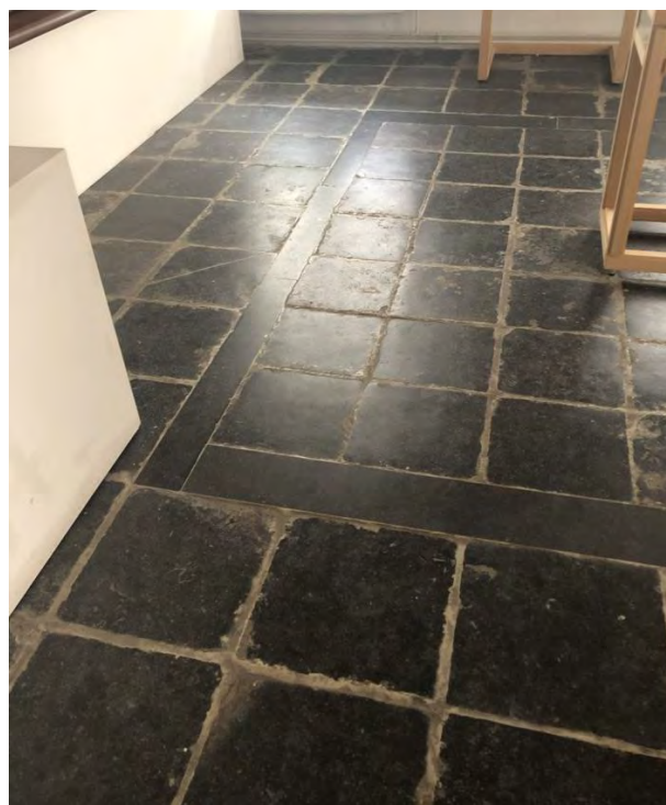
Figuur 358 (rechts) klooster, 0.05: Zoutuitbloeiingen ter hoogte van mortelvoegen (AS, 17.10.2023)
