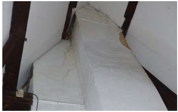
Figuur 285 (links) klooster, 2.02: Barst in de schouw van de oostvleugel, vermoedelijk structureel (AS, 17.10.2023)
