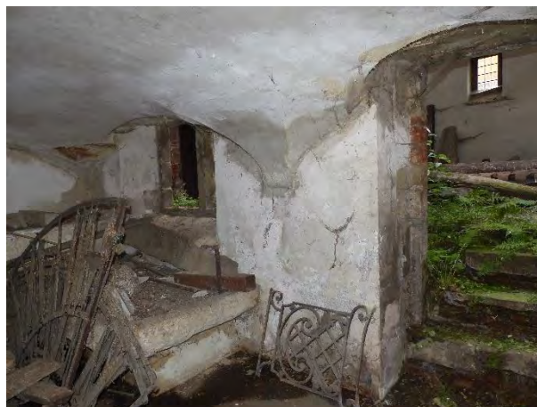
Figuur 222 (rechts) Galerij, broederskelder: Gepleisterd gewelf in de kelder staan zichtbaar nat (AS, 17.10.2023)
