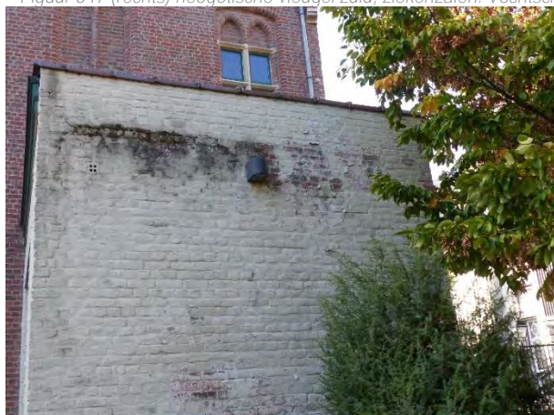
Figuur 648 (links) en Figuur 649 (rechts) neogotische vleugel zuid, pastorie, O: Vochtschade aanbouw (AS, 17.10.2023)
