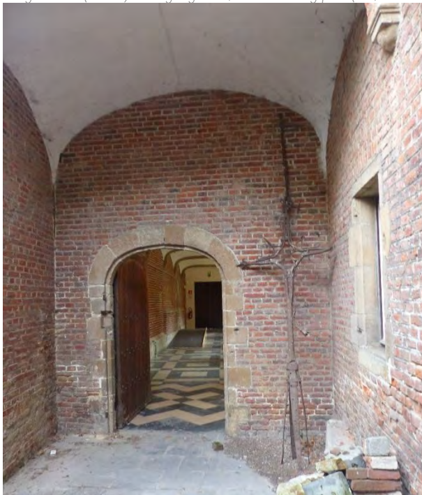
Figuur 199 (links) en Figuur 200 (rechts) Pandgang zuid, O: De kalkzandstenen negblokken van de toegang naar pandgang zuid vertonen verschillende lacunes. Het voegwerk is verweerd. De duimen van het geheng van de oude deur zijn nog aanwezig en zijn gecorrodeerd. Verschillende herstellingen met een ander type baksteen. De onderzijde van de pandgang is afgewerkt met een gepleisterd kruisribgewelf (AS, 17.10.2023)
