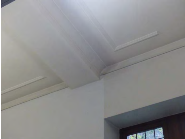
Figuur 552 (links) en Figuur 553 (rechts) eerste ziekenzaal, 0.32: Detail plafondafwerking. De plafondafwerking dateert van na de aanpassingswerken aan de zoldervloer begin jaren 1980 (AS, 17.10.2023)
