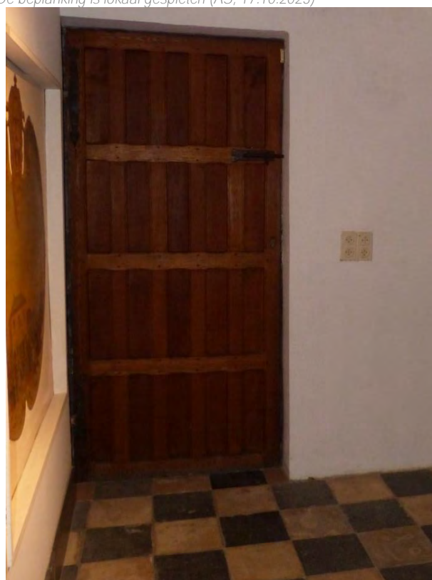
Figuur 250 (links) en Figuur 251 (rechts) Klooster, oostvleugel, Z: Vernislaag afgesleten, vooral aan de onderzijde (AS, 17.10.2023)
