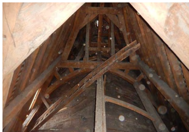
Figuur 106 (links) kapel, dakstructuur: Loopplanken vol houtafval (Monumentenwacht, 2021)
