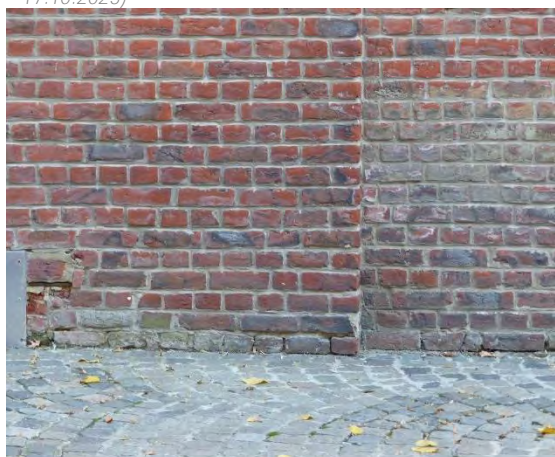
Figuur 633 (links) neogotische vleugel zuid, W: Schade door opstijgend vocht ter hoogte van overgang tussen pastorie en vijfde ziekenzaal en gekaleide plint van de ziekenzalen (AS, 17.10.2023)
