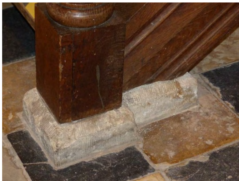
Figuur 350 (links) klooster, 0.08: Beschadigingen vloer door vocht en ingesloten verontreinigingen (AS, 17.10.2023)
