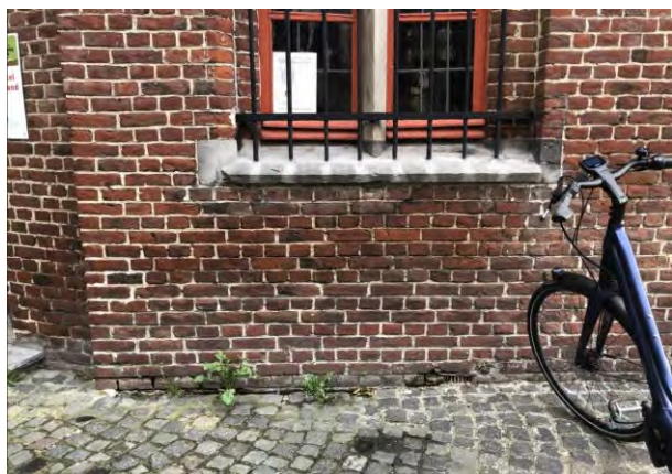
Figuur 631 (links) neogotische vleugel noord, W: Schade door opstijgend vocht, vervuild metselwerk en gebarsten dorpel (AS, 17.10.2023)
