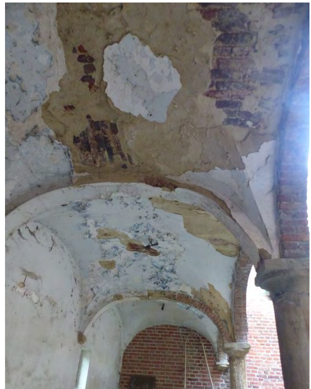
Figuur 203 (links) en Figuur 204 (rechts) Galerij, galerij: Detail verwerking kalkzandstenen kolommen en pleisterwerk gewelven en westgevel (AS, 17.10.2023)
