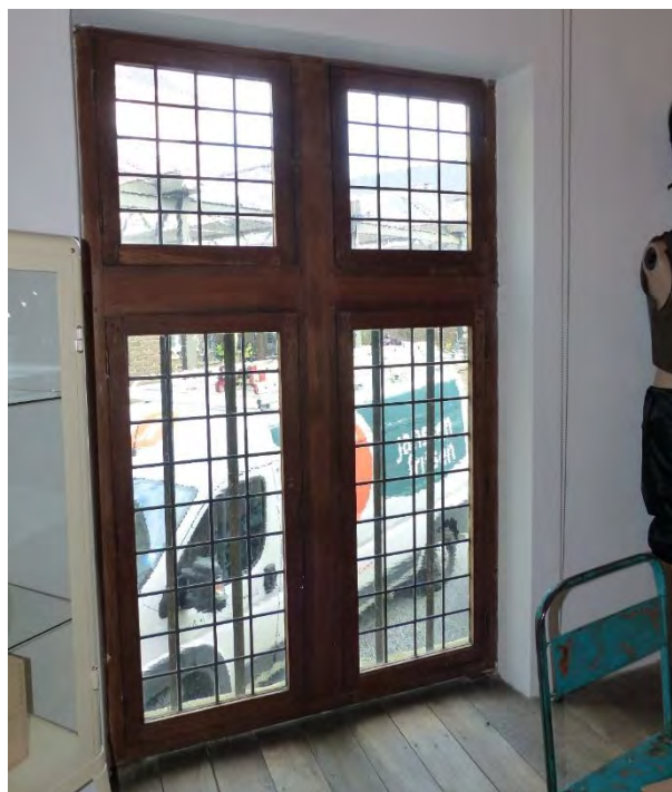
Figuur 256 (links) Klooster, noordvleugel, N: Kruisraam, afwerkingslaag volledig verweerd aan de buitenzijde (AS, 17.10.2023)
