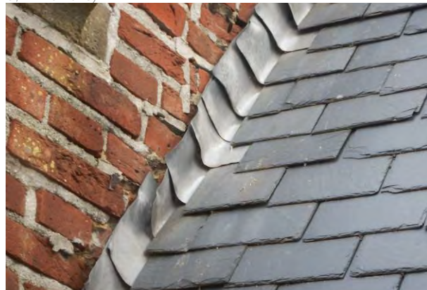
Figuur 517 (links) eerste ziekenzaal, N(W): Aansluiting van het dak met de westgevel van de kapel (Monumentenwacht, 2021)
