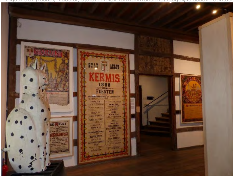
Figuur 340 (links) klooster, 1.01: Vakwerkwand tussen vertrek en traphal. De zone boven de deur is niet bepleisterd en bestaat uit verticale vitsen waartegen leem en stro zijn aangebracht. In de leemlaag zijn afdrucken van bakstenen aanwezig (AS, 17.10.2023)
