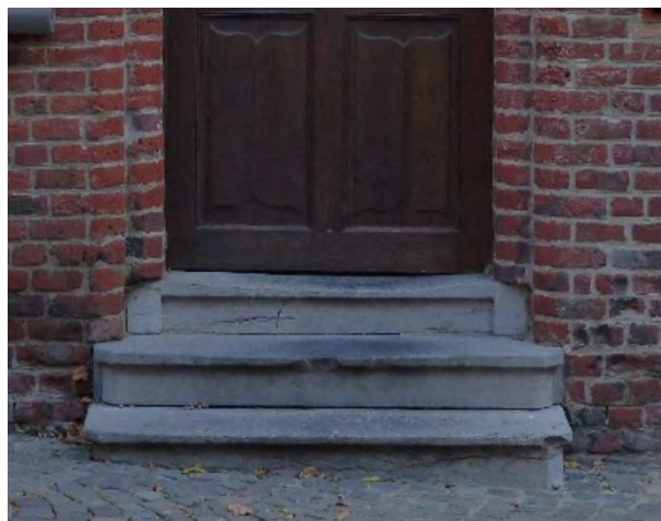
Figuur 652 (links) neogotische vleugel noord, W: Vernieuwde dorpels, waarvan één hoek is afgebroken (AS, 17.10.2023)
