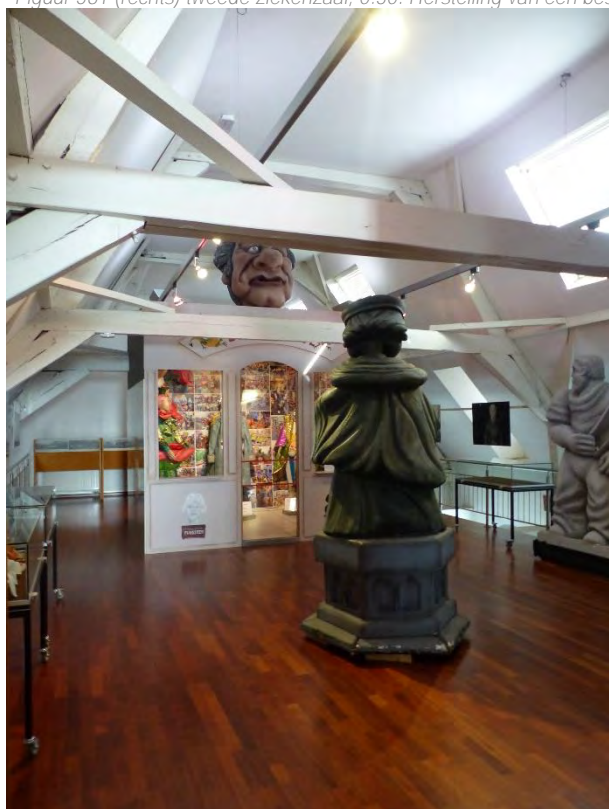
Figuur 582 (links) tweede ziekenzaal, 1.30: Historisch dakspant met verschillende vervangingen (AS, 17.10.2023)
