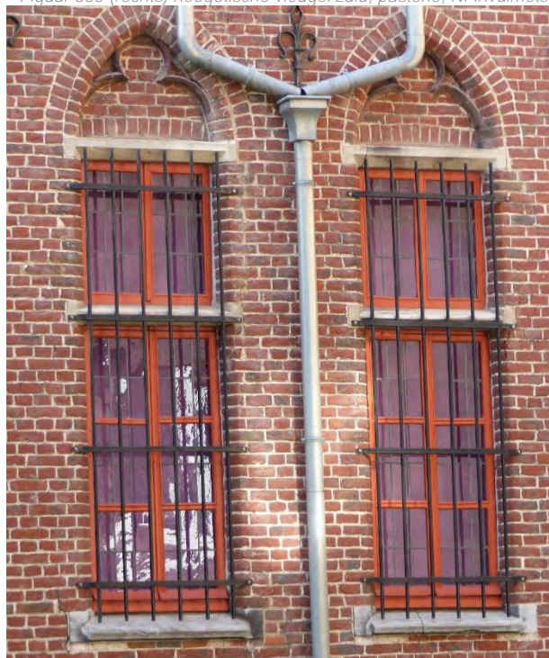
Figuur 636 (links) neogotische vleugel noord, O: Zoutuitbloeiingen t.h.v. regenpijp (AS, 17.10.2023)
