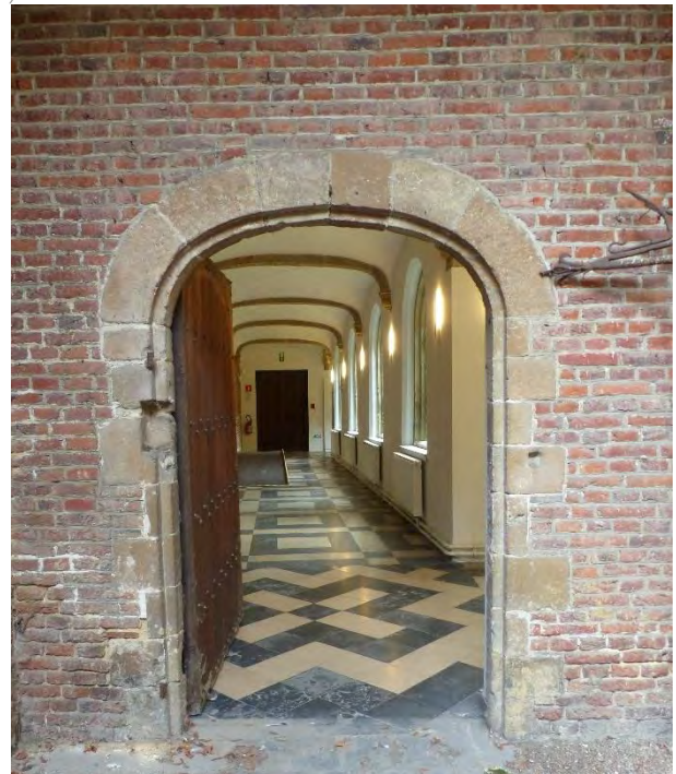
Figuur 199 (links) en Figuur 200 (rechts) Pandgang zuid, O: De kalkzandstenen negblokken van de toegang naar pandgang zuid vertonen verschillende lacunes. Het voegwerk is verweerd. De duimen van het geheng van de oude deur zijn nog aanwezig en zijn gecorrodeerd. Verschillende herstellingen met een ander type baksteen. De onderzijde van de pandgang is afgewerkt met een gepleisterd kruisribgewelf (AS, 17.10.2023)
