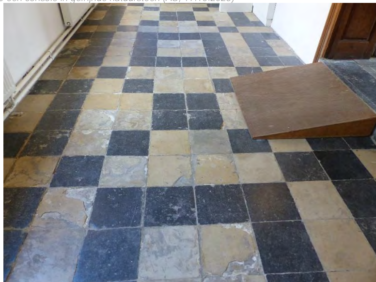
Figuur 352 (links) klooster, 0.09 (N): Pathologie natuurstenen vloer pandgang noord (AS, 17.10.2023)
