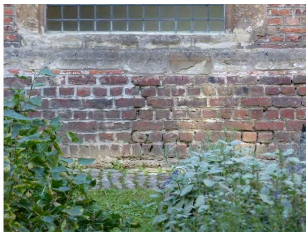
Figuur 189 (links) Pandgang zuid, N: Muurvaren tussen verweerde voegen van de plint (AS, 17.10.2023)
