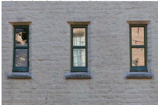
Figuur 656 (links) neogotische vleugel zuid, trappenhuis, N: Verweerde raamdorpels (AS, 17.10.2023)
