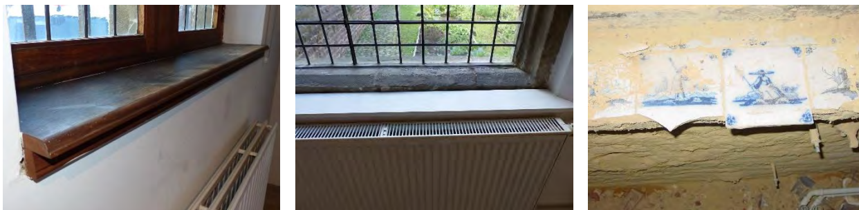
Figuur 463 (links) klooster, 0.01: Afgeronde houten venstertablet (AS, 17.10.2023)
