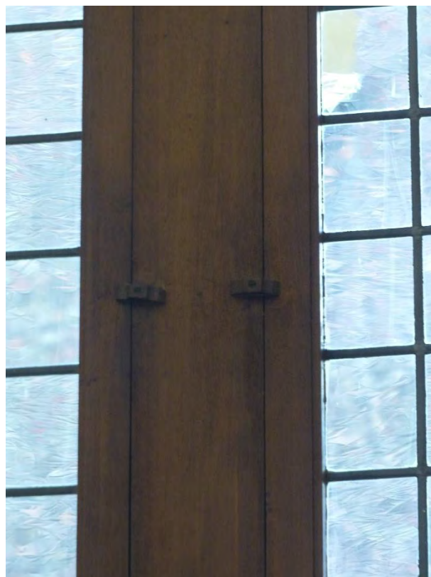
Figuur 541 (links) en Figuur 542 (rechts) eerste ziekenzaal, N: Dubbele vleugel en detail sluitwerk (AS, 17.10.2023)
