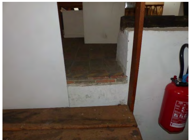
Figuur 373 (links) klooster, 2.01: Ongeglazuurde rode en grijsblauwe aardewerktegels in ruitpatroon, vermoedelijk origineel. Sterk vervuild. Er komen afgebrokkelde en afgesleten tegels voor (AS, 17.10.2023)
