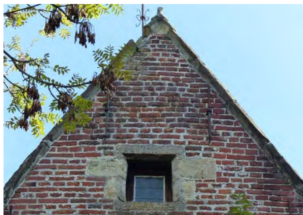
Figuur 88 (links) en Figuur 89 (rechts) kapel, W: Detail puntgevel. Verweerd voegwerk en gecorrodeerde gevelankers. Verweerde dekstenen (AS, 17.10.2023)
