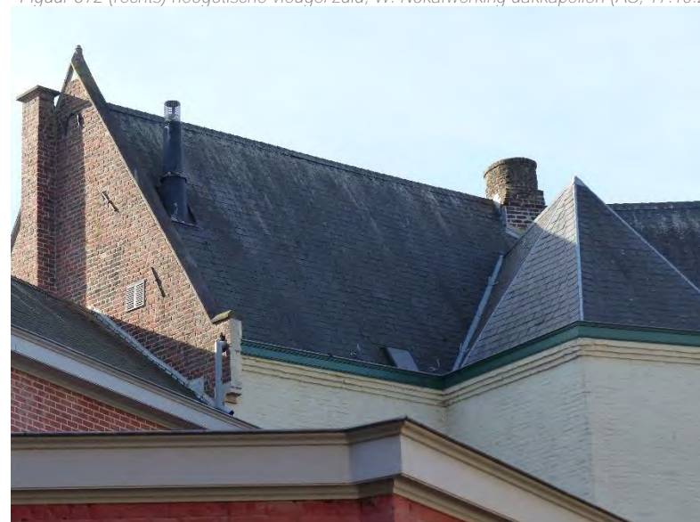
Figuur 673 (links) neogotische vleugel zuid, vierde ziekenzaal en trappenhuis, N: Aansluiting kilgoten en hoekkepers (AS, 17.10.2023)
