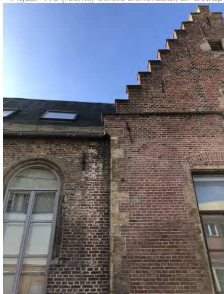
Figuur 497 (links) eerste ziekenzaal, O: Vervuiling metselwerk oostgevel (AS, 17.10.2023)
