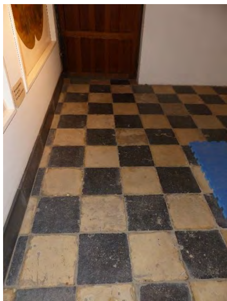
Figuur 350 (links) klooster, 0.08: Beschadigingen vloer door vocht en ingesloten verontreinigingen (AS, 17.10.2023)
