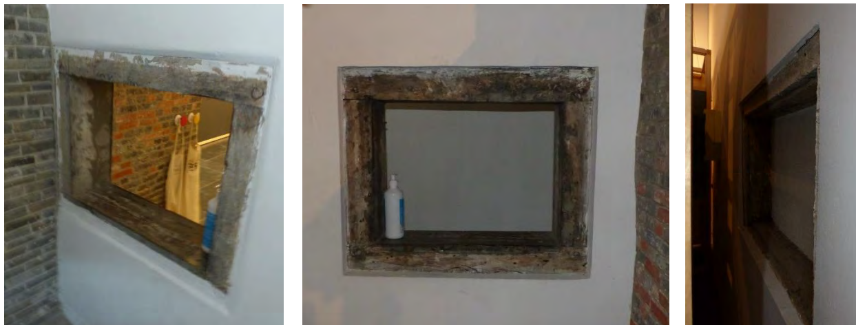
Figuur 450 (links) klooster, 0.05 en Figuur 451 (midden) klooster, 0.04: Houten kader rond opening in muur (AS, 17.10.2023) Figuur 452 (rechts) klooster, 0.04: Houten kader rond opening in muur naar vertrek 0.02 (AS, 17.10.2023)
