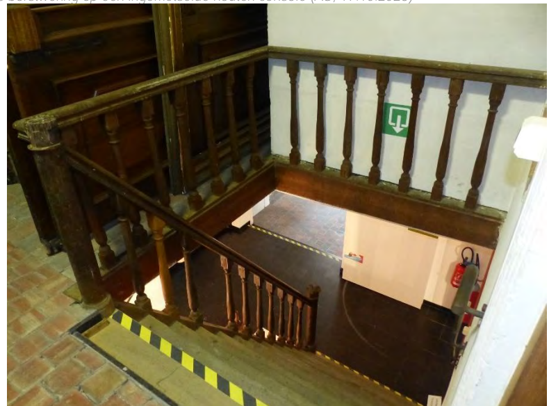
Figuur 419 (links) klooster, 1.08: De aansluiting tussen de trap naar de eerste verdieping en de zoldertrap loopt niet door (AS, 17.10.2023)
