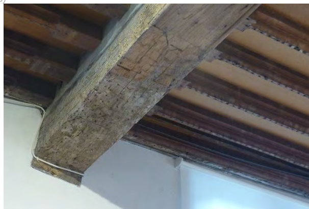
Figuur 315 (rechts) klooster, 0.05: Moerbalk met ontbrekend sleutelstuk. Gotische kinderbalken met peerkraalmotief met sporen van verwijderde rinkellatten (AS, 17.10.2023)
