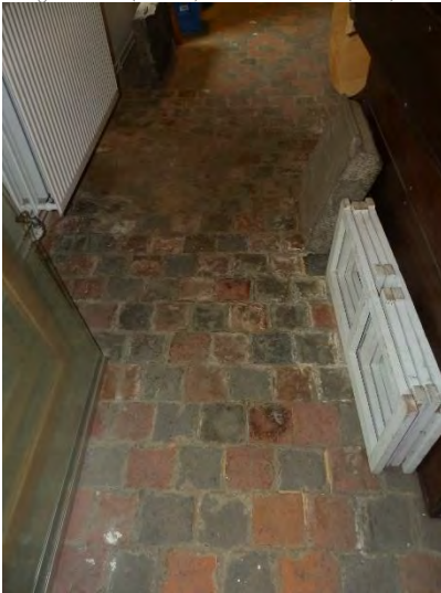
Figuur 370 (links) klooster, 1.09 (W): Aardewerktegels gerecupereerd uit het hof Schockaert te Erondegem en geplaatst in 1959. De randen zijn afgebrokkeld en lokaal komt schade door een waterlek voor (AS, 17.10.2023)
