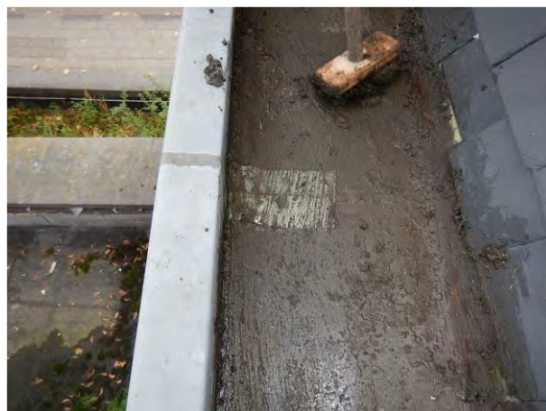
Figuur 521 (linksboven) eerste ziekenzaal, N(O): Putcorrosie ter hoogte van de afvoer van de bakgoot (Monumentenwacht, 2021)
