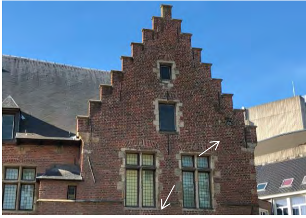
Figuur 172 (links) Klooster, noordvleugel, O: Biodeterioratie topgevel. Kalkzandstenen waterlijst loopt niet door (AS, 17.10.2023) Figuur 173 (rechts) Klooster, noordvleugel, W: Detail metselwerkverband, herstellingen en schadepatroon (AS, 17.10.2023)
