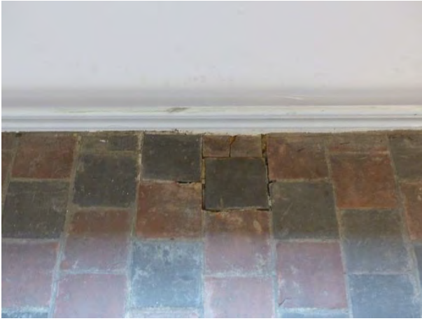
Figuur 368 (links) klooster, 1.09 (O): Vervuilde aardewerktegels. Losgekomen voegen (AS, 17.10.2023)
