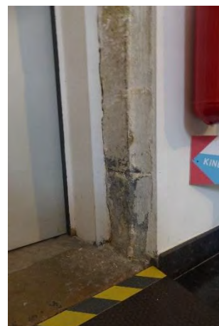
Figuur 549 (links), Figuur 550 (midden) en Figuur 551 (rechts) eerste ziekenzaal, 0.31: Kalkzandstenen deuromlijsting tussen ziekenzaal en kapel (AS, 17.10.2023)
