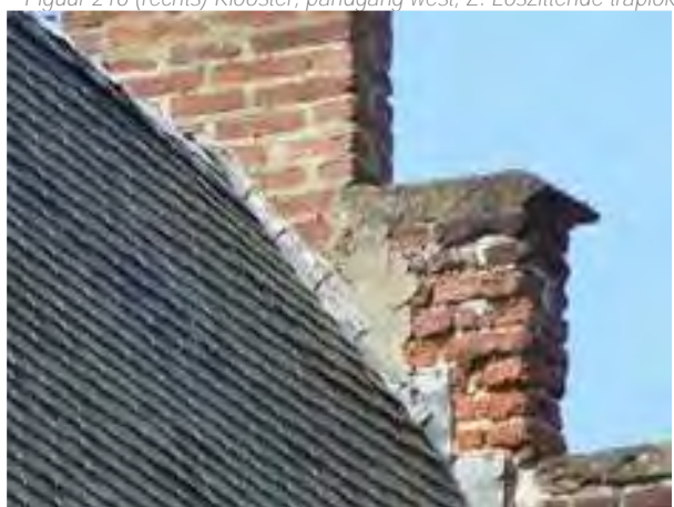
Figuur 217 (links) Klooster, noordvleugel, W: Ontbrekende traploketten ter hoogte van de aansluiting van de nok en de trapgevel (Monumentenwacht, 2021)
