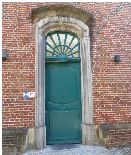
Figuur 504 (links) eerste ziekenzaal, W: Arduinen deuromlijsting (AS, 17.10.2023)
