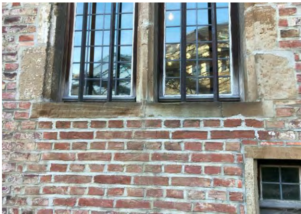
Figuur 168 (links) Klooster, noordvleugel, N: Gebarsten dorpel (AS, 17.10.2023)
