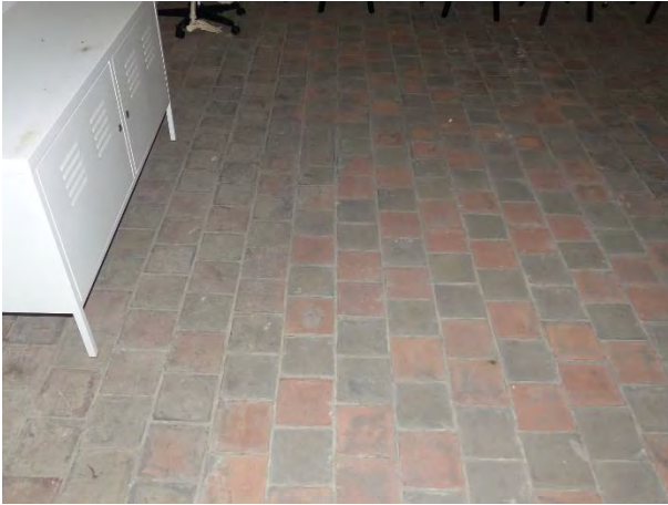
Figuur 375 (links) en Figuur 376 (rechts) klooster, 2.02: Ongeglazuurde rode en grijsblauwe aardewerktegels in ruitpatroon, vermoedelijk origineel. Sterk vervuild. Er komen afgebrokkelde en afgesleten tegels voor (AS, 17.10.2023)
