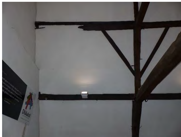
Figuur 245 (rechts) Klooster, oostvleugel: Aangetaste vloering in zuidwesthoek (AS, 17.10.2023)
