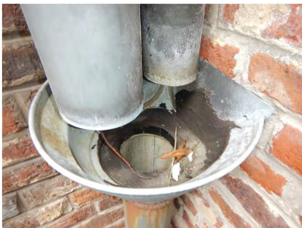
Figuur 225 (links) Pandgang west, N: Vergaarbak hangt scheef (Monumentenwacht, 2021)
