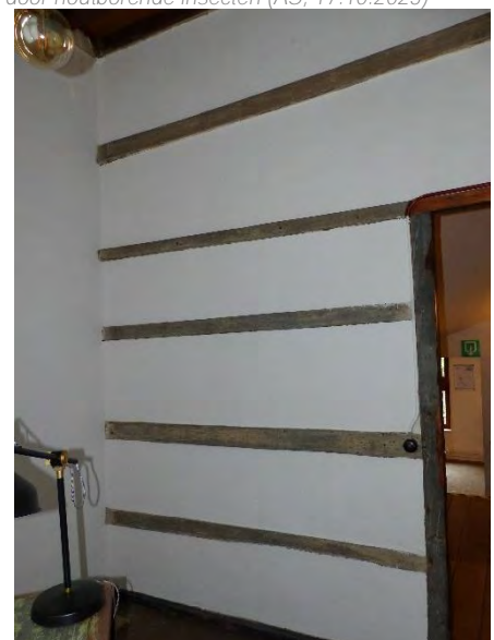
Figuur 340 (links) klooster, 1.01: Vakwerkwand tussen vertrek en traphal. De zone boven de deur is niet bepleisterd en bestaat uit verticale vitsen waartegen leem en stro zijn aangebracht. In de leemlaag zijn afdrucken van bakstenen aanwezig (AS, 17.10.2023)
