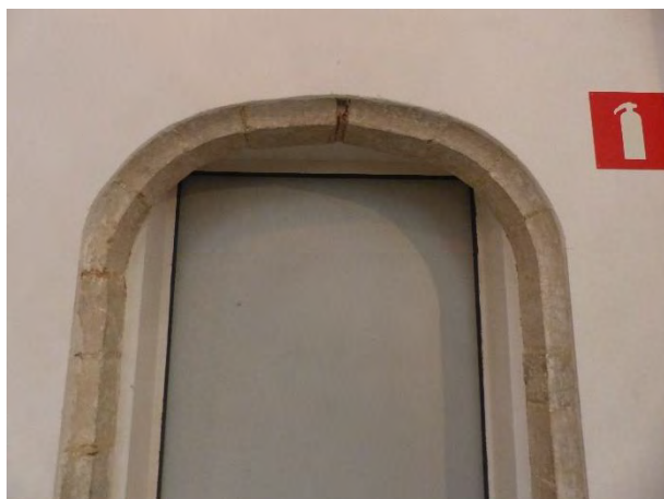
Figuur 549 (links), Figuur 550 (midden) en Figuur 551 (rechts) eerste ziekenzaal, 0.31: Kalkzandstenen deuromlijsting tussen ziekenzaal en kapel (AS, 17.10.2023)
