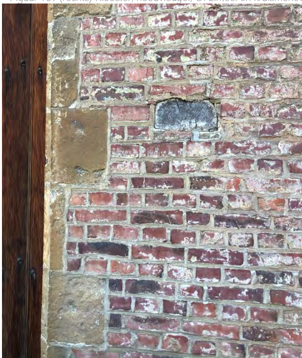
Figuur 170 (links) Klooster, noordvleugel, N: Ingemetselde houten balk naast toegangsdeur (AS, 17.10.2023)
