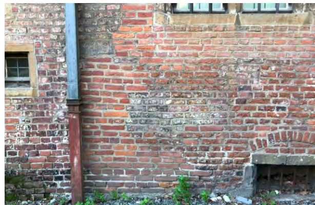
Figuur 166 (links) Klooster, noordvleugel, N: Metselwerk van de plint is sterk beschadigd. Door aanwezigheid van vocht treedt er lokaal mosvorming op (AS, 17.10.2023)
