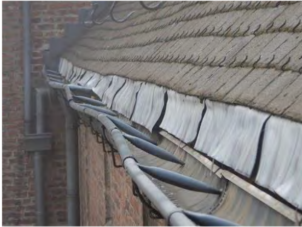
Figuur 223 (links) Klooster, pandgang west, N: De mastgoot is gekanteld, waardoor het daklood niet meer in de goot komt (Monumentenwacht, 2021)
