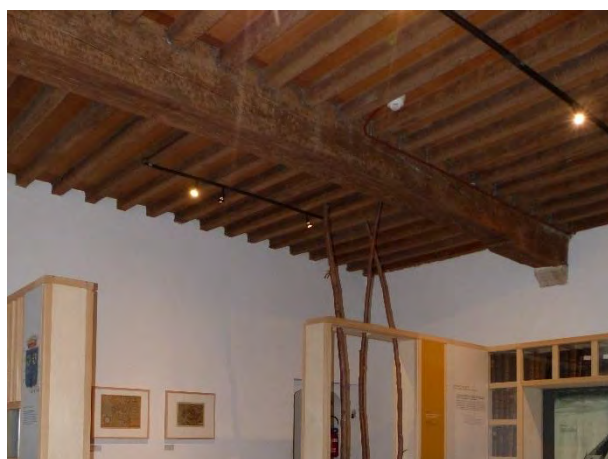
Figuur 310 (links) klooster, 0.01: Zichtbare roostering in noordvleugel (AS, 17.10.2023)
