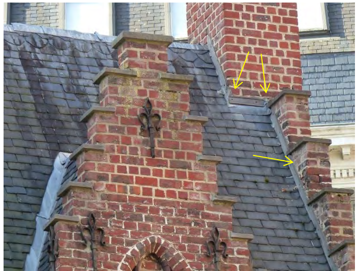
Figuur 665 (links) neogotische vleugel noord, O: Nok- en hoekkeperafwerking (AS, 17.10.2023)
