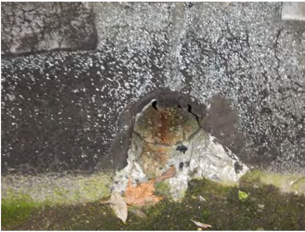
Figuur 227 (linksboven) Pandgang zuid: Sterk verweerde tapbuis in plat dak (Monumentenwacht, 2021)
