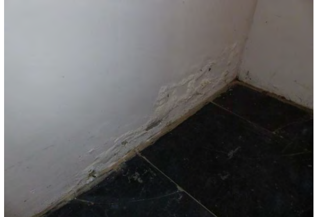
Figuur 290 (links) klooster, -1.05: Zoutuitbloeiingen op cementering en barsten ten gevolge van waterdoorslag. De andere kelders konden niet bezocht worden, maar hebben wellicht een gelijkaardig schadebeeld (AS, 17.10.2023)
