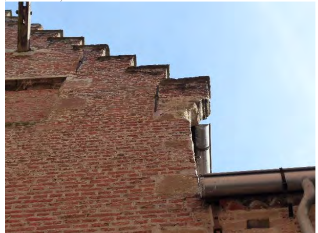
Figuur 176 (links) Klooster, noordvleugel, W: Gepekte natuurstenen plint. Lacunes in metselwerk (AS, 17.10.2023) Figuur 177 (rechts) Klooster, noordvleugel, W: Natuurstenen dekstenen en consoles verweerd (AS, 17.10.2023)
