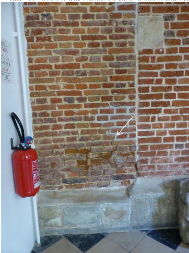
Figuur 129 (links) kapel, N: Verweerd voegwerk door vocht en barst ter hoogte van grafkelder (AS, 17.10.2023)
