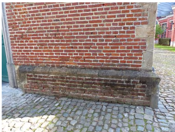
Figuur 492 (links) eerste ziekenzaal, N: Vocht- en vorstschade aan de plint van de noordgevel (AS, 17.10.2023)
