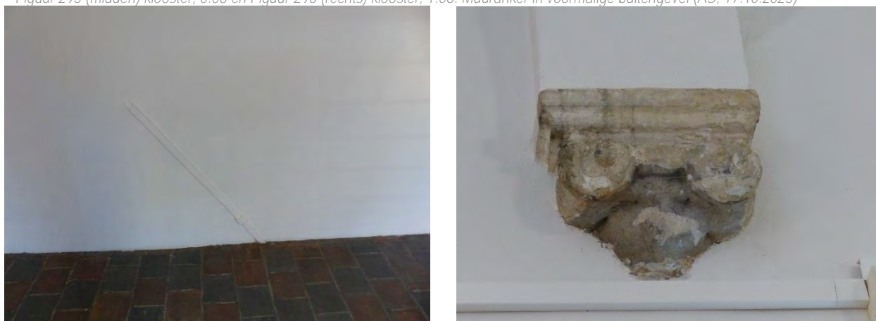
Figuur 297 (links) klooster, 1.09 (N): Muuranker in de voormalige buitengevel van de noordvleugel (AS, 17.10.2023)
