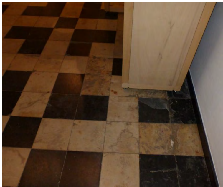
Figuur 348 (links) en Figuur 349 (rechts) klooster, 0.01: Beschadiging vloer door vocht en verontreiniging door gecorrodeerde metalen objecten (AS, 17.10.2023)
