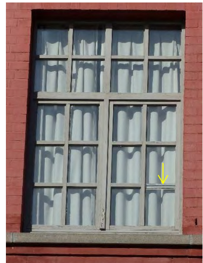
Figuur 620 (midden) en Figuur 621 (rechts) derde ziekenzaal, Z: Toplaag schilderwerk staat mager, waardoor het hout verweerd is. Lokaal ontbreekt een roede (AS, 17.10.2023)
