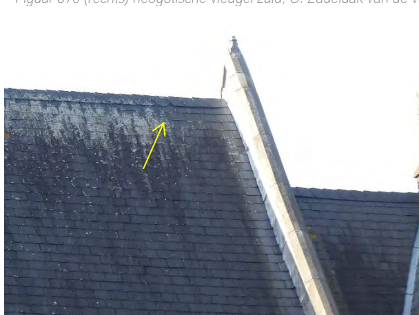
Figuur 671 (links) neogotische vleugel zuid, O: Uitgeschoven noklei (AS, 17.10.2023)
