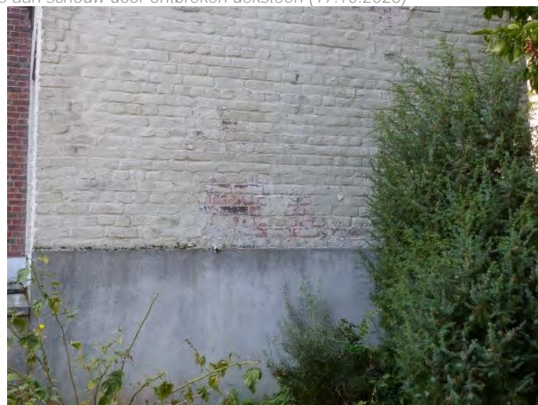
Figuur 648 (links) en Figuur 649 (rechts) neogotische vleugel zuid, pastorie, O: Vochtschade aanbouw (AS, 17.10.2023)
