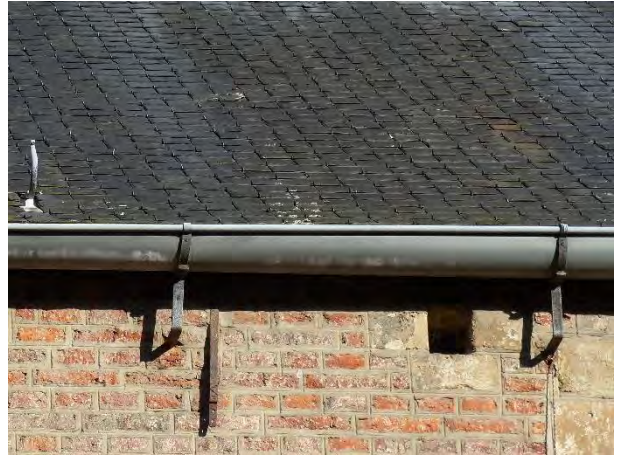
Figuur 223 (links) Klooster, pandgang west, N: De mastgoot is gekanteld, waardoor het daklood niet meer in de goot komt (Monumentenwacht, 2021)
