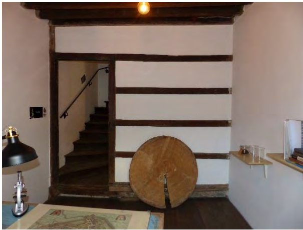
Figuur 336 (links) klooster, 0,5.02: Vakwerkwand tussen vertrek en traphal (AS, 17.10.2023)
