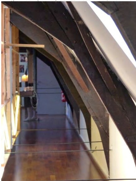
Figuur 533 (links) eerste ziekenzaal, 1.31: Dakstructuur verankerd met ijzeren latten aan gevel (AS, 17.10.2023)
