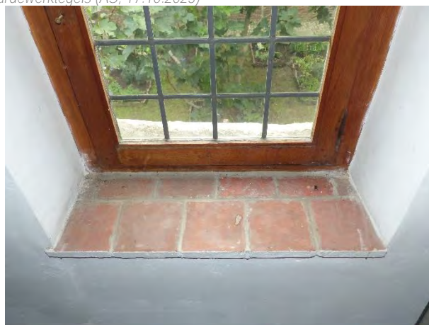
Figuur 469 (rechts) klooster, 1.08: Verflekken op de venstertablet in aardewerktegels (AS, 17.10.2023)
