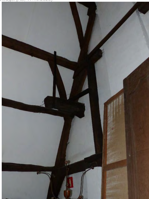
Figuur 238 (links) en Figuur 239 (rechts) Klooster, noordvleugel: Dakstructuur met ingeklemde takel in westgevel (AS, 17.10.2023)
