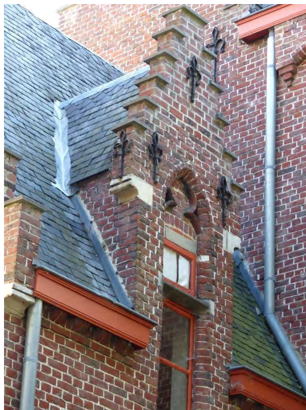
Figuur 667 (links) neogotische vleugel noord, aanbouw, O: Aansluiting met opgaand metselwerk met loden slabben en gecorrodeerde krammen. Lokaal ontbreken leien (AS, 17.10.2023)
