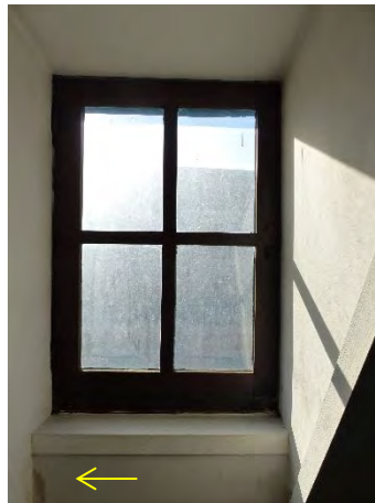
Figuur 554 (links) eerste ziekenzaal, 0.32: Schade door opstijgend vocht (AS, 17.10.2023)
