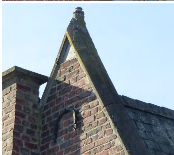
Figuur 658 (links) neogotische vleugel zuid, knik tussen ziekenzalen, Z: Verwering dekstenen (AS, 17.10.2023)
