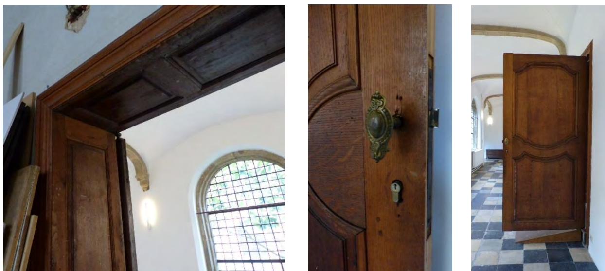
Figuur 438 (links), Figuur 439 (midden) en Figuur 440 (rechts) klooster, 0.07: Eikenhouten paneeldeur met messing beslag (AS, 17.10.2023)
