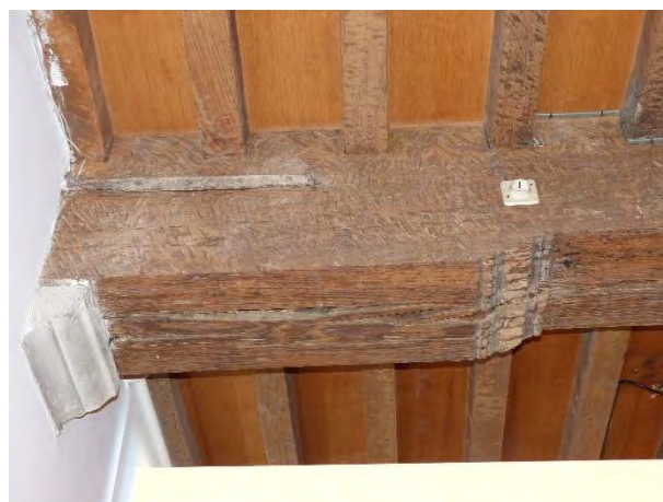
Figuur 311 (rechts) klooster, 0.01: De moerbalk met renaissancestische vormgeving is gespleten. Gecorrodeerde beugel (AS, 17.10.2023)
