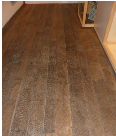
Figuur 377 (links) klooster, 0,5.02: Gebeitste eikenhouten planken (AS, 17.10.2023)
