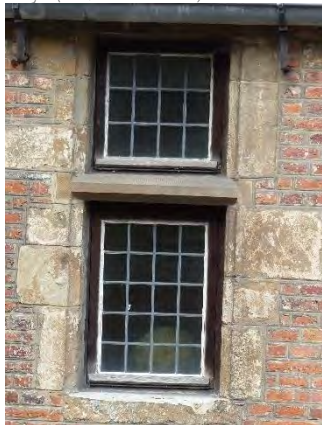
Figuur 264 (links) Klooster, pandgang west, O: Enkele vleugel met bovenlicht. Afwerkingslaag volledig verweerd (AS, 17.10.2023)
