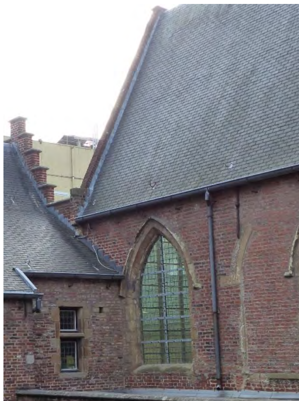
Figuur 84 (links) kapel, O: Vochtschade t.h.v. schouderstukken en vervuiling t.h.v. regenwaterafvoer (AS, 17.10.2023)
