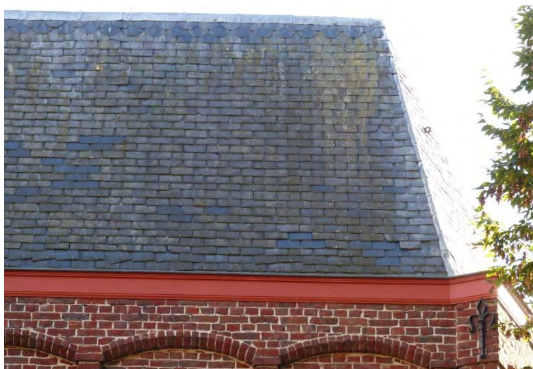
Figuur 661 (links) neogotische vleugel noord, N: Uitgeschoven leien (AS, 17.10.2023)
