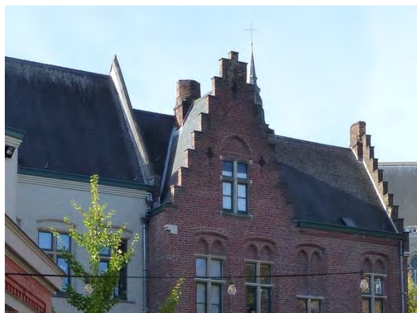
Figuur 669 (links) neogotische vleugel zuid, ziekenzalen en trappenhuis, N: Dakbedekking vervuild door uitlopen loodoxide (AS, 17.10.2023)
