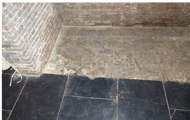
Figuur 359 (links) klooster, 0.04: Vloer in recente blauwe hardsteentegels (AS, 17.10.2023)
