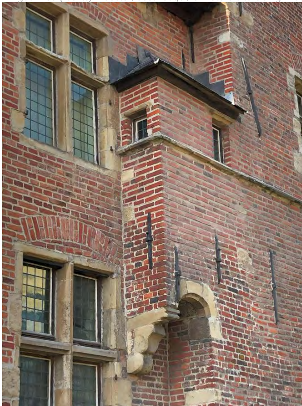
Figuur 181 (links) Klooster, oostvleugel, O: Metselwerk erker sterk vervuild en lokaal herstellingen met andere kleur baksteen. Kalf van het onderste kruismoneel (recent) vernieuwd (AS, 17.10.2023)
