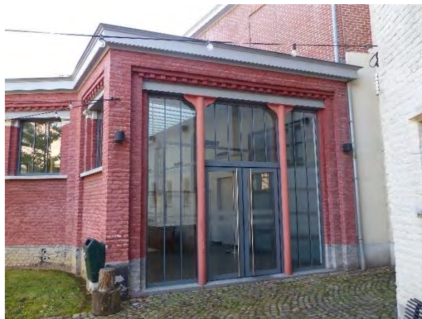
Figuur 609 (links) beeldengalerij, N: Detail metselwerk rond ramen. Lokaal lacunes in het parement (AS, 17.10.2023)
