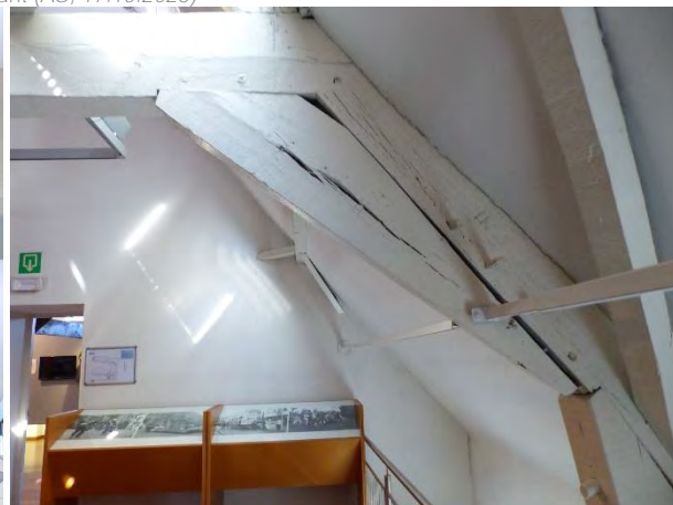
Figuur 584 (links) tweede ziekenzaal, 1.30: Barsten in hout door corrosie-expansie (AS, 17.10.2023)
