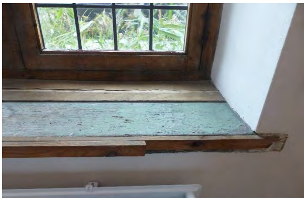
Figuur 459 (links) en Figuur 460 (rechts) klooster, 0.05: Houten venstertabletten met olijfgroene verweerde afwerkingslaag in de voormalige refter (0.05) (AS, 17.10.2023)
