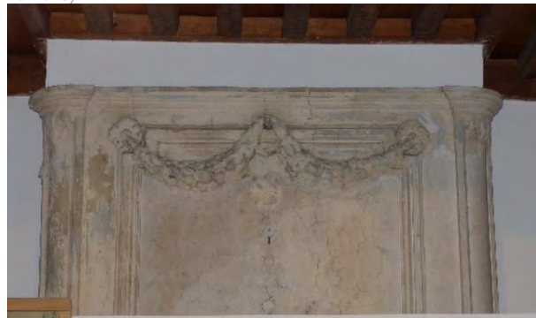
Figuur 386 (links) klooster, 0.07: Eenvoudig stucwerk dat op verschillende plaatsen scheuren vertoont. Vermoedelijk zit een grote oppervlakte pleisterwerk los (AS, 17.10.2023)
