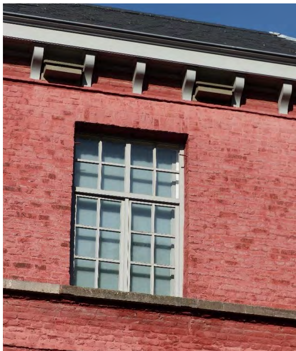
Figuur 611 (links) derde ziekenzaal, Z: Doorlopende natuurstenen dorpel op de verdieping is vernieuwd tot de achtste travee (AS, 17.10.2023)
