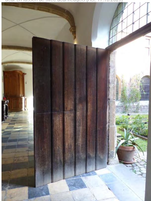
Figuur 254 (links) en Figuur 255 (rechts) Klooster, pandgang, O: Verweerde afwerkingslaag van de toegangsdeur tot de kloostertuin (AS, 17.10.2023)
