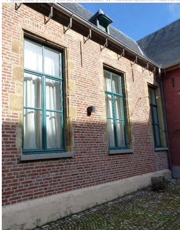
Figuur 506 (links) en Figuur 507 (rechts) eerste ziekenzaal, Z: Kalkzandstenen raamomlijstingen en plint (AS, 17.10.2023)
