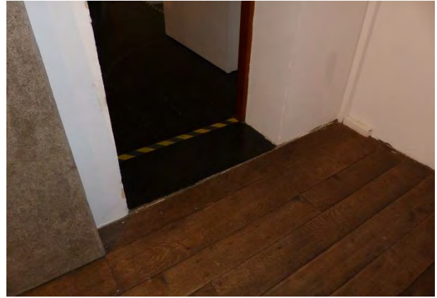
Figuur 362 (rechts) klooster, 1.08: Trede en tussendorpel in recente blauwe hardsteentegels (AS, 17.10.2023)
