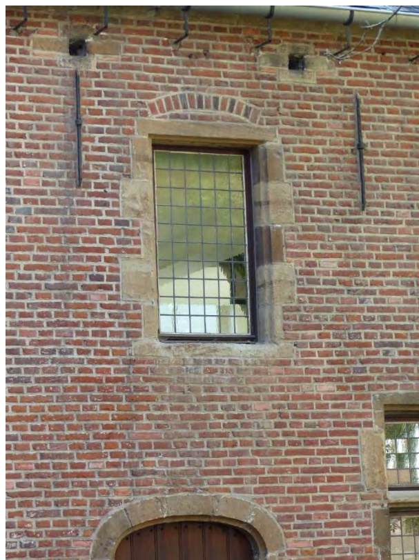
Figuur 500 (links) eerste ziekenzaal, N: Kalkzandstenen plint en deuroplijsting (AS, 17.10.2023)
