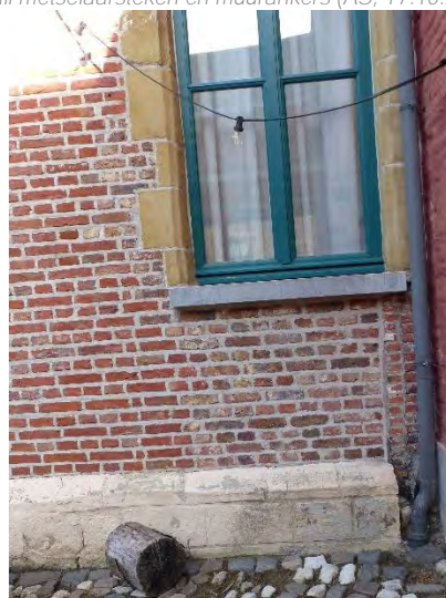
Figuur 494 (links) en Figuur 495 (midden) eerste ziekenzaal, Z: Pathologie plint zuidgevel (AS, 17.10.2023)
