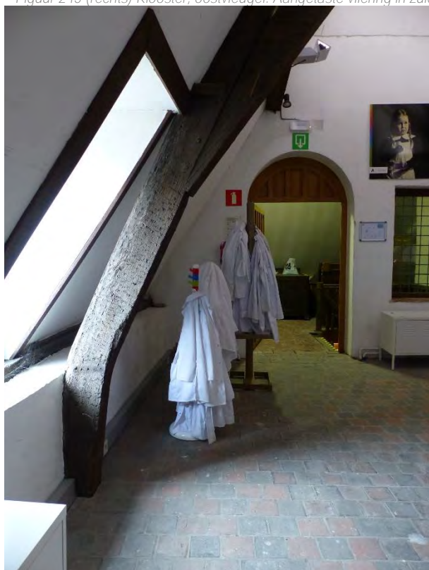
Figuur 246 (links) Klooster, oostvleugel: Gekromde kreupele stijl (AS, 17.10.2023)
