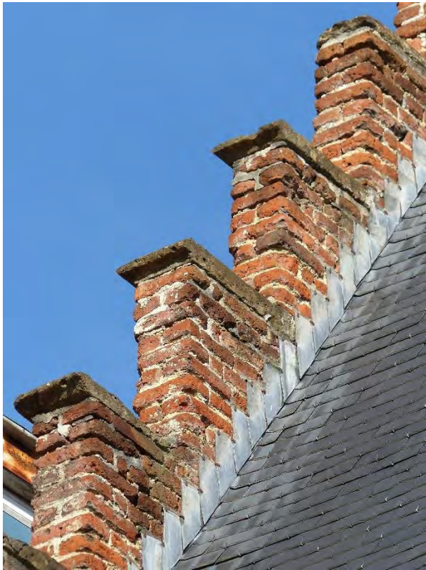
Figuur 174 (links) Klooster, noordvleugel, Z-W: Voegen topgevel (W) uitgespoeld (AS, 17.10.2023) Figuur 175 (rechts) Klooster, noordvleugel, W: Diverse bouwsporen (AS, 17.10.2023)
