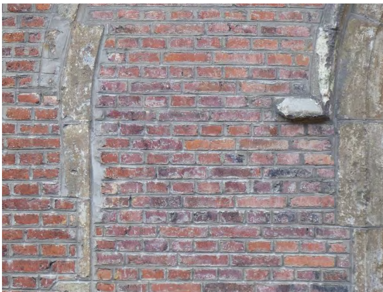
Figuur 90 (links) kapel, N: Natuurstenen raamomlijsting schilfert af. Herstellingen met cementmortel (AS, 17.10.2023)
