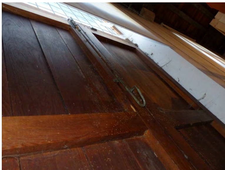
Figuur 248 (links) en Figuur 249 (rechts) Klooster, noordvleugel, N: Vernislaag afgesleten over de volledige oppervlakte van de deur, waardoor aan de binnenzijde sporen van waterinfiltratie zichtbaar zijn. De beplanking is lokaal gespleten (AS, 17.10.2023)
