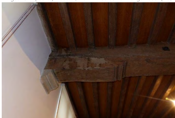
Figuur 318 (links) en Figuur 319 (rechts) klooster, 1.01: Oude (?) vochtschade aan de balkkoppen (AS, 17.10.2023)
