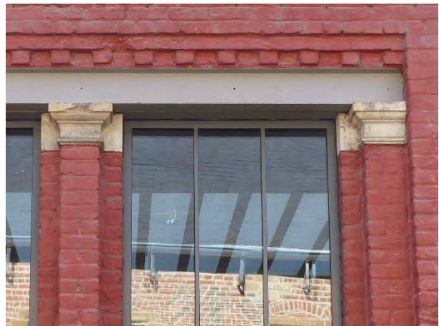
Figuur 613 (links) beeldengalerij, N: Lacune in arduinen dorpel t.h.v. eerdere herstelling (AS, 17.10.2023)
