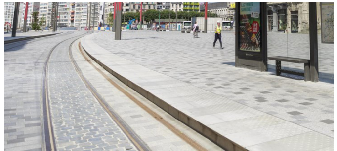
Afbeelding 73. Voorbeeld van een tramhalte met uniform materiaalgebruik (Opera Antwerpen)
