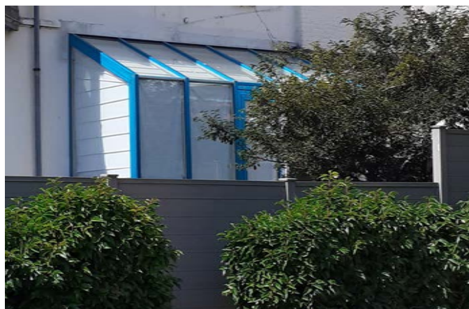
Afbeelding 56. Vernieuwde uitbouw in pvc
