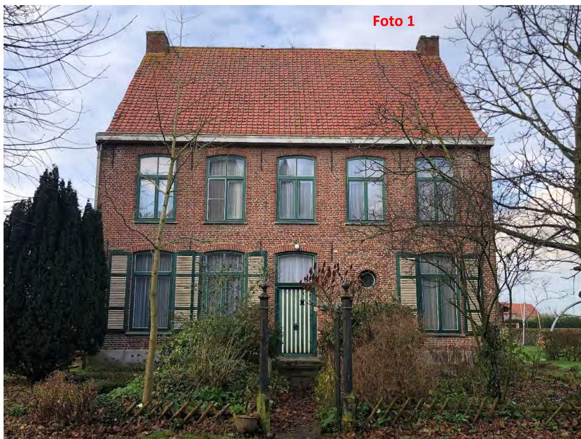
Foto boven: voorgevel
