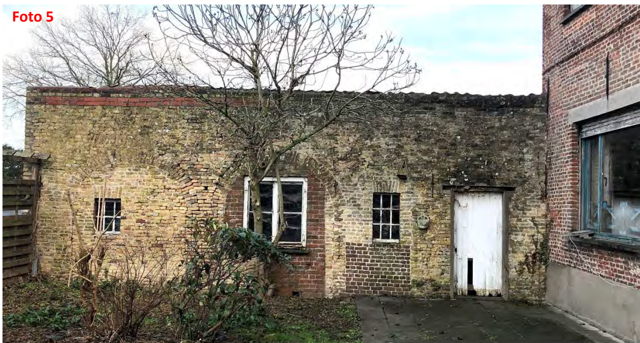
Foto boven: tuinzicht van noordelijke aanbouw
