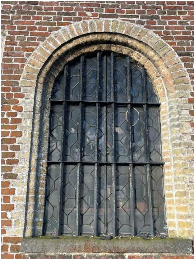
Foto's boven: glasramen van de sacristie met meer figuratieve veelhoekige vormen. Enkel glas zit met fijne mastiekrand vast in een metalen frame en is eerder zeldzaam.
