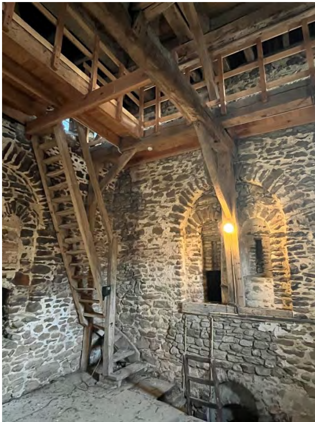
Nivo met dicht gemetselde romaanse raamopeningen. Trap naar bovenliggend nivo met houten rondgang
