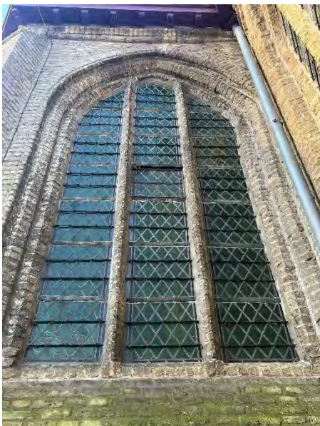
Foto links: raamopening aan noordzijde van het middenkoor. Het ontbrekende maaswerk is afwijkend tov de andere ramen. Sporen wijzen op afbraak van dit maaswerk.
