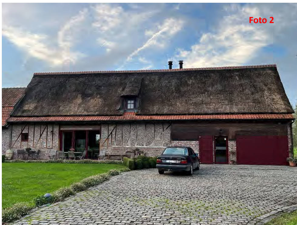
Foto boven: aangebouwde voormalige schuur tegen de woning
