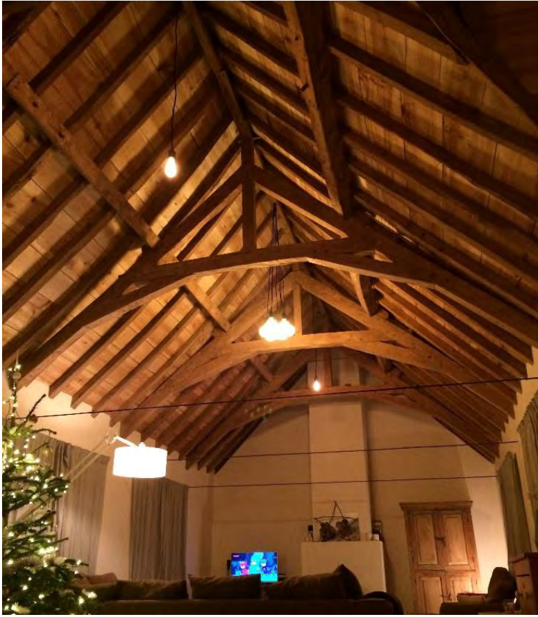
Foto boven: oorspronkelijke 3 identieke dakgebintes van noordelijk aangebouwd volume (winterkapel) met nog aanwezige metalen spankabels.
