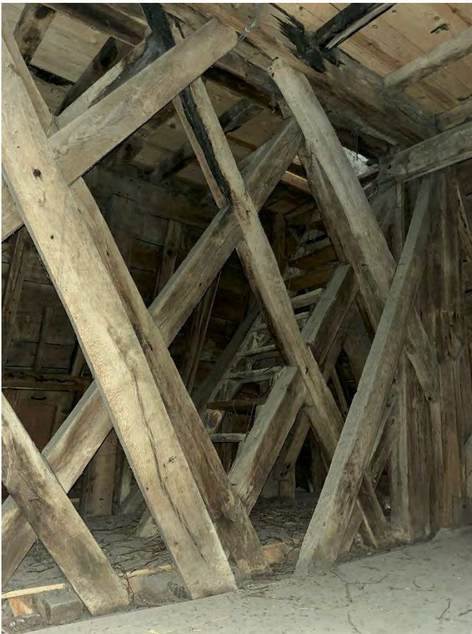
Nivo onder de klokkenstoel met diagonale steunstructuur voor bovenstaande klokkenstoel. Ontbrekende planken op kepers aan buitenzijde om inspectie mogelijk te maken.
