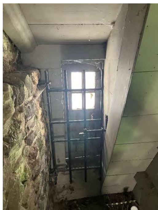
Toegangsdeurtjes naar daken met achterliggend opendraaiend traliewerk ter beveiliging
