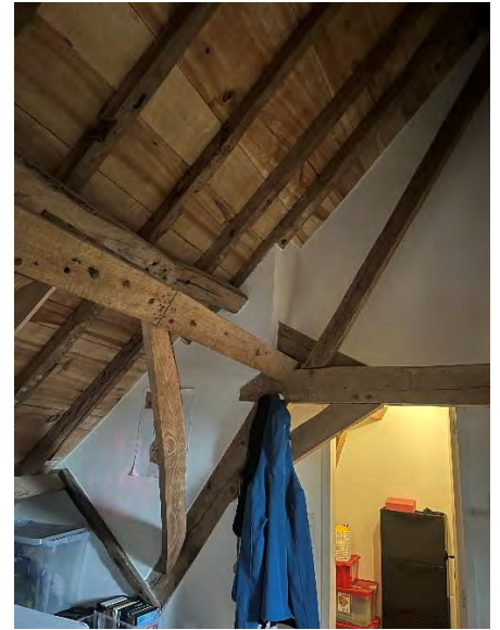
Foto boven: oorspronkelijke 3 identieke dakgebintes van noordelijk aangebouwd volume (winterkapel) met nog aanwezige metalen spankabels.
