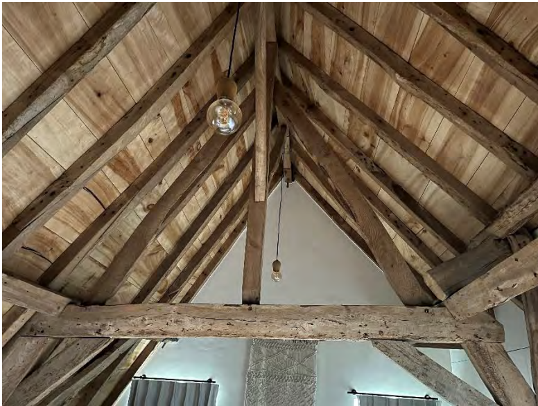
Foto boven: oorspronkelijke 3 identieke dakgebintes van noordelijk aangebouwd volume (winterkapel) met nog aanwezige metalen spankabels.
