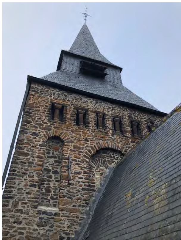
zicht op oostelijke torenzijde
