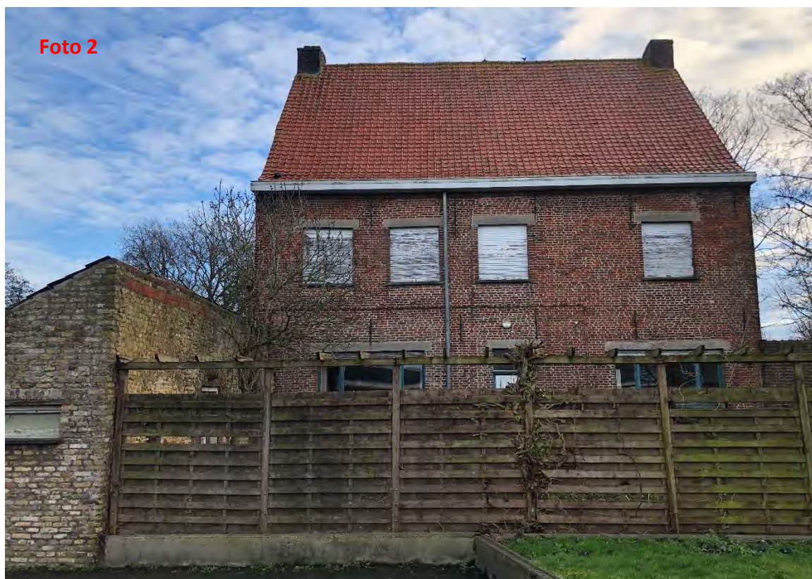
Foto boven: achtergevel
