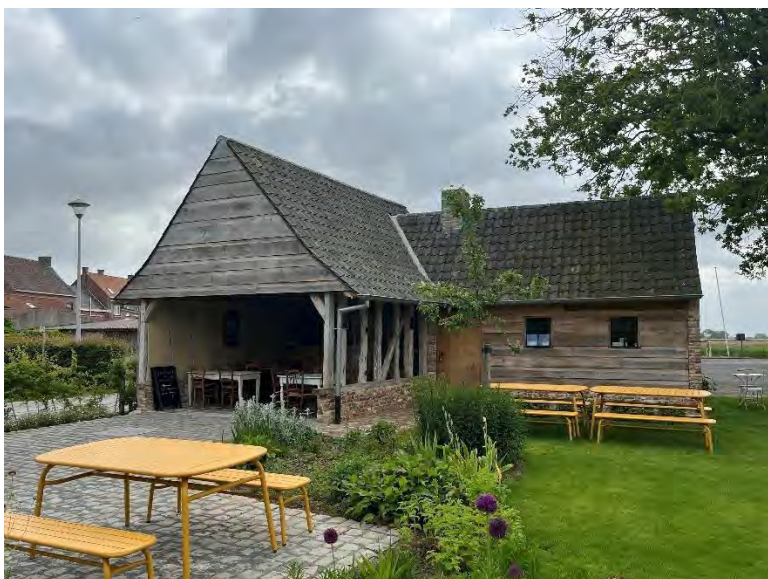
Bijgebouw op Haringeplein 5
