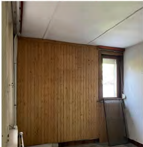
+00.06 bouwspoor achter recente planchetten; originele afwerkingen mogelijks aanwezig achter verlaagd plafond
