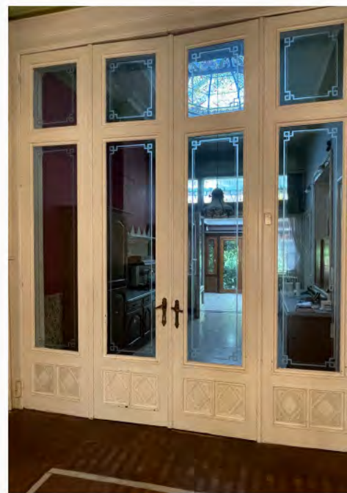
Geometrisch houtsnijwerk in de deuren rondom het tweede salon op het gelijkvloers (+00.03), o.a. een harmonicadeur.
