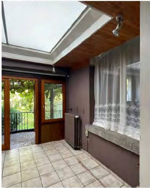
+00.05 (nieuwe veranda): recente binnenaafwerkingen op originele buitenwanden
