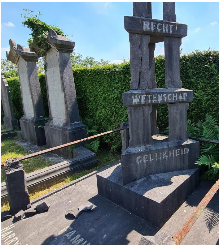
Figuur 12: Het middendeel van de toren op dit graf heeft een gebarsten steunelement (ontstaan door roestvorming van het bindende metalen element in het midden van het steunelement). Brokstukken liggen al her en der verspreid over het platform van het grafteken.
