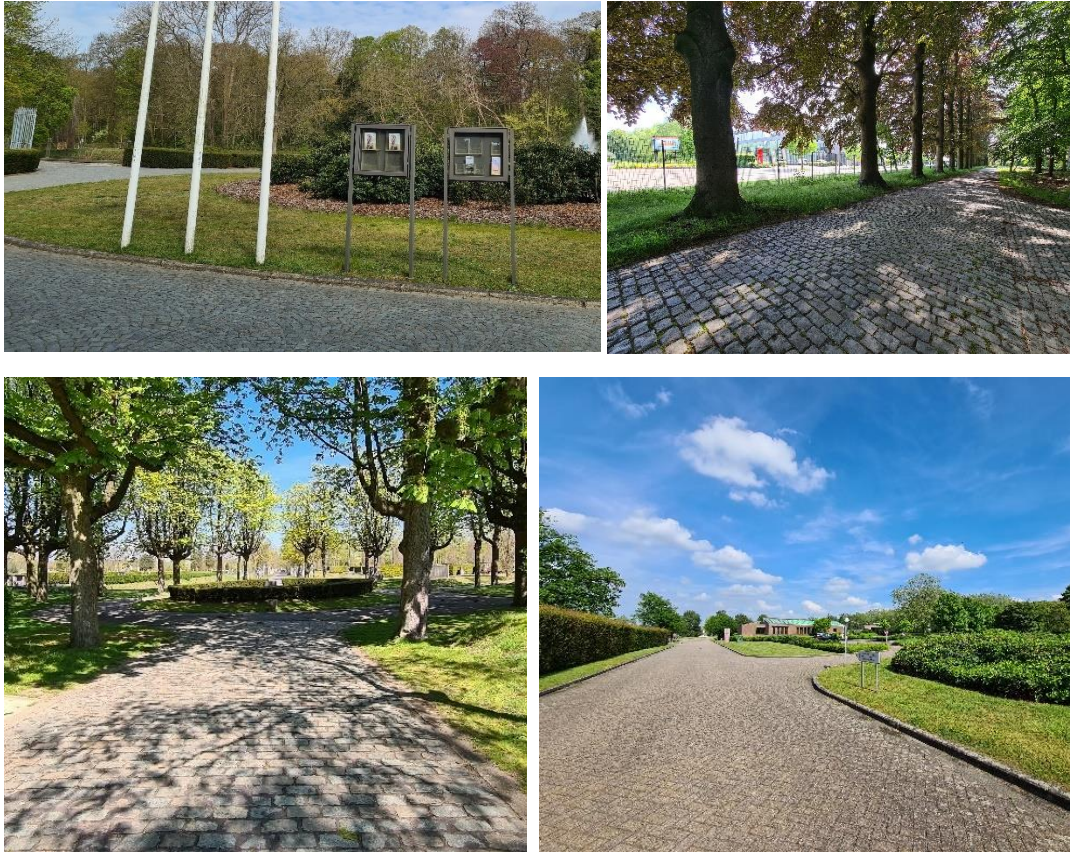
Figuur 17: Op diverse plekken liggen kasseiwegen (en -opritten), rond het crematorium zijn de wegen voorzien van klinkers. De oude kasseiwegen (nabij de Neerhoeve en achter perk 1) zijn niet geschikt voor het toelaten van zwaar werfverkeer (net zoals de met kassei ingelegde bruggen aan het kasteel). In het kader van het historisch landschap worden deze wegen echter wel onderhouden.
