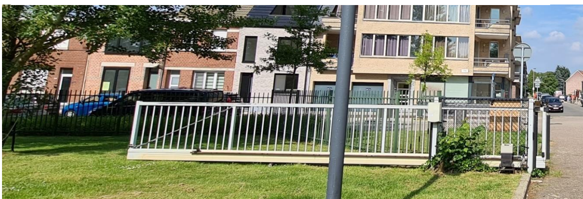
Figuur 23: Een ander type moderne (lage) omheining staat langs de straatzijden van het crematoriumgedeelte. Dit is de geautomatiseerde uitgang na sluitingstijd van het domein die zich bevindt buiten de beschermde perimeter, nl. t.h.v. de oostelijke parking van het crematorium.
