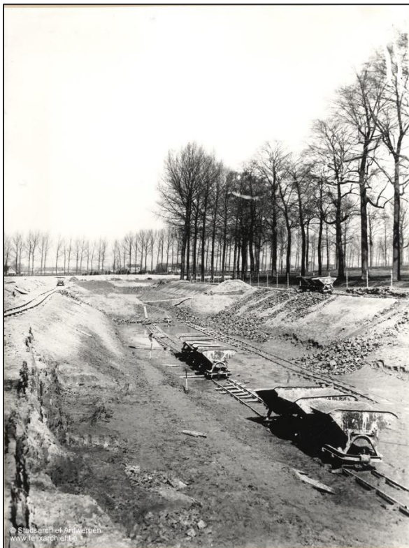
Figuur 30: aanleg van de grachten in 1926. Op deze oude opname is heel goed te zien hoe het terrein aan de linkerkzijde werd opgehoogd voor begraving met grond uit de grachten (bron: Felixarchief Antwerpen).
