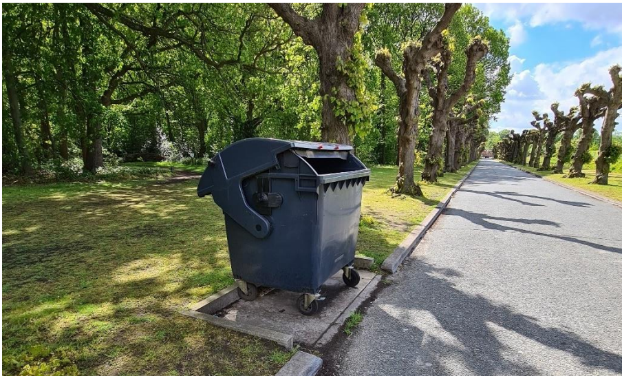
Figuur 9: Op meerdere plaatsen is er een stelplaats/haven in beton voorzien voor grote vuilnisbakken (op wielen). Dit vergemakkelijkt de huisvuilophaling en berging van de containers.
