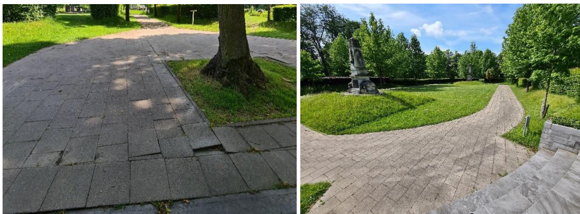
Figuur 16: Tussen de militaire ereperken is een wandelpad voorzien van dals en klinkers. Dit pad is niet met wagens (auto's) toegankelijk (wel voor dienstvoertuigen). Voor de meeste betondals wordt beter een overgang naar andere bestrating ingepland. Hier moet rekening gehouden worden met een onderhoudsvrije bestrating, de niet gevoegde kasseien zijn erg duur in onderhoud.
