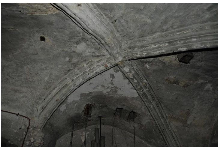
Afbeelding links : zicht op het kruisribgewelf eerste verdieping van de toren
