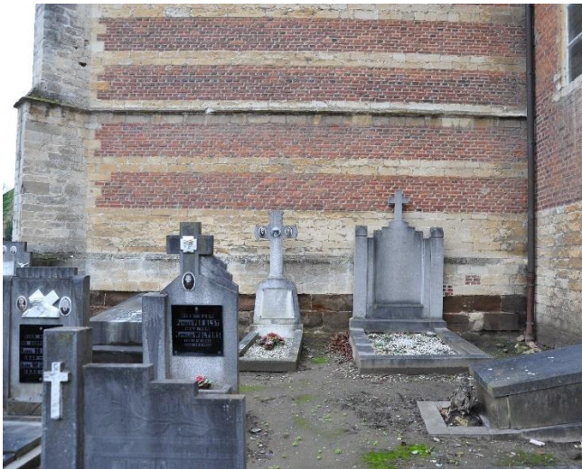
Afbeelding links : zuidtransept, oostelijke muur
