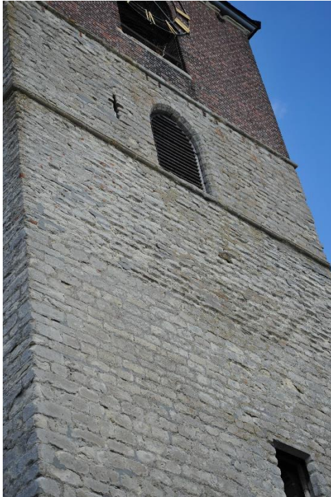
Afbeeldingen links en rechts: het natuurstenen parement van de toren gaat over in een wit bepleisterd metselwerk met hierboven gewoon metselwerk
