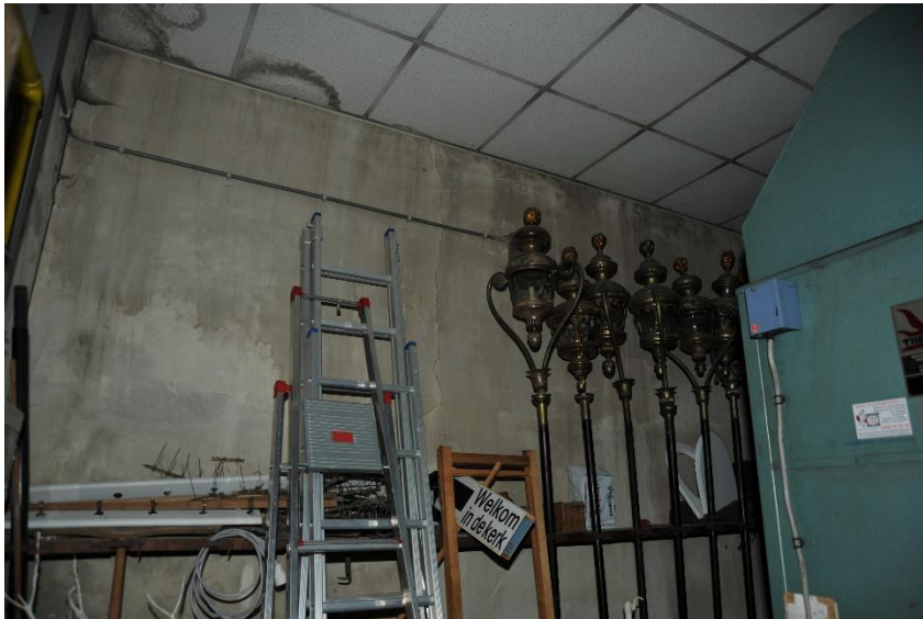
Afbeelding: bijgebouw noordzijde van de toren: vals plafond, technische ruimte.
