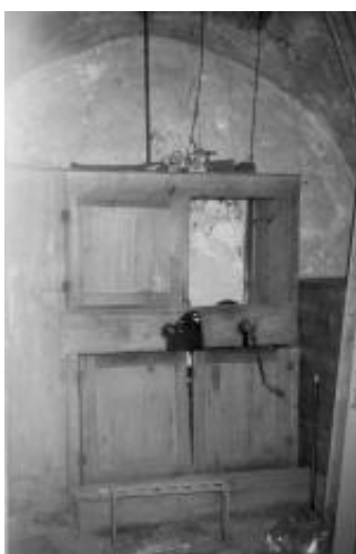
Afbeelding links: voormalige behuizing van de gewichten voor de voormalige windas, heden verdwenen.
