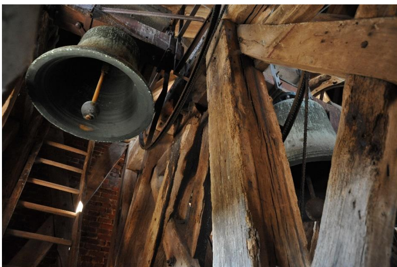
Afbeelding: vierde verdiep van de toren: klokkenstoel met drie klokken
