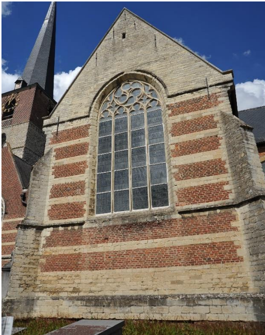
Afbeelding: topgevel zuidelijk transept
