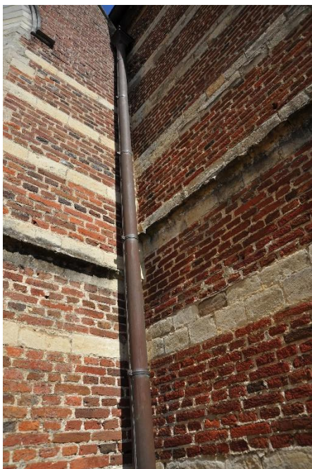
Afbeelding links: aansluiting schip met zuidtransept: speklagen lopen niet volledig door
