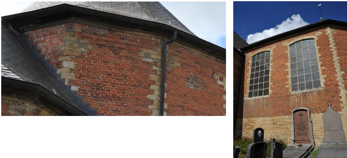
Afbeelding links : onsamenvattend metselwerk koor
