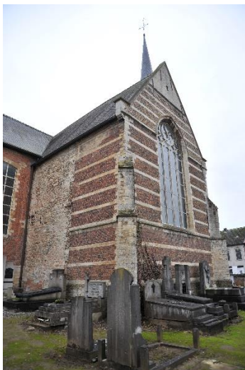
Afbeelding : restant romaanse muur uit zandsteen in breuksteenverband.
