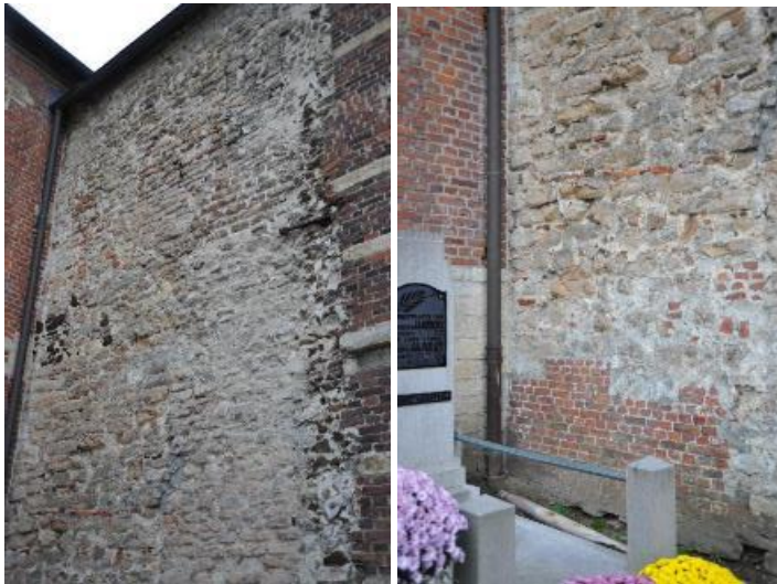
Afbeelding links : westelijke muur van het noordtransept met restant 13 de -eeuwse muur, 2021: detail
