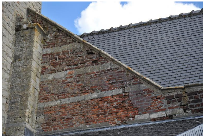
Afbeelding links: aansluiting schip met zuidtransept: speklagen lopen niet volledig door
