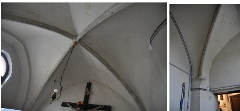
Afbeelding links: kruisribgewelf in de voormalige doopkapel. Nu berging.
