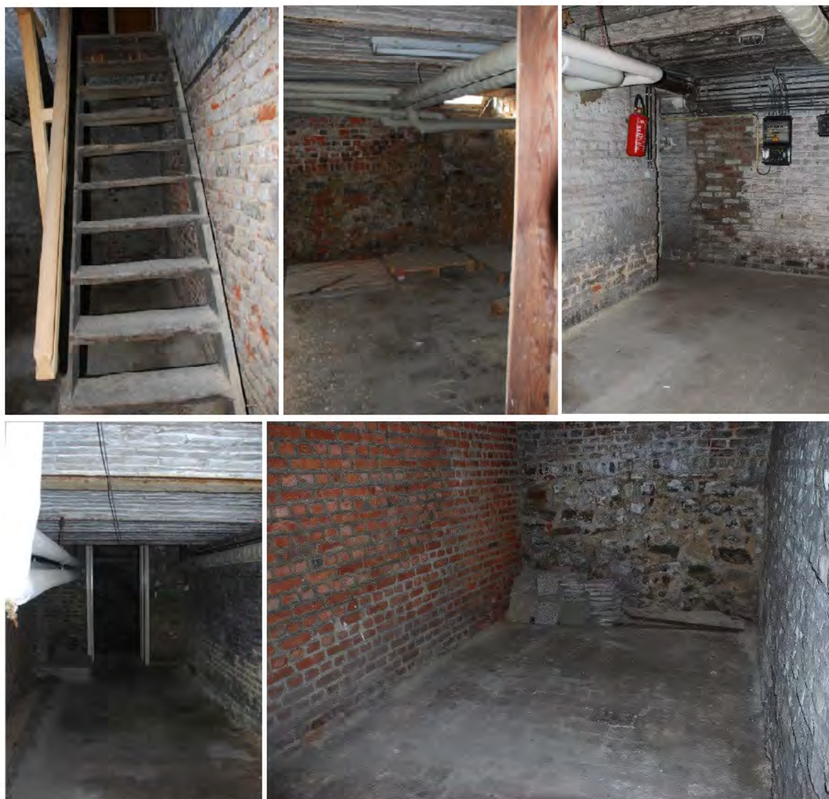
Afb. 30 Hotel Schaetzen, fotoreportage van de diverse kelderruimten
