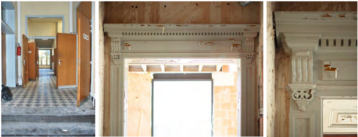
Afb. 24 centrale gang en detail deurlijst ©Studiebureau Monumentenzorg (d.d. 15/02/2019)
