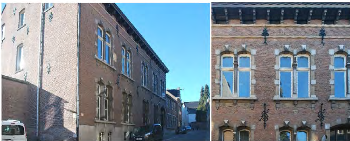
Afb. 10 straatgevel ©Studiebureau Monumentenzorg (d.d. 15/02/2019)
