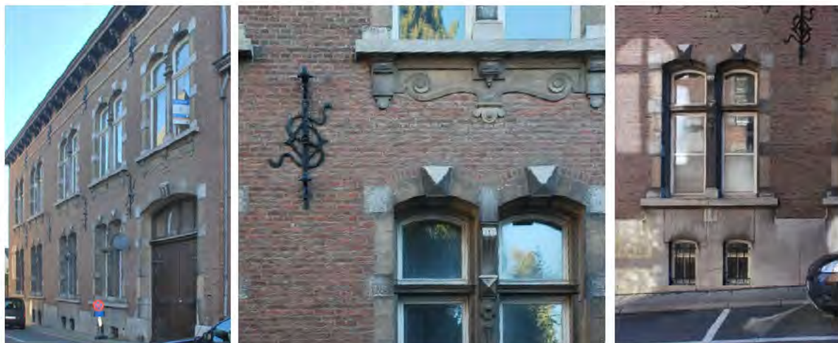
Afb. 12 straatgevel ©Studiebureau Monumentenzorg (d.d. 15/02/2019)
