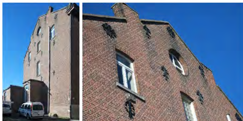
Afb. 16 linker zijgevel ©Studiebureau Monumentenzorg (d.d. 15/02/2019)
